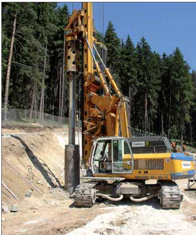
Obr. 1 Vrtanie pilotovej steny v úseku západného portálu Fig. 1 Drilling for the pile wall in the western portal section
