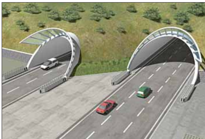
Obr. 2 Portál tunelu Lochkov
