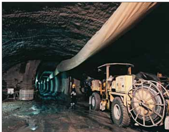
Obr. 3 Průzkumná štola st. 514 v místě rozšíření do kaloty budoucího tunelu Fig. 3 Construction lot 514 – the exploration gallery at the section enlarged to the top heading dimension
