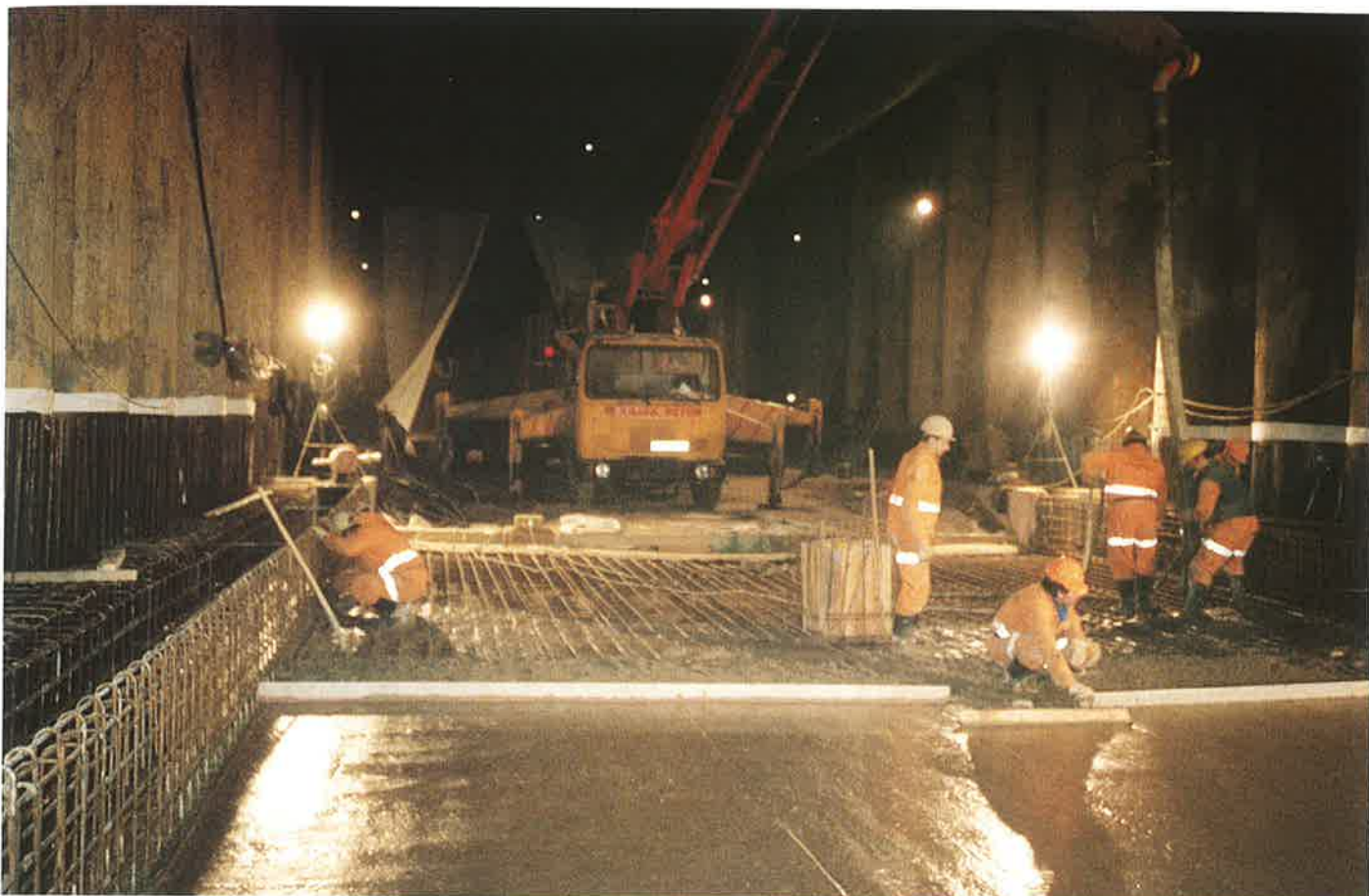
Obr. 3 Betonáž počvy galérie z južnej strany
