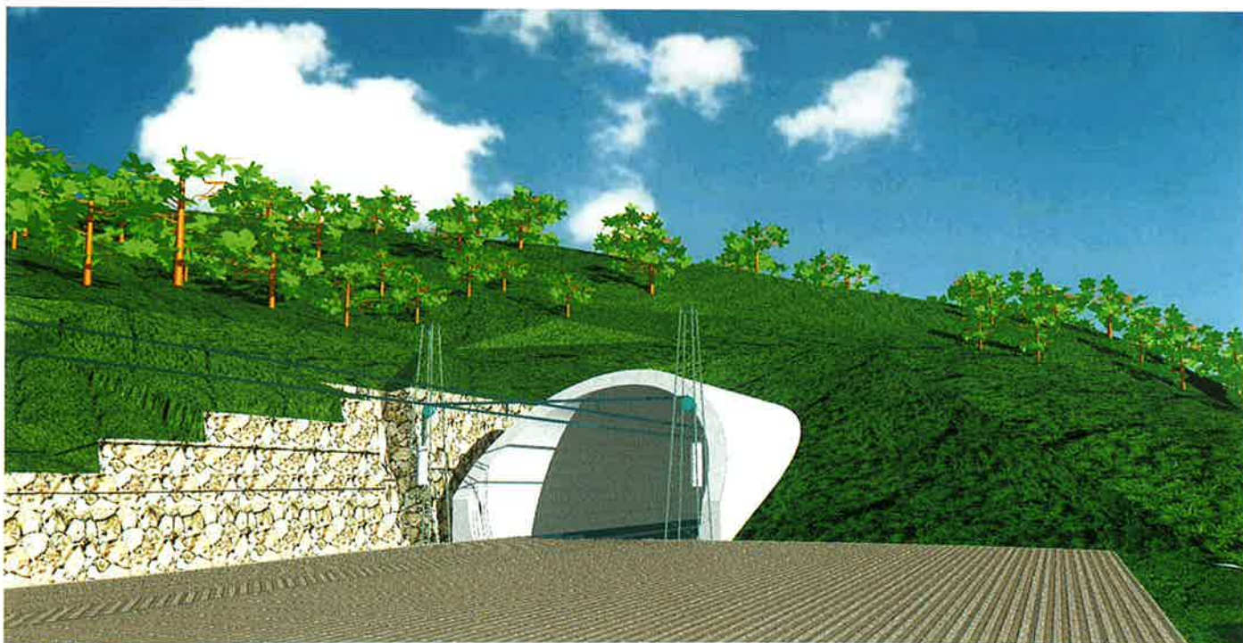
Obr. 2 Vizualizace řešení pražského portálu s gabionovou zdí Fig. 2 Computer model of the Prague portal, with a gabion wall
