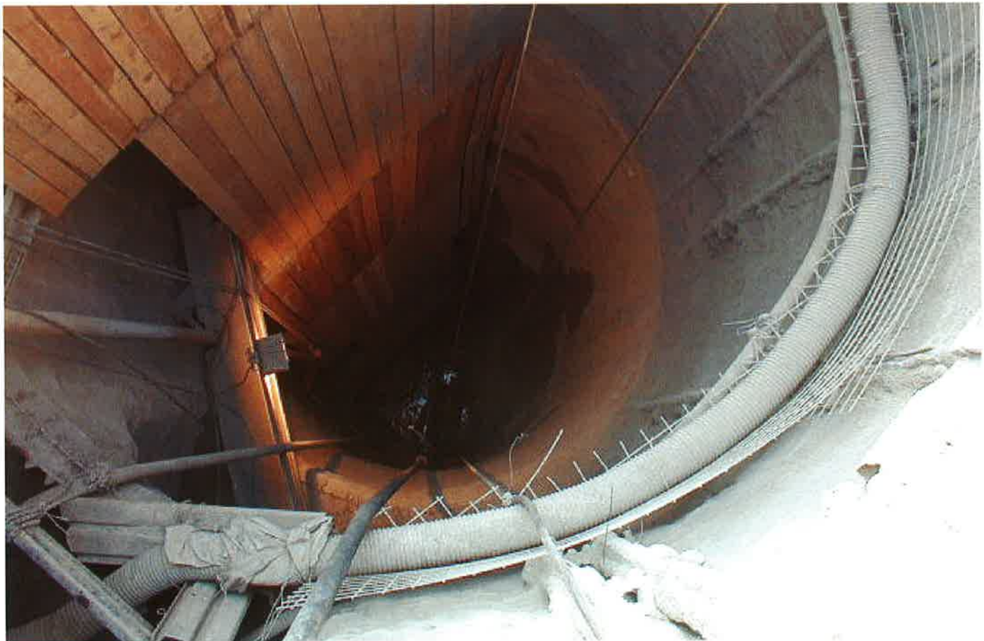
Obr. 2 Těžní šachta Š31 Fig. 2 Hauling shaft Š31
