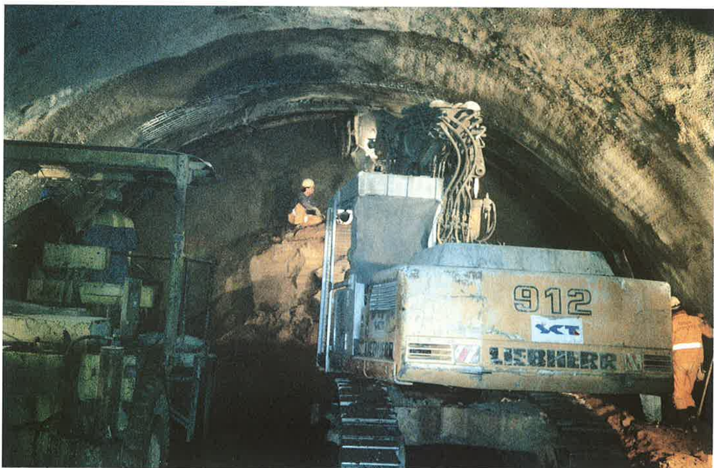
Obr. 4 Razenie katoly tunela
