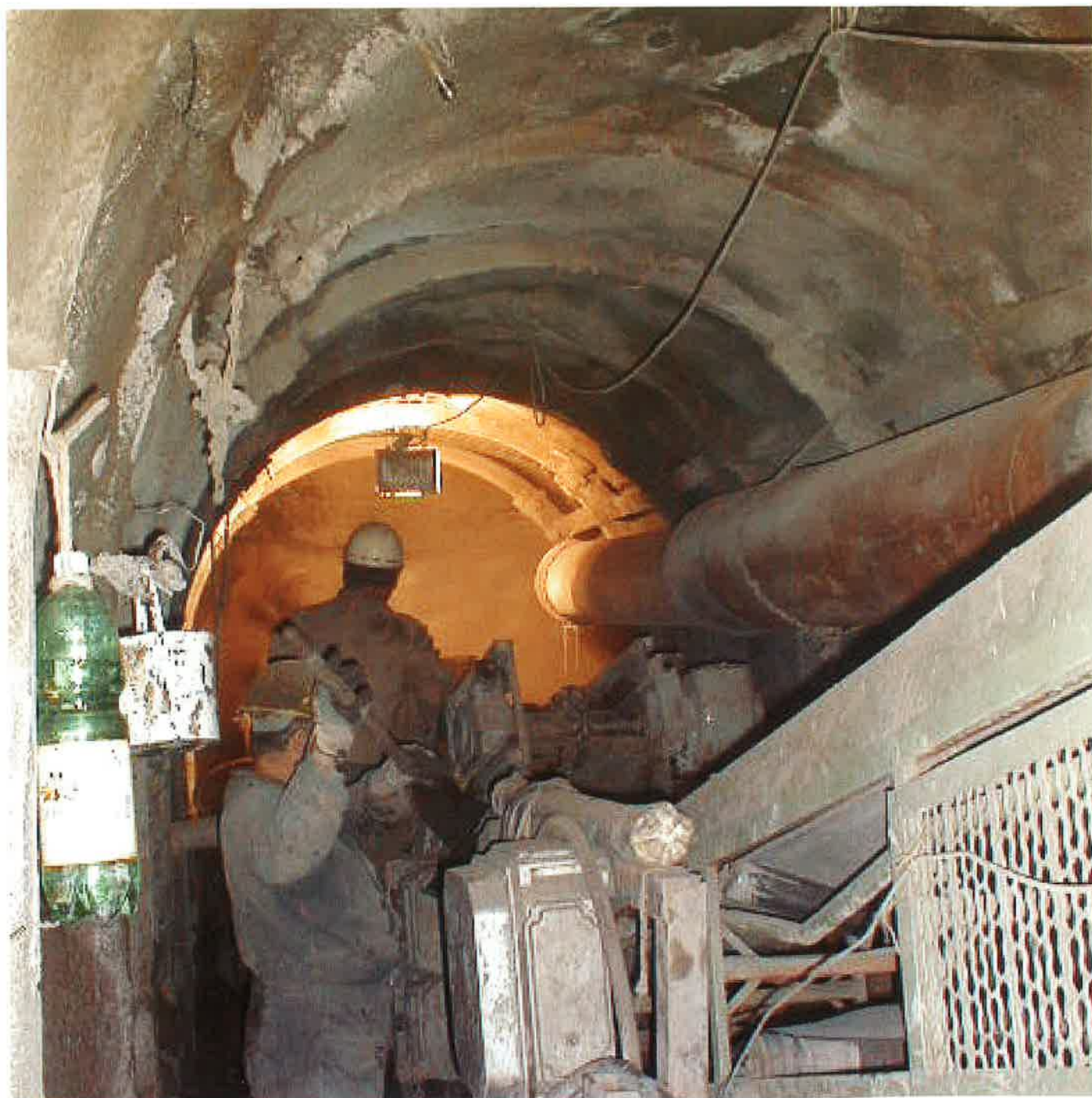
Obr. 3 Strojní ražba kabelového tunelu Fig. 3 Mechanical excavation of the cable tunnel
