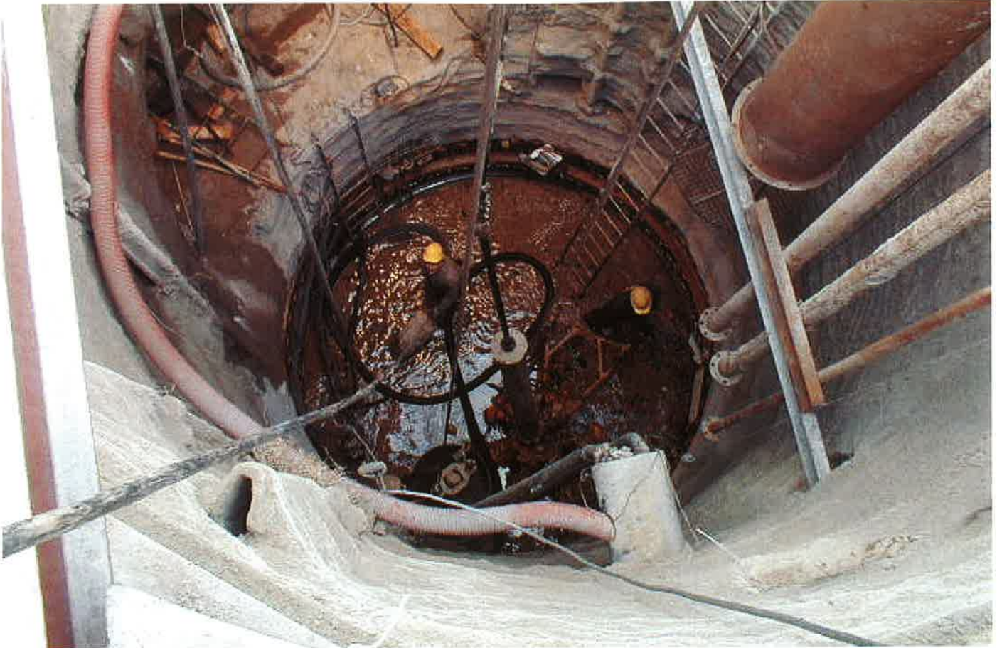
Obr. 1 Hloubení šachty Š31 Fig. 1 Excavation of Š31 Shaft
