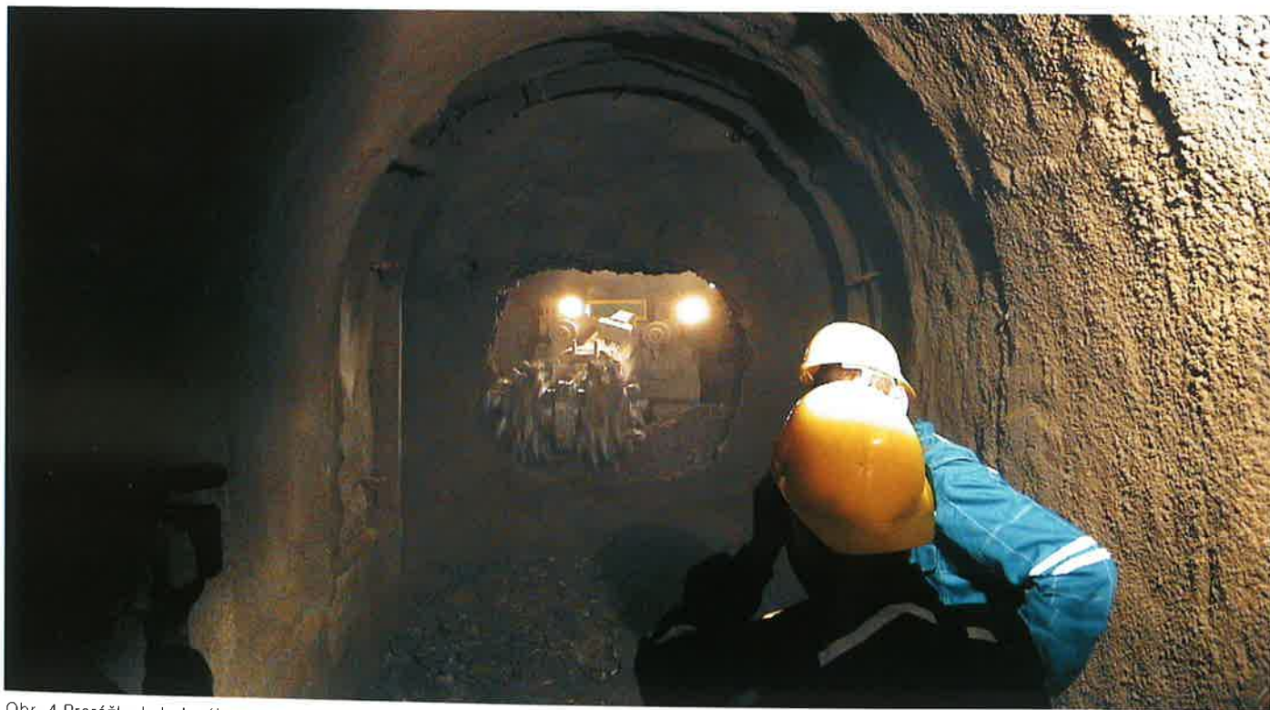
Obr. 4 Prorážka kabelového tunelu Fig. 4 Cable tunnel breakthrough
