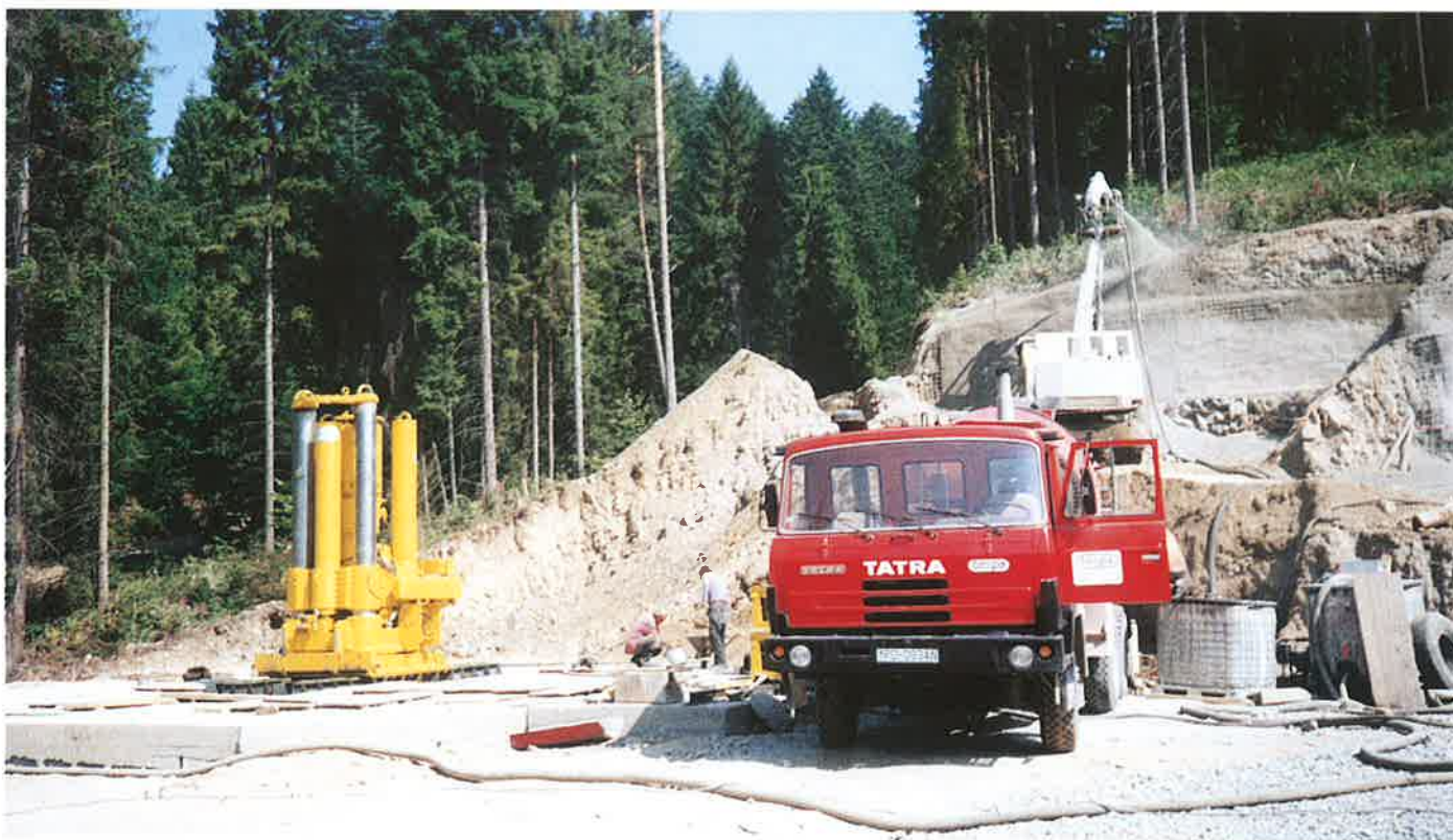
Obr. 3 Situácia povrchovej základne šachty v štádiu predvrtávania súpravou BESPADRILL
