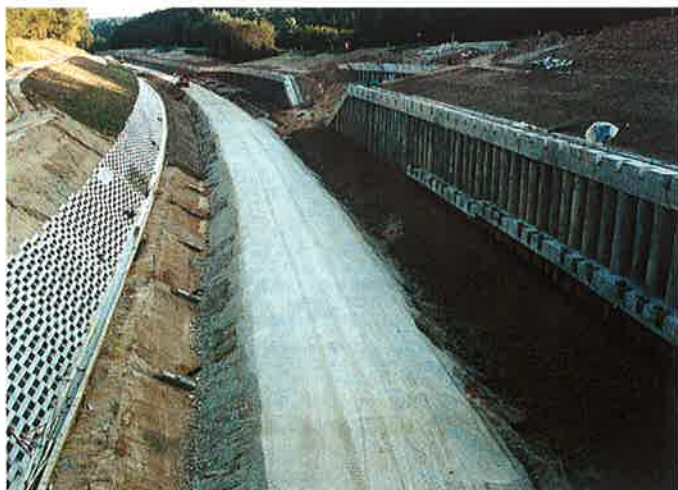
Obr. 6 Stabilizácia svahov pred vstupným portálom Fig. 6 Slopes stabilisation on front of the entrance portal
