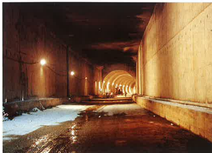
Obr. 7 Definitívne ostenie galérie tunela Fig. 7 Final lining of the gallery
