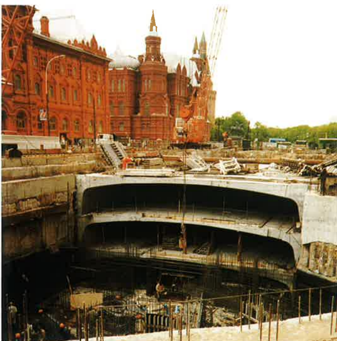
Podzemní garáže ve stavbě – v pozadí Kremľ Underground parking-garage under construction – Kremľ in background
