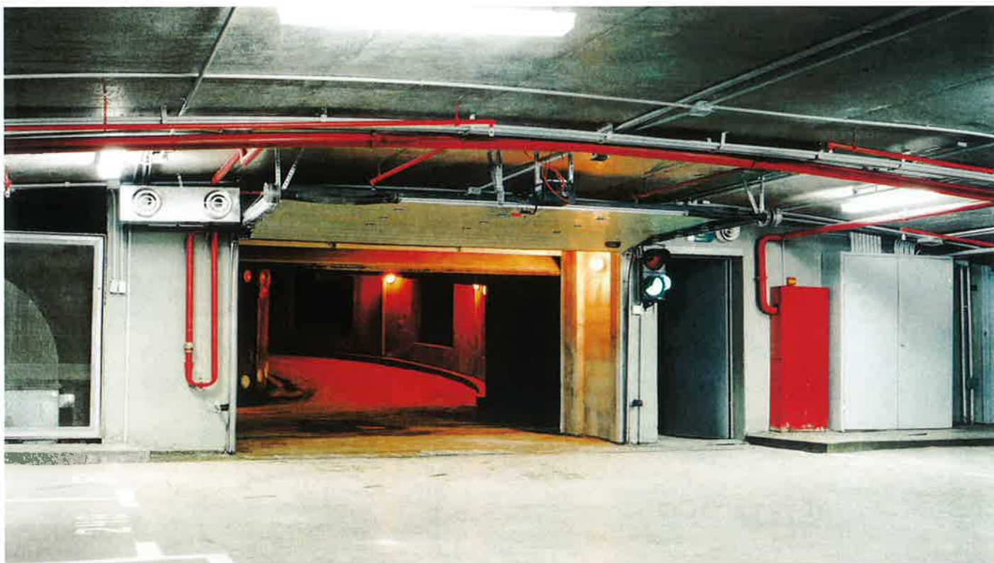
Podzemní garáže po dokončení Underground parking-garage after completion
