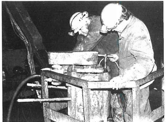
Injektáž kotev tlakovým kotlíkem z výsuvné plošiny
