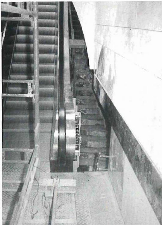
Eskalátorový tunel ve stanici Václavské náměstí před dokončením
