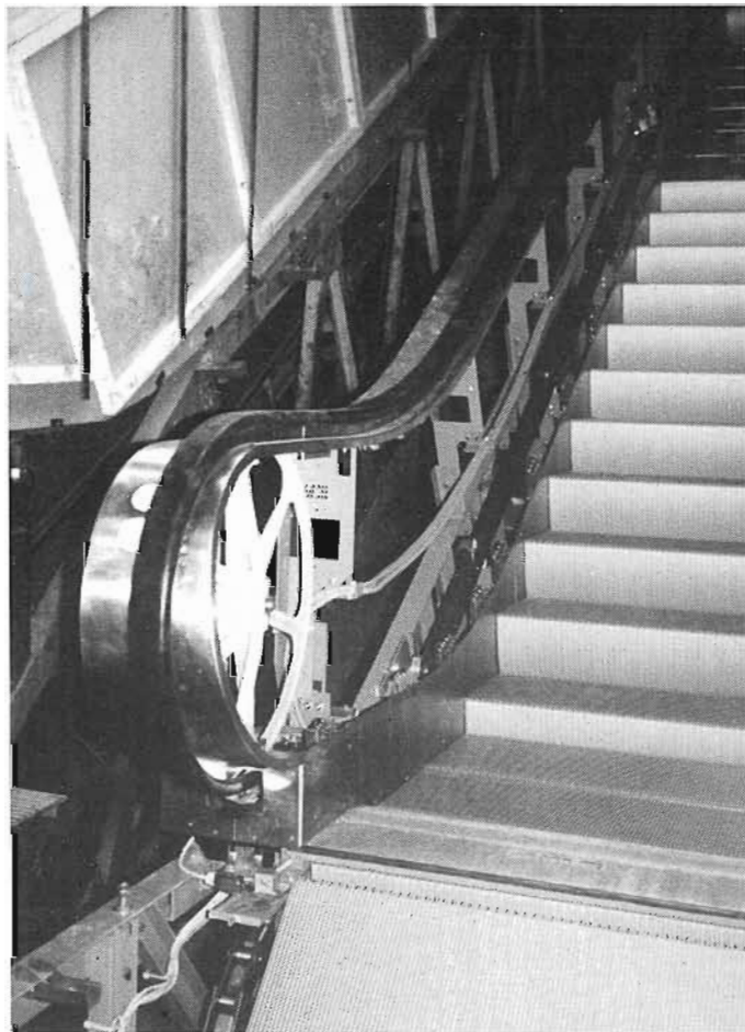
Pohled na eskalátor ve stanici I. P. Pavlova před dokončením montáže
