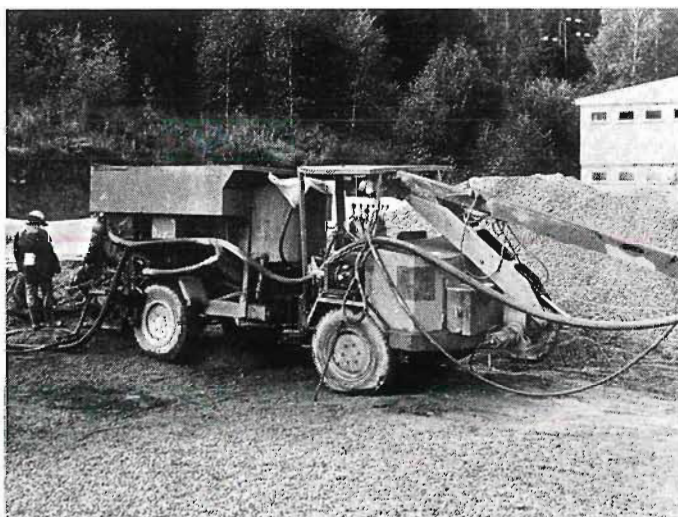
Manipulační důlní vůz pro stříkání betonu
