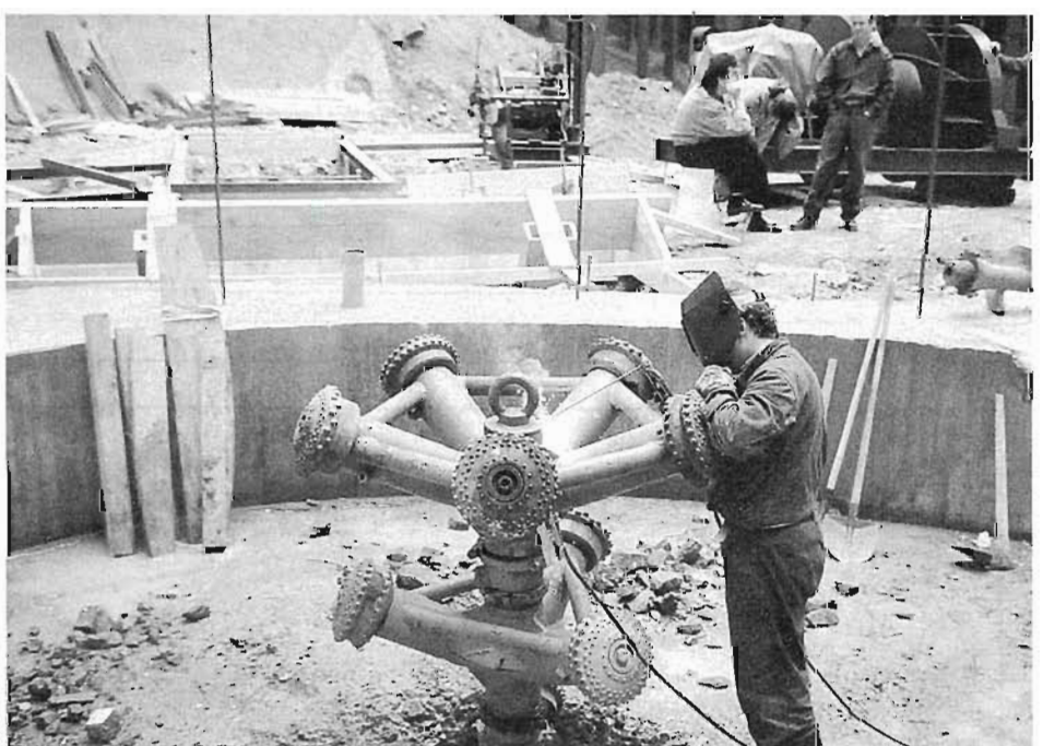
e) montáž rozšiřovacího dláta \varnothing 1,42 m
