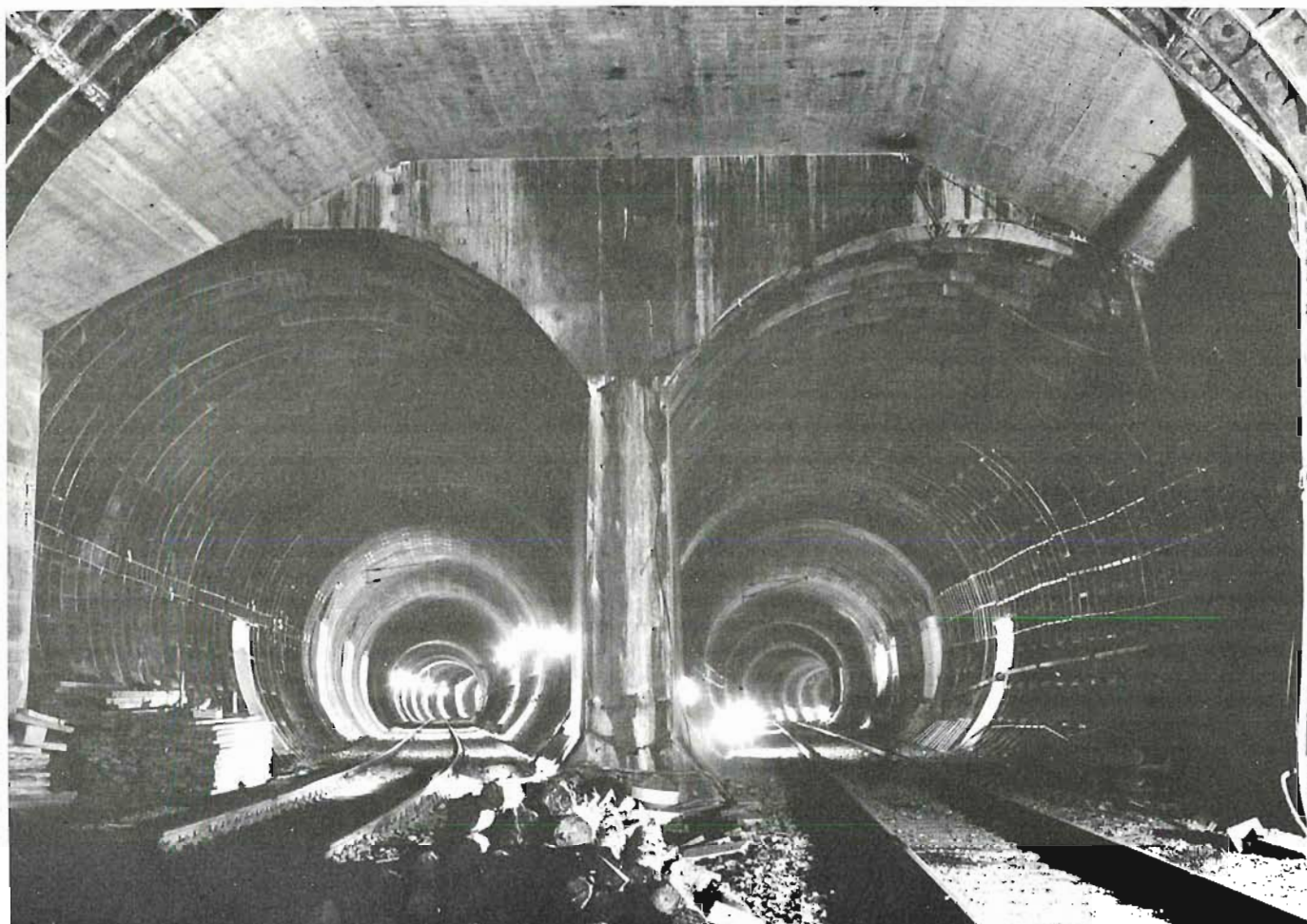
Pohled do vyražených tuneů
