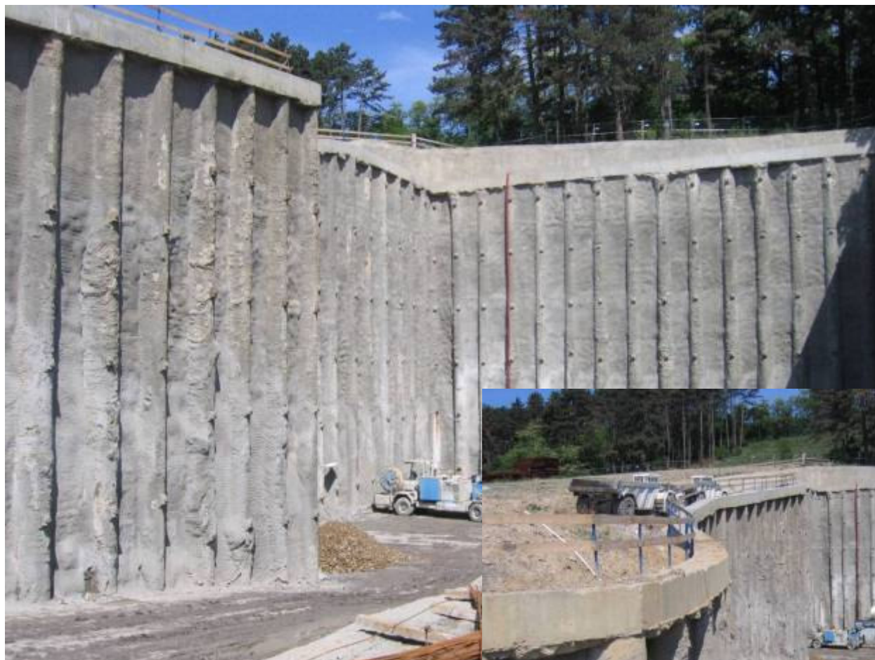
Stavební jáma KU1
