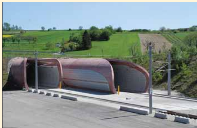
Obr. 2 Západní portál tunelů Wienerwald Fig. 2 Western portal of the Wienerwald tunnel
