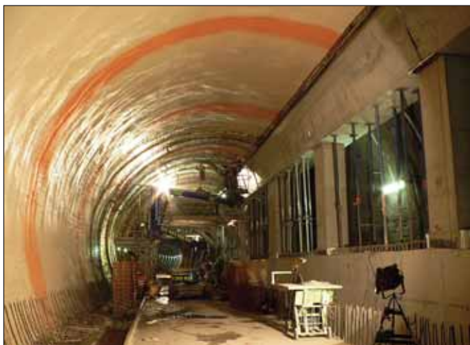
Obr. 3 Stříkaná izolace a armatura definitivního ostění ve stanici Velešlavín (foto: Chotár) Fig. 3 Spray-on waterproofing and steel reinforcement of the final lining in Velešlavín station (photo: Chotár)
