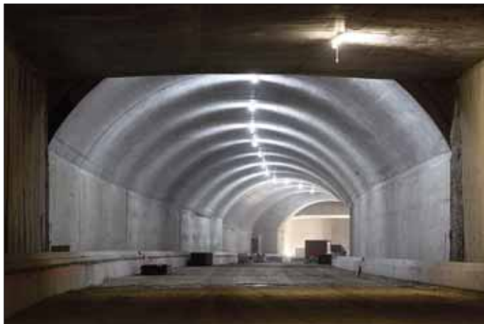
Obr. 1 Klenbový úsek hloubeného tunelu pod Patočkovou ulicí (foto: Jakub Karlíček)
