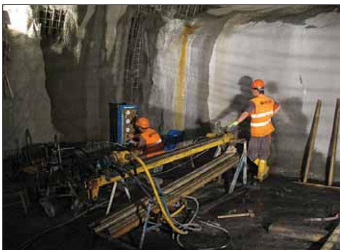
Obr. 2 Realizace doplňkových průzkumných vrtů a presiometrického měření ve stanici Červený Vrch pro potřeby upřesnění strukturně-geologické stavby a geotechnických parametrů horninového masivu (foto D. Moravanský)
