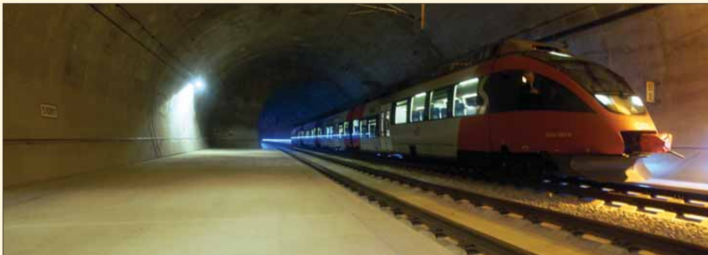
Obr. 7 Exkurze – vlaková souprava v místě rozšíření tunelu (foto: Libor Mařík)
