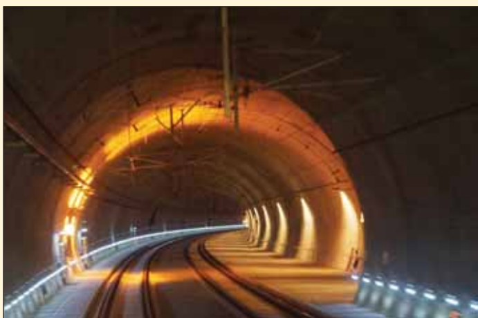
Obr. 6 Exkurze – osvětlení v místě rozšíření tunelu a únikové cesty (foto: Libor Mařík)
