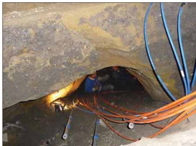
Obr. 7 Hadice pro doinjektování cementem Fig. 7 Hoses for final injection of cement grout
