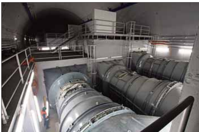
Obr. 5 Axiální ventilátory v raženém strojně pod Letnou (foto: Jakub Karlíček)
