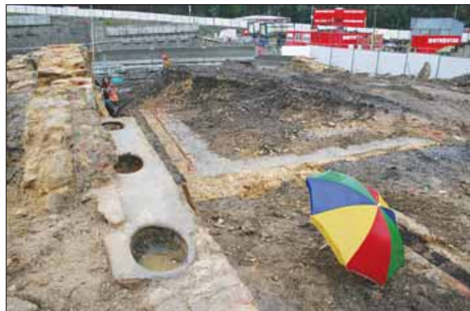
Obr. 14 Dochované relikty zástavby z 19. a 1. poloviny 20. století jižně od Patočkovy ulice – zaniklé objekty cihelny a octárny, odkrývání podlahy stáji a obvodového zdiva se žlaby (foto ARÚ Praha)
