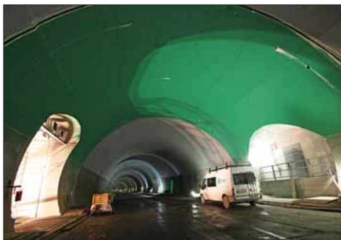
Obr. 6 Odstavný záliv s napojením průjezdné propojky TP17 a technického centra TGC5 (foto: Jakub Karlíček)
