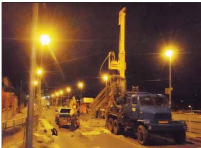
Obr. 9 Realizace průzkumného vrtu pro ověření geotechnických podmínek ražby a sanace podloží vozovky a tramvajové trati v prostoru ulice Evropská nad jednokolejnými tratovými tunely raženými pomocí EPB (foto J. Tlamsa) Fig. 9 Realisation of an exploratory borehole for the verification of geotechnical conditions for the underground excavation and stabilisation of the road and tram track subgrade in the area of Evropská Street, above the EPB-driven single-track running tunnels (Photo courtesy of J. Tlamsa)
