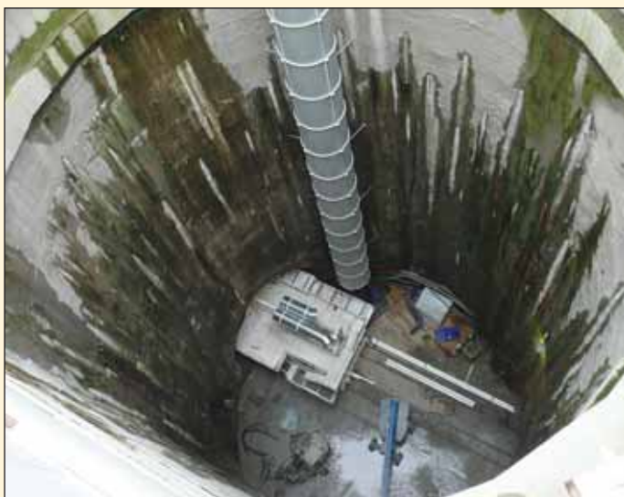
Obr. 5 Montážní šachta Leibenfeld – na dně probíhá montáž prvního tunelovacího stroje Fig. 5 Leibenfeld assembly shaft with the first full-face tunnelling machine being assembled at the bottom
