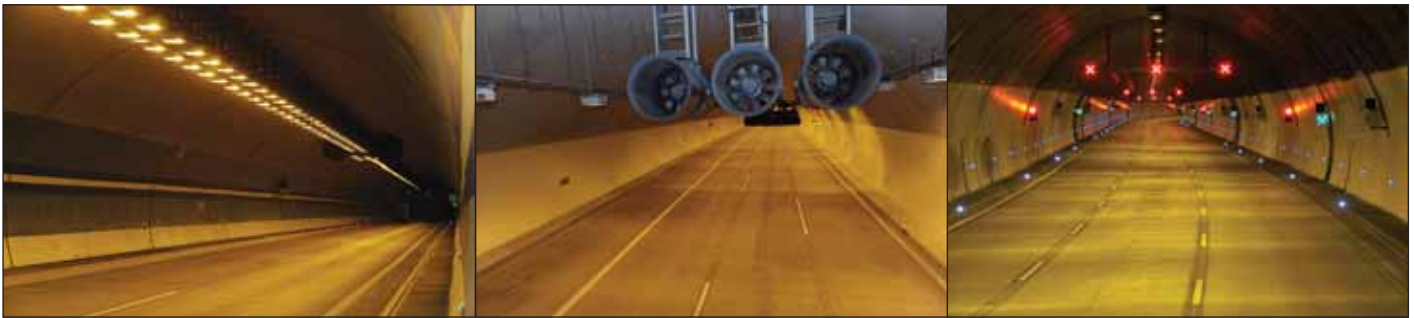
Obr. 7 Technologické vybavení tunelu Fig. 7 Tunnel equipment
