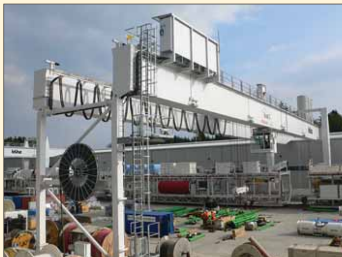
Obr. 4 Zařízení staveniště KAT 2 u Leibenfeldu, v pozadí hala výroby segmentů Fig. 4 KAT 2 construction site utility near Leibenfeld with a segment casting yard in the background
