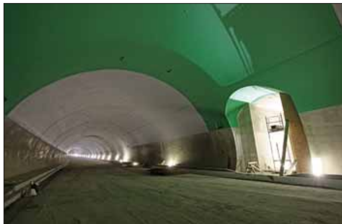
Obr. 2 Dokončovací práce v raženém tunelu Brusnice (foto: Jakub Karlíček)
