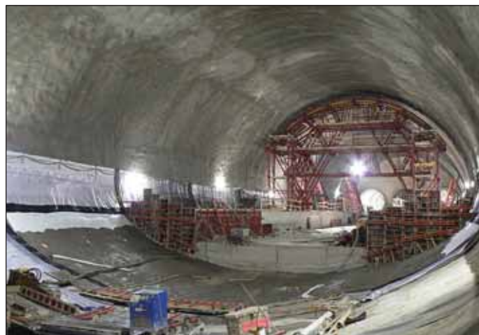
Obr. 2 Stanice Petřiny a počátek realizace definitivního ostění (foto: Chotár) Fig. 2 Petřiny station and the beginning of the final lining installation (photo: Chotár)
