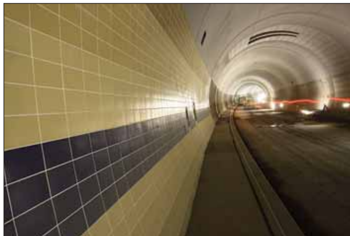
Obr. 4 Obklad stěn raženého tunelu pod Stromovkou (foto: Jakub Karlíček)
