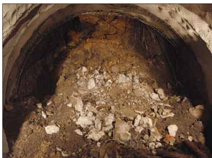
Obr. 8 Zával při ražbě vzduchotechnické štoly v Motole při zastížení štoly z období druhé světové války; při pravém okraji snímku je v rubanině a čelbě patrná dřevěná výztuž (foto J. Tlamsa)
