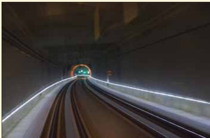
Obr. 4 Exkurze – průjezd hloubeným tunelem a přejezd do ražené části (foto: Libor Mařík)
