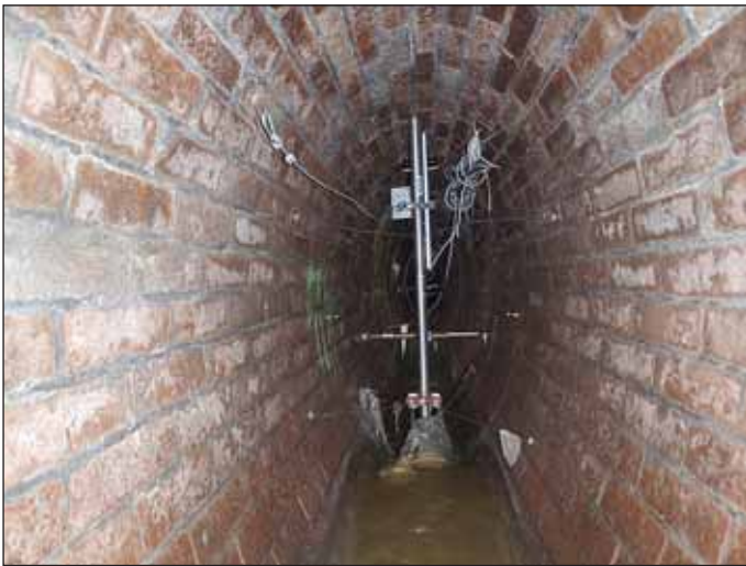
Obr. 6 Automatický monitoring deformací stoky (foto sdružení Arcadis – Inset)
