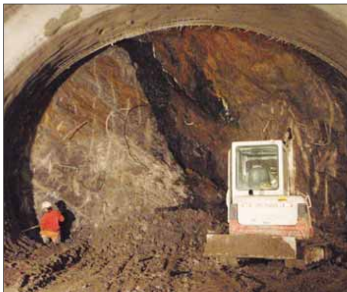
Obr. 6 Tektonicky nasunutá hornina kosovského souvrství (šedé jílovité břidlice a křemence – levá část čelby) a siluru (černé jílovitoprachovité břidlice) v prostředí ordovických břidlic bohdaleckého souvrství (šedé jílovité břidlice – pravá část čelby); důkladná dokumentace tektonické stavby umožnila prognózu podmínek ražby přilehlé štoly VZT (foto D. Schaffner)
