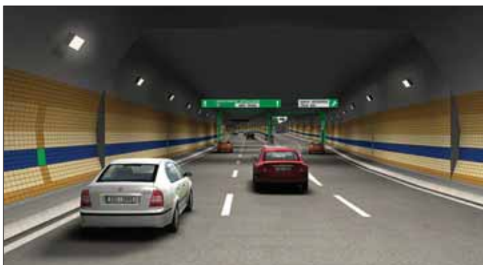
Obr. 3 Vizualizace tunelové trouby s výjezdovou rampou a tunelovou propojkou (zdroj: www.tunelblanka.cz )
