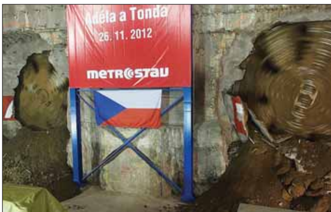
Obr. 5 Dva EPB štíty současně prorazily do prostoru odstavných kolejí stanice Dejvická (foto: Junek) Fig. 5 The two EPB shields broke out into the space of the dead-end tail track tunnel at Dejvická station (photo courtesy of J. Junek)
