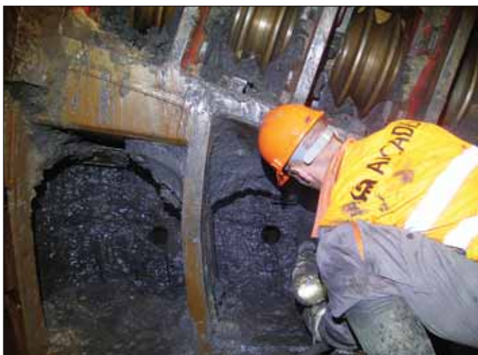
Obr. 5 Odběr vzorků horniny z prostoru těžní komory EPB S-609 (Tonda) pro stanovení fyzikálně-mechanických parametrů včetně abrazivnosti podle CAI (foto J. Rout)
