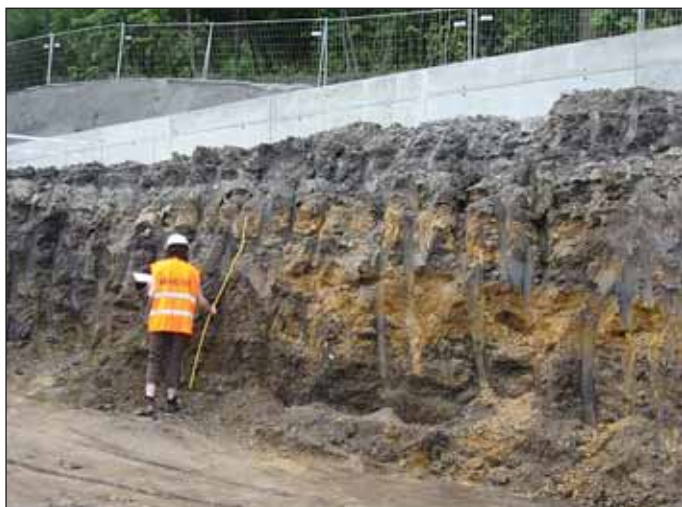
Obr. 4 Inženýrskogeologická dokumentace postupného odtěžování hlouběného tunelu pro obrátové koleje při stanici Motol v prostředí tektonicky porušeného horninového masivu a fosilních svahových pohybů (foto J. Tlamsa)
