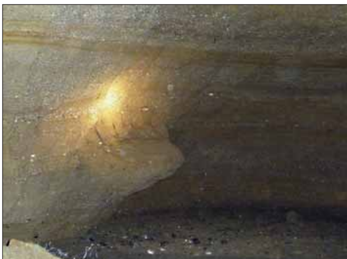
Obr. 6 Marinní jílovité písky spodního badenu s polohami drobného šterku; zastižené stěny podzemní prostory jsou nepodpřené; v počtvě je patrný uložený erodovaný písek
