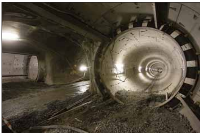
Obr. 1 Propojení traťových tunelů u stanice Petřiny (foto: Husák) Fig. 1 Interconnection between running tunnels at Petřiny station (photo: Husák)
