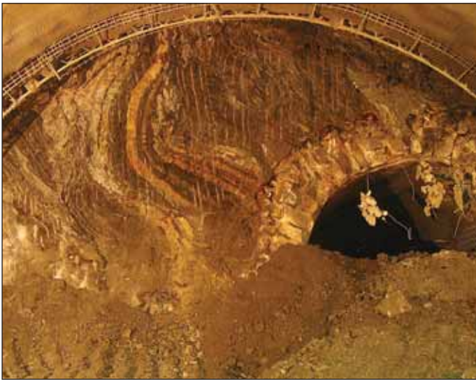
Obr. 2 Tunel Jablunkov – geologie na čelbě Fig. 2 Jablunkov tunnel – geology at the heading
