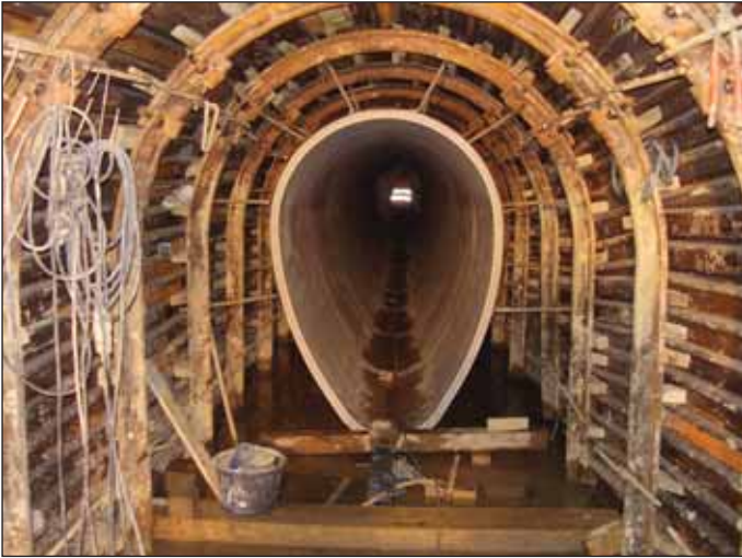
Obr. 1 Montáž kmenové stoky z polymerbetonového potrubí DN 1200/1800 do klasicky ražené štoly, meziprostor bude vyplněn samozhutitelným betonem C 30/37 XA1
