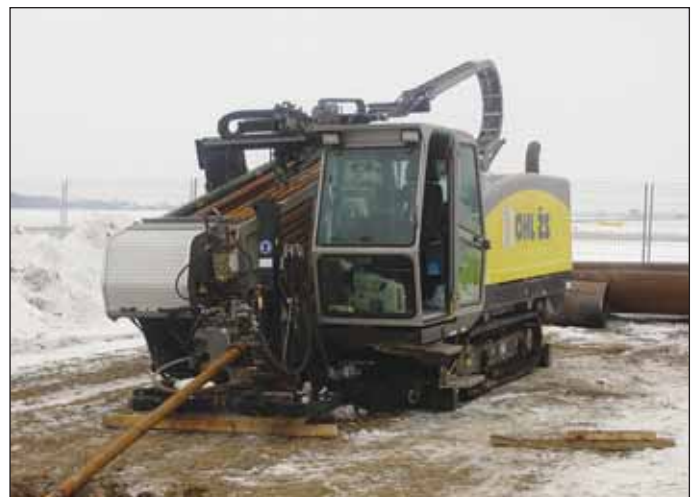
Obr. 7 Vrtná souprava Grundodrill 25N v pracovní pozici před startovací šachtou
