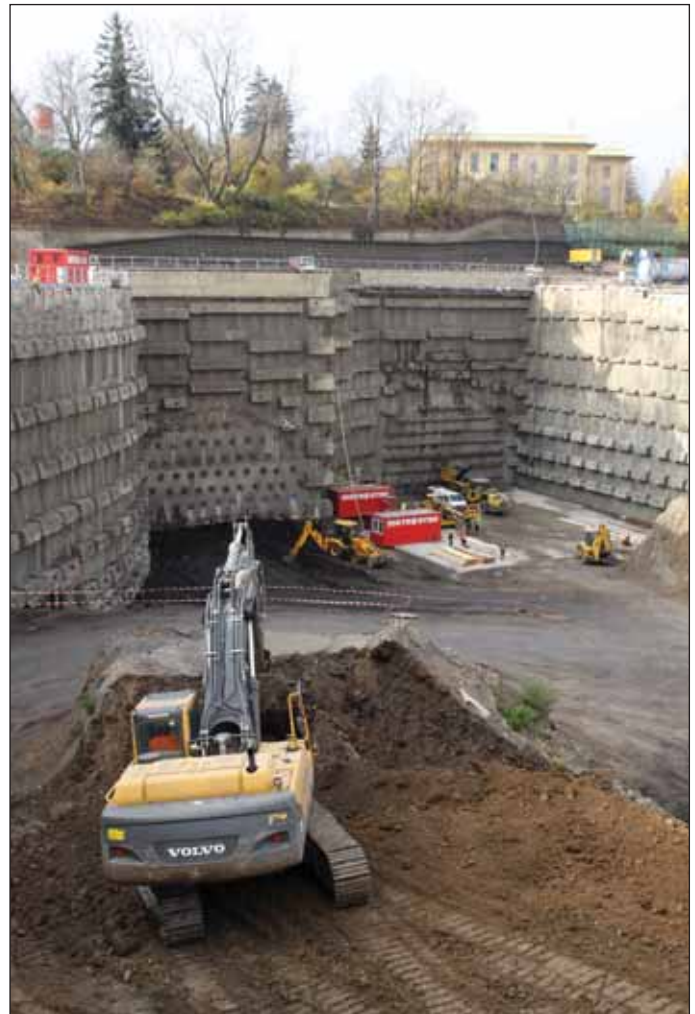
Obr. 4 Stavební jáma Myslbekova a staveniště hloubených tunelů Patočkova Fig. 4 The Pražský Most construction pit
