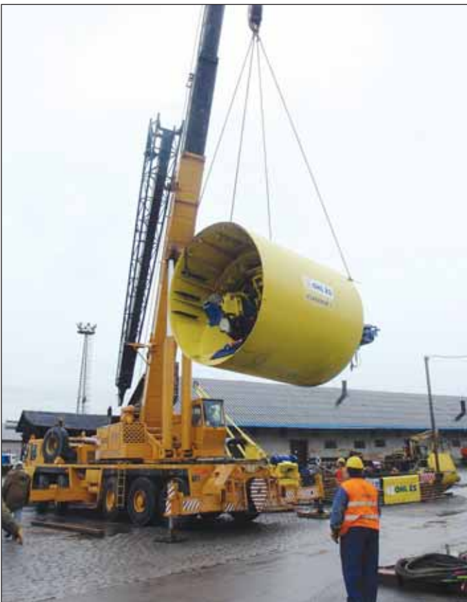
Obr. 2 Polomechanizovaný štít RŠK 3050 před spuštěním do startovací šachty, v přední části hydraulicky ovládaná lžičce, v zadní části pásový dopravník Fig. 2 Semi-mechanised shield RŠK 3050 before lowering into the launching shaft; the hydraulically controlled shovel at the front end, the belt conveyor in the rear part
