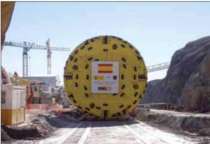
Obr. 2 Vrtací hlava sestaveného tunelovacího stroje před instalací na pracovišti Fig. 2 The cutterhead of the assembled tunnelling machine before the installation at the heading
