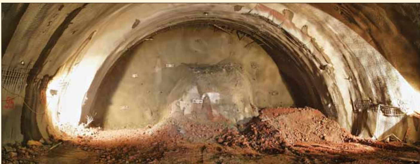
Obr. 9 Čelba tunelu Lichtenholz v složitých geotechnických podmínkách Fig. 9 The Lichtenholz tunnel excavation face in complicated geotechnical conditions
