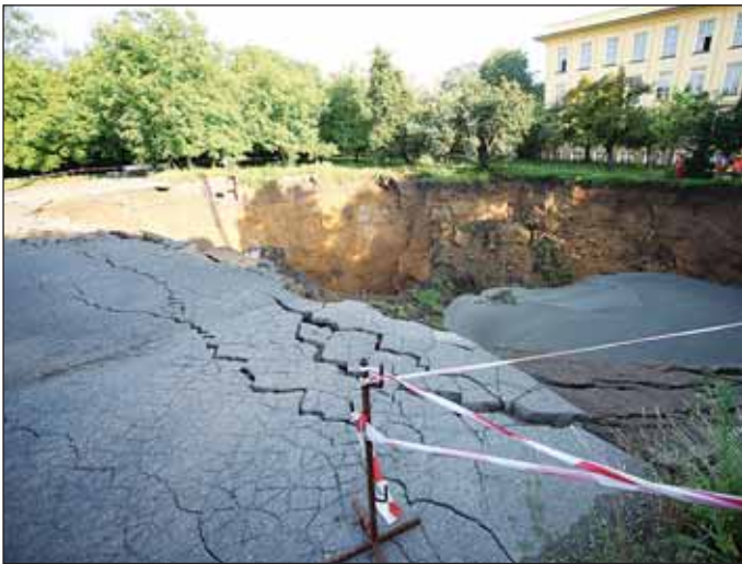
Obr. 4 Blanka tunel Brusnice – mimořádná událost 5. 7. 2010 (archiv Metrostav a. s.)
