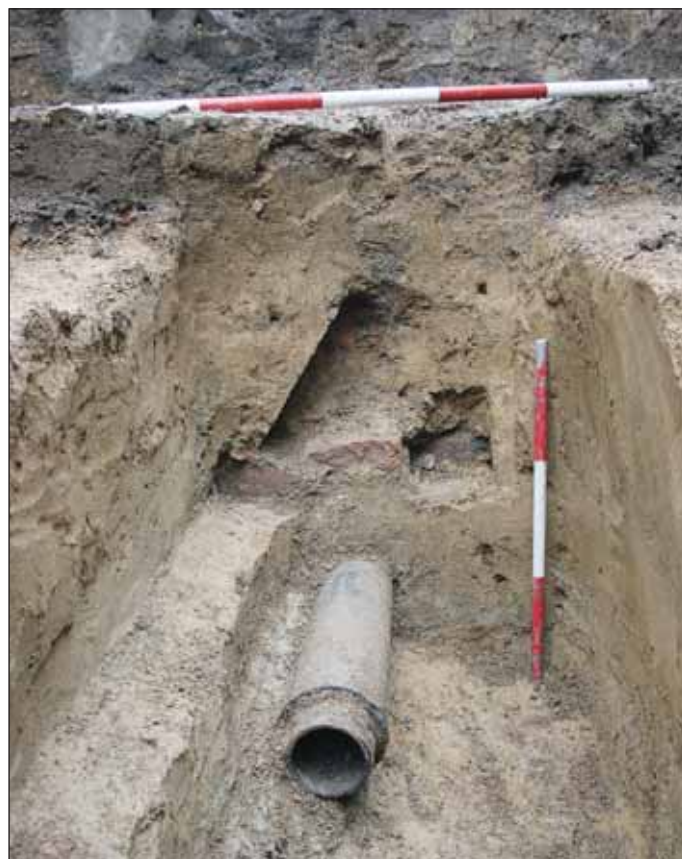
Obr. 7 Dominikánské náměstí – TŠ1, detail novověkého vodovodu z přelomu 17. a 18. století (19. stavba Veselá–Dominikánské náměstí; foto Archaia Brno) Fig. 7 Dominikánské Square –TŠ1 shaft, a detail of a Early Modern water line from the end of 17 th century (Lot. No. 19 Veselá Street–Dominikánské Square; photo courtesy of Archaia Brno)
