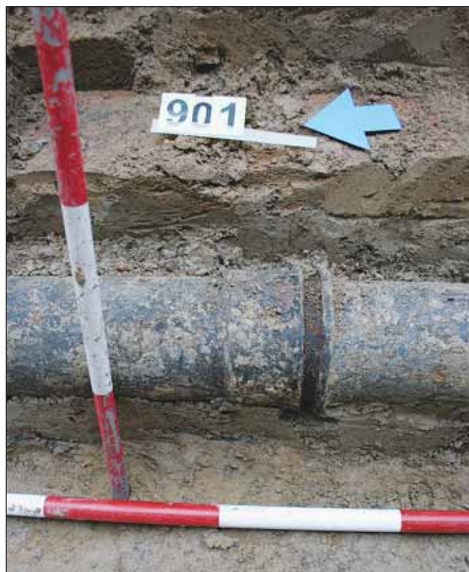
Obr. 8 Detail spojení keramických vodovodních trubek odkrytých v rámci TŠ1 (19. stavba Veselá–Dominikánské náměstí; foto Archaia Brno) Fig. 8 A detail of a joint between clayware water pipes exposed within the framework of sinking TŠ1 (Lot No. 19 Veselá Street–Dominikánské Square; photo courtesy of Archaia Brno)
