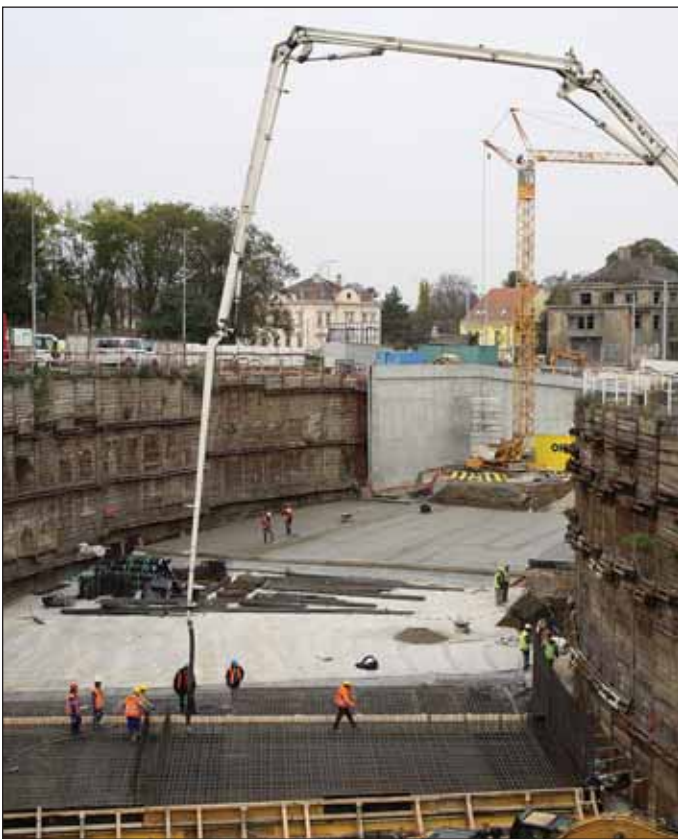
Obr. 7 Výstavba jižních ramp křižovatky U Vorlíků Fig. 7 Construction of southern ramps of the U Vorlíků grade-separated intersection
