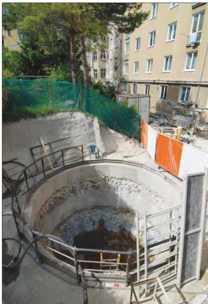
Obr. 10 Pracoviště pro kompenzační injektáž byla navržena a realizována maximálně úsporně s ohledem na zatížení okolí stavby
