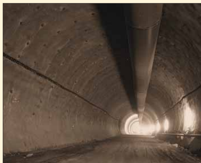
Obr. 2 Kompenzační elementy v primárním ostění
