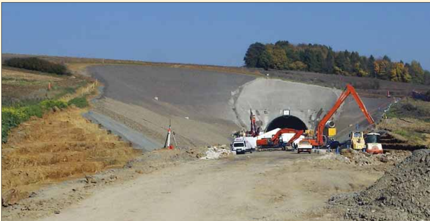
Obr. 8 Portálový zářez tunelu Kulch a stabilizace svahů Fig. 8 The Kulch tunnel pre-portal open cut and slope stabilisation
