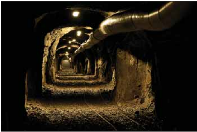
Obr. 2 Podzemí UEF Josef Fig. 2 Underground space of Josef UEF
