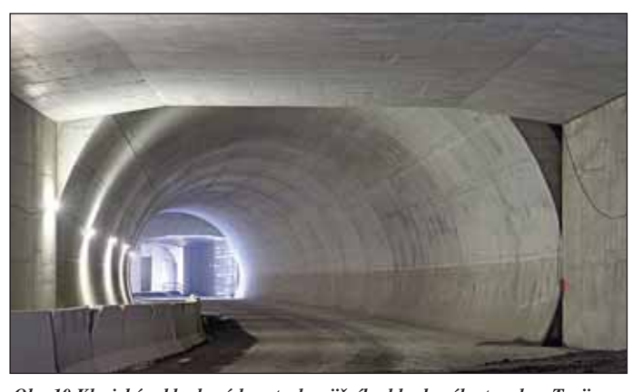
Obr. 10 Klasická a klenbová konstrukce jižního hloubeného tunelu v Troji Fig. 10 Classical structure and vaulted structure of the southern cut-and-cover tunnel in Troja
