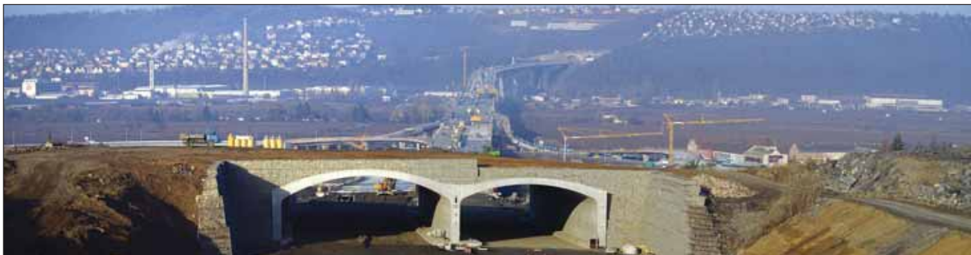
Obr. 1 Pohled od portálu Komořany stavby 513 Fig. 1 A view from the Komořany portal, Lot 513
