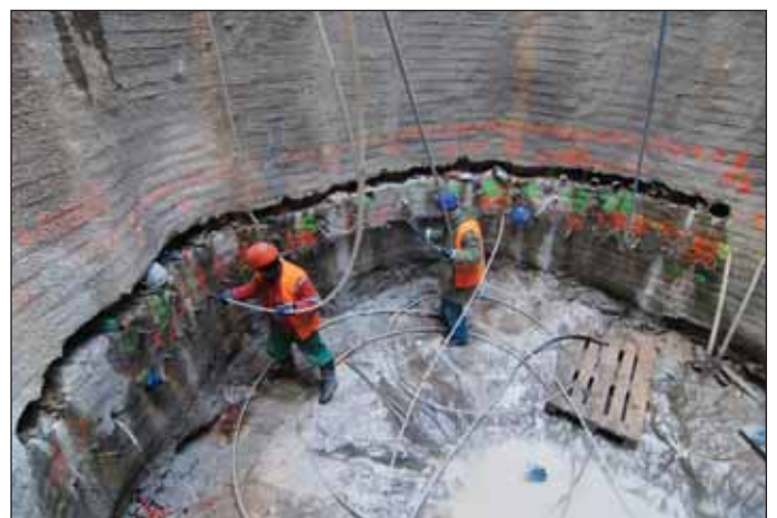
Obr. 6 a 7 Pohled na injektážní vrtů pro kompenzační injektáž s osazenými manžetovými trubkami a na výše položené návrtné body pro subhorizontální clonu z TI, šachta 04
