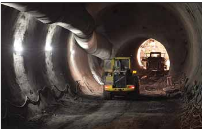
Obr. 9 Ražba vzduchotechnického kanálu 04 pod Letnou Fig. 9 Excavation of the Ventilation Duct 04 under Letná
