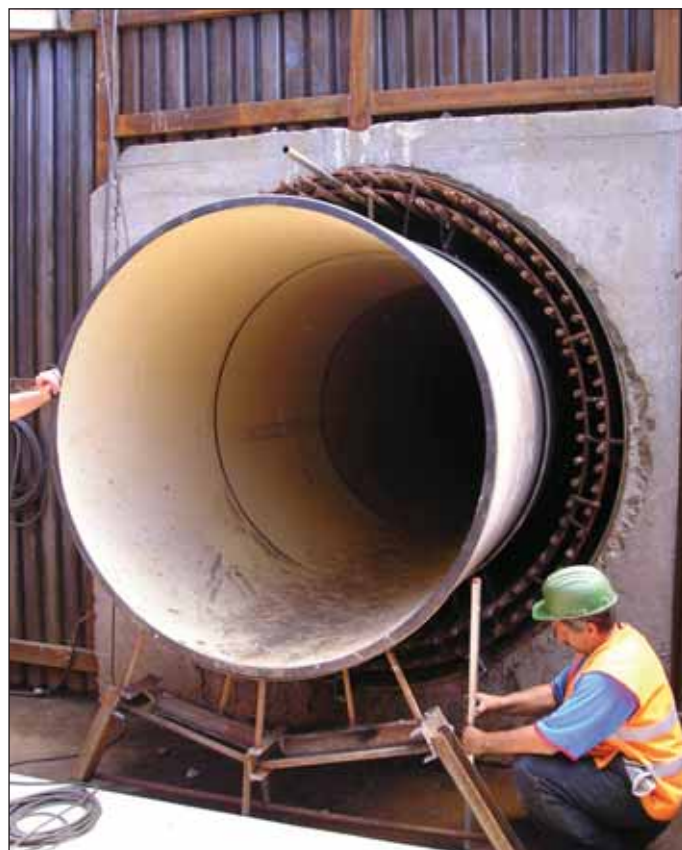
Obr. 4 Pohled z cílové šachty na vystrojování dokončeného protlaku ocelového potrubí DN 2340 potrubím HOBAS DN 1600 SN 10 000 včetně osazeného armokoše a trubky pro doinjektování vrchlíku profilu
