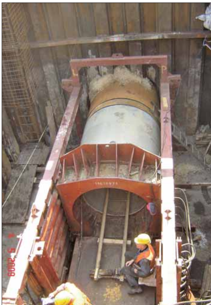
Obr. 5 Protlačecí 12pístová souprava osazená ve startovací šachtě včetně předštitku a první zatlačené železobetonové roury DN 1600
