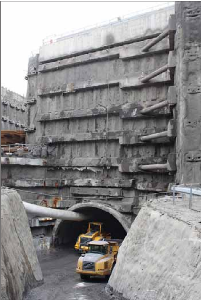
Obr. 3 Portál vzduchotechnického kanálu v jámě Myslbekova Fig. 3 Ventilation duct portal in the Myslbekova construction pit
