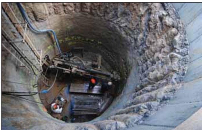
Obr. 3 Pohled do šachty při hloubení vrtů pro osazení injekčních trubek Fig. 3 View down the shaft during the installation of boreholes for grouting pipes
