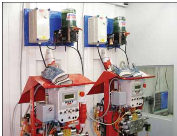
Obr. 9 Pohled na část injektční stanice Obermann, která flexibilně zvládala požadavky na proměnná zadání injektážních parametrů
