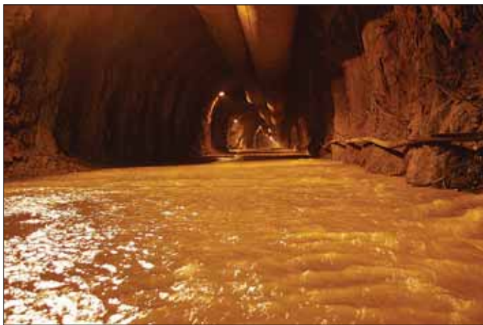
Obr. 1 Island: Řeka v tunelu (archiv Metrostav a. s.)
