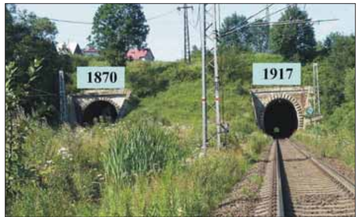
Obr. 1 Tunel Jablunkov – historické tunely, pohled na jižní portál Fig. 1 Jablunkov tunnel – historic tunnels, a view of the southern portal
