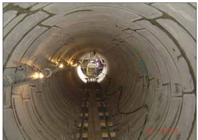
Obr. 3 Pohled do vyražené štoly zajištěné ostěním z betonových segmentů směrem k těžní šachtě, odtěžení rubaniny pomocí kolejové strojní dopravy Fig. 3 A view down the excavated gallery toward the hoisting shaft; the gallery is lined with concrete segments; muck removed by rail-bound machine transport
