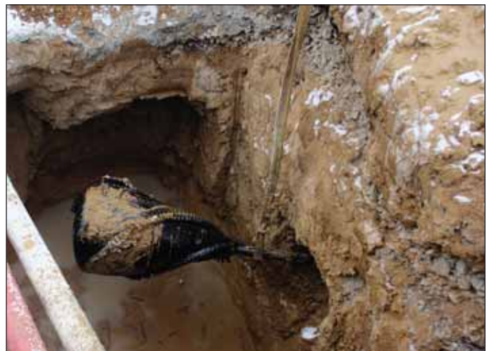
Obr. 8 Nasazení rozšiřovací hlavy DN 920 na kolonu vrtacích tyčí v cílové šachtě
