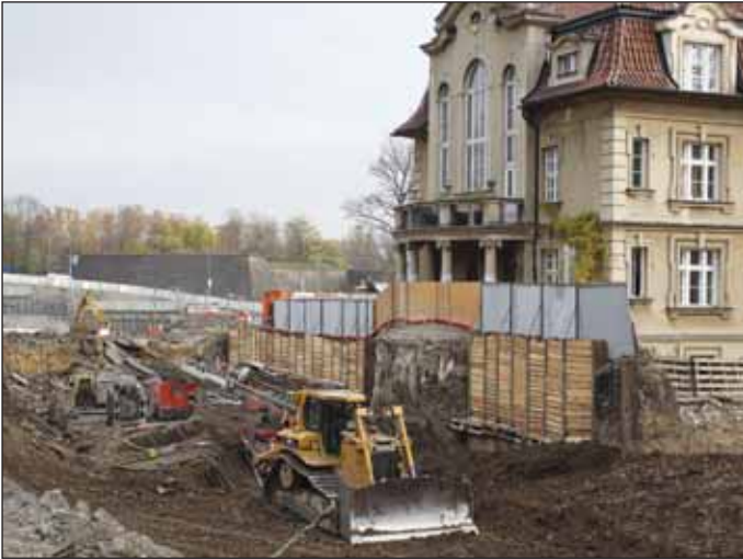
Obr. 1 Zajistění stavební jámy Patočkova pro hloubené tunely SAT 2B Fig. 1 Stabilisation of the Patočkova Street construction trench for SAT 2B cut and cover tunnels
