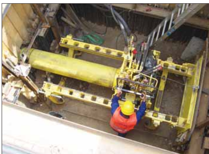
Obr. 6 Vrtací stroj PERFORATOR PBA 150 osazený ve startovací šachtě, použití výpažnic pro vrtání profilu DN 400
