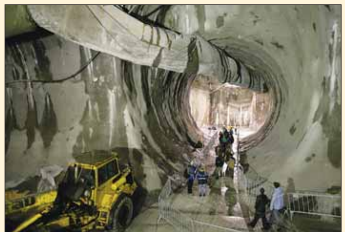
Obr. 2 Tunel Blanka – Den otevřených dveří: Pohled z STT přes propojku č.13 do JTT Fig. 2 Community open day: A view from the NTT, through cross passage No. 13, into the STT
