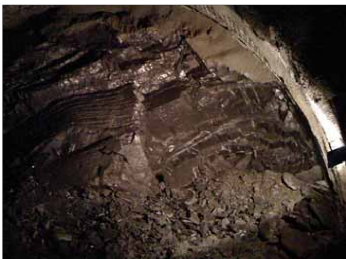
Obr. 5 Čelba tunelu Blanka
