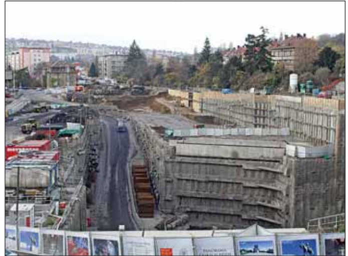
Obr. 2 Stavební jáma Myslbekova a staveniště hloubených tunelů Patočkova Fig. 2 The Myslbekova Street construction pit and the construction site for Patočkova Street cut-and-cover tunnels
