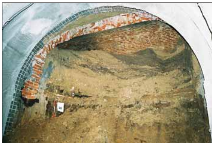
Obr. 3 Pohled na proražený barokní sklep (10. stavba kolektoru náměstí Svobody; foto Archaia Brno)
