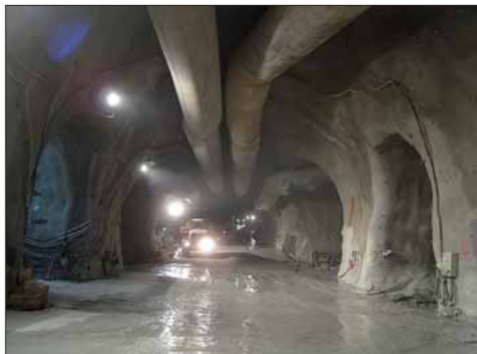
Obr. 5 Ražba kaverny konvenční metodou pro záchranu stroje
