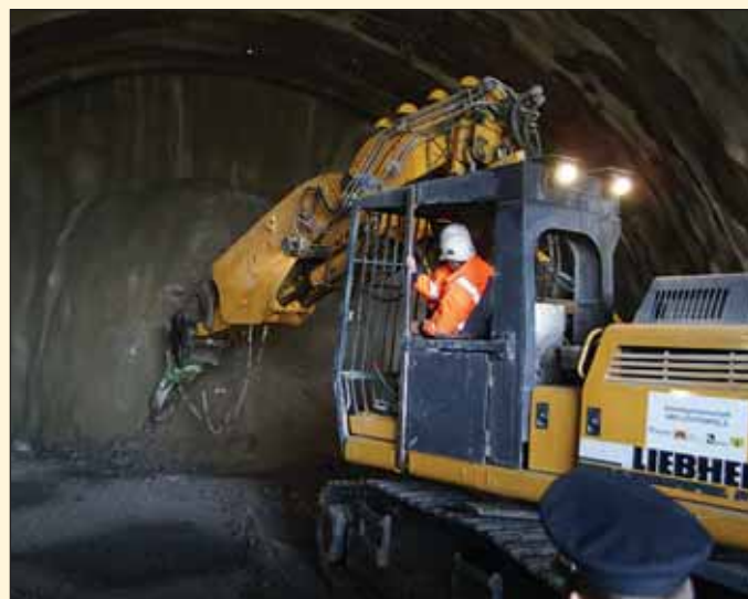
Obr. 11 Zahájení ražby tunelu Kulch patronkou tunelu Fig. 11 Commencement of the Kulch tunnel excavation by the tunnel patron
