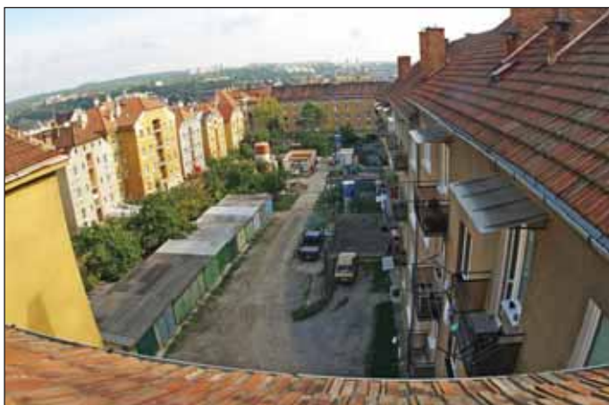
Obr. 1 Pohled na objekty bloku bytových domů, vybraných pro zabezpečení metodou kompenzační injektáže
