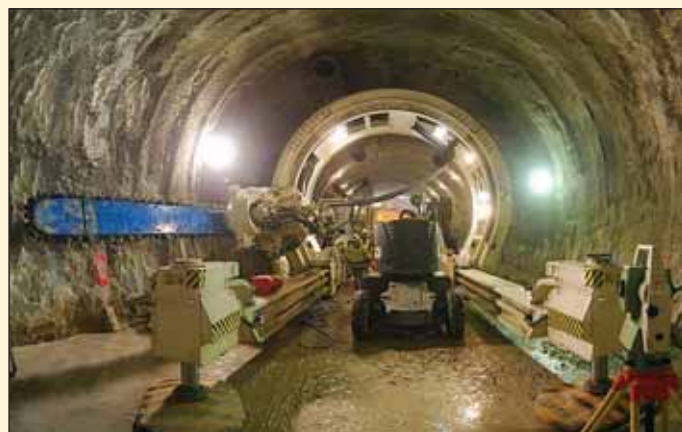
Obr. 3 Vrubovací stroj Fig. 3 Pre-vault tunnelling machine
