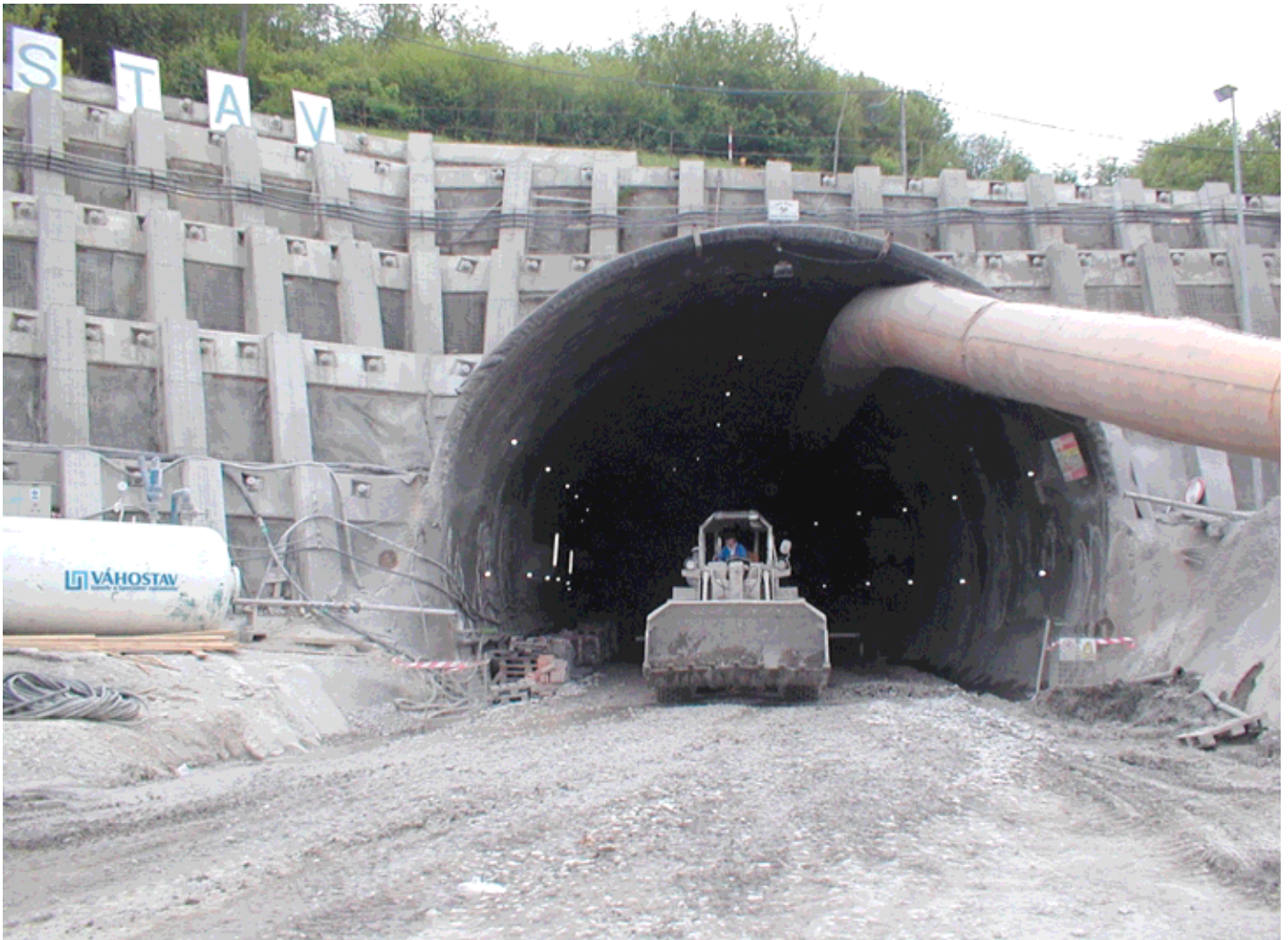
Obr. 6 Tunel Horelica v primárnej výstuži - portál Čadca Fig. 6 The Horelica tunnel with primary lining – the Čadca portal
