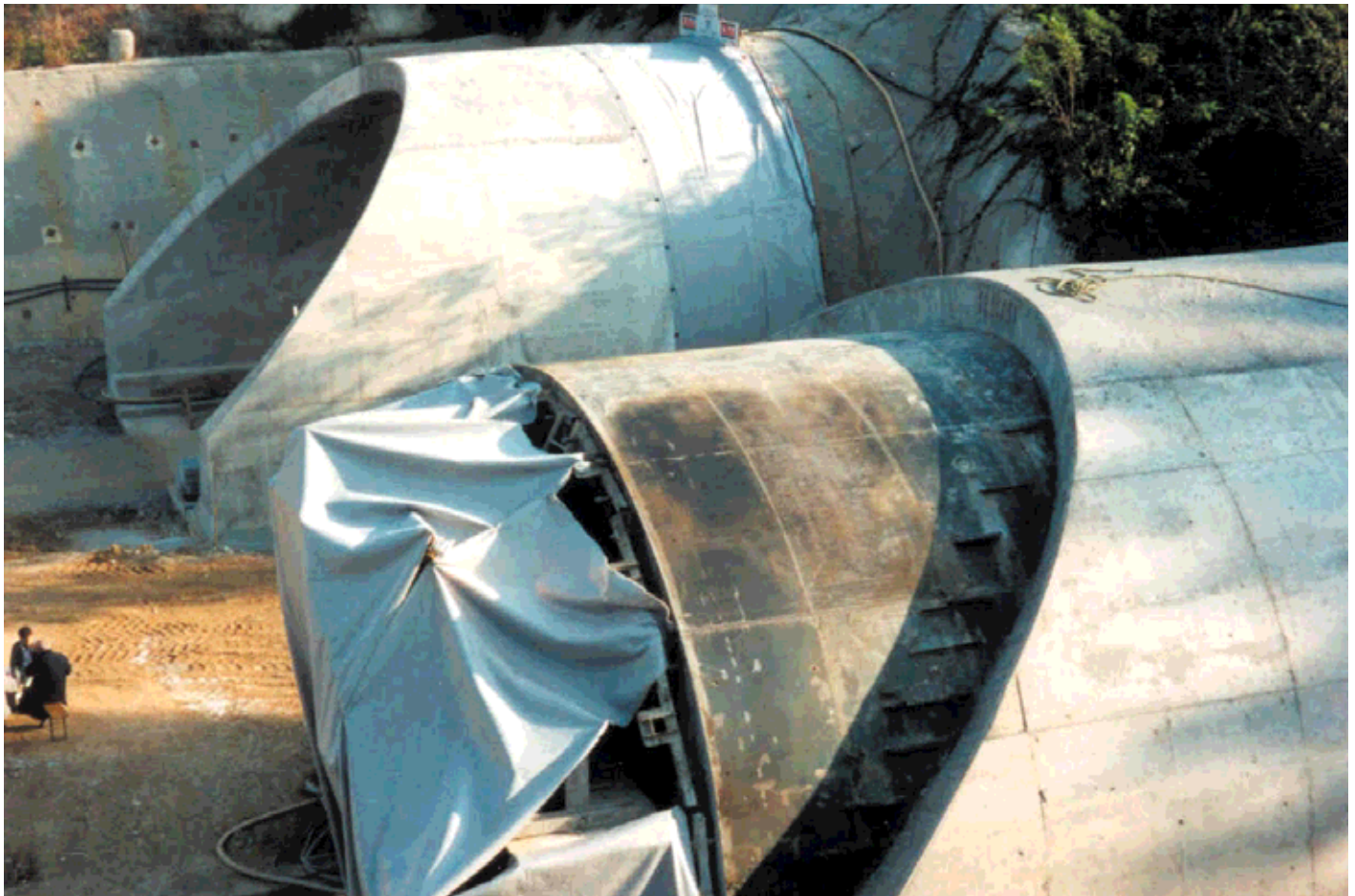
Obr. 7 Pohled na severní portály po dokončení betonáže
