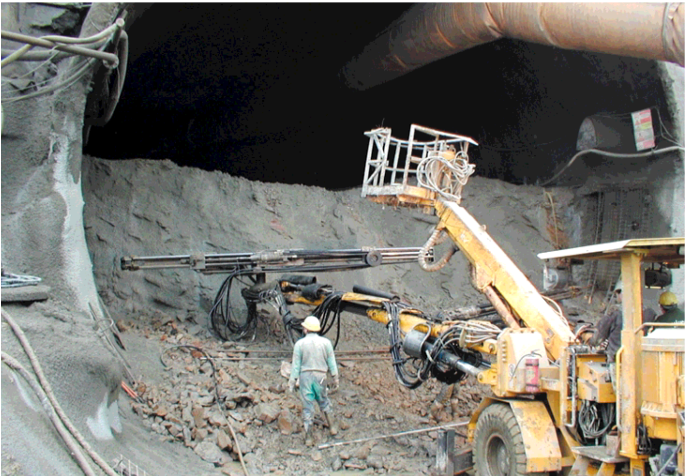
Obr. 5 Začiatok razenia lavice a dna z portálu Čadca Fig. 5 Beginning of the bench and invert excavation from the Čadca portal
