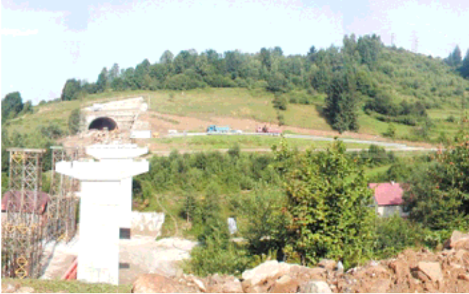
Obr. 4 Panoráma žilinského portálu Fig. 4 Panorama of the Žilina portal
