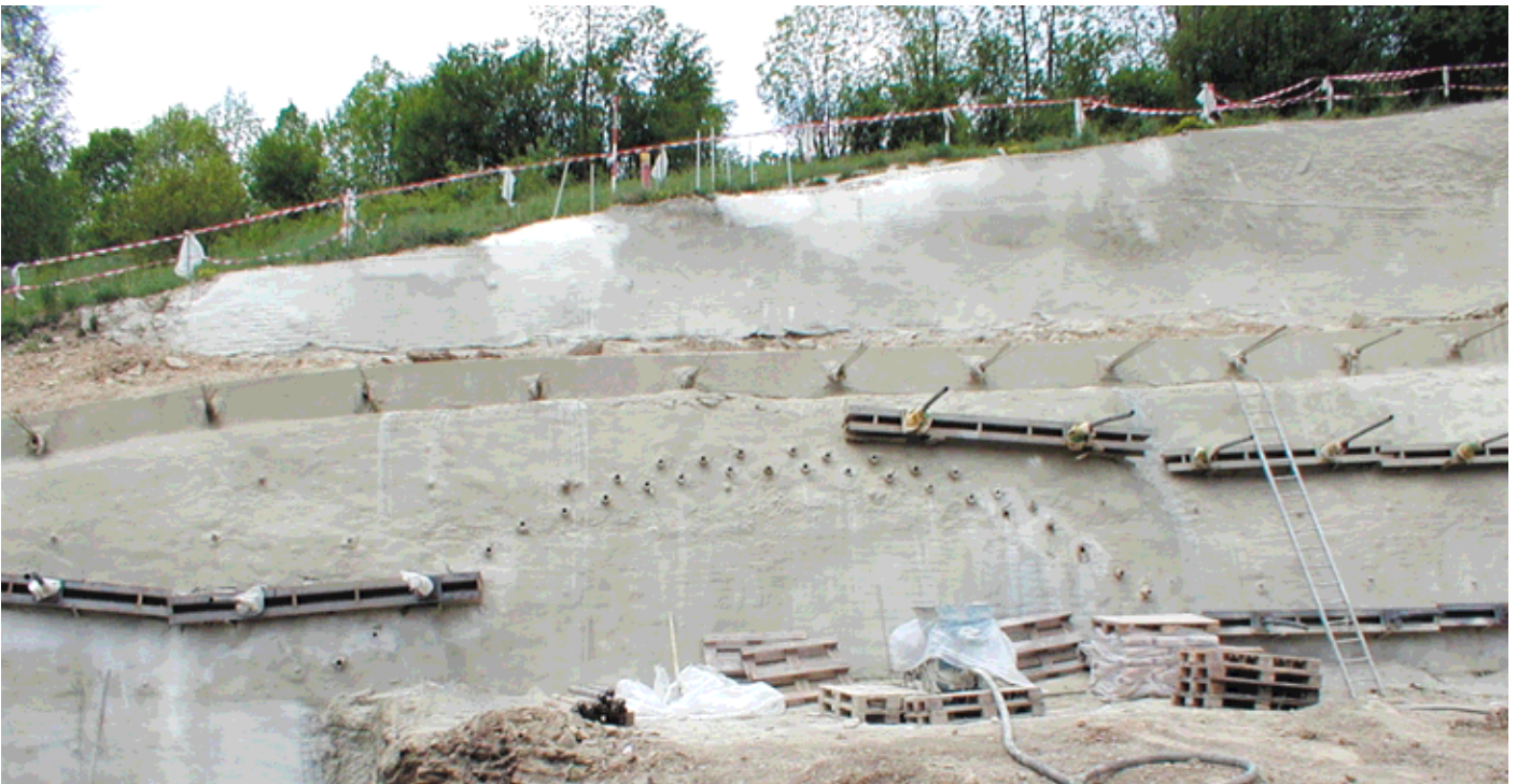
Obr. 4 Dvojradowý mikropilótvý dáždník portálu Žilina tunela Horelica Fig. 4 Double-row micropile umbrella of the Žilina portal of the Horelica tunnel
