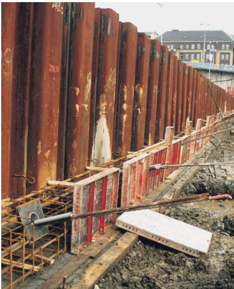
Obr. 2 Štětová stěna s přípravou armokošů Fig. 2 Sheet-pile wall with reinforcement cages
