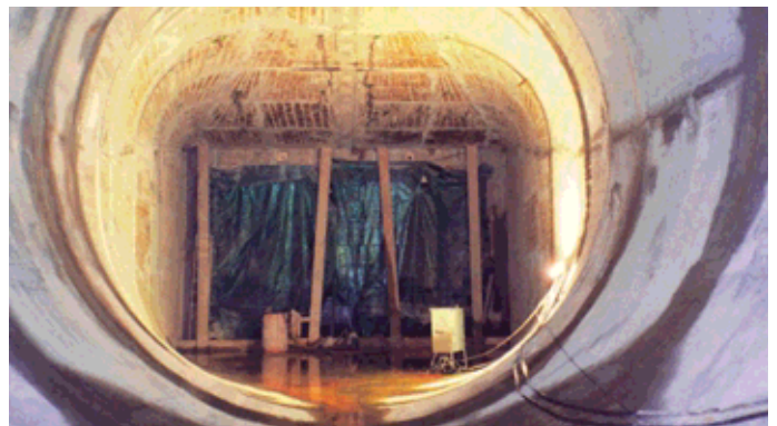
Obr. 10 Zabetónovaný prvý blok od saviek (blok č. 1 - prechod z obdĺžnikového do kruhového profilu) Fig. 10 The first block concreted from draught tubes (block no. 1 – conversion from rectangular to circular profile)
