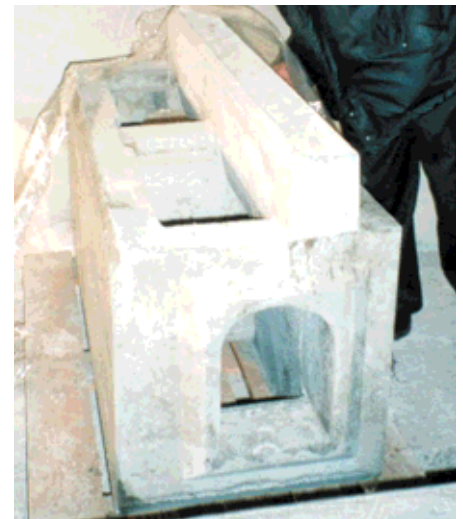
Obr. 12 Prefabrikát horní části syfonu šterbinové odpadní roury s normou stěnou
