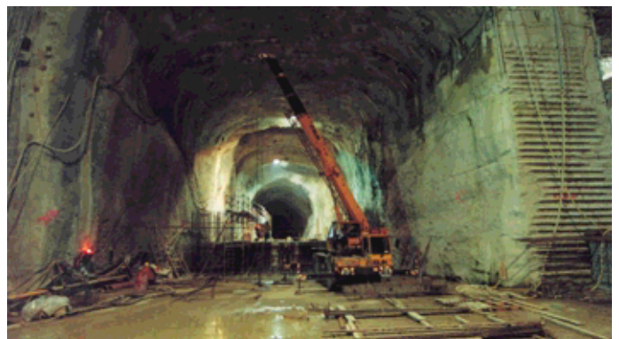
Obr. 11 Pohľad z dolnej nádrže do výtokového objektu. V klenbe vidieť hradidlovú šachtu Fig. 11 View from lower basin into the outlet structure. The gate shaft can be seen in the vault
