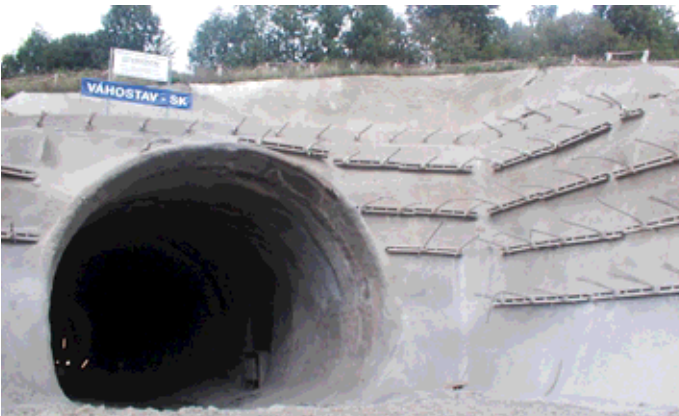
Obr. 5 Kompletné zabezpečenie žilinského portálu tunela Horelica – tunel v primárnej výstuži pred profilovaním Fig. 5 Complete support of the Žilina portal of the Horelica tunnel – tunnel before profiling, supported by primary lining.
