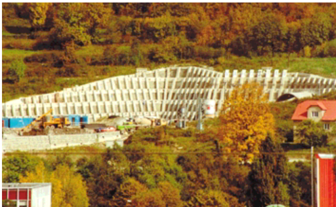
Obr. 2 Kompletné zaistenie portálu Čadca tunela Horelica Fig. 2 Complete support of the Čadca portal of the Horelica tunnel
