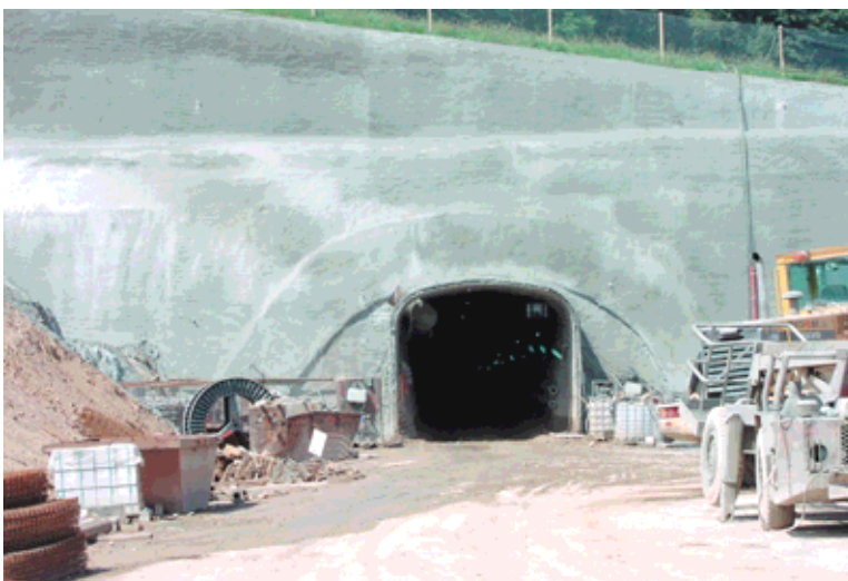
Obr. 4 Jižní portál Fig. 4 Southern portal
