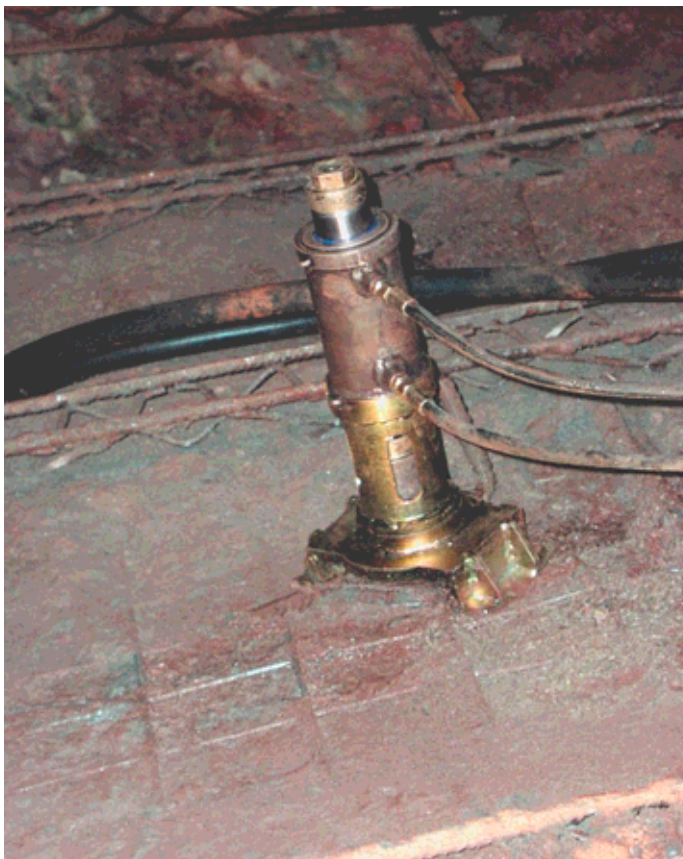
Obr. 2 Provádění tahových zkoušek hydraulicky upínaných svorníků typ BOLTEX 12 Fig. 2 Execution of pull-out tests of the hydraulically expanded rockbolts of BOLTEX 12 type
