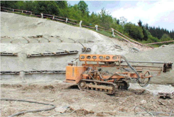
Obr. 3 Zabezpečenie portálu Žilina lanovými kotvami Fig. 3 Support of the Žilina portal by cable anchors
