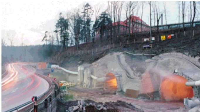
Obr. 1 Východný portál tunela Gäubahn Fig. 1 The Gäubahn tunnel portal East
