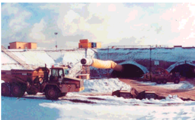
Obr. 6 Tunel Dölszchen – severný portál Fig. 6 The Dölszchen tunnel – North portal
