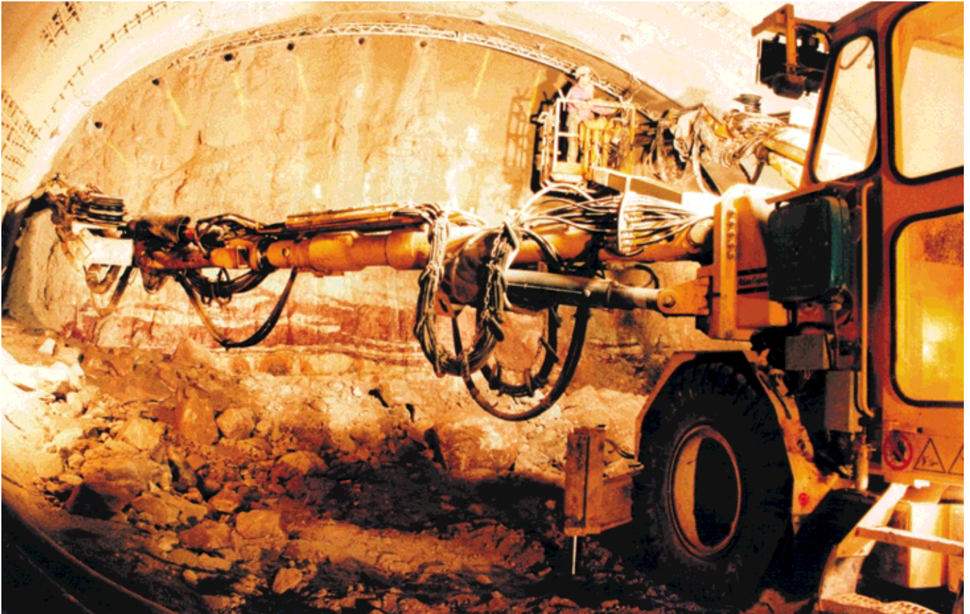
Obr. 4 Čelba tunela Gäubahn s vývrtmi pre mikropilóťový dáždnik Fig. 4 The Gäubahn tunnel face with holes drilled for the micropile umbrella
