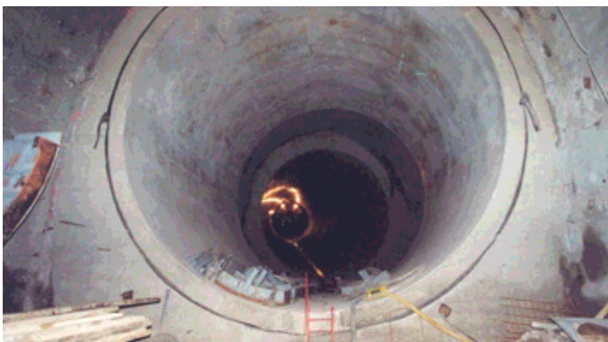
Obr. 9 Pohľad z ešte nazabetonovanej rozdeľovacej komory do spodnej výtokovej chodby. Za blokom č. 7 vidieť vynechaný blok č. 8 s 3D zakrivením Fig. 9 View from not yet concreted bifurcation chamber into the tailrace tunnel. Behind the block no. 7 the skipped block no. 8 with the 3D curve is visible
