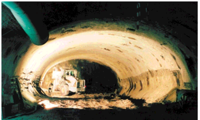
Obr. 3 Úsek kaloty s protiklenbou tunela Gäubahn v mieste s nízkym nadložím (4,5 m) Fig. 3 A top heading section with invert of the Gäubahn tunnel in a location with low cover (4.5 m)
