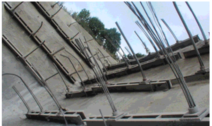
Obr. 6 Lanové kotly s horizontálnymi oceľovými roznášacími prahmi – portál Žilina tunela Horelica Fig. 6 Cable anchors with horizontal steel spreading sills – the Žilina portal of the Horelica tunnel
