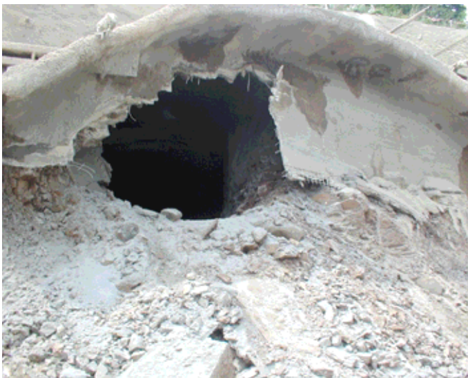
Obr. 7 Prerážka kalotou do žilinského portálu Fig. 7 Top heading breakthrough to the Žilina portal
