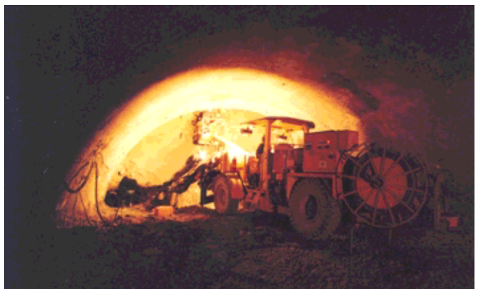
Obr. 3 Príprava trhacích prác v kalote Fig. 2 Preparation of blasting in the top heading
