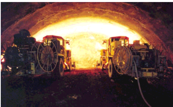
Obr. 9 Súbežné nasadenie dvoch vrtných vozov v kalote
