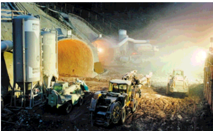
Obr. 2 Priestor pred východným portálom slúžil na medziskládku vyťaženej horniny Fig. 2 The area in front of the portal East was used as an intermediate stockpile of muck
