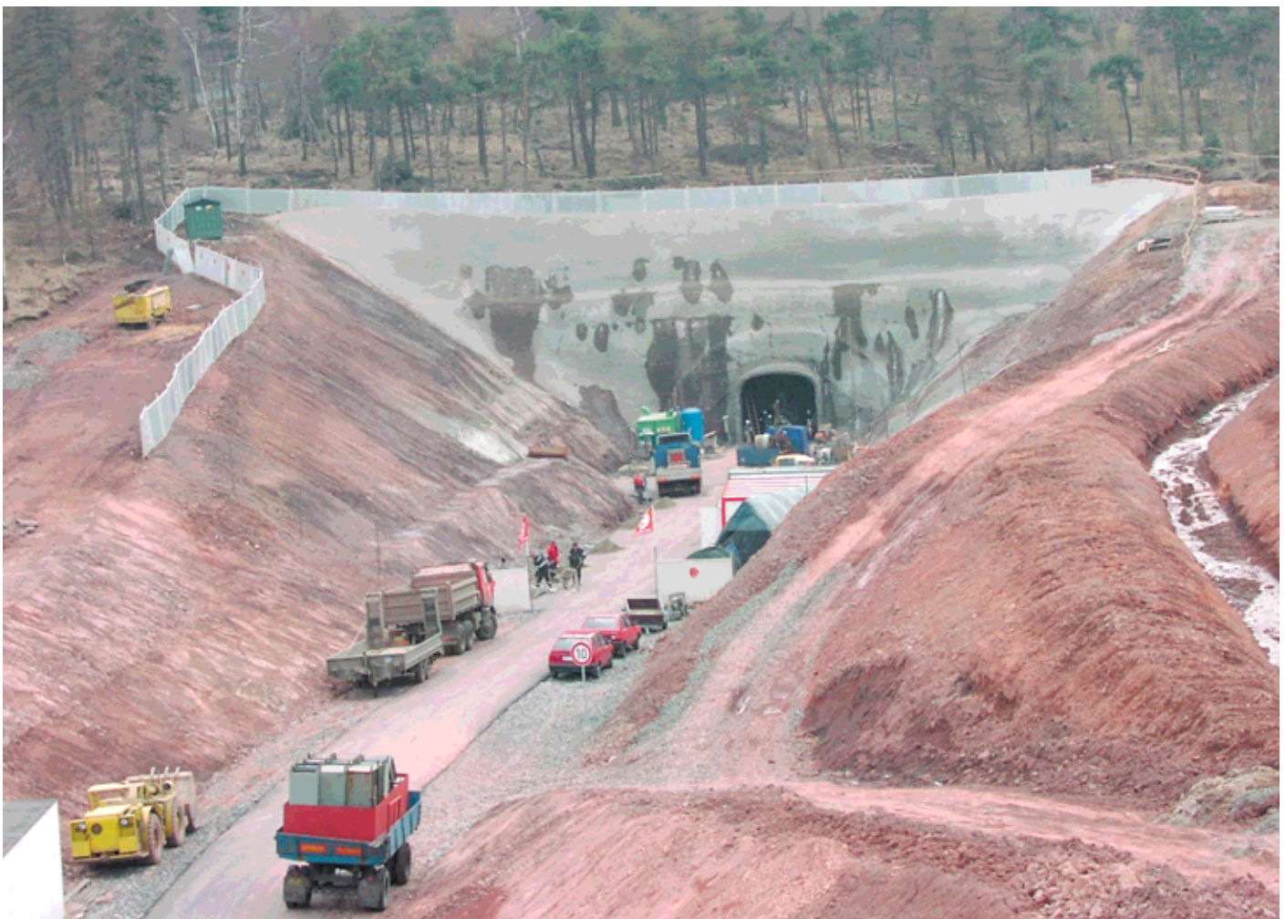
Obr. 1 Severní portál Fig. 1 Northern portal
