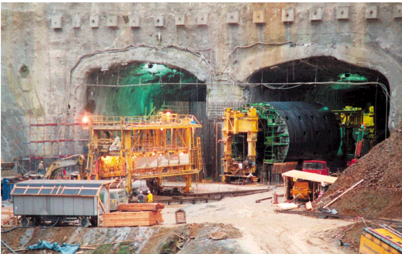
Obr. 12 Pohľad na severný a južný výtokový objekt s armovacím a debniacim vozom
