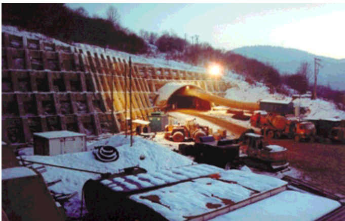
Obr. 1 Portál južnej tunelovej rúry a stavebný dvor v Čadci. Vyrazená zatiaľ iba kalota
