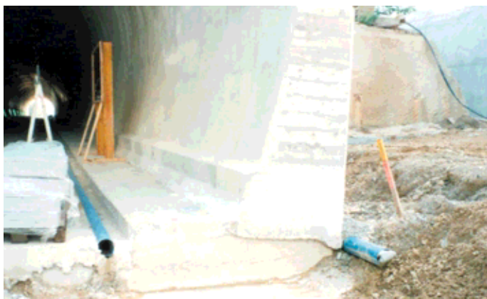
Obr. 10 Pohled na tunelovou drenáž u portálu (vpravo) a odvodnění vrstev vozovky (vlevo) Fig. 10 View of the tunnel drainage at a portal (right), and drainage of the sub-base courses (left)
