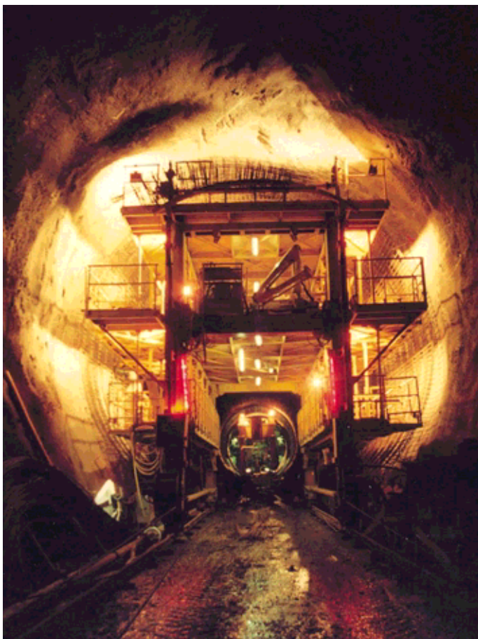
Obr. 2 Armovací voz spodných výtokových chodieb Fig. 2 Reinforcement installation platform for the tailrace tunnels
