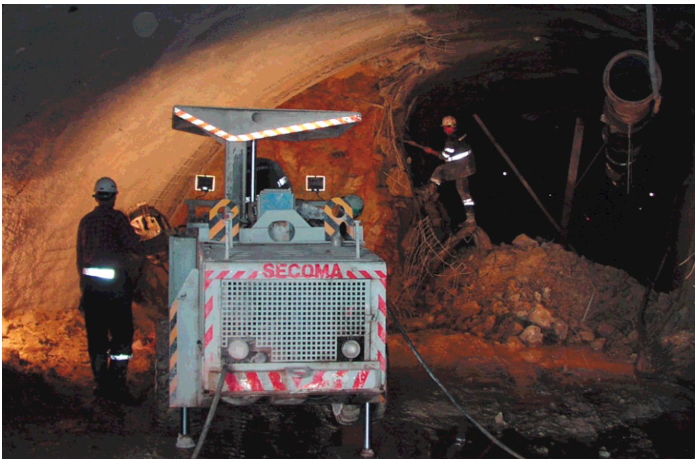
Obr. 3 Rozšíření severní průzkumné štoly na profil budoucí kaloty velkého tunelu Fig. 3 Expansion of the northern exploratory gallery into future large tunnel calotte profile
