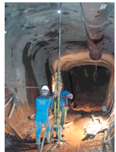
Obr. 5 Vrtání vějíře pro presiometrické zkoušky Fig. 5 Boring of a fan for pressiometric tests
