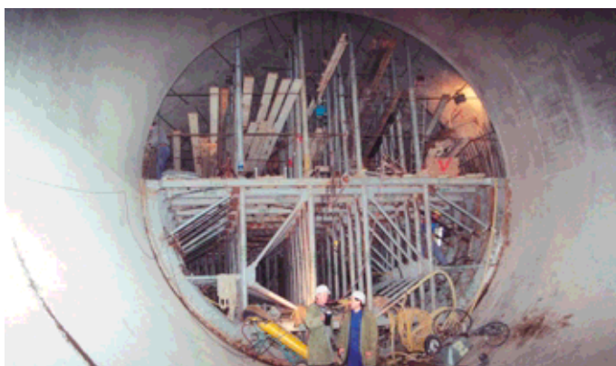
Obr. 7 Pohľad z bloku č. 8 na zabetónovanú spodnú polovicu rozdeľovacej komory (blok č. 6). Fig. 7 View from block no. 8 on the concreted lower half of the bifurcation chamber (block no. 6)
