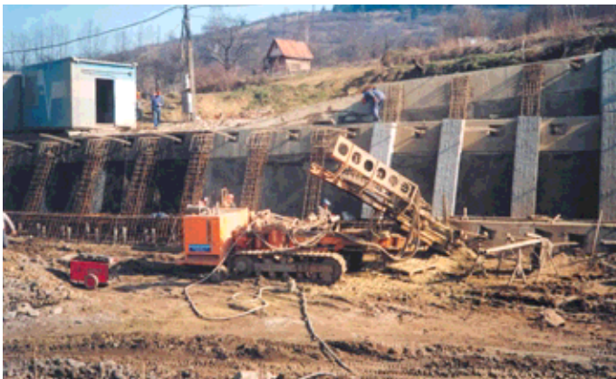
Obr. 1 Kotvenie štvrtého horizontálneho prahu zabezpečenia portálu Čadca Fig. 1 Anchoring of the fourth horizontal sill of the Čadca portal support
