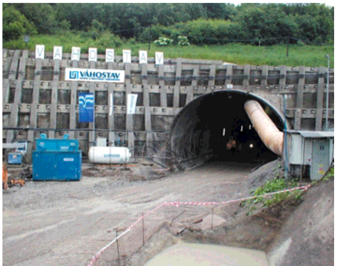
Obr. 8 Portál tunela Horelica v Čadci Fig. 8 The Horelica tunnel portal in Čadca
