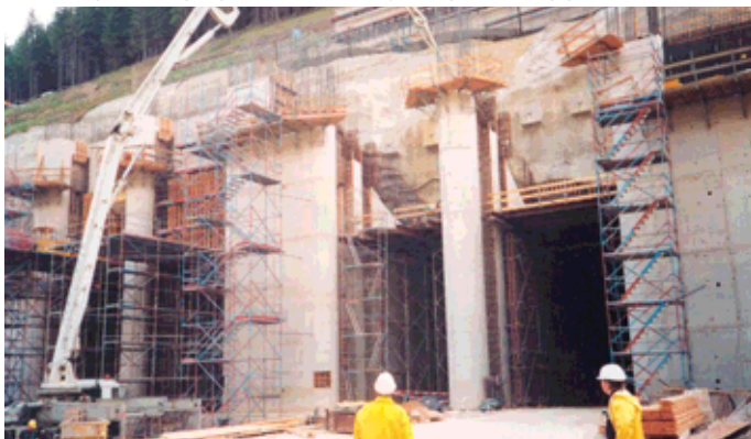
Obr. 13 Betonáž južného výtokového objektu Fig. 13 Concrete placement of the southern outlet structure
