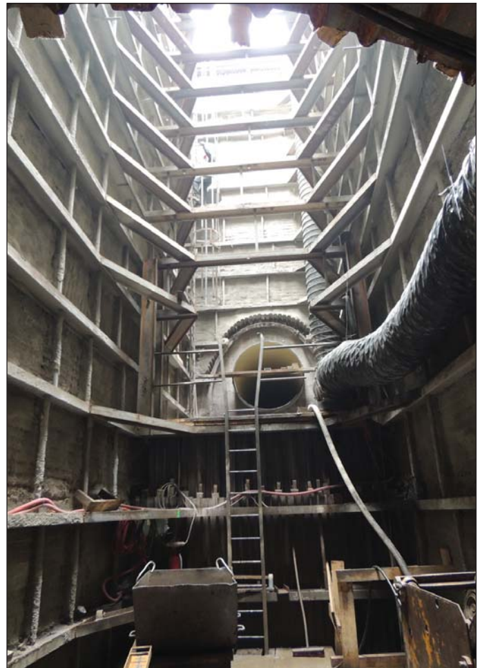
Obr. 13 Stoka CO3, šachta Š03.6, spadišťový stupeň (Ivan Šalka, Energie – stavební a báňská a.s.)
