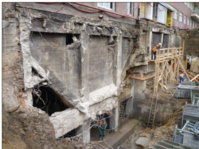
Obr. 4 Bourání suterénu č. p. 105, ul. Patočkova, Praha (Ivan Šalka, Energie – stavební a báňská a.s.)
