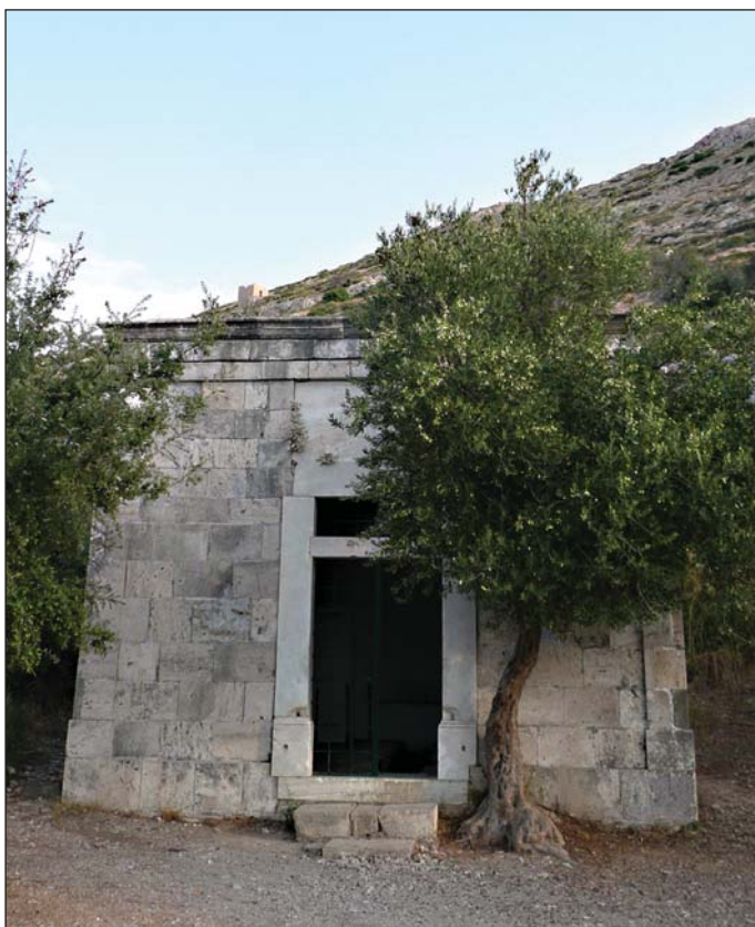
Obr. 8 Jižní vstupní portálek nad přístupovou chodbou do tunelu/štol Fig. 8 The southern little access portal above the access adit to the tunnel
