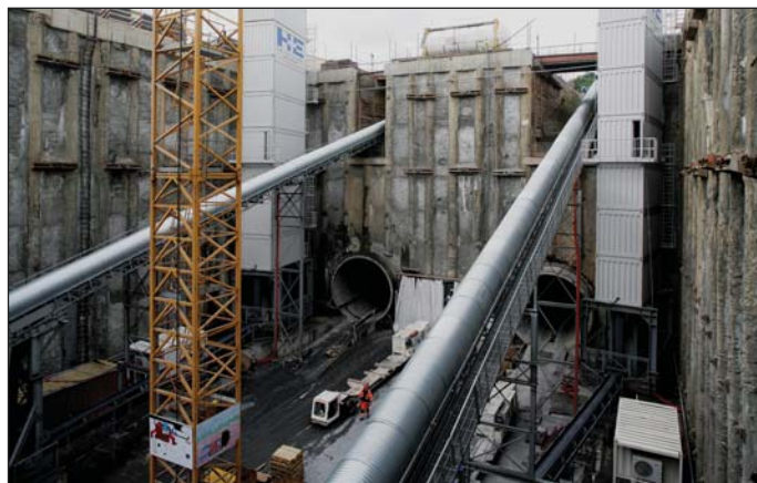
Obr. 2 Cesty logistiky technologie EPBS ve stavební jámě E2 (foto: Husák)
