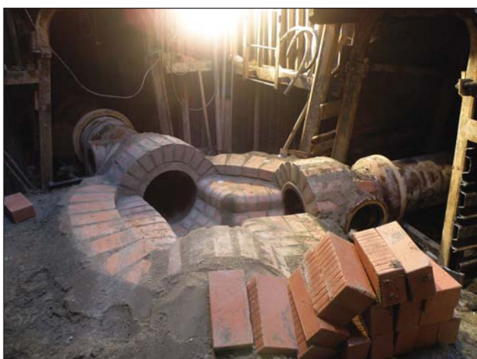
Obr. 3 Ražené stoky O11 a O12, spojná šachta Š 011.4, propoj KT DN300, DN400, ul. Nad Vojenskými hřbitovy (Ivan Šalka, Energie – stavební a báňská a.s.)
