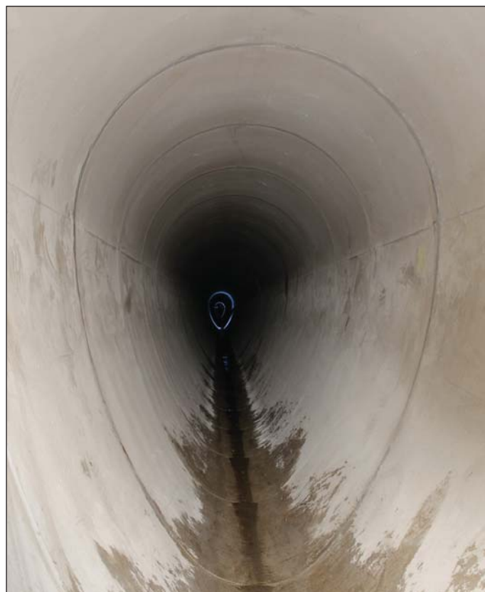
Obr. 5 Finální podoba kanalizačního sběrače na stavbě Rybníček Fig. 5 Final shape of the main sewer on the Rybníček construction site
