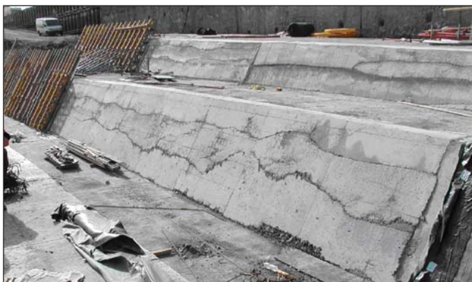
Obr. 13 Nevhodný podklad pod izolaci Fig. 13 Improper waterproofing layer substrate
