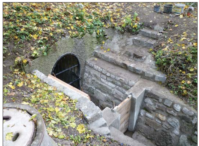
Obr. 11 Nový Svět, sanace objektů pod Mariánskými hradbami (Dušan Hora, Energie – stavební a báňská a. s.)
