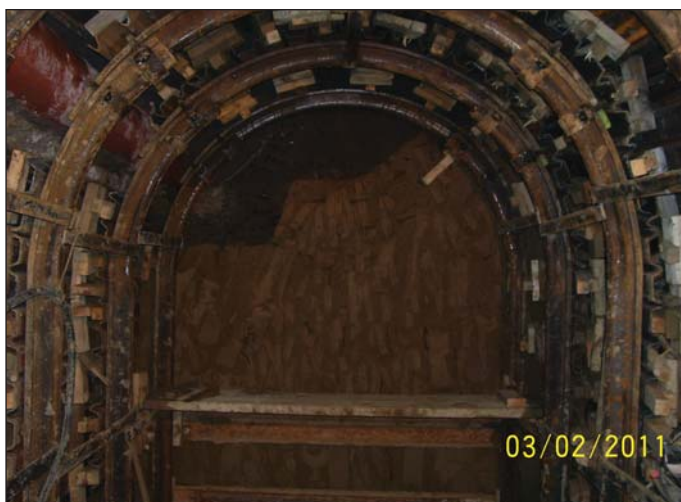
Obr. 2 Rybníček, čelba – vlevo nahoře provizorně propojená stávající kanalizace Fig. 2 Rybníček, excavation face – a temporarily interconnected existing sewer pictured in the top left corner
