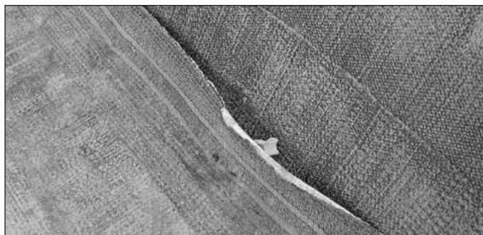
Obr. 12 Nekvalitně provedené napojení izolací umožňující vtečení betonové směsi do spoje Fig. 12 Shoddy workmanship on a joint between waterproofing mats making the flowing of concrete mix into it
