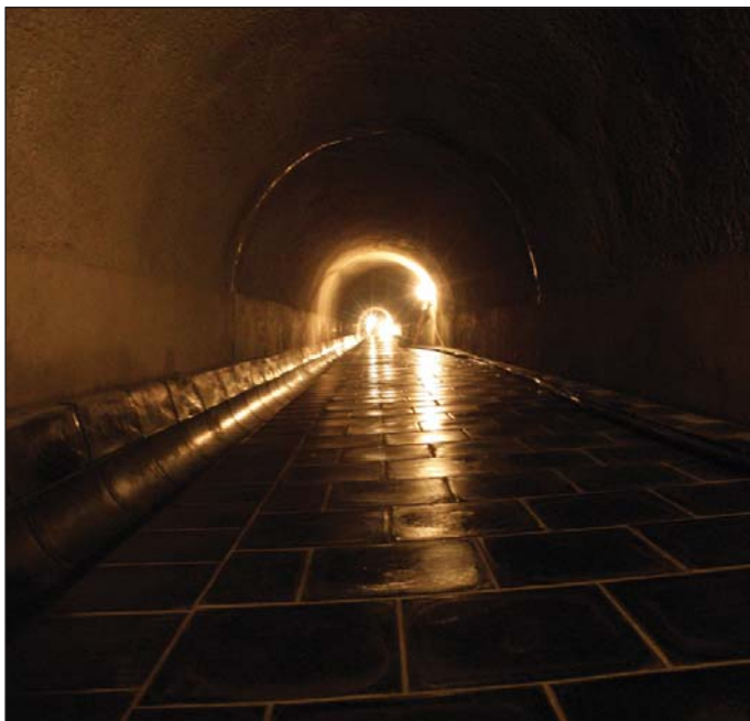
Obr. 5 Pohled do dokončeného díla s dlažbou a žlábkem z taveného čediče – výrobky firmy Eutit s. r. o. (Ivan Šálka)
