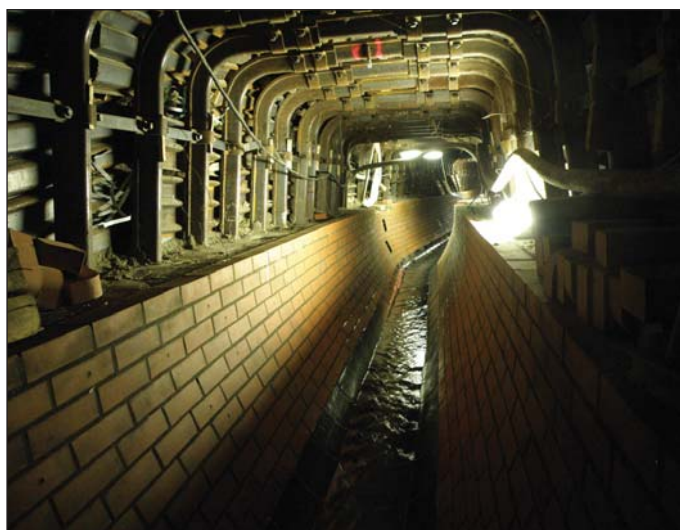
Obr. 8 Přeložka potoku Brusnice, profil 1895x1100 mm, provizorní stav, ul. Patočkova, (Ivan Šalka, Energie – stavební a báňská a.s.)
