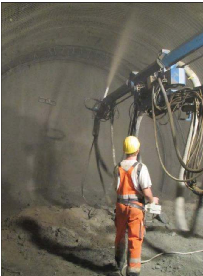
Obr. 2 Nástřik betonové směsi 6a Fig. 2 Spraying of mixture 6a
