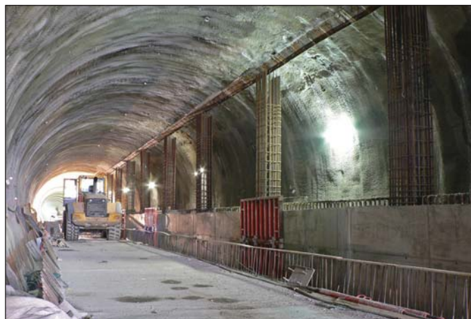
Obr. 6 Provádění definitivního osídlení v trojlodní stanici Veleslavín (foto: Chotár)
