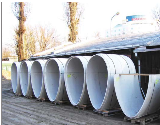
Obr. 3 Polymerbetonové dílce DN 1400 na 2100 mm na stavbě Rybníček Fig. 3 Polymer concrete segments DN 1400/2100 mm on Rybníček construction site
