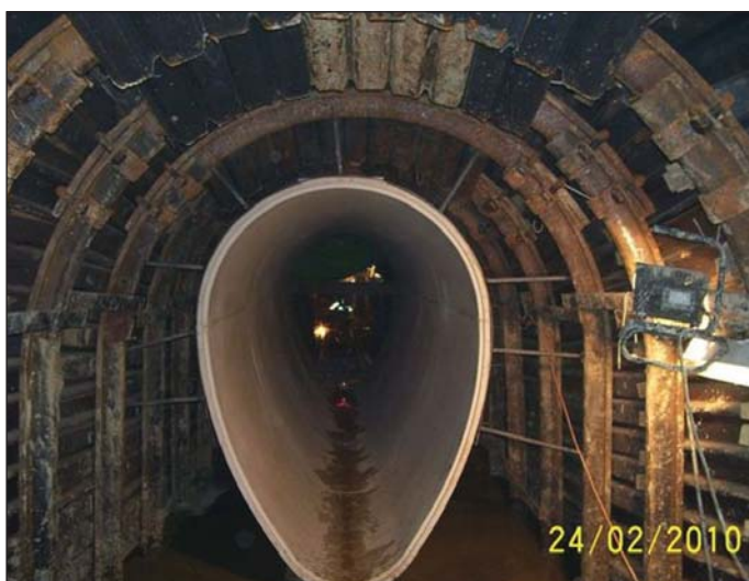
Obr. 4 Rooseveltova, zafixování polymerbetonových dílců ve štolu Fig. 4 Roosevelt Street, polymer concrete segments fixed in the tunnel
