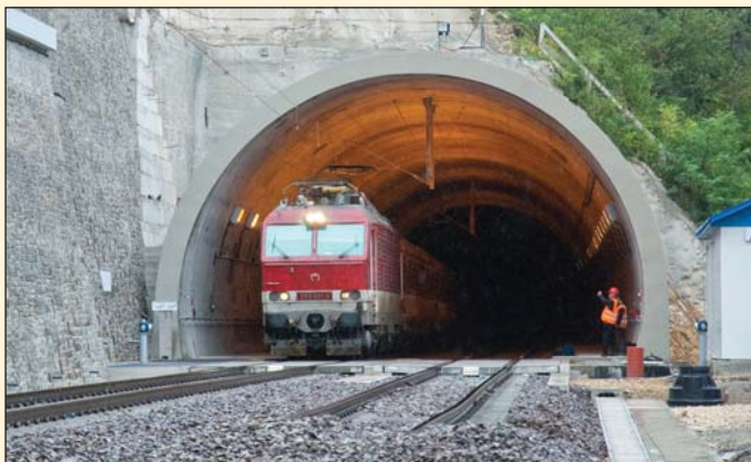
Obr. 1 Južný portál tunela Turecký vrch (foto Juraj Michalka) Fig. 1 Southern portal of the Turecký Vrch tunnel (photo courtesy of Juraj Michalko)
