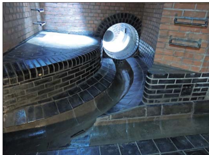
Obr. 6 Zaústění spadiště do spojné komory (Ivan Šálka)
