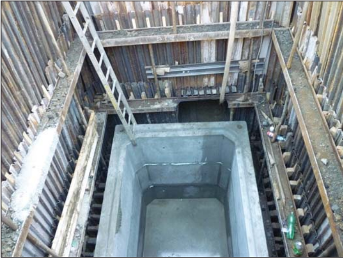
Obr. 9 Provizorní čerpací stanice (Dušan Hora, Energie – stavební a báňská a.s.) Fig. 9 Temporary pumping station (Dušan Hora, Energie – stavební a báňská a.s.)
