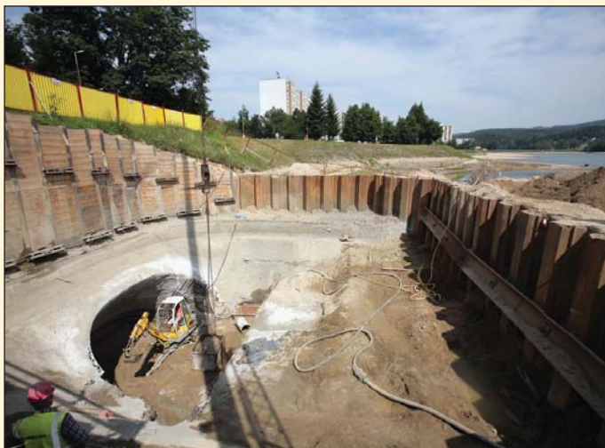
Obr. 1 Protipovodňová opatření Jablonec nad Nisou – výstavba vtokového objektu (foto Josef Husák)
