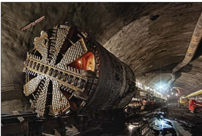
Obr. 1 Zeminový štít Adéla při průtahu a odpočinku ve stanici Červený Vrch (foto: Tatar)
