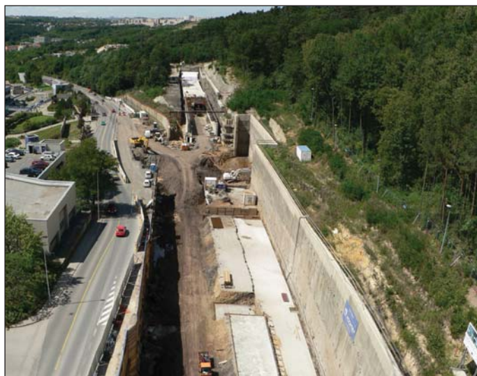
Obr. 4 Staveniště hloubené stanice Motol z nahledu (foto: Chotár)
