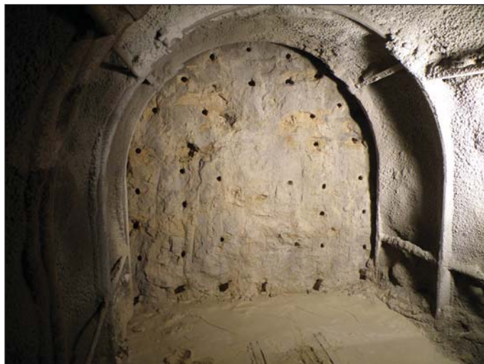
Obr. 4 Čelba ražby navrtaná podle vrtného schématu (Ivan Šálka) Fig. 4 Excavation face with drill holes carried out according to a drill pattern (Ivan Šálka)
