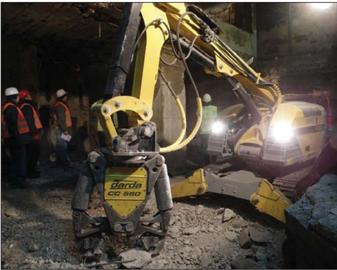
Obr. 5 Bourací stroj BROKK 400, nasazení v suterénu č. p. 105, ul. Patočkova, Praha (Ivan Šalka, Energie – stavební a báňská a.s.)
