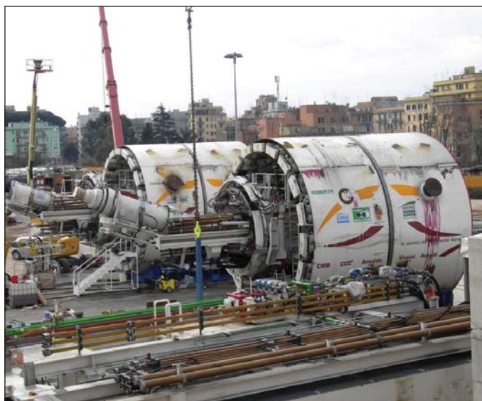
Obr. 2 Dva zeminové štíty během montáže na stavbě Malatesta Fig. 2 Two EPB shields during the assembly on Malatesta construction site
