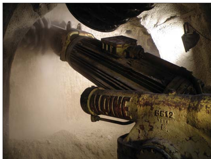
Obr. 3 Ražba štoly tunelovou frézou ALPINE F6A (Ivan Šálka) Fig. 3 Tunnel excavation using ALPINE F6A roadheader (Ivan Šálka)
