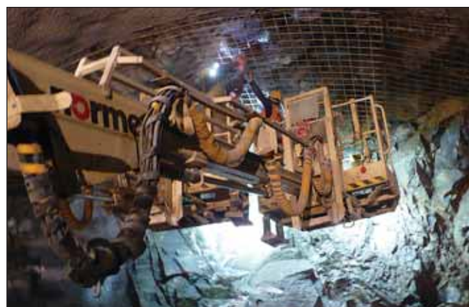
Obr. 5 Osazování výztužných sítí primárního ostění – důlní plošina Normet Himec 9905BT Fig. 5 Installation of welded mesh reinforcing the primary lining – a Normet Himec 9905BT platform lifter
