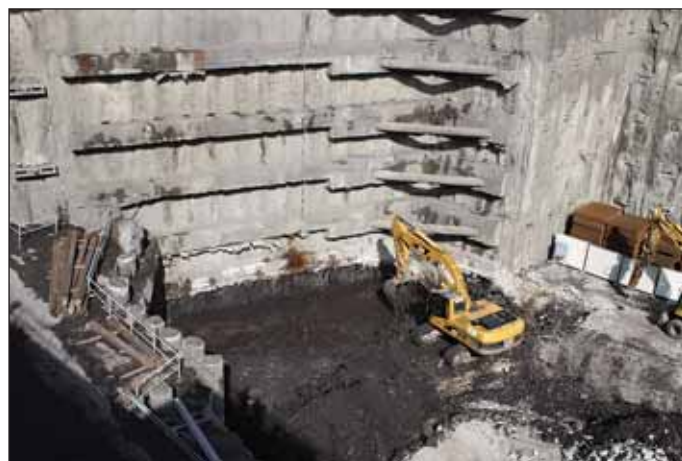
Obr. 2 Staveniště Myslbekova, hloubení dna jámy pro ražbu vzduchotechnického kanálu Fig. 2 Myslbekova construction site – digging the pit bottom for the excavation of a ventilation duct
