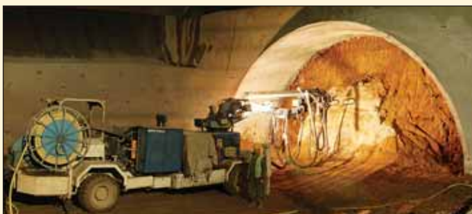
Obr. 5 První záběr kaloty od vjezdového portálu Fig. 5 First round of excavation from the entrance portal
