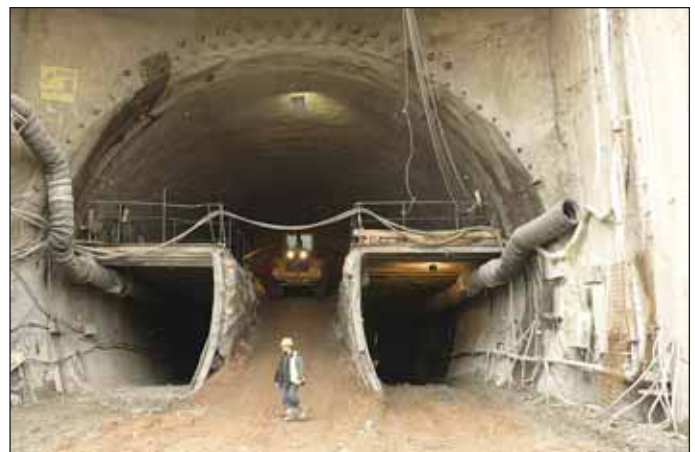
Obr. 7 Pohled na provizorní portál Královo pole ze dne 5. 3. 2008
