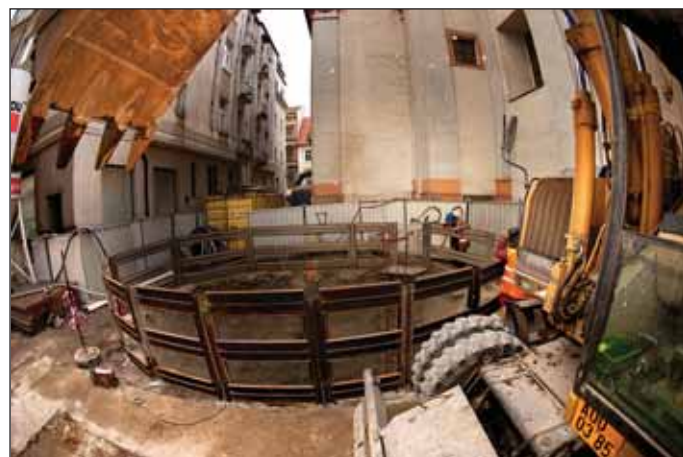
Obr. 2 Staveniště bylo těsné zejména těžké technice Fig. 2 The site was too small first of all for heavy equipment
