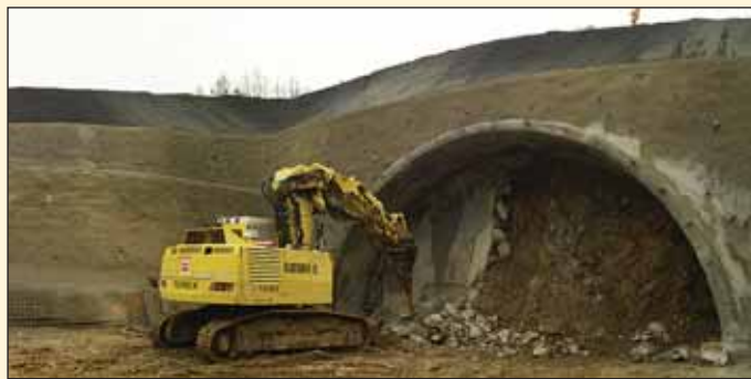
Obr. 2 Zahájení ražby od výjezdového portálu Fig. 2 Commencement of excavation from the exit portal
