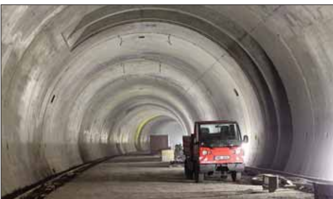
Obr. 12 Ražený tunel Královská obora, definitivní ostění ve dvoupruhovém tunelu Fig. 12 Královská Obora mined tunnel – final lining in the double-lane tunnel
