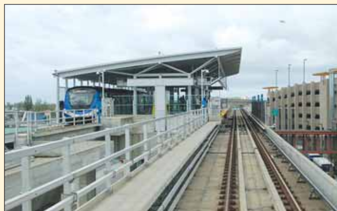
Obr. 3 Metro Canada Line – stanice na estakádě
