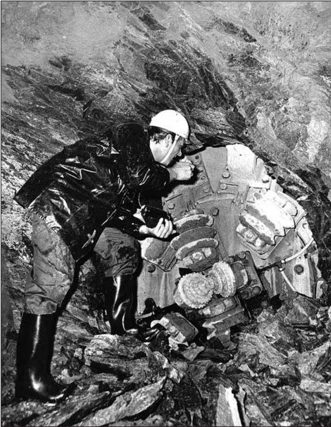
Obr. 2 Tunelovací stroj Demag při prorážce štoly v Prosečnicích Fig. 2 DEMAG tunnelling machine holing through in Prosečnice
