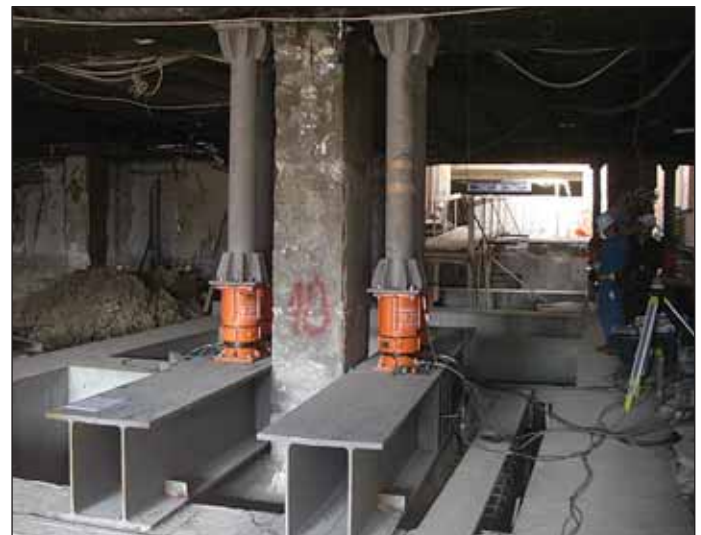
Obr. 3 Podchyťovanie (základová päťka č. 10) Fig. 3 Underpinning (Foundation No. 10)
