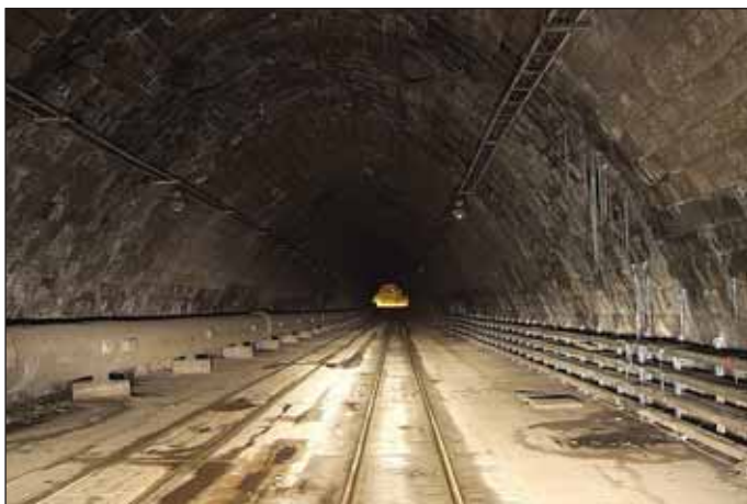
Obr. 3 Interiér tunela pred rekonštrukciou (foto M. Dekánek, 2009) Fig. 3 Tunnel interior before reconstruction (Photo courtesy of M. Dekánek, 2009)
