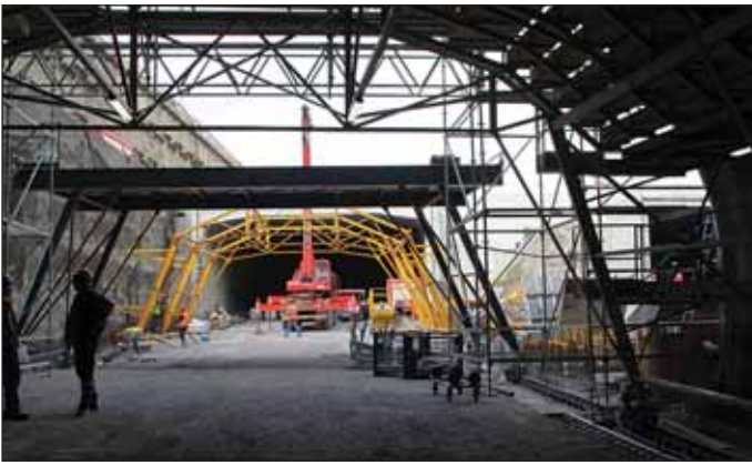
Obr. 7 Staveniště Letná, plošiny pro montáž výztuže klenby definitivního ostění Fig. 7 Letná construction site – platforms for installation of reinforcement of the final lining vault
