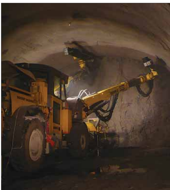
Obr. 4 Vrtací práce – vrtací stroj Boomer E2C fy Atlas Copco Fig. 4 Drilling operations – an Atlas Copco Boomer E2C drill rig
