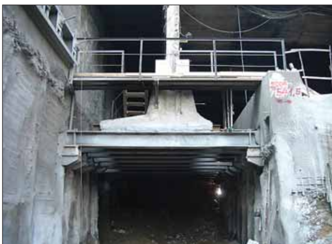
Obr. 6 Podchytávanie základového pásu Fig. 6 Underpinning of wall foundation
