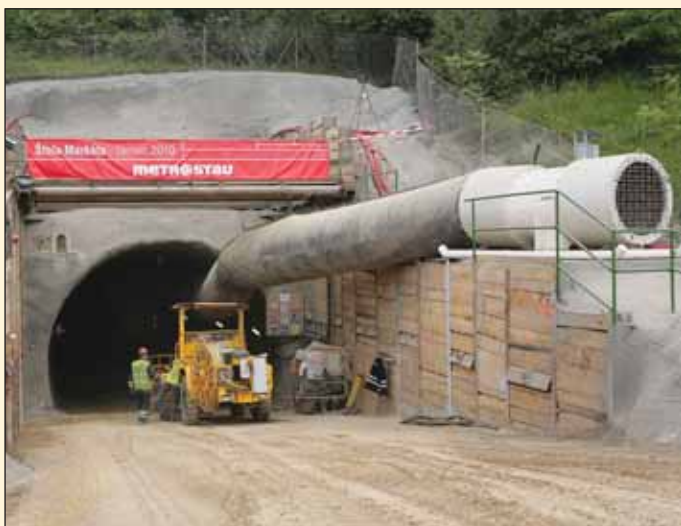
Obr. 1 Pohled na portál přístupového tunelu Markéta Fig. 1 A view of the Markéta access tunnel portal
