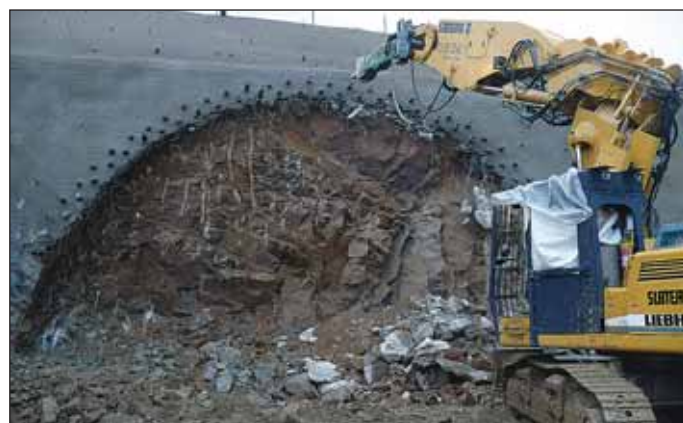
Obr. 3 Strojní rozpojování horniny u portálu – skalní bagr 934 fy Liebherr Fig. 3 Mechanical rock breaking – a Liebherr 934 rock excavator
