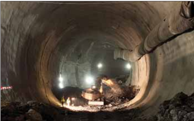
Obr. 9 Uzavřený profil ražené strojovny vzduchotechniky pod Letnou Fig. 9 Closed profile of the mined ventilation plant cavern under Letná
