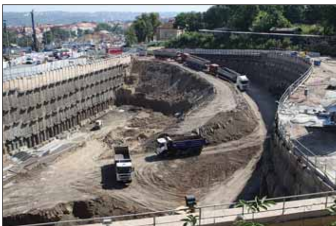
Obr. 5 Staveniště Prašný most, stavební jáma pod hradbami Fig. 5 Prašný Most construction site – construction pit under fortification walls
