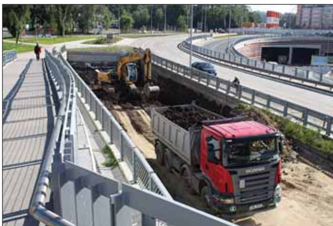
Obr. 1 Staveniště Malovanka, hloubení výjezdové rampy směr Břevnov Fig. 1 Malovanka construction site – excavation for the off-ramp in the direction of Břevnov
