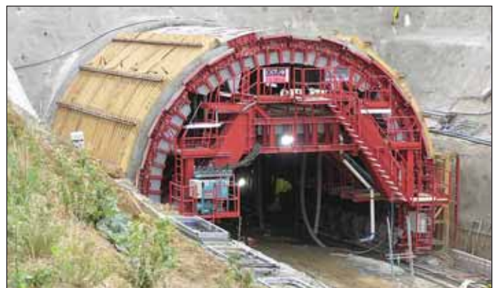
Obr. 12 Zabetonovaný blok definitivního ostění výjezdového portálu Fig. 12 A completed final lining concrete block of the exit portal
