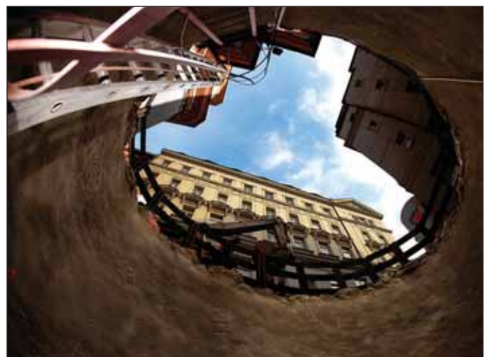
Obr. 5 Pohled ze šachty Š1 na povrch Fig. 5 View of the surface from shaft Š1
