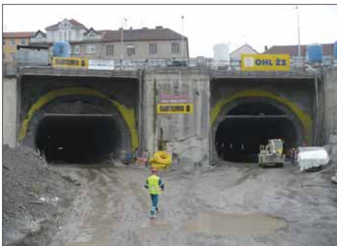
Obr. 4 Pohled na provizorní portál Královo pole po zhotovení sekundárního ostění obou tunelů ze dne 1. 6. 2010
