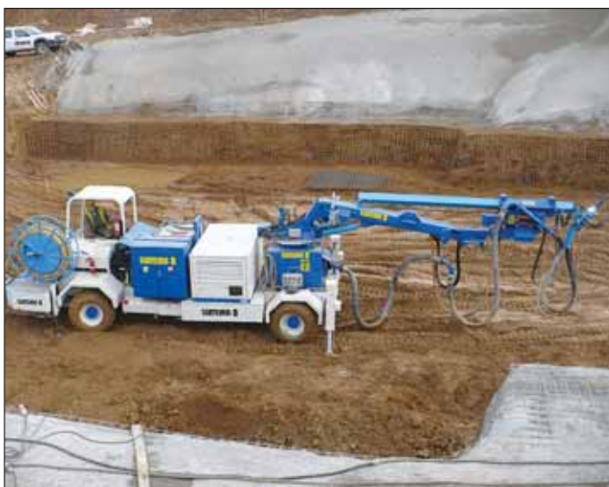
Obr. 1 Zajišťování svahů výjezdového portálu stříkaným betonem – manipulátor Potenza fy Meyco Fig. 1 Stabilisation of exit portal slopes with shotcrete – a MEYCO Potenza concrete spraying unit
