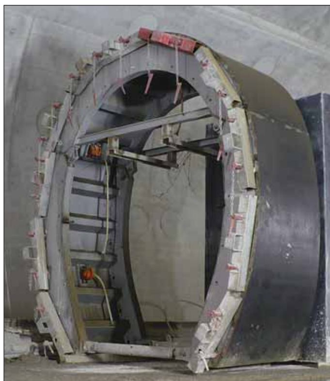
Obr. 20 Bednění zárodku tunelové spojky a velkého elektrovýklenku
