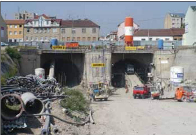
Obr. 2 Pohled na provizorní portál Královo pole po zahájení ražby T I ze dne 19. 6. 2008
