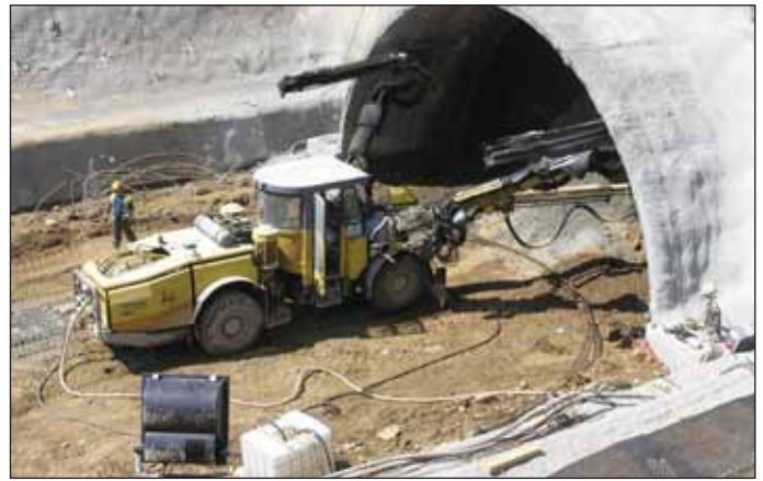
Obr. 7 Zajištění výrubu – vrtací stroj Boomer L2C fy Atlas Copco Fig. 7 Installation of excavation support – an Atlas Copco Boomer L2C drill rig
