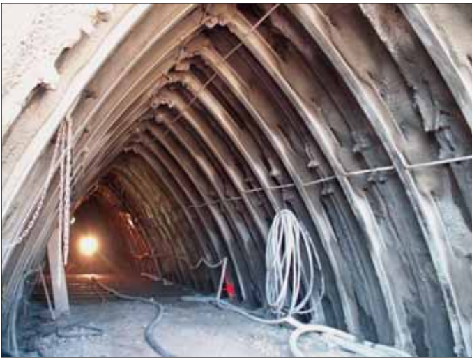
Obr. 6 Pohled na zesilování ostění průzkumné štoly v úseku při portále ze dne 21. 9. 2007
