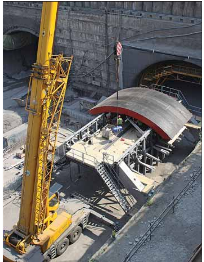
Obr. 8 Staveniště Letná, montáž formy definitivního ostění třípruhového tunelu Fig. 8 Letná construction site – assembly of the formwork for the final lining of the triple-lane tunnel
