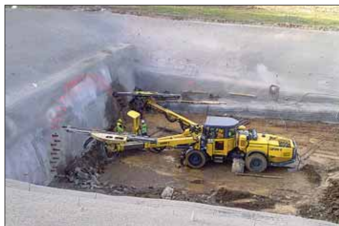
Obr. 2 Instalace mikropilotového deštníku – vrtací stroj Boomer E2C fy Atlas Copco Fig. 2 Installation of canopy tube pre-support – an Atlas Copco Boomer E2C drill rig
