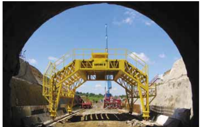
Obr. 10 Armovací vůz na výjezdovém portálu Fig. 10 A reinforcement installation travelling scaffold at the exit portal
