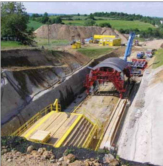
Obr. 11 Montáž bednicího vozu fy OSTU STETTIN Fig. 11 Assembly of OSTU STETTIN form traveller
