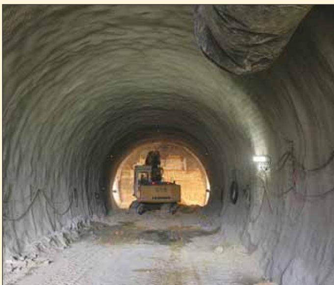
Obr. 3 Ražba prvních metrů přístupového tunelu Markéta Fig. 3 Driving initial metres of the Markéta access tunnel
