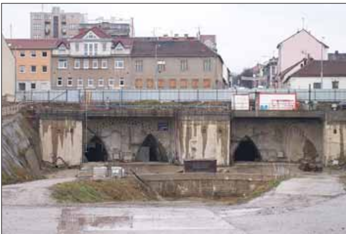
Obr. 1 Pohled na provizorní portál Královo pole po dokončení ražeb průzkumných štol ze dne 28. 2. 2007
