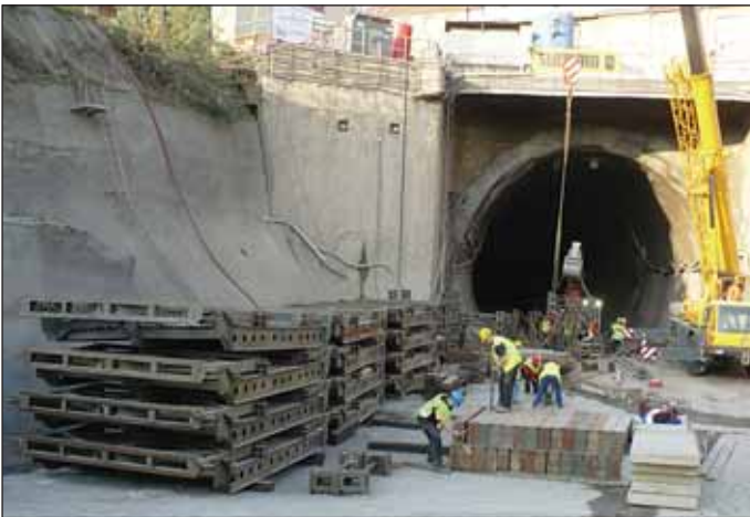
Obr. 16 Montáž ocelového ženíjního mostu Fig. 16 Steel military bridge assembly
