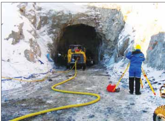
Obr. 3 Začiatok razenia prístupového tunela k hlavnému privádzacu Fig. 3 Commencement of driving the access tunnel to the headrace tunnel
