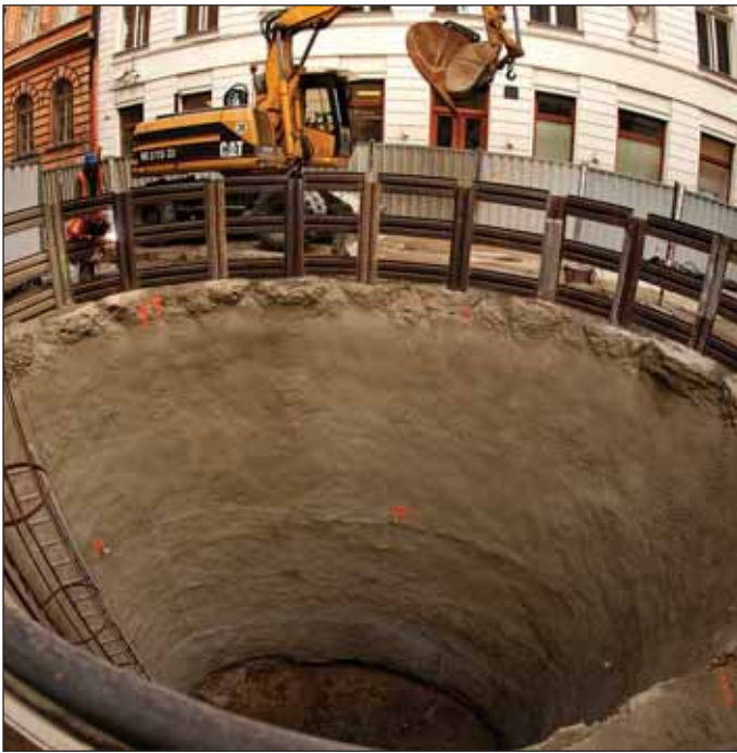
Obr. 4 Pohled na postup výstavby šachty Š1 Fig. 4 View of shaft Š1 construction process
