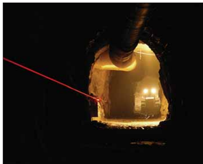
Obr. 4 Odťahba v hlavnom privádzacu Fig. 4 Muck loading in the headrace tunnel
