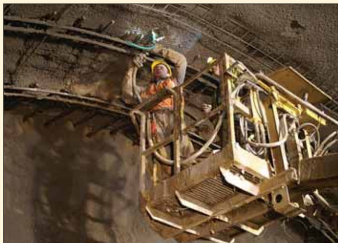
Obr. 6 Injektování SN kotev Fig. 6 Injecting grout into boreholes for SN-anchors
