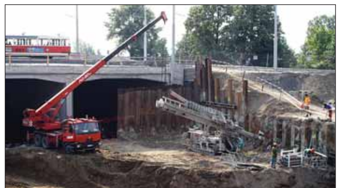
Obr. 13 Staveniště Troja, stavební jáma v místě dřívější tramvajové tratě Fig. 13 Troja construction site – construction trench in the location of a former tram track
