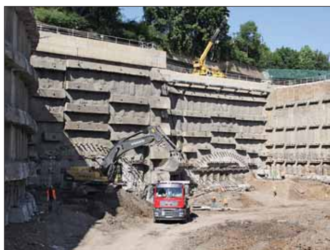
Obr. 4 Staveniště Prašný most, portálová stěna ražených tunelů Fig. 4 Prašný Most construction site – portal wall of mined tunnels
