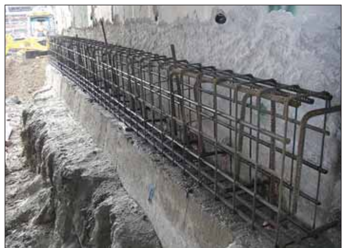
Obr. 7 Stužujúci železobetónový veniec Fig. 7 Reinforcement of the splint RC beams
