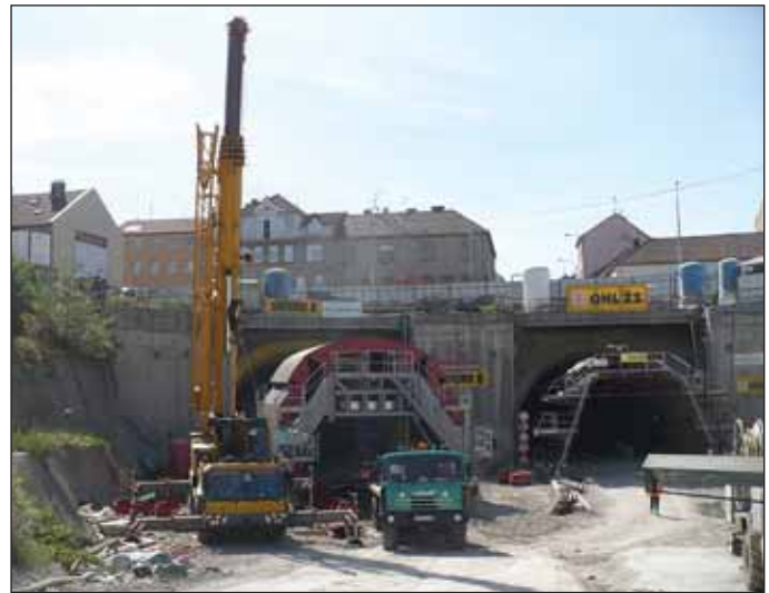
Obr. 3 Pohled na provizorní portál Královo pole při montáži pojízdné bednicí formy na T II a izolačnického vozu na T I ze dne 31. 8. 2009
