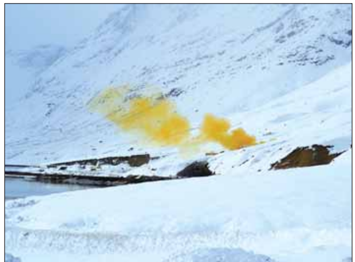
Obr. 2 Pohľad na vstupný a servisný tunel po odpale
