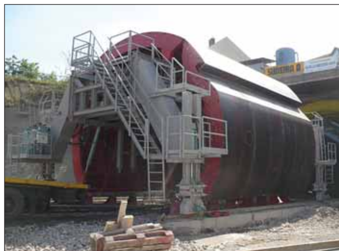
Obr. 19 Bednicí forma klenby před zajištěním do tunelu
