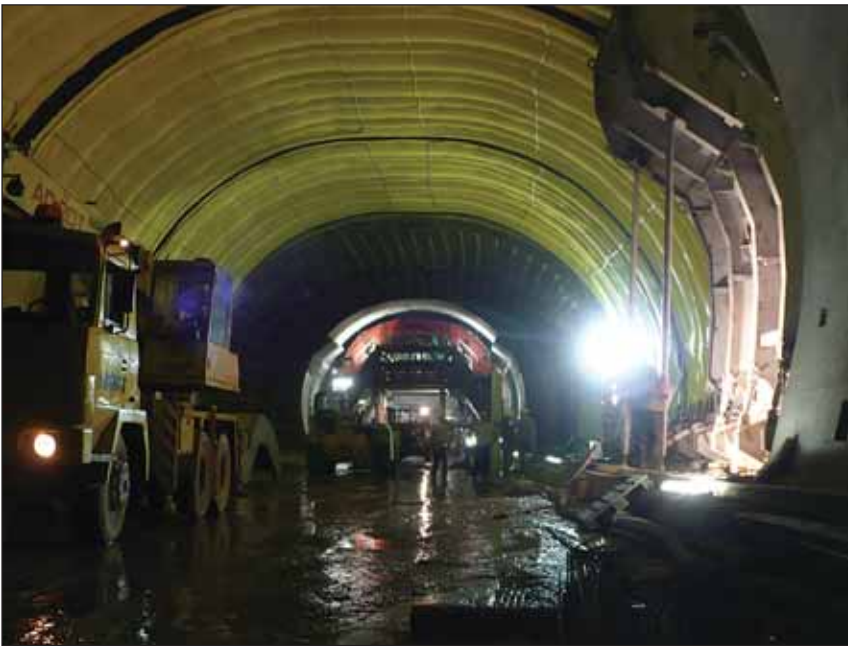
Obr. 21 Rozšíření bednicí formy klenby v nouzovém zálivu Fig. 21 Increased width of the formwork for the upper vault in the emergency stopping bay
