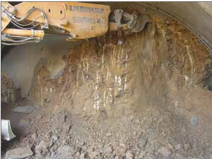
Obr. 8 Strojní rozpojování horniny – skalní bagr 944 fy Liebherr Fig. 8 Mechanical breaking of rock – a Liebherr 944 rock excavator
