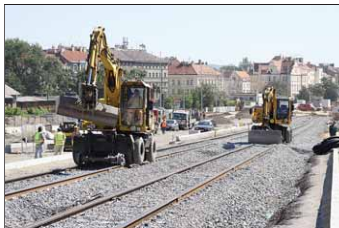
Obr. 6 Staveniště Hradčanská, obnova tramvajové tratě nad dokončeným tunelem Fig. 6 Hradčanská construction site – reinstatement of tram track above the completed tunnel
