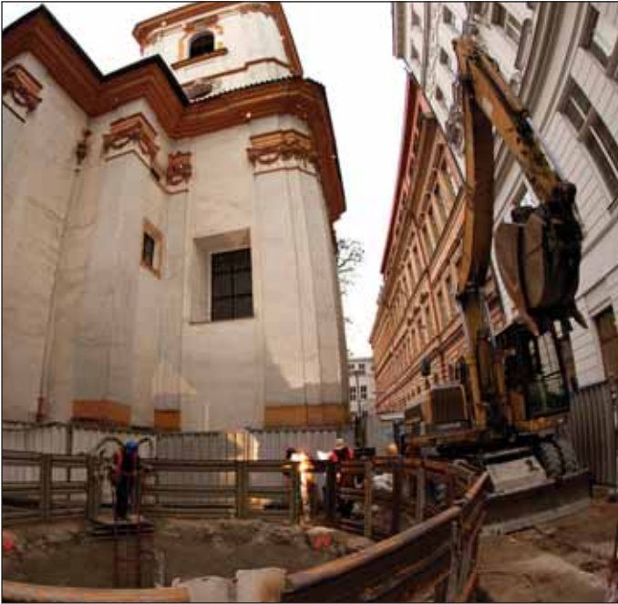
Obr. 3 Stavba výtahu do stanice metra Národní byla vedle kostela Nejsvětější Trojice
