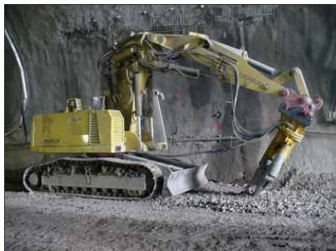
Obr. 8 Pohled na pásové rypadlo Terex s osazenými hydraulickými nůžkami na železobeton
