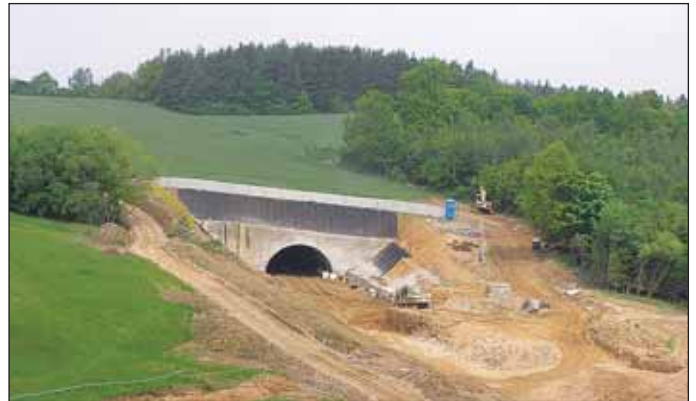
Obr. 9 Výjezdový portál Fig. 9 The exit portal
