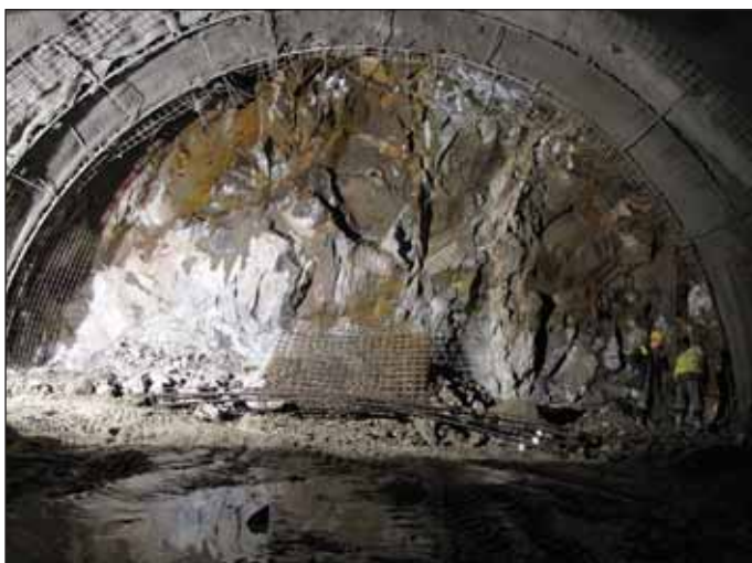
Obr. 2 Čelba Zahradnického tunelu ve staničení TM 933,2 – biotiticko-amfibolitické žuly na puklinách limonitizované – na obrázku je patrné zajištění přístropí jehlami
