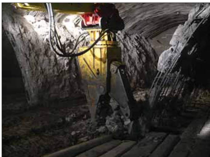
Obr. 9 Hydraulické nůžky na železobeton při práci Fig. 9 Hydraulic reinforced concrete demolition shears at work
