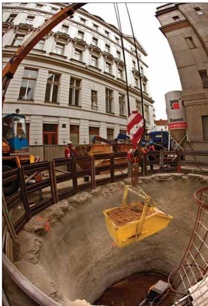
Obr. 6 Dopravení výkopku na povrch pomocí jeřábu Fig. 6 Lifting the muck to the surface by a crane
