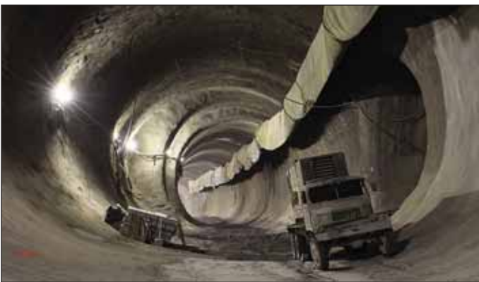
Obr. 10 Ražený tunel Královská obora, primární ostění v místě nouzového zálivu Fig. 10 Královská Obora mined tunnel – primary lining at the emergency parking bay
