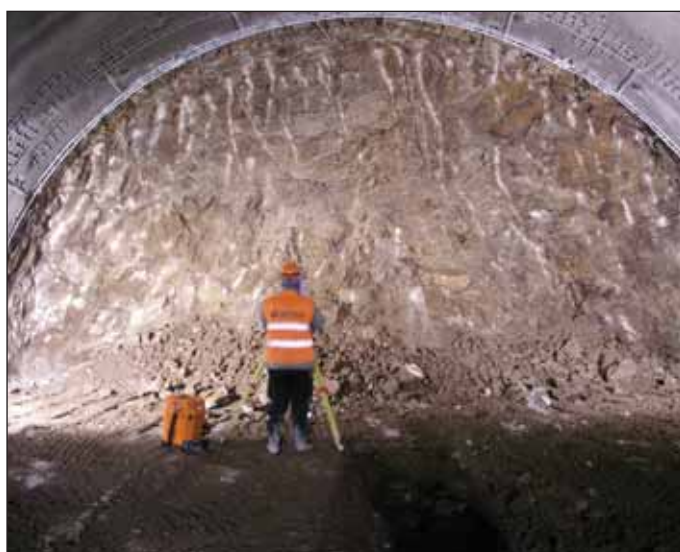
Obr. 1 Čelba Olbramovického tunelu ve staničení TM 96,9 – biotitická rula rozpukaná limonitovaná – na obrázku je patrné zajištění přístropí jehly s relativně malou roztečí
