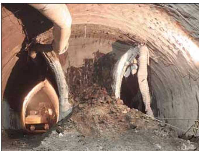
Obr. 3 Ražený tunel Brusnice, vertikální členění výrubu Fig. 3 Brusnice mined tunnel – vertical excavation sequence
