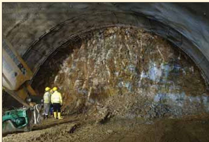
Obr. 3 Čelba v prostředí zvětralých rul Fig. 3 Excavation face in the environment formed by weathered gneiss
