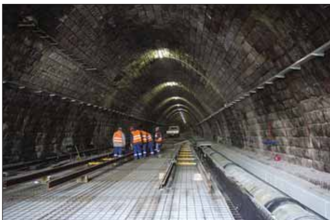
Obr. 6 Výstavba koľajovej trate, vpravo potrubie vodovodu v kanáli Fig. 6 Construction of the rail track; for the right: the water pipeline in the duct
