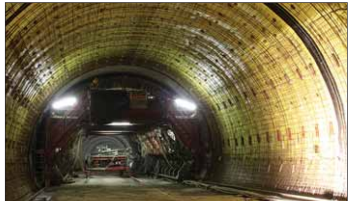
Obr. 11 Ražený tunel Královská obora, výztuž klenby a forma definitivního ostění Fig. 11 Královská Obora mined tunnel – reinforcement of the vault and formwork for the final lining
