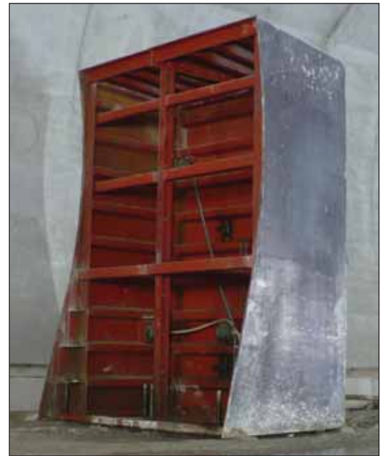
Obr. 22 Bednění malých výklenků Fig. 22 Formwork for small niches
