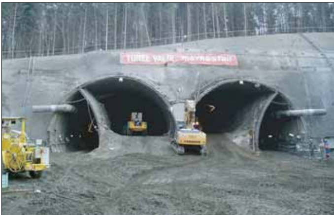
Obr. 1 Výstavba tunelů Fig. 1 Tunnel construction
