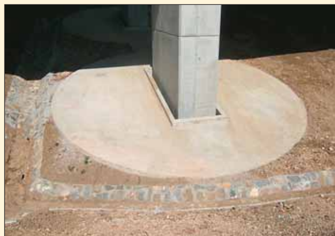
Obr. 3 Opatření u pilířů v sesuvném území
