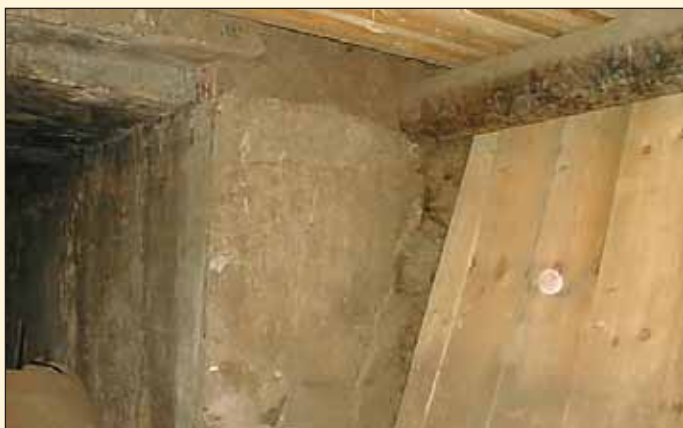
Obr. 3 Celkový pohled na portál ražby v místě kompenzátorové jímky Fig. 3 An overall view of the excavation portal at the compensator shaft
