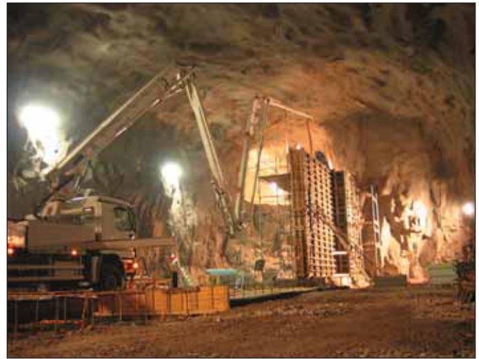
Obr. 3 Stredová stena – nitrifikačná sekcia Fig. 3 The central wall in the nitrification section
