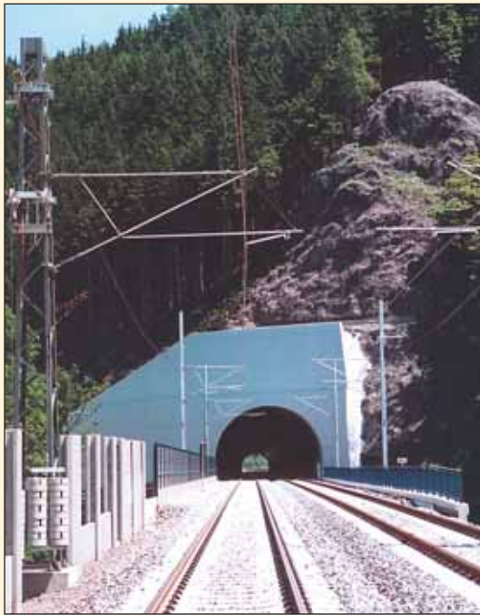
Obr. 3 Západní portál tunelu Hněvkov II s úpravou skalního svahu Fig. 3 The western portal of the Hněvkov II tunnel with the rock slope treatment
