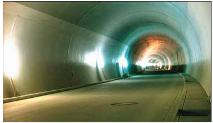
Obr. 6 Tunelová rúra pripravená na montáž technológie
