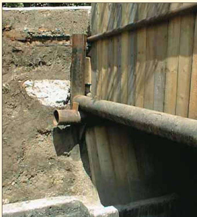
Obr. 2 Průlezná část topného kanálu před rekonstrukcí
