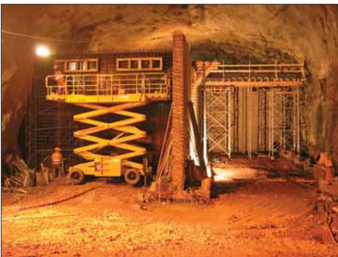
Obr. 4 Pričné steny – nitrifikačná sekcia Fig. 4 Transverse walls in the nitrification section
