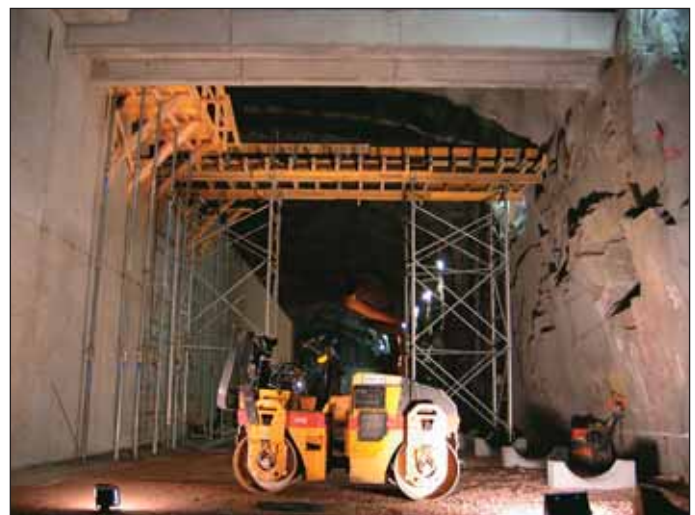
Obr. 5 Pochôdzne lávky – nitrifikačná sekcia Fig. 5 Service walkways in the nitrification section
