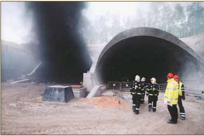
Obr. 2 Zplodiny hoření unikající z tunelové trouby cca 5 min. po zapálení hořlaviny
