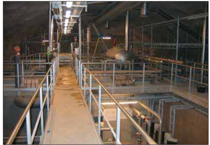
Obr. 8 Objekt flotácie a flokácie Fig. 8 The flotation and flocculation tanks
