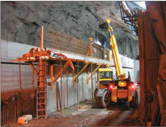
Obr. 2 Žľabové steny – sedimentačná sekcia Fig. 2 A trough wall in the sedimentation section
