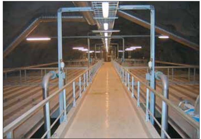
Obr. 7 Nová biologická časť po spustení do prevádzky Fig. 7 The new biological block brought into service
