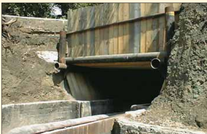
Obr. 1 Zajištění mělko uložené velkoprofilové ražby v štěrkopiscích zaberaněním trubek DN 500
