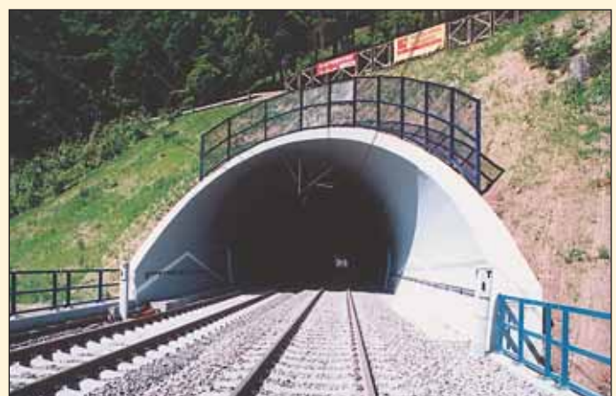
Obr. 2 Pohled na východní portál tunelu Hněvkov II z mostu přes Moravskou Sázavu
