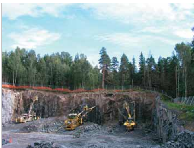
Obr. 1 Severný portál tunelov Vuoli
