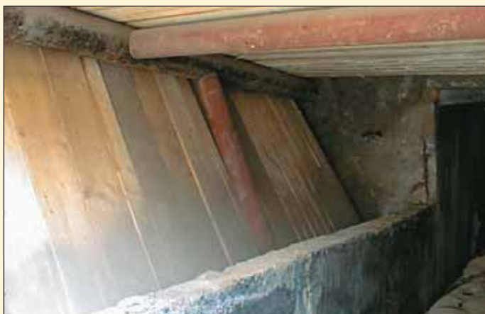
Obr. 5 Vyděra stropu z fošen uložených na výšku na zaberaněné nosníky Fig. 5 Roof support timbering using boards set on edge on driven beams
