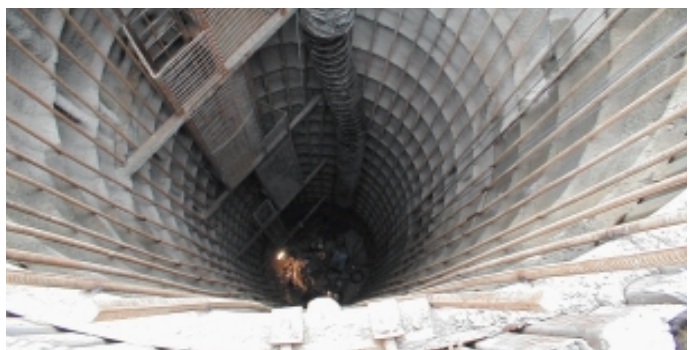
Obr. 5 Šachtový pilíř Fig. 5 Shaft pillar
