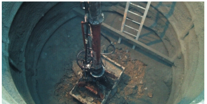
Obr. 4 Hloubení strojem RDK Fig. 4 Excavation using the RDK machine
