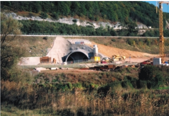
Obr. 4 Pohled na severní portál tunelu Irlahüll Fig. 4 A view of the Irlahüll tunnel North portal
