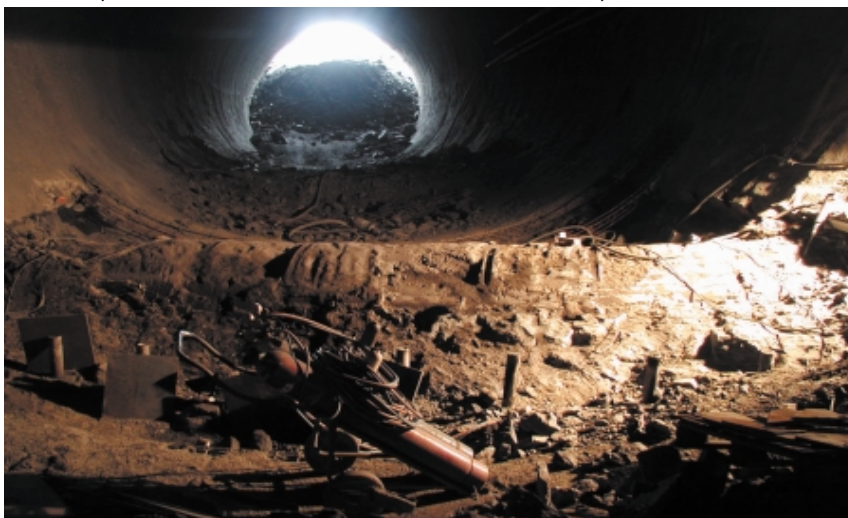
Obr. 10 Obnažené těleso sběrače P napříč dnem tunelu VTT Fig. 10 Exposed body of the interceptor P leading across the bottom of the ETT tunnel
