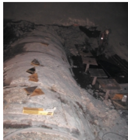
Obr. 11 Těleso sběrače ve dně VTT. Mikropiloty v těsné blízkosti boků sběrače jsou součástí ochranné konstrukce nad jeho klenbou.
