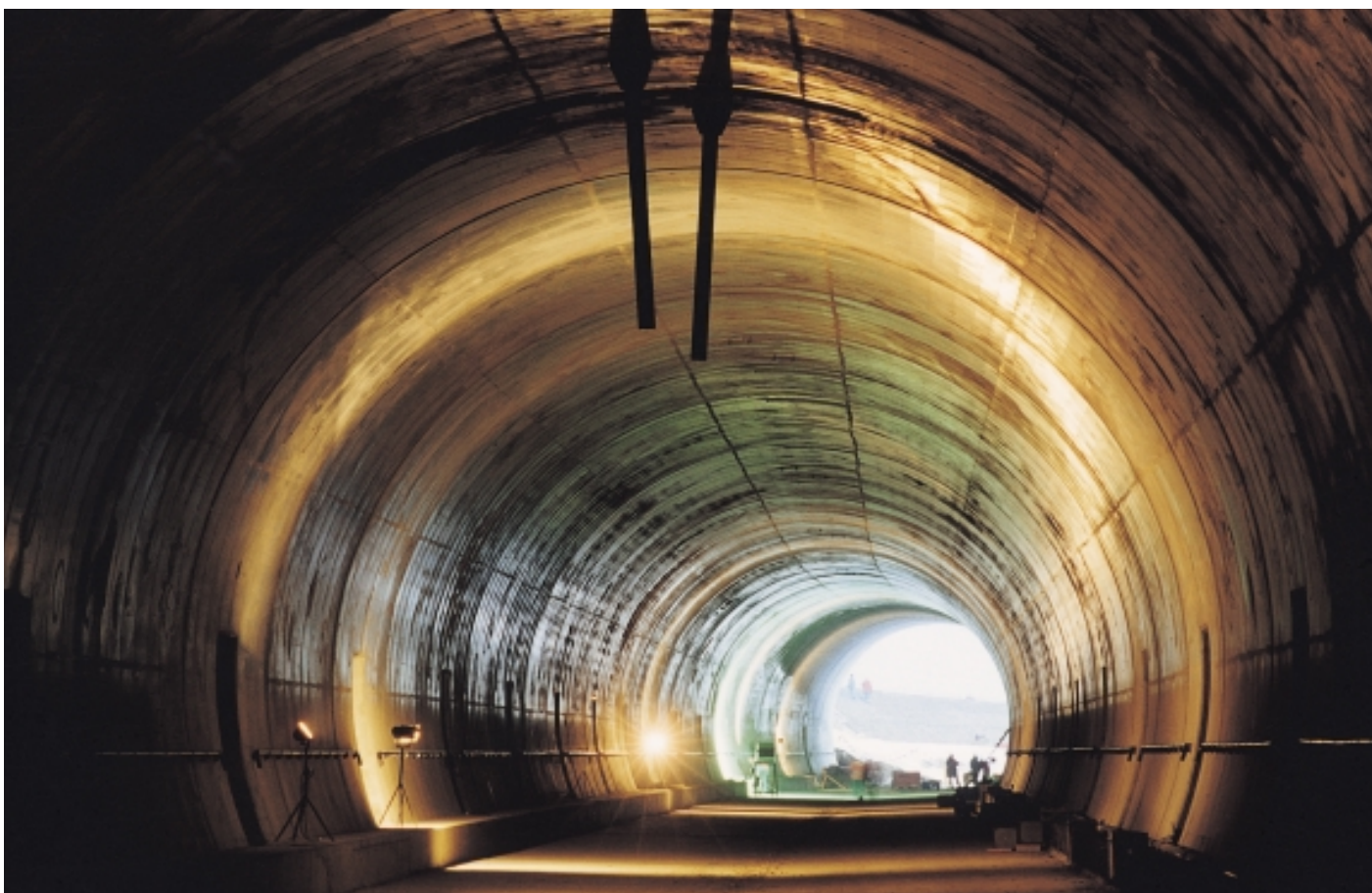
Obr. 8 Tunel po dokončení betonáže je připraven pro pokládku kolejí
