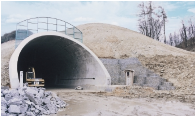
Obr. 9 Děčínský portál s malou gabionovou zdí Fig. 9 The Děčín portal with a small gabion wall
