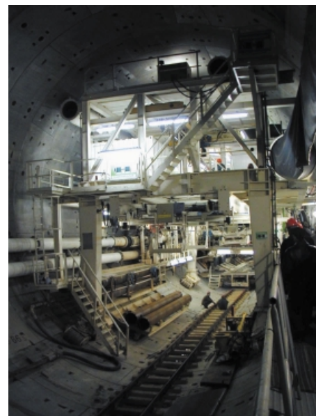
Obr. 8 Celkový pohled na razicí stroj Fig. 8 A global view of the boring machine
