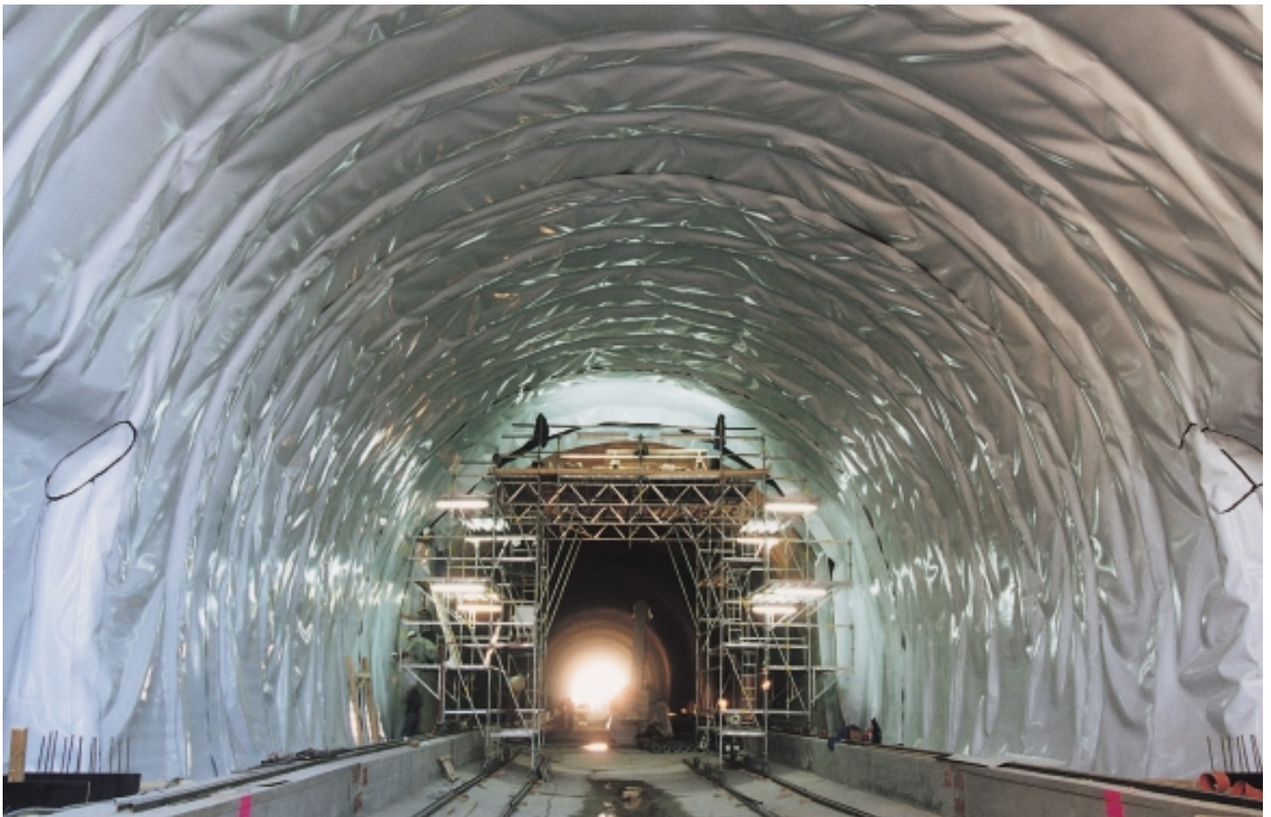
Obr. 5 Záběr, který potvrzuje dosažení vysoké úrovně provedení mezilehlé izolace Fig. 5 The picture confirms the high level of the intermediate insulation workmanship
