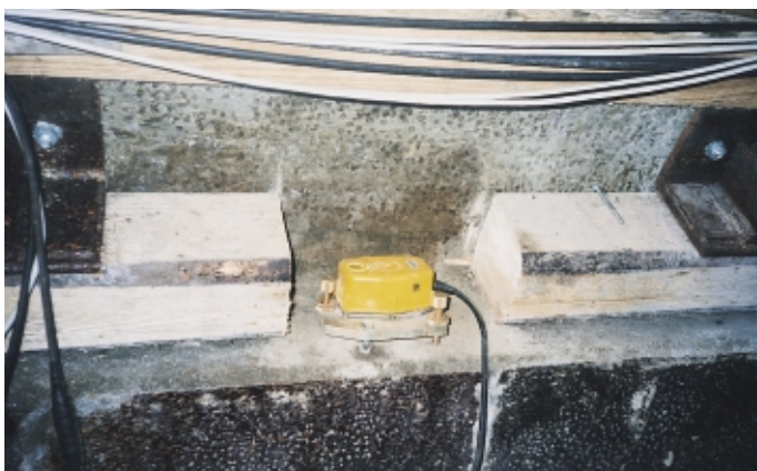
Obr. 7 Umístění snímače rychlosti kmitání na parapetu keramické vyzdívkvy sběrače Fig. 7 Installation of a vibration velocity sensor on a parapet of the ceramic tiling of the interceptor
