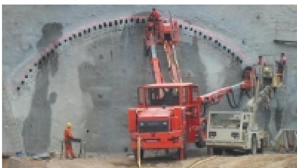
Obr. 1 Vrtací vůz používaný pro osazování mikropilot Fig. 1 Drilling rig used for installation of grouted steel pipes
