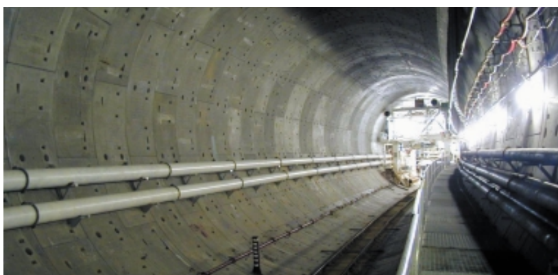
Obr. 6 Hotová tunelová trouba. Nalevo potrubí pro přívod bentonitu a odvod zeminové suspenze, napravo pochozí lávka, napájecí kabely, vzduch apod. Celý profil je absolutně suchý, přestože je zde hladina spodní vody 2 m pod terémem. Fig. 6: Final tunnel tube. To the left pipeline for inflow of bentonite and drain of spoil, to the right an emergency walkway, power cables, air etc The entire profile is absolutely dry, although there is a groundwater table of 2 m under the surface.
