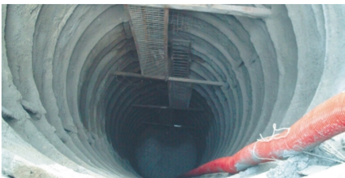
Obr. 6 Betonáž šachtového pilíře Fig. 6 Concrete placement of the shaft pillar
