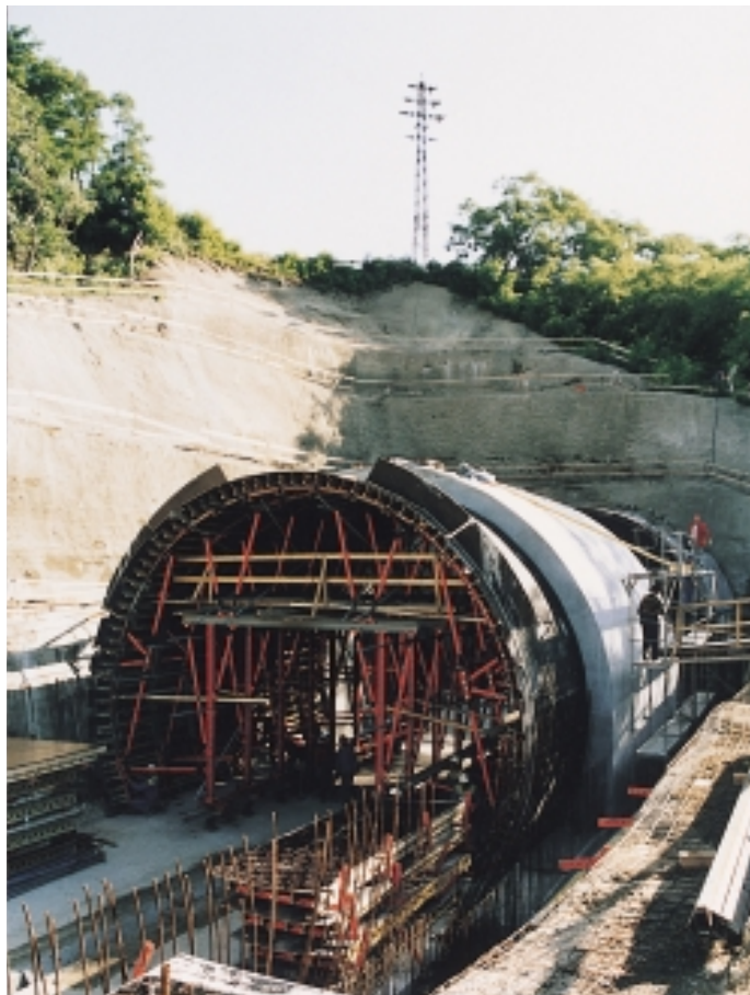
Obr. 7 Pro betonáž v hloubených částech bylo používáno bednění PERI
