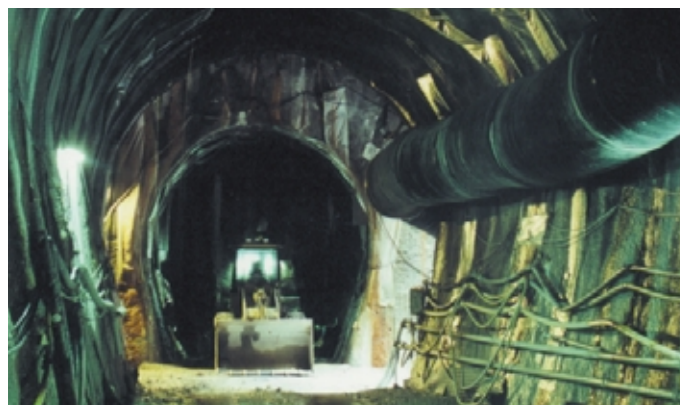
Obr. 2 Traťový tunel ražený NRTM s křížením Fig. 2 NATM running tunnel and junction
