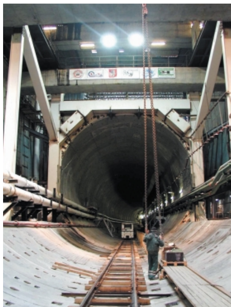
Obr. 5 Montážní jáma a vstup do vlastního tunelu Fig. 5 An assembling pit and access to the tunnel
