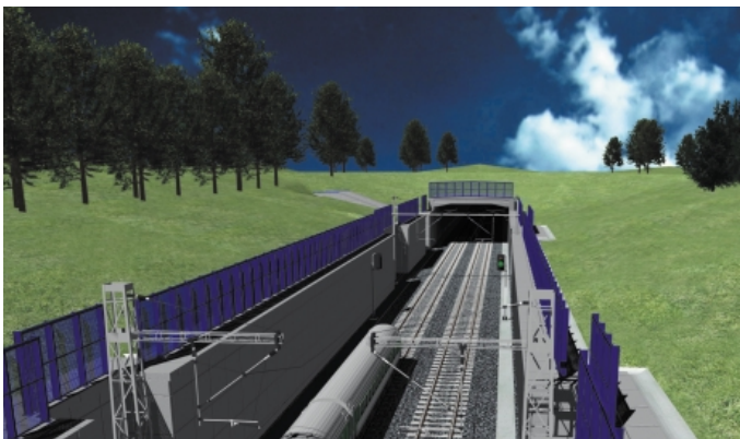
Obr. 6 Vizualizace - pohled na vjezdový portál a zárubní di Fig. 6 Visualisation - A view of the entrance portal and retaining wall
