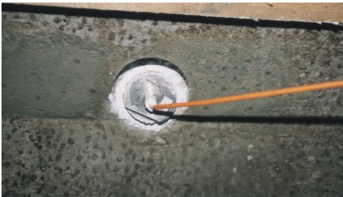
Obr. 8 Snímač rychlosti kmitání zabudovaný v betonovém ostění sběrače Fig. 8 A vibration velocity sensor installed at the concrete lining of the interceptor
