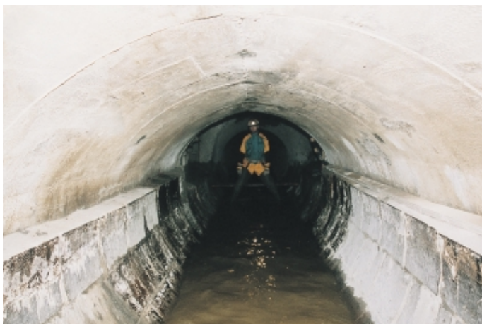
Obr. 5 Pohled do sběrače P Fig. 5 A view inside the interceptor sewer P
