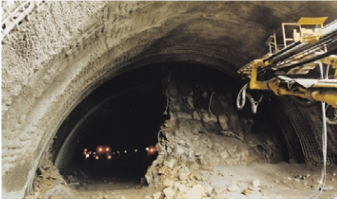
Obr. 3 Datum prorážky kaloty - 7. května 2001 v 14,24 hod. Fig. 3 Top heading break through on May 7, 2001 at 2:24 p.m.
