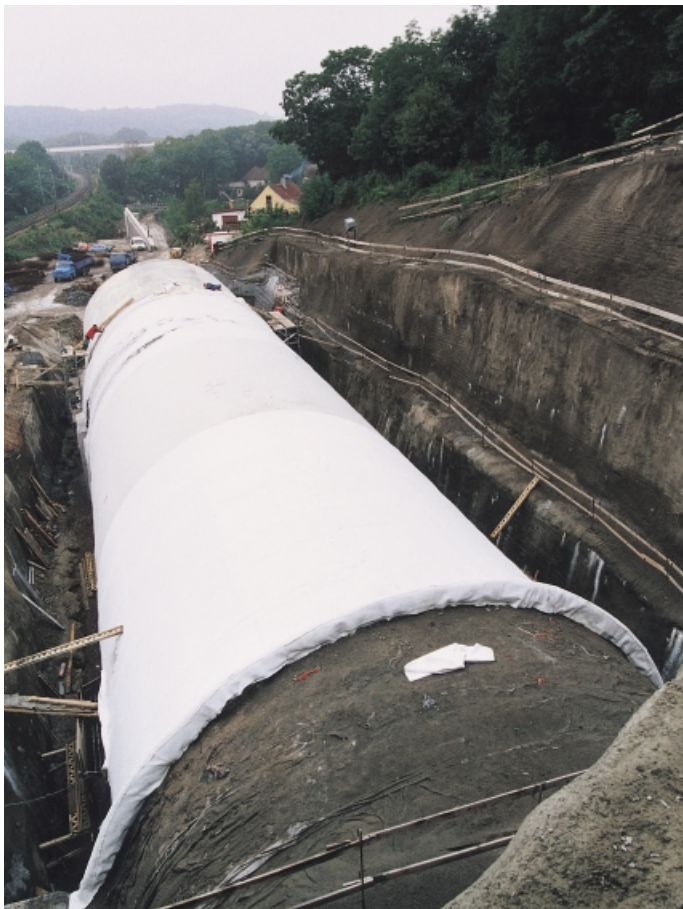
Obr. 6 Na styku hloubených a ražených částí byla důkladná pozornost věnována detailu styku izolace...
