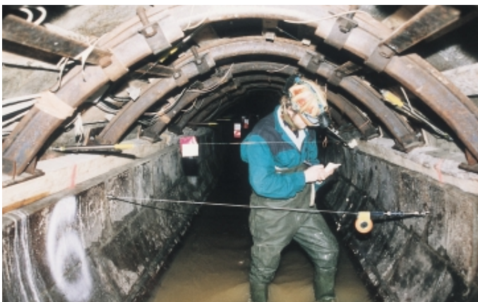
Obr. 6 Dočasné vyztužení sběrače v místě křížení s VTT a ZTT, ruční měření konvergenčí, patrné jsou i snímače automatického měření Fig. 6 Temporary support of the interceptor sewer at the crossing with the ETT and WTT, manual convergence measurement, also the sensors of the automatic convergence measurement system are visible
