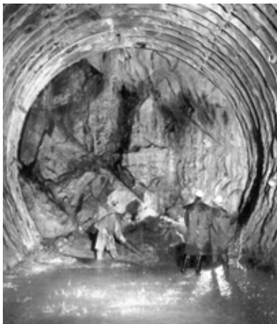
Obr. 21 Použití příhradových rámu a stříkaného betonu na tlakovém tunelu Monastero, Itálie 1958 (Curzio 1963) Fig. 21 Use of lattice girders with shotcrete in the Monastero pressure tunnel, Italy 1958 (Curzio 1963)
