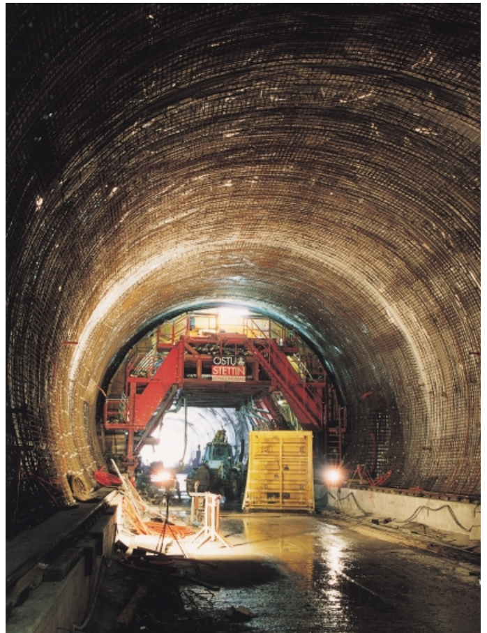
Obr. 4: S příslušným předstihem postupovaly práce na výztuži ostění Fig. 4: Reinforcing work was progressing with a necessary advance
