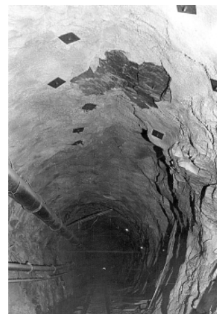
Obr. 20 Použití stříkaných betonů a svorníků na vodních tunelech hydroelektrárny Maggia (úsek Pecchia - Caveragno), Švýcarsko 1952-1955 (Foto s laskavým svolením D. Pradera) Fig. 20 Use of shotcrete and bolts in the waterway tunnels of the Maggia Hydroelectric Scheme (section Pecchia - Caveragno), Switzerland 1952-1955 (Photos courtesy D. Prader)
