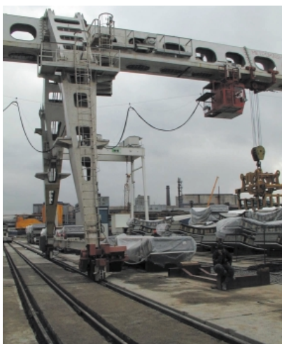
Obr. 3 Montážní jeřáb – zde byl sestaven vlastní štít, nyní slouží jeřáb k zavážení segmentů ostění do tunelu. Fig. 3 An assembling crane; the shield was assembled here, now the crane supplies lining into the tunnel
