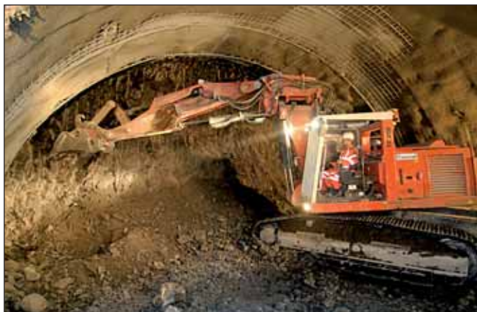
Obr. 6 Rozpojování horniny skalním bagrem
