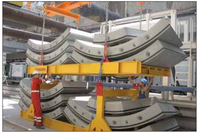
Obr. 4 Přepravní rámy pro celý prstenec Fig. 4 Transport frames for complete ring
