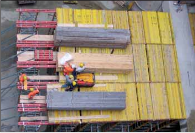
Obr. 3 Plošina pro bagr; podpěrné věže na místě, plnostěnné nosníky uložené na sraz
