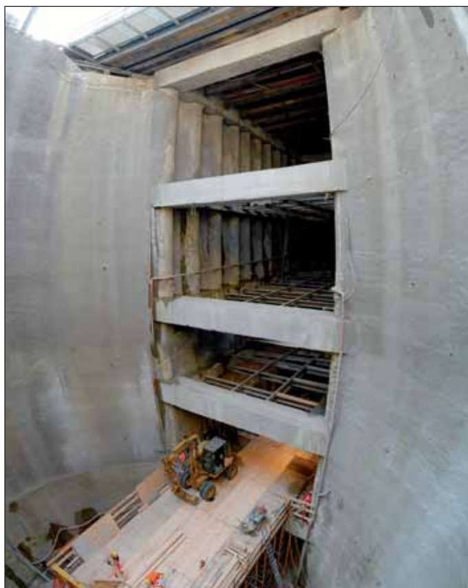
Obr. 2 Šachta v ulici Klimtgasse; plošina pro bagr s téměř dokončenou dřevěnou podlahou
