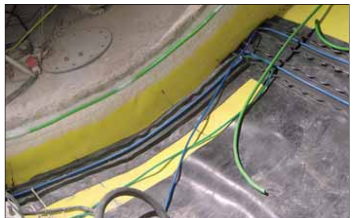
Obr. 7 Lepený styk Fig. 7 Glued connection
