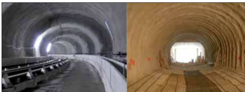
Obr. 6 Tunel Viret, trasa M2 metra v Lausanne. Vpravo: Situace v průběhu stavby s hydroizolační stříkanou membránou provedenou po celém obvodu tunelu včetně dna, těsně před zahájením prací na konstrukci ve dně. Vlevo: Dokončený tunel s definitivním kompozitním vodotěsným ostěním ze stříkaného betonu na stěnách a v klenbě a s monolitickým železobetonovým dnem (Holter, Tappy, 2008)
