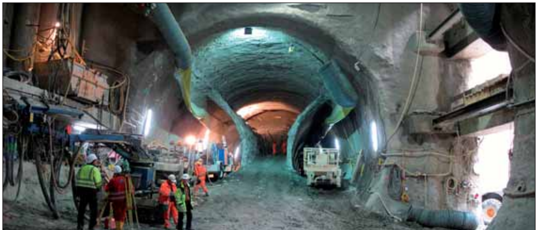
Obr. 5 30 m úplného profilu Fig. 5 30 m of total cross section
