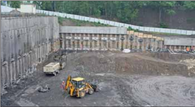
Obr. 1 Staveniště Myslbekova, severní a východní stěna jámy Fig. 1 Myslbekova site – northern and eastern walls of the excavation box
