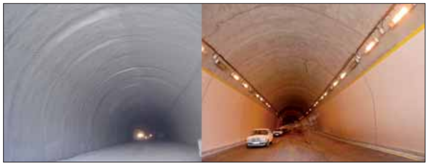
Obr. 11 Vlevo: Povrch tunelu po aplikaci vnitřního ostění ze stříkaného vláknobetonu. Vpravo: Povrch tunelu s konečnou povrchovou úpravou hlazenou omítkou v klenbě a obklady na stěnách (Makhlouf, Holter, 2008)
