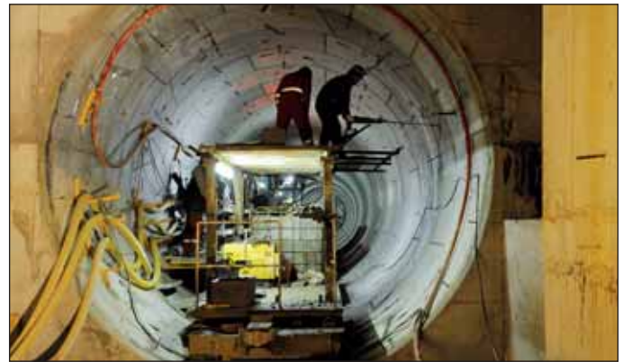
Obr. 12 Druhotná injektáž v severním tratovém tunelu Fig. 12 Second injection running tunnel north
