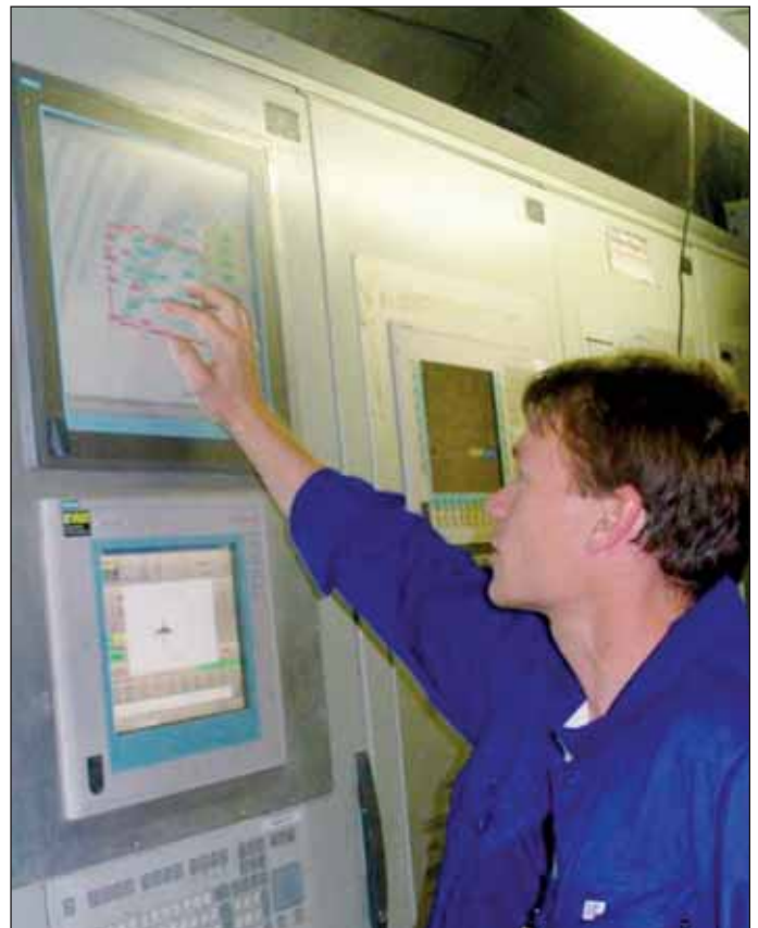
Obr. 7 Monitor ZSRT na tunelovacím stroji TBM Fig. 7 ATDS-display on TBM
