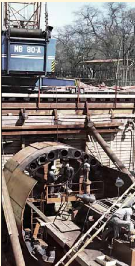
Obr. 1 Montáž nemechanizovaného štítu Fig. 1 Assembly of a non-mechanised shield
