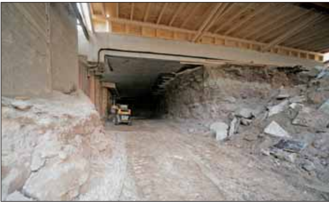
Obr. 5 Stavba metodou čelního odtěžování Fig. 5 Top-down construction method
