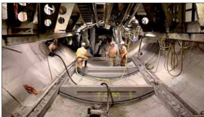
Obr. 3 Budování dna tunelu
