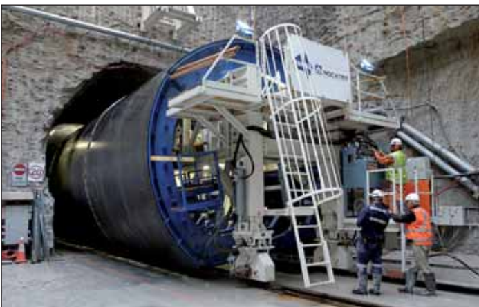
Obr. 6a, b Zasouvání bednicích vozů do tunelu a jejich zaparkování v kaverně stanice Mac Uni Fig. 6a, b Shutters entering tunnel, parking at Mac Uni station
