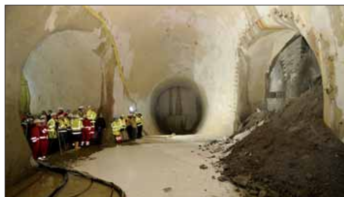
Obr. 11 Prorážka stroje TBM do vzduchotechnického objektu na západní straně náměstí Gellert
