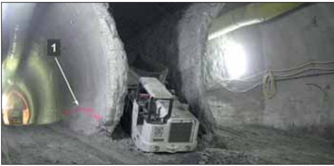
Obr. 9 (1) Trhlina ve vnitřní stěně boční štoly, úsek W, staničení 52–60 Fig. 9 (1) Crack at the inner wall of the side wall drift, section W, Chainage 52–60
