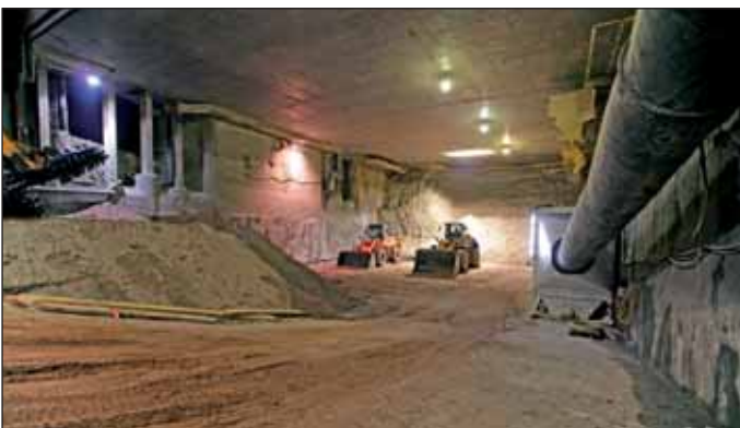
Obr. 7 Výkopová komora na náměstí Friedrich-Ebert-Platz v průběhu ražeb Fig. 7 Excavation chamber at Friedrich-Ebert-Platz, during driving work
