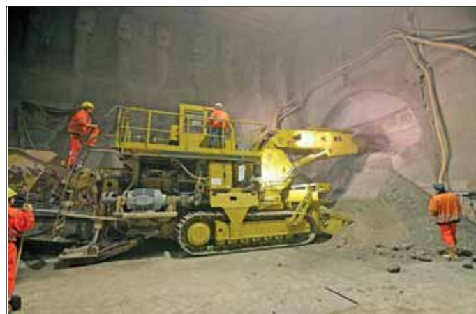
Obr. 10 Použití frézy pro ražby Fig. 10 Using a roadheader for driving
