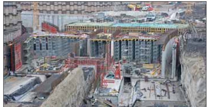
Obr. 4 Staveniště Letná, výstavba dilatací D16, D17, D18, D19 a R2 Fig. 4 Letná site – construction of expansion blocks D16, D17, D18, D19 and R2
