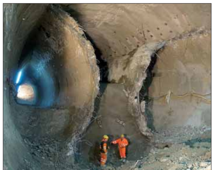
Obr. 8 Provedení dna v celém profilu (ražba zbytku opěří a dna a bourání vnitřních stěn boční štoly)
