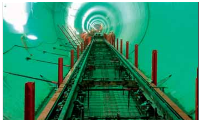
Obr. 7 Budování kolejové desky pro přímé upevnění (Sydney Egg) metodou shora dolů
