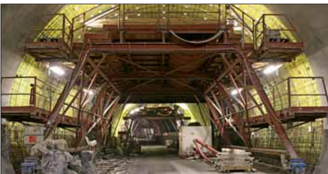
Obr. 5 Ražený tunel, montáž výztuže klenby definitivního ostění Fig. 5 Mined tunnel – installation of the final lining vault reinforcement
