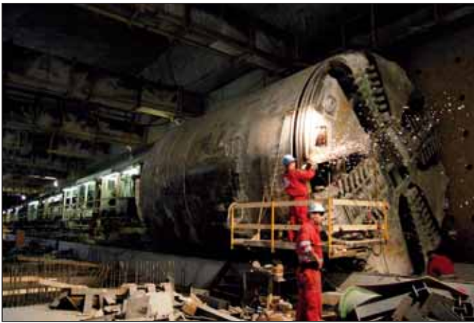
Obr. 3 Údržba TBM ve stanici Bocskai Fig. 3 TBM maintenance at Bocskai
