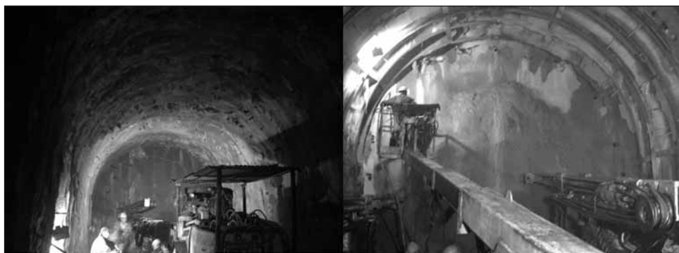
Obr. 6 Vpravo: Fotografie pořízená na čelbě ukazující injektáž skrz ocelové trubky – v první etapě rychletvrdnoucím mikrojemným cementem. Vlevo: Čelba tunelu ve směru ke konci obtížné zóny. Předstihovými injektážemi se dosáhlo stabilního a doslova suchého obrysu a čela výrubu umožňujícího bezproblémovou instalaci provizorního zajištění výrubu (Bahadur a kol. 2007)
