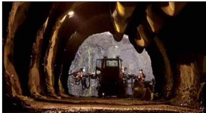
Obr. 2 Poslední záběr Fig. 2 Last excavation round
