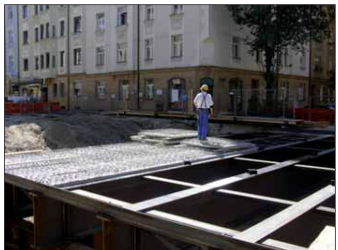
Obr. 4 Provizorní strop pro převedení dopravy
