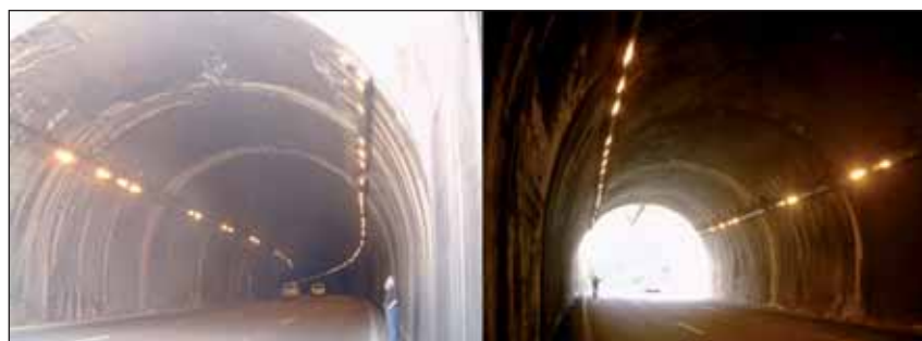
Obr. 7 Tunel Chekka před provedením sanací (Makhlouf, Holter, 2008) Fig. 7 The Chekka tunnel before refurbishment (Makhlouf, Holter, 2008)
