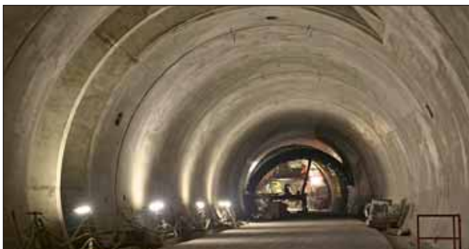
Obr. 6 Ražený tunel, klenba definitivního ostění s požárními kanálky Fig. 6 Mined tunnel – final lining vault with exhaust ducts
