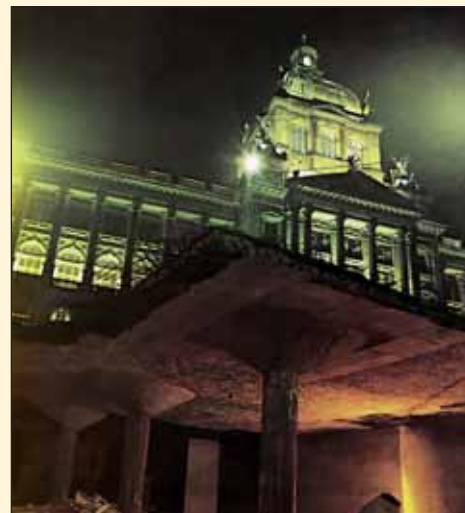
Obr. 3 Noční snímek rozestavěné stanice Muzeum Fig. 3 Night photo of Muzeum Station, under construction
