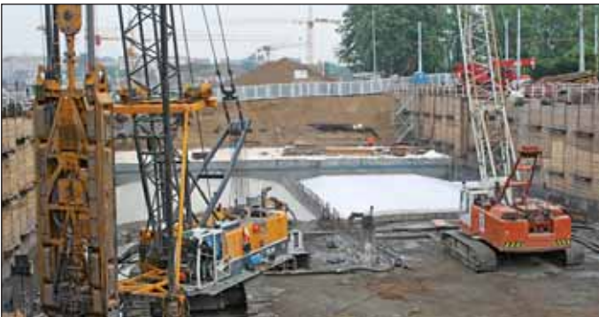
Obr. 3 Staveniště Letná, výstavba dilatací D8 a D7 tzv. milánskou metodou Fig. 3 Letná site – construction of expansion blocks D8 and D7 by the Milan Method
