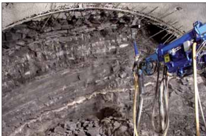
Obr. 10 Provádění stříkaného betonu na čelbě kaloty, zajištěné jehlováním Fig. 10 Application of shotcrete at the top heading supported by forepoling
