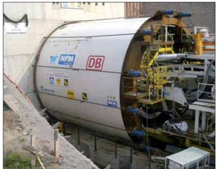
Obr. 8 „Letný start štítu“ na novém tunelu Schlüchtern Fig. 8 “Flying shield start-up” at New Schlüchtern Tunnel
