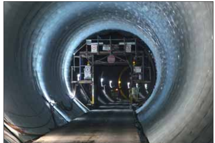
Obr. 5 Izolace proti vodě z nopové fólie Fig. 5 Dimple Sheet Waterproofing
