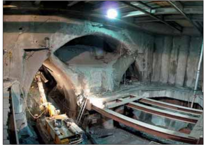
Obr. 4 Ražba přístropí dokončena, začalo rozšiřování v předstihu ražené boční štolý; zbývající rozepření je dosud na místě
