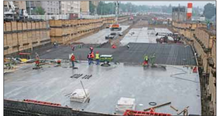
Obr. 2 Staveniště Hradčanská, stropní deska dilatací B/2 a B/1 Fig. 2 Hradčanská site – roof decks on expansion blocks B/2 and B/1
