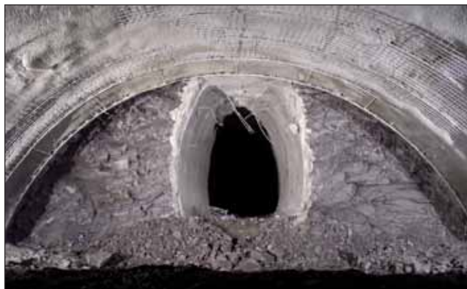
Obr. 7 Čelba kaloty třípruhového tunelu s profilem průzkumné štoly
