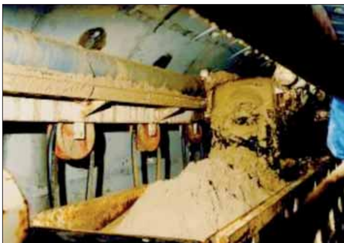
Obr. 9 Ražba v písku s pomocí pěny a polymerů Fig. 9 Sand excavation with Foam & Polymer
