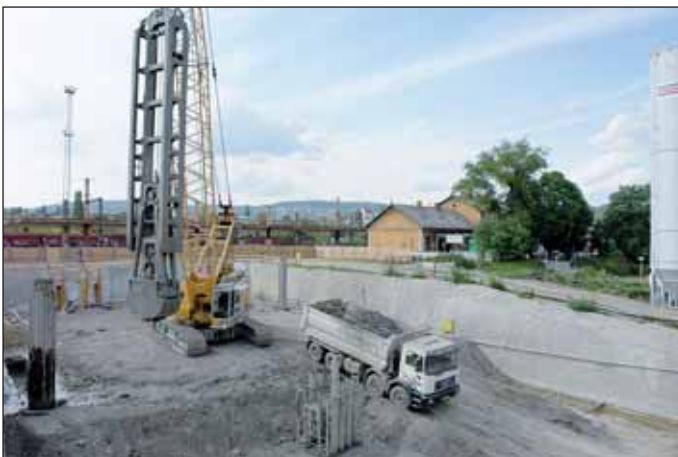
Obr. 1 Drapákové zařízení Fig. 1 Clamshell equipment
