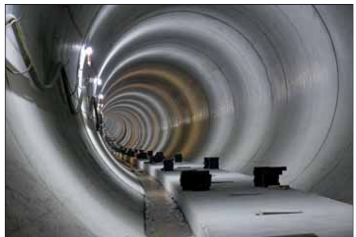
Obr. 8 Plovoucí kolejová deska před zvednutím a podložním ložisky
