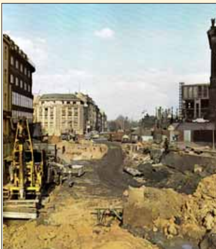
Obr. 2 Stavební jáma Mezibranská – Václavské nám. (Muzeum) Fig. 2 Mezibranská – Wenceslas Square. (Museum Station) excavation box
