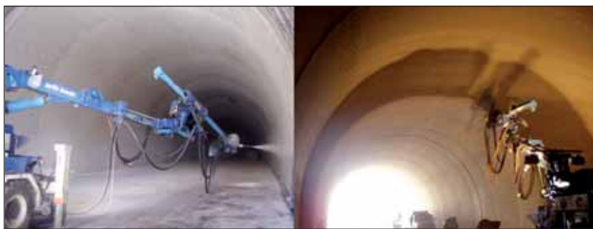
Obr. 10 Počítačem řízené robotizované nanášení hydroizolační stříkané membrány o tloušťce 2–3 mm (vlevo) a stříkaného vláknobetonu o přesné tloušťce 4 cm (vpravo). Hlavní číselné údaje z provádění sanačních prací jsou shrnuty níže v tabulce 1 (Makhlouf, Holter, 2008)
