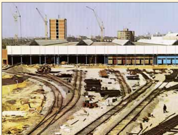
Obr. 5 Rozestavěné depo Kačerov Fig. 5 Kačerov depot – under construction
