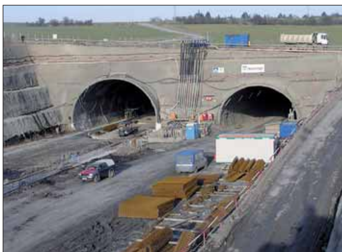
Obr. 3 Severní ražený portál tunelu v Lochkově Fig. 3 Northern mined tunnel portal in Lochkov
