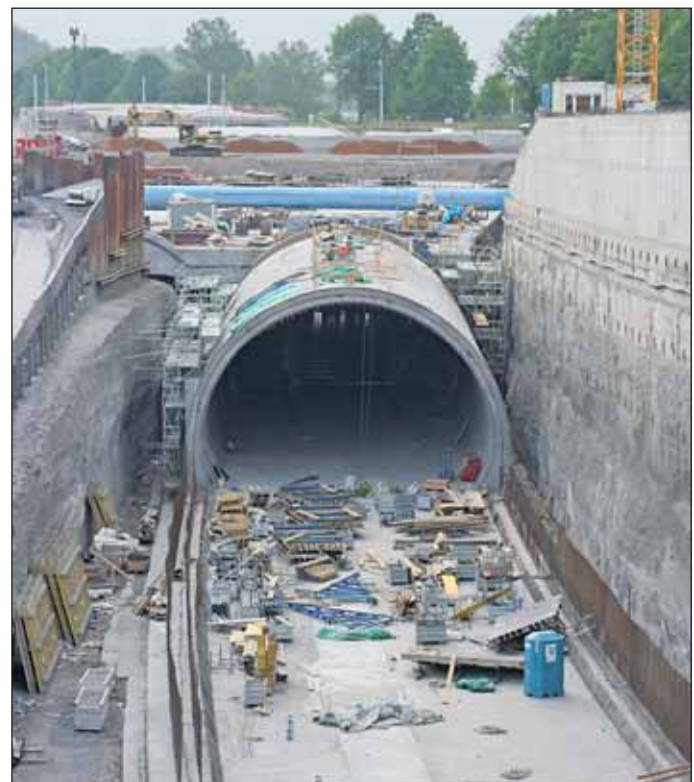
Obr. 7 Staveniště Troja, výstavba klenbového tunelu v jámě 6 Fig. 7 Troja site – construction of a vaulted tunnel in construction trench
