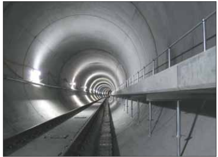
Obr. 9 Tunnel s železničním svrškem
