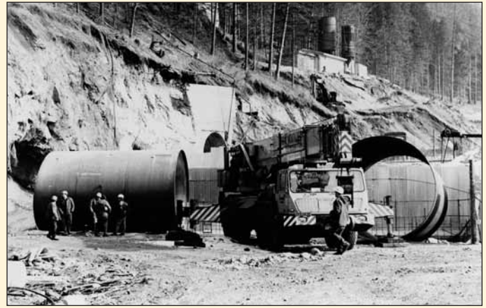
Obr. 4 Príprava rúr na stavenisku pred montážou v privádzači Fig. 4 Preparation of tubes on site, before the installation in the penstock
