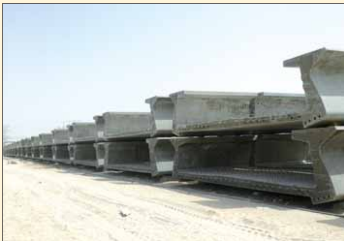
Obr. 8 Skládka železobetonových dílců ve výrobě prefabrikátů Fig. 8 Reinforced concrete segment stocking facility at the casting yard
