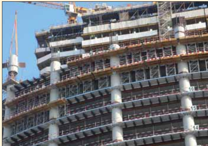
Obr. 12 Osazování ocelového opláštění sloupů na stavbě mrakodrapu Sky Tower v Abú Dhábí Fig. 12 Installation of the steel cladding of columns during the construction of the Sky Tower building in Abu Dhabi
