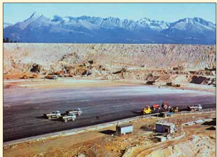
Obr. 2 Pohľad na stavebnú jamu hornej nádrže Fig. 2 A view of the construction pit for the upstream reservoir
