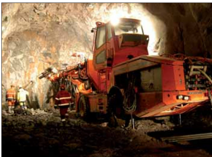
Obr. 4 Vrtání pomocí vrtacího stroje TAMROCK Obr. 4. Drilling by a TAMROCK drilling set
