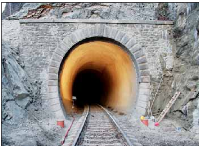
Obr. 6 Rekonstruovaný tunel Fig. 6. The tunnel after reconstruction
