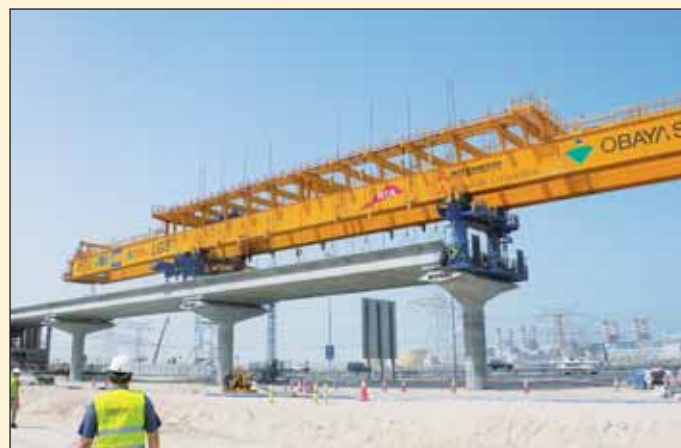
Obr. 7 Montáž viaduktu dubajského metra pomocí zavážecího mostu Fig. 7 Erection of a viaduct for the Dubai metro using an assembly bridge
