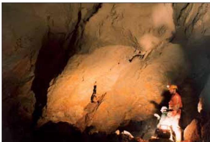
Obr. 9 Krasové jevy zastížené při ražbě tunelu Irlahull (ILF Consulting Engineers s. r. o.)
