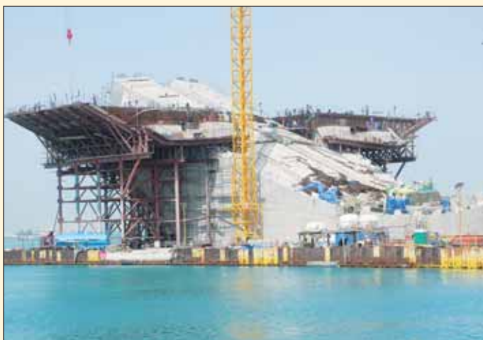
Obr. 11 Rozestavěný mohutný střední pilíř mostu Fig. 11 The mighty central pillar of the bridge
