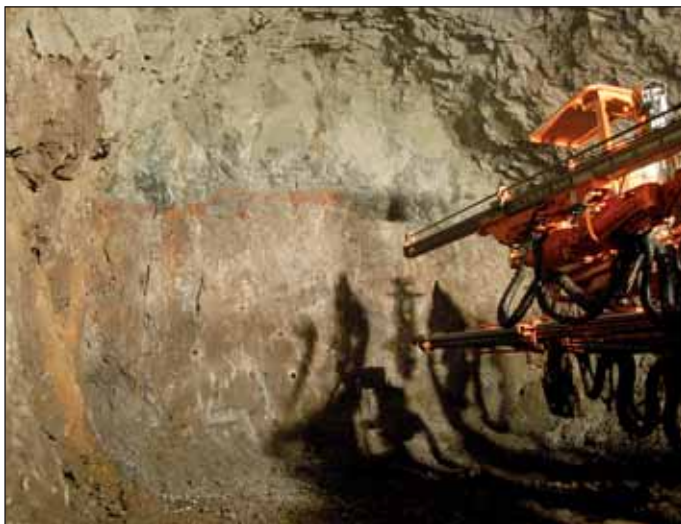
Obr. 6 Červená scoria zastížená ve spodní části čelby Obr. 6 Red scoria encountered in the lower part of the excavation face
