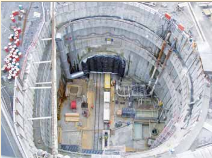
Obr. 1 Šachta pro sestavení TBM
