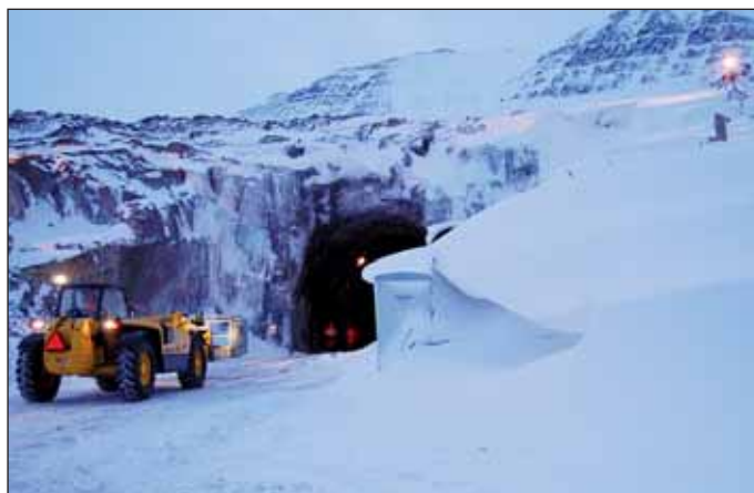
Obr. 5 Závěj před portálem tunelu Ólafsfjörður – leden 2007 Obr. 5 A snow bank in front of the Ólafsfjörður tunnel portal – January 2007
