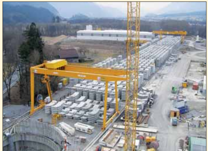
Obr. 2 Zařízení staveniště sekce H3-4
