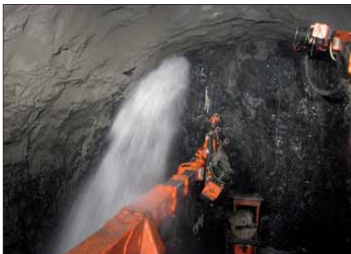
Obr. 7 Intenzivní přítoky vody z předvrtů Obr. 7 Intense water inflows from advance boreholes
