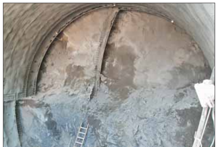
Obr. 3 Pohled do příportálového úseku STT ve třídě Va s konvergenčním profilem Fig. 3 View down the NTT portal section in class Va, with a convergence measurement station
