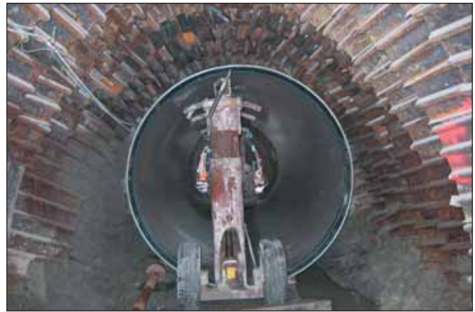
Obr. 8 Rúra Hobas DN 1800 po zatahnutí do štólne zberača Fig. 8 Hobas DN 1800 pipe after pulling into the gallery
