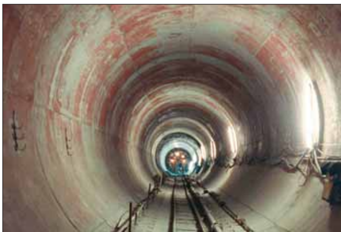
Obr. 1 Jednokolejný tunel trasy IVB pražského metra Fig. 1 Single-rail tunnel on the Line IVB of Prague metro
