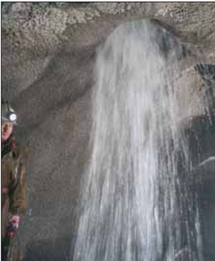
Obr. 5 Soustředěné výrony vody v průzkumné štole Višňové
