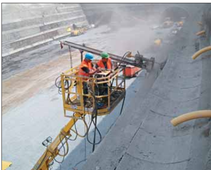
Obr. 5 Vrtací souprava Morath upevněná na konstrukci pracovního koše, ovládací pult vrtací soupravy je umístěn v pracovním koši Fig. 5 The Morath drill rig mounted on the working platform; the position of the control console of the drilling rig is in the working basket
