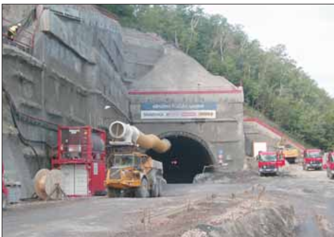
Obr. 1 Pohled na provizorní východní portál Fig. 1 View of the temporary East Portal
