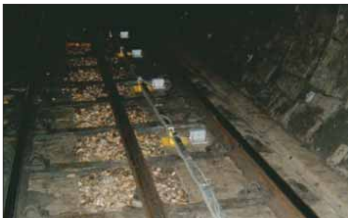
Obr. 3 Elektrické vodováhy (vlevo) a sklonoměry (vpravo) instalované na trati Fig. 3 Electrolevel beams (left) and tiltmeters (right) installed on track
