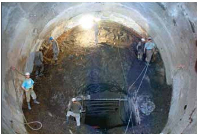
Obr. 2 Ražba eskalátorového tunelu stanice Hloubětín Fig. 2 Excavation of the escalator tunnel in the Hloubětín Station
