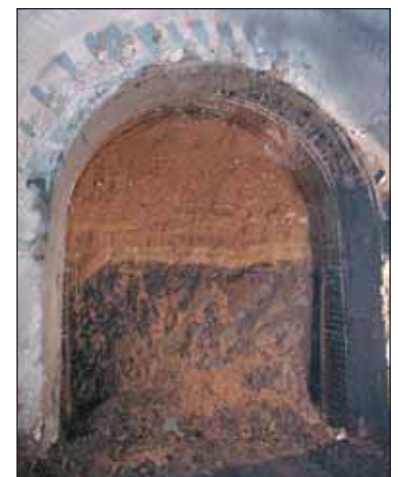
Obr. 4 Fotografie geologických poměrů na čele výrubu pod Václavským náměstím Fig. 4 Photo of geological conditions at the excavation face under Wenceslav Square
