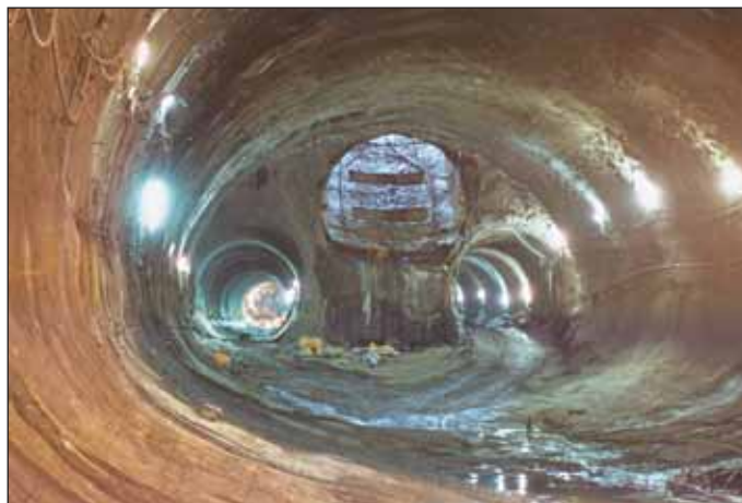
Obr. 4 Výrub jednolodní stanice Kobylisy
