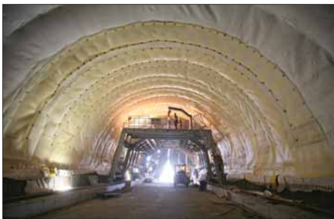
Obr. 2 Zahájení izolačních prací v tunelové trubě A Fig. 2 Commencement of installation of the waterproofing
