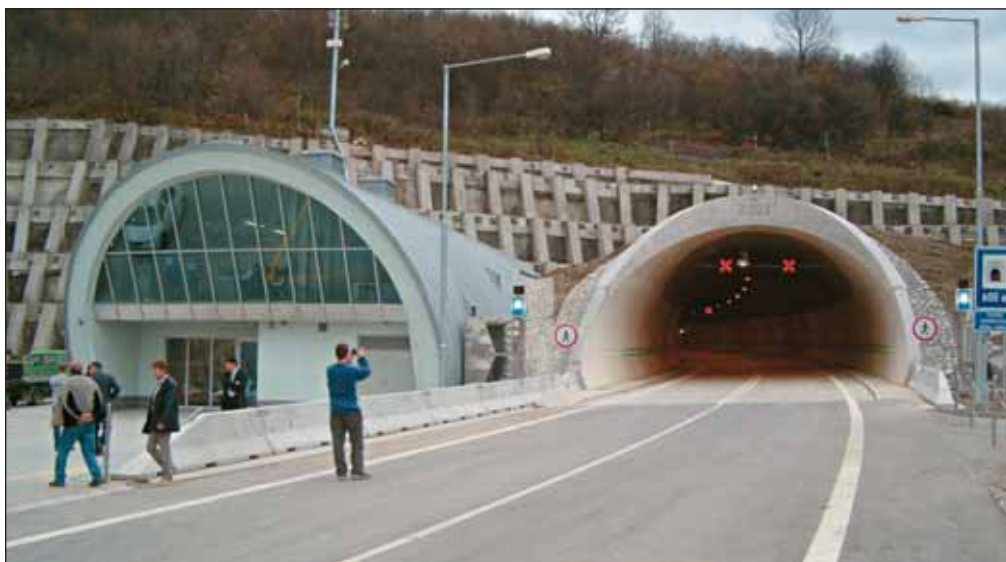
Obr. 1 Riadiaci dispečing tunela Horelica so západným portálom od Čadce Fig. 1 Open cut for the entrance portal
