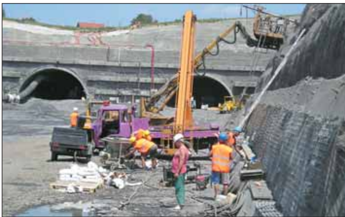
Obr. 6 Provádění injektáže Fig. 6 Grout injection operation
