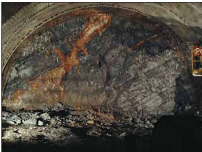
Obr. 6 Čelba JTT – střídání břidlic a křemenců Fig. 6 STT excavation face – alternation of shale and quartzite
