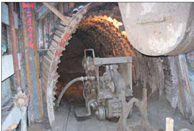
Obr. 5 Štôľňa zberača razená v oblúkovom profile s pažením Union plechmi Fig. 5 The vaulted-profile gallery excavation using UNION steel sheet lagging
