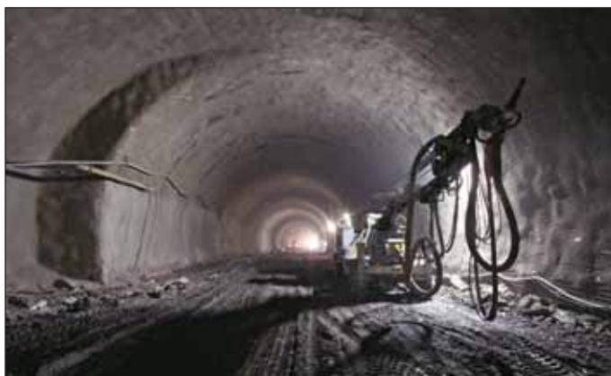
Obr. 1 Primární ostění tunelové trouby B Fig. 1 Primary lining of the tunnel tube B
