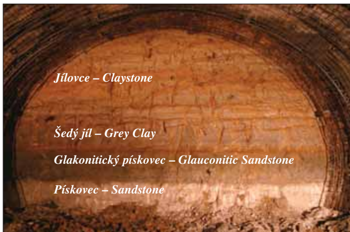
Obr. 1 Geologický profil tunelu pod mostními objekty Fig. 1 Geological profile of the tunnel under the bridge structures
