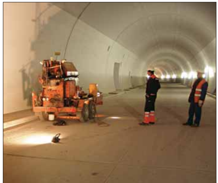
Obr. 6 Finálna úprava rezaných škár zálievkou Fig. 6 Final treatment of cut joints using hot-applied sealant
