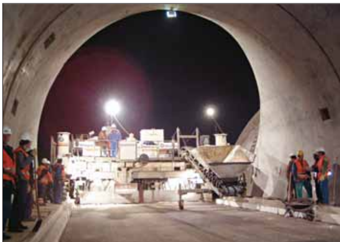
Obr. 5 Začiatok betonáže krytu pred severným portálom Fig. 5 Beginning of the casting of the pavement in front of the northern portal
