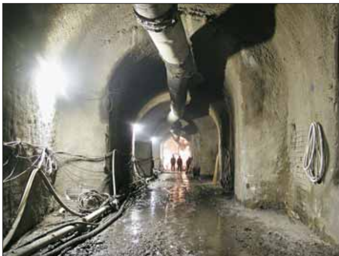
Obr. 2 Fotografie z ražby kolektoru na Karlově náměstí Fig. 2 Photo of the utility tunnel excavation in Charles Square
