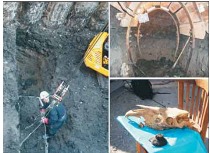
Obr. 7 Organické sedimenty mokřadu v okolí ústí ul. Školské do ulice Vodičkovy. Nalevo šachta Š 26 u „Dívčí školy“, vpravo dole lebka koně, nalezená v této šachtě, vpravo nahoře štola pro opravu kanalizačního sběrače nad úrovní kolektoru
