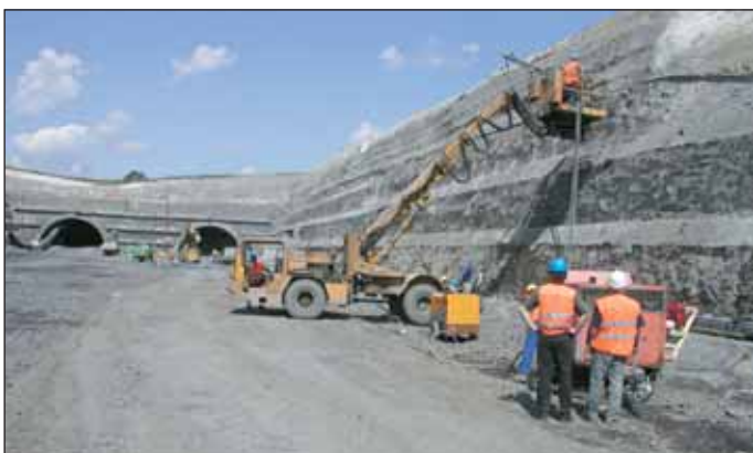
Obr. 3 Zahájení vrtání kotev dne 27. 6. 2005 Fig. 3 Commencement of installation of the self-drilling anchors on 27.6.2005
