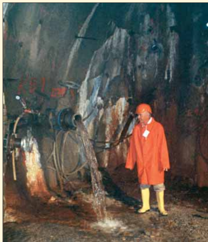
Obr. 3 Odvodňovací vrt v čelbe konvenčne razeného tunela (Foto F. Klepsatel)
