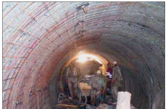
Obr. 7 Průzkumná štola Višňové – ražba TBM Fig. 7 The Višňové exploration gallery – TBM excavation
