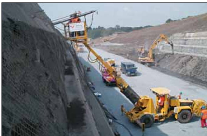
Obr. 4 Pokračování dalšího vrtání dne 1. 7. 2005 po výměně pracovní plošiny Fig. 4 Continuation of other installation of self-drilling anchors on 1. 7. 2005, after replacement of the hoisting platform
