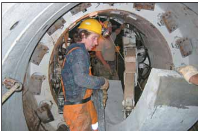
Obr. 3 Ukladanie železobetónových segmentov pomocou výložníkového podávača Fig. 3 Installation of reinforced concrete segments using an erector
