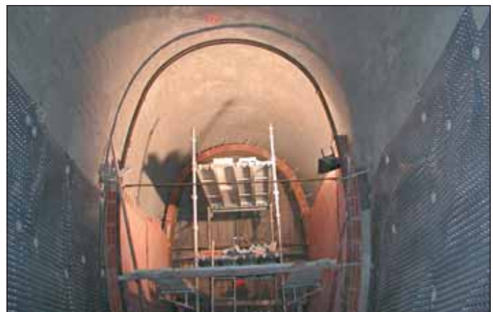
Obr. 10 Zdění cihelného obkladu (ditto) Fig. 10 Erection of the brick lining (ditto)
