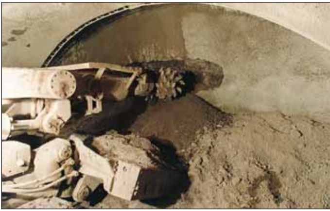
Obr. 3 Ražba kaloty v SST stanice Hloubětín
