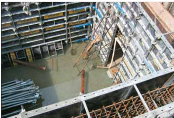
Obr. 6 Debnenie stien revíznej šachty Fig. 6 Manhole walls formwork
