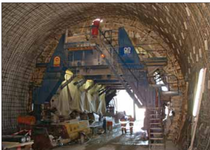
Obr. 2 Betonáž definitívneho ostenia razeného tunela Fig. 2 Casting of final lining in the mined tunnel
