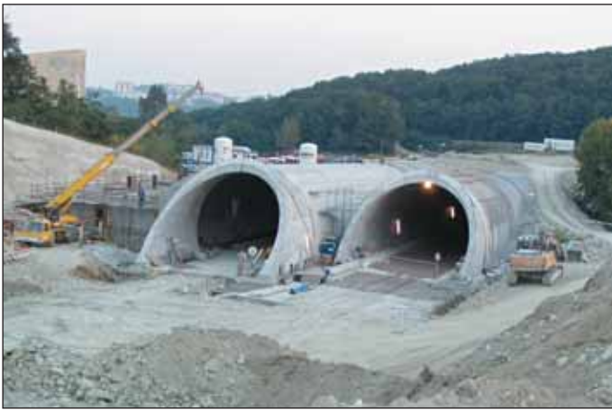
Obr. 4 Severný portál tunela so zasypávaním hĺbených úsekov Fig. 4 Northern portal of the tunnel with backfilling of the cut-and-cover sections
