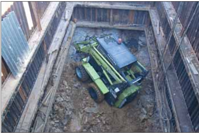
Obr. 7 Malý lopatový nakladač na dne pracovnej jamy Fig. 7 A small shovel loader at the construction shaft bottom
