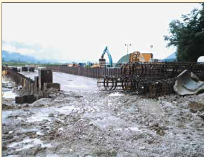
Obr. 2 Výstavba hĺbeného tunela (Foto F. Klepsatel)
