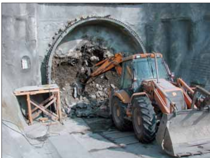
Obr. 2 Zahájení ražeb z portálu Komořany Fig. 2 Commencement of excavation from the Komořany portal
