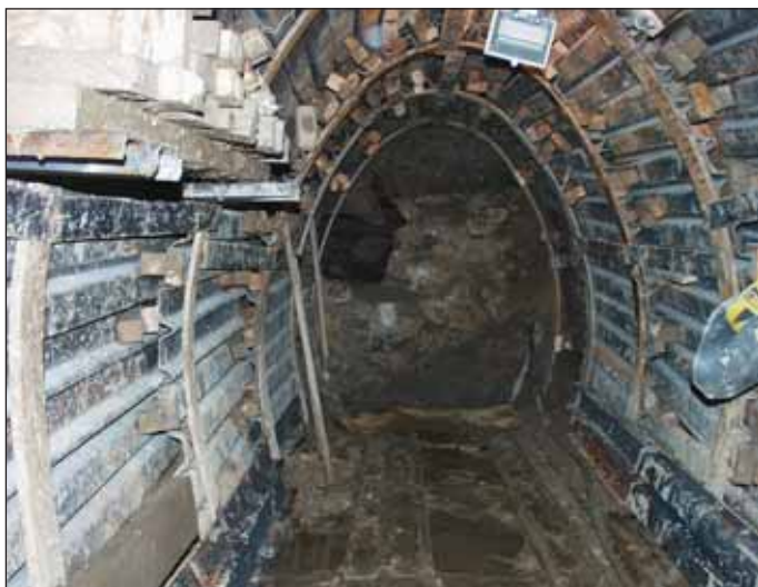
Obr. 3 Písek – štola ražená klasickým způsobem skrz stávající kamennou kanalizaci Fig. 3 Písek – the gallery driven conventionally through the existing stone sewer
