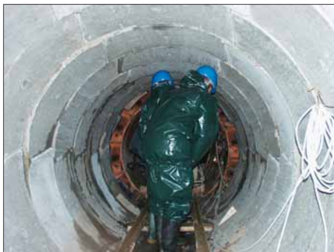
Obr. 2 Štola ražená nemechanizovaným štítem na stavbě Písek – Palackého sady
