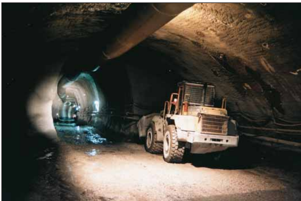
Obr. 2 Zvětšený profil štoly velikosti kaloty budoucího tunelu Fig. 2 Enlarged cross-section of the gallery with dimensions equal to top heading of the future tunnel
