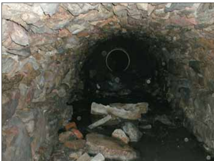
Obr. 1 Stávající kamenná stoka v Písku s patrnou provizorní opravou po její havárii
