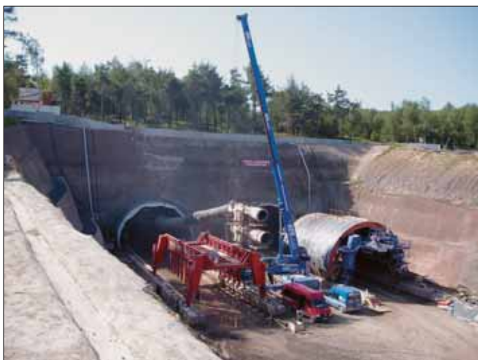
Obr. 1 Pohled na severní portál Fig. 1 A view of the north portal
