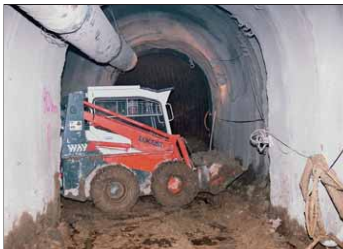
Obr. 5 Kolový nakladač LOCUST 752 TUNEL ve štolě Fig. 5 LOCUST 752 TUNEL wheeled loader in the tunnel
