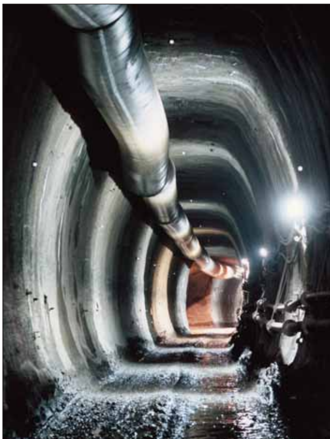
Obr. 1 Štola s ostěním ze stříkaného betonu Fig. 1 The gallery with shotcrete lining
