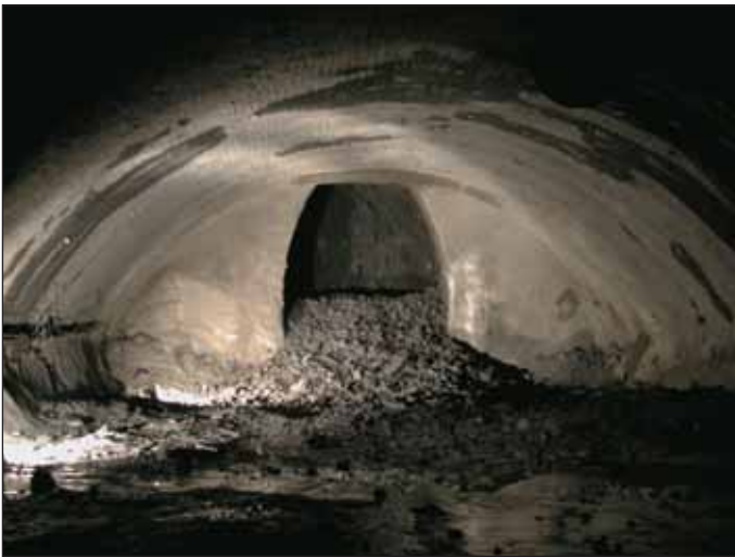
Obr. 4 Přechod z pokusného výrubu do průzkumné štoly Fig. 4 The transition from the trial excavation to the exploration gallery
