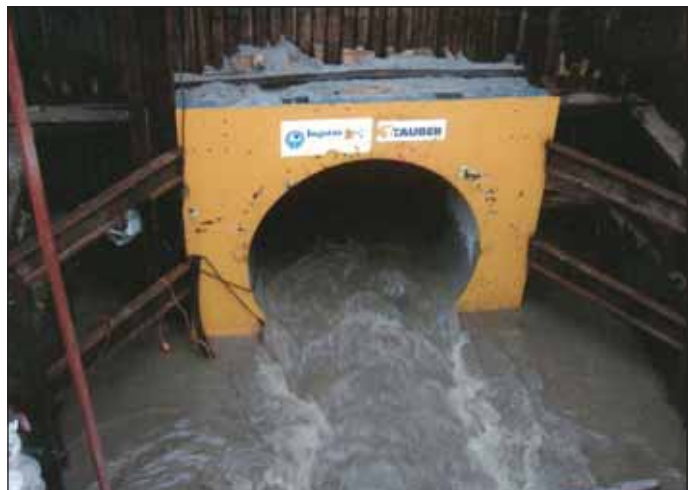
Obr. 4 Průnik dešťových vod do nově budované stoky – pohled do startovací šachty štítu
