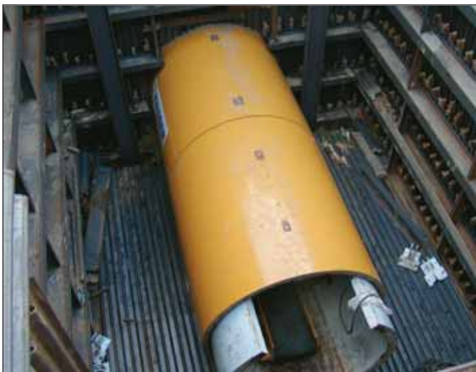
Obr. 7 Razičí štít ve startovací šachtě Š4 těsně před zahájením razičích prací Fig. 7 The shield in the launching shaft Š4 before the excavation commencement
