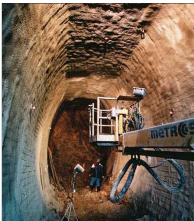
Obr. 3 Pohled na čelbu štoly Fig. 3 The gallery face
