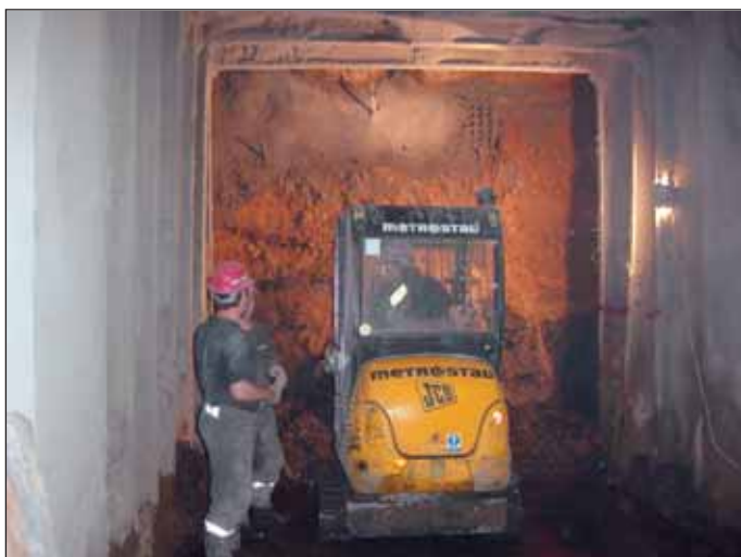
Obr. 4 Minibagr JCB 8017 na čelbě Fig. 4 JCB 8017 mini-excavator at the face
