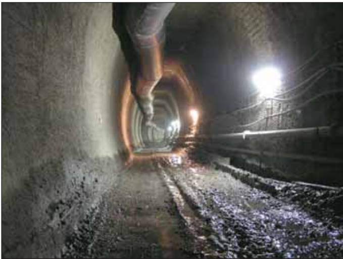
Obr. 3 Průzkumná štola Fig. 3 The exploration gallery
