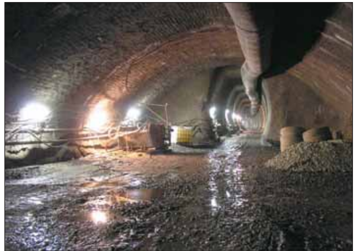
Obr. 5 Pokusný výrub na šířku kaloty silničního tunelu a průzkumná štola Fig. 5 Trial excavation with a width of the road tunnel's calotte, and the exploration gallery
