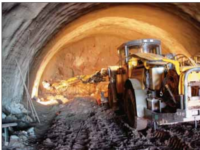
Obr. 5 Ražba kaloty LTT Fig. 5 LTT top heading excavation
