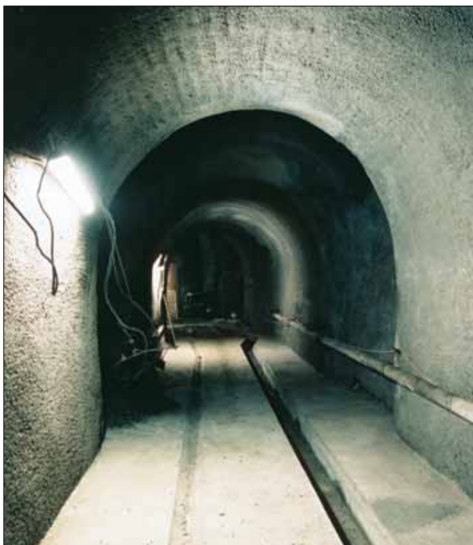
Obr. 7 Definitivní ostění kolektoru
