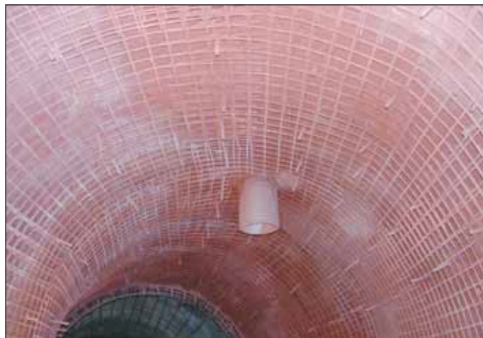
Obr. 6 Primární ostění s nástřikem izolace MONOCRETE MONOMIX XP TH Fig. 6 Primary lining with waterproofing spray MONOCRETE MONOMIX XP TH
