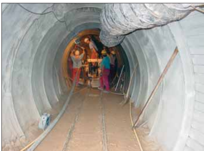
Obr. 6 Klasičky ražená štola ve skalním masívu Kániho vrchu Fig. 6 The gallery driven conventionally through the rock massif of Káni Vrch hill
