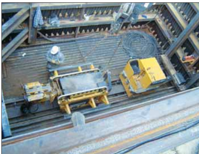
Obr. 4 Lokomotiva a speciální vůz pro přepravu železobetonových segmentů a jejich montáž ve štolě Fig. 4 The locomotive and RC segment transport and installation car
