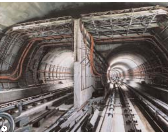
Obr. 5 Stanice Kobylišy při montáži technologie a vnitřních úpravách Fig. 5 Kobylišy station in the phase of equipment installation and interior finishing
