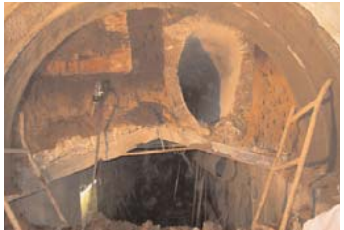
Obr. 3 Dokončování raženého profilu v ulici Koblizná Fig. 3 Finishing of the mined profile in Koblizna Street
