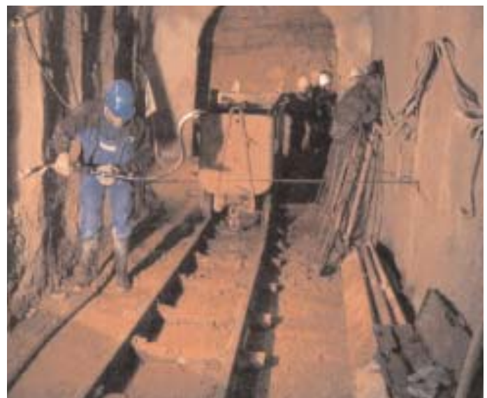
Obr.6 Měření konvergence v kolektoru Kozí Fig.6 Convergence measurement in the Kozí collector
