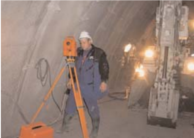
Obr. 12 Geodetické sledování bodů konvergenčního profilu Fig. 12 Geodetic monitoring of points of a convergence section
