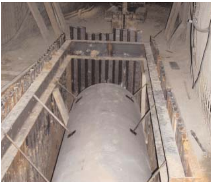
Obr. 4 Ukládání kanalizace průměru 1000 mm pod podlahu kolektoru Fig. 4 Laying of the 1000mm sewer under the collector's floor
