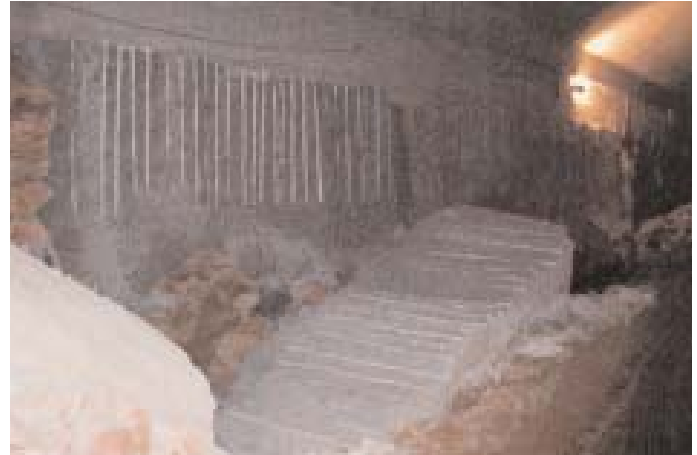
Obr. 4 Úprava podzemních stěn Fig. 4 Adjustment of a surface of diaphragm walls
