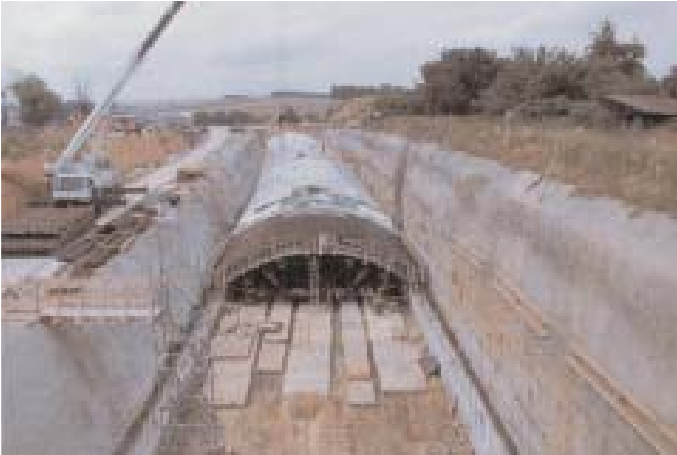
Obr. 3 Výstavba hloubeného tunelu Fig. 3 Construction of a cut-and-cover tunnel
