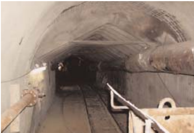
Obr. 2 Ražba sníženého profilu Fig. 2 Excavation of the reduced cross section
