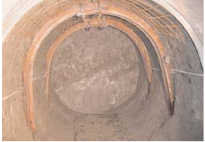
Obr. 9 Příprava měření napjatosti konvergenční metodou v kruhovém profilu rozrážky R2 Fig. 9 Preparation of stress measuring by convergence method in the circular section of the test gallery R2
