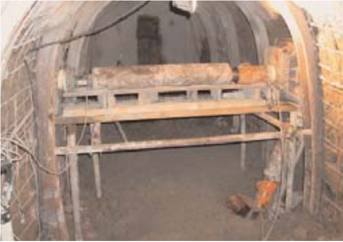
Obr. 7 Příprava smykové zkoušky v rozrážce R1 Fig. 7 Preparation of a shear test in the test gallery R1
