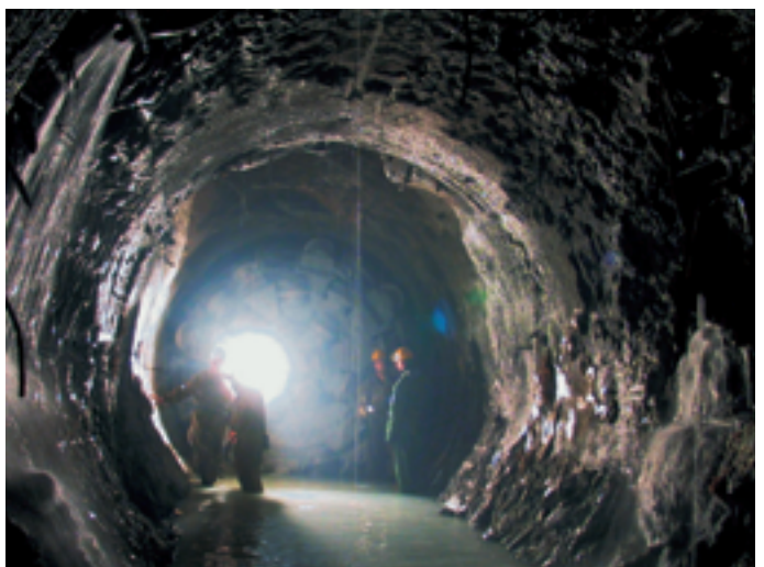
Obr. 17 Kontrolné sanačné práce pred cúvnutým raziacim strojom v čiastočne stabilizovanej poruche Fig. 17 Rock treatment ahead of the retracted cutterhead within a partially stabilised weakness zone
