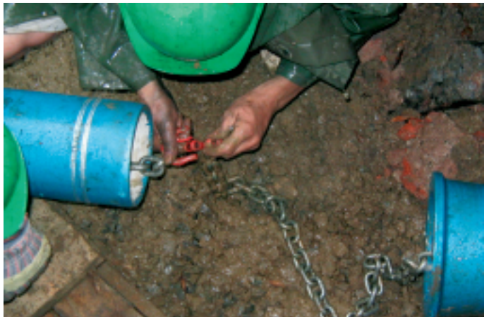
Obr. 2 Do hrdla zatažené sekce byl vložen těsnící kroužek, následuje spojení tažného řetězu pomocí karabiny, vyrovnání a napojení trubních sekcí Fig. 2 The packing ring was inserted into the socket of the pipe section in the microtunnel followed by the connection of the pulling chain with shackle. Aligning and connecting the pipe sections
