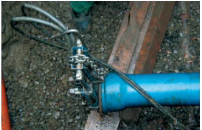
Obr. 4 Detail napínáku na hrdle nové trubní sekce. Tahem řetězu se hladký konec dotlačí po značku a uzamkne se zámekem VI v hrdle předchozí trubky Fig. 4 The most important construction element on the bottom of the manipulation trench: steel U-section laid in the direction and grade of the drawn main
