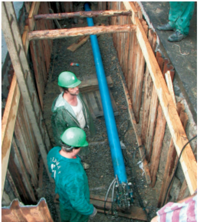
Obr. 6 Další trubní sekce je připravena k zatažení do mikrotunelu Fig. 6 Another pipe section is prepared for pulling in the microtunnel
