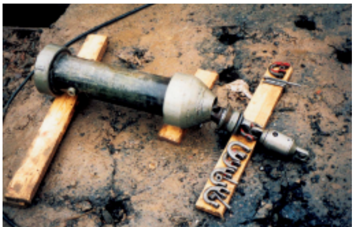
Obr. 8 Detail tažné hlavy a tažného mezikusu (zprava do leva): obrtlík – tažný závěs, na který je napojen tažný řetěz – hladký konec první trubní sekce umístěný v tažném mezikusu je zajištěn imbusovým šroubem proti vytržení Fig. 8 The detail of the towing head and intermediate pulling pipe. From right to left: swivel – the pulling shackle which the pulling chain is connected with – the spigot of the first main pipe situated in intermediate pulling pipe is secured with a hexagonal socket screw against whipping out
