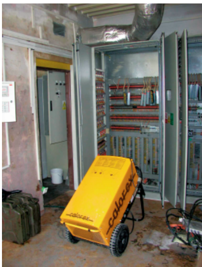
Obr. 4 Vysoušení prostor velínu po prvotní očiště Fig. 4 Drying the interior of the control centre after the initial clean-up
