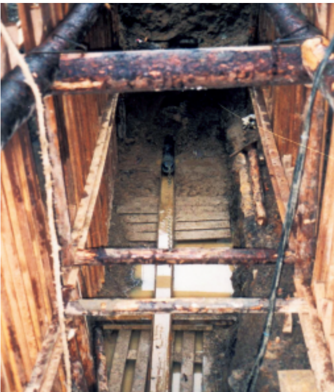
Obr. 7 Nejdůležitější technologický prvek na dně manipulační rýhy: ocelový U-profil položený a fixovaný ve směru a sklonu zatahovaného trubního řadu Fig. 7 The most important construction element on the bottom of the manipulation trench: steel U-section laid in the direction and grade of the drawn main
