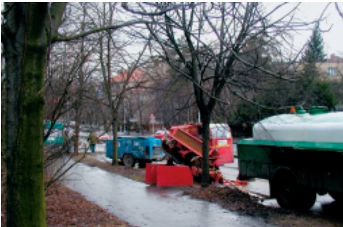
Obr. 1 Stanoviště vrtné soupravy J 5515D Terra-Jet v Jeremenkově ulici při zavrtávání pilotního vrtu pro mikrotunel budoucího vodovodního řadu. Veškeré práce probíhají při nepřerušném silničním provozu Fig. 1 The position of the J 5515D Terra-Jet rig in Jeremenkova Street in spudding of the pilot hole for microtunnel of the future water main. All works are running under continuous traffic
