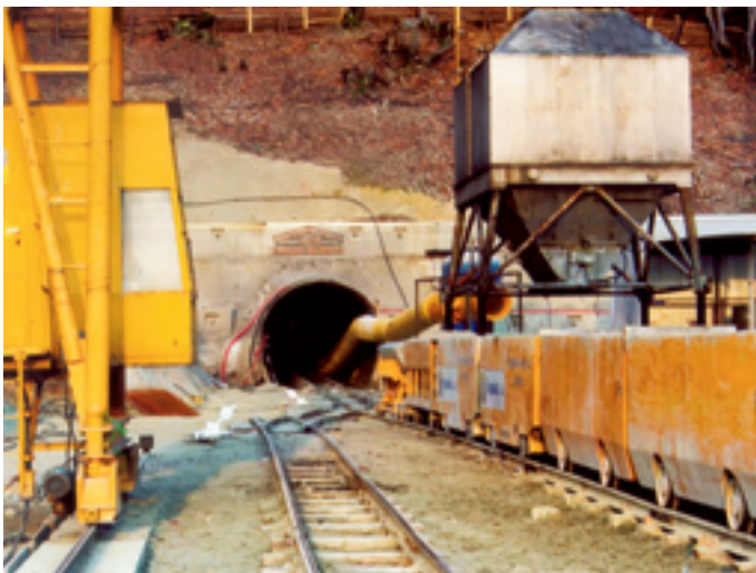
Obr. 16 Východný portál so súpravou vagónov Fig. 16 The portal East with the train
