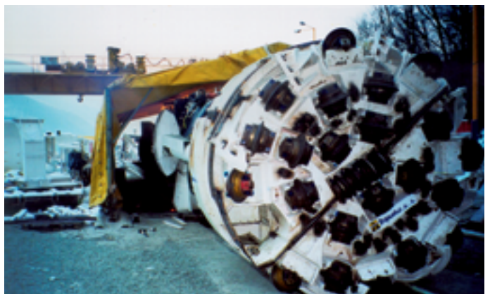
Obr. 13 Montáž raziaceho stroja na VP portáli pred vkráčaním do štólne Fig. 13 The TBM assembly at the portal East before entering the gallery
