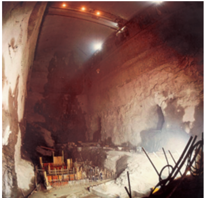
Obr. 14 PVE Dlouhé Stráně – komora VE v průběhu ražby Fig. 14 PPS Dlouhé Stráně – Cavern of underground power station during excavation
