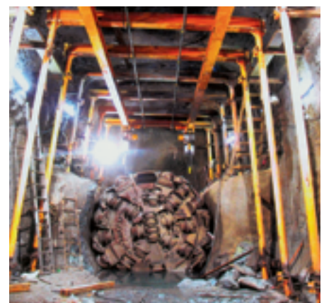
Obr. 9 Použitie technické zariadenie pre demonštráciu TBM v štólne Fig. 9 The equipment used for the TBM dismantling in the gallery
