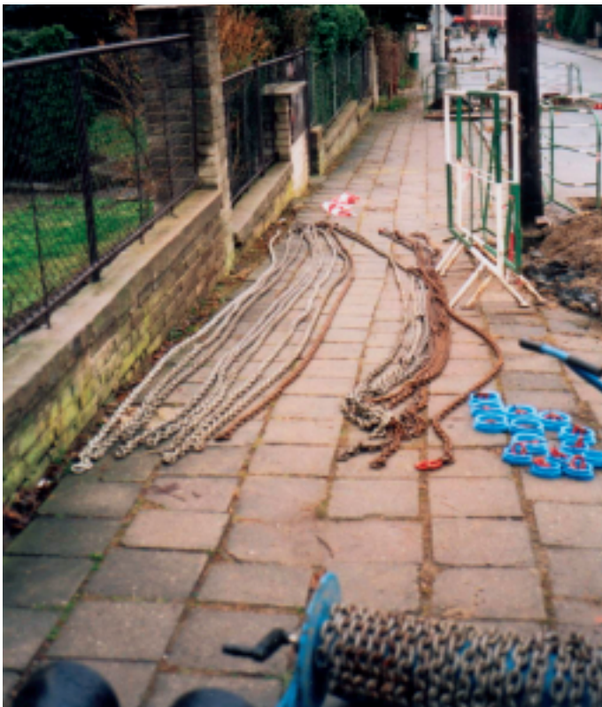
Obr. 5 Pohled na Darwinovu ulici od cílové rýhy. Na obrázku jsou patrné technologické přípojné šachtice ke každému domu. V popředí jsou uloženy na zemi tažné řetězy se spojkami
