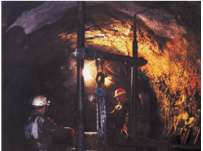
Obr. 15 Sondážny vrt s IVS-200 pre raziacou hlavou
