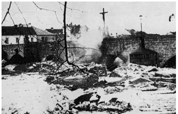
Foto 2 Nápor vody na kamenný most v roce 1954 Photo 2 Water attacking the Stone Bridge in 1954
