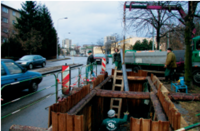
Obr. 3 Transport litinové trubní sekce opatřené tažným řetězem do manipulační rýhy. Pracoviště je označeno pouze výstražnými stojany a páskami. Silniční provoz není omezen Fig. 3 Transport of the cast iron pipe with pulling chain to the manipulation trench. The job site is indicated only with warning stands and tapes. The traffic is not limited
