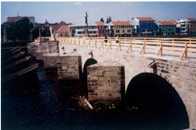
Obr. 4 Kamenný most 1. den po kulminaci povodně Fig. 4 The Stone Bridge on the 1st day after the flood culmination
