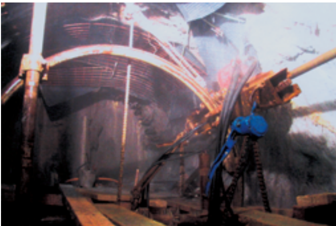
Obr. 11 Dalšia zo sedmich jímok úpadaného razenia zo západnej strany Fig. 11 Other one of the seven sumps for the downhill excavation from the west
