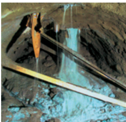
Obr. 7 Vzdialenosť 3503 m od východného portálu. Zabezpečenie čelby a výrubu striekaným betónom. Sústredený prítok vody z kaloty so súfóznym vyplavovaním Fig. 7 A distance of 3503 m from the portal East. The face and excavation support by shotcrete. Concentrated water inflow from the crown exhibiting the solid support
