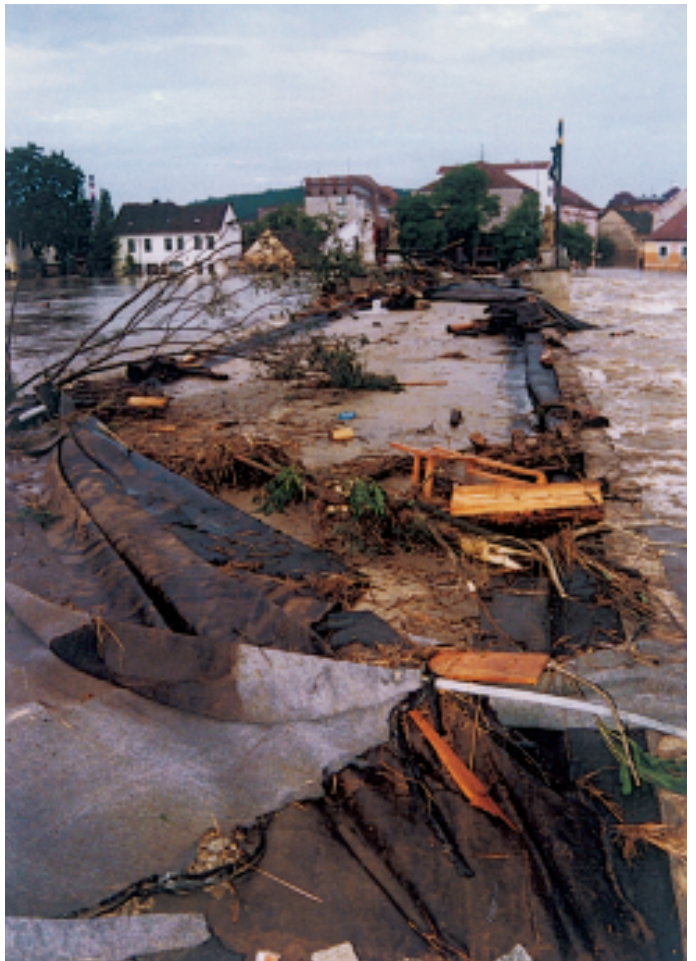
Obr. 5 Kamenný most pár dnů po povodni Fig. 5 The Stone Bridge a couple of days after the flood
