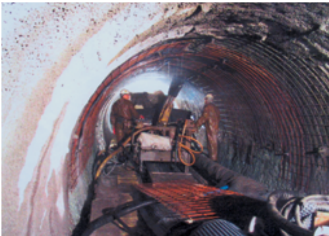
Obr. 14 Osadzovanie výstrojových prostriedkov z kotiev a kari sietí v pracovnej časti L2
