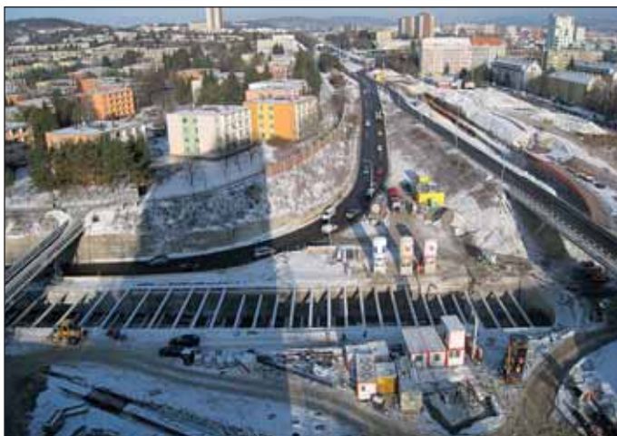
Obr. 8 Stavební jáma hloubené části Žabovřesky a bednění pro most na ulici Hradecká Fig. 8 Construction trench for the Žabovřesky cut-and-cover section and formwork for a bridge on Hradecká Street
