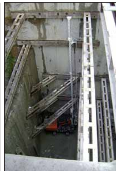
Obr. 5 Provedení tryskové injektáže dna stavební jámy TC Fig. 5 Jet grouting into the bottom of the construction pit for the services centre
