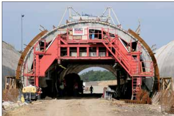
Obr. 6 Bednící vůz definitivního ostění dvoupruhového tunelu ve stavební jámě u sliveneckého portálu Fig. 6 Travelling formwork for the final lining of the double-lane tunnel in the construction trench at the Slivenec portal
