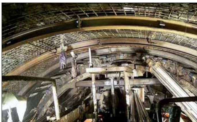
Obr. 12 Instalace vstrojení v klenbě TBM tunelu, ocelové rámy se sítí, třída vstrojení IV, stříkaný beton bude aplikován následně, případně i injektáž za ostění
