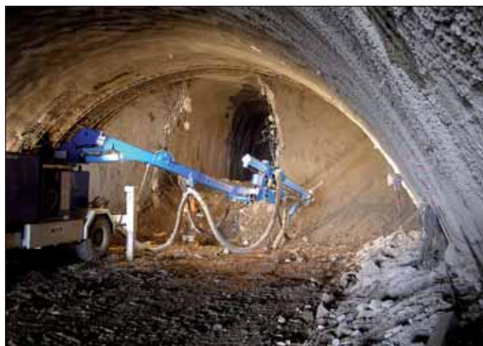
Obr. 2 Nástřik betonu primárního ostění v třípruhovém tunelu Fig. 2 Construction of shotcrete primary lining in the three-lane tunnel
