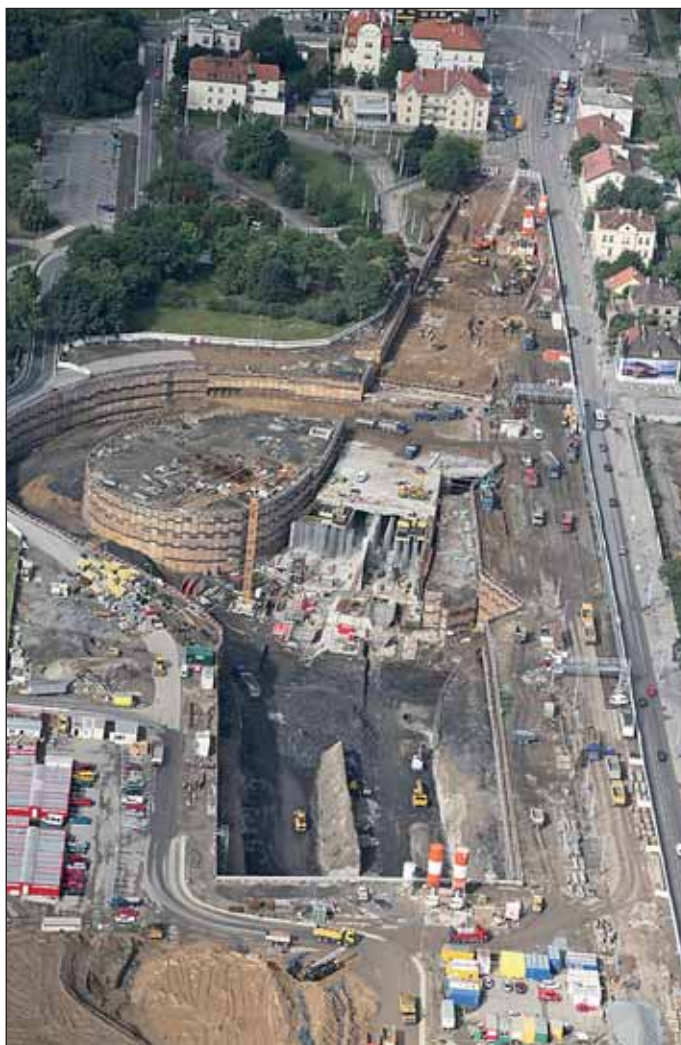
Obr. 9 Letecký pohled na staveniště Letná (7/2008) Fig. 9 Aerial view of the Letná construction site (7/2008)
