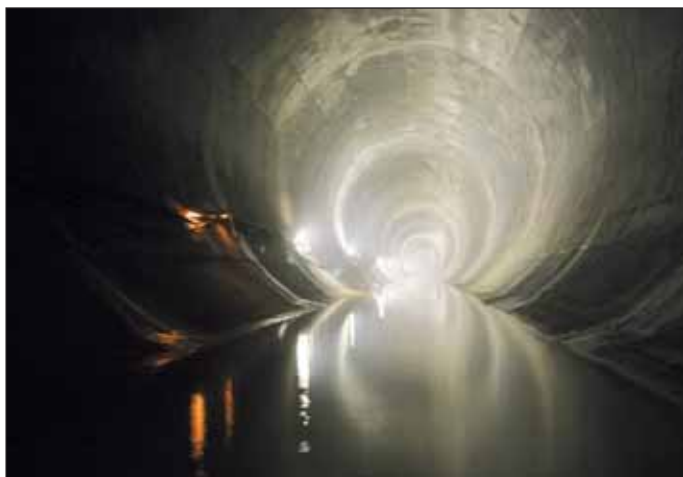
Obr. 13 Počáteční úsek hlavního tunelového přívaděče vystrojený prefabrikovanými železobetonovými segmenty
