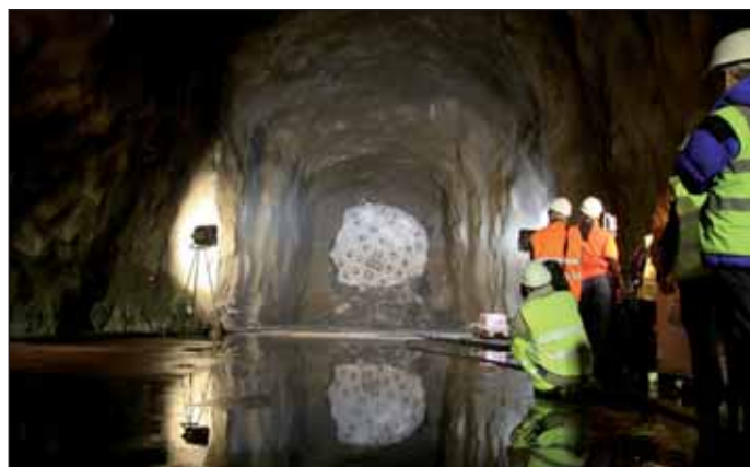
Obr. 8 Prorážka TBM 1 na hlavním tunelové přivaděči HRT, 9. září 2006 Fig. 8 TBM 1 breakthrough in the headrace tunnel HRT – 9/9/2006
