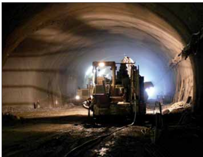
Obr. 7 Strojní sestava pro stříkaný beton ve dvoupruhovém tunelu Fig. 7 Equipment set for application of shotcrete in the double-lane tunnel
