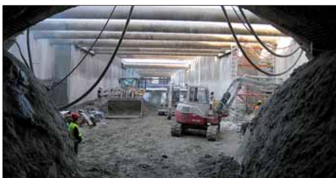
Obr. 7 Pohled na rozepřenou stavební jámu hloubené části Žabovřesky ze zárodku ražené části Fig. 7 View of the braced construction trench for the Žabovřesky cut-and-cover section, from a germ of the mined section
