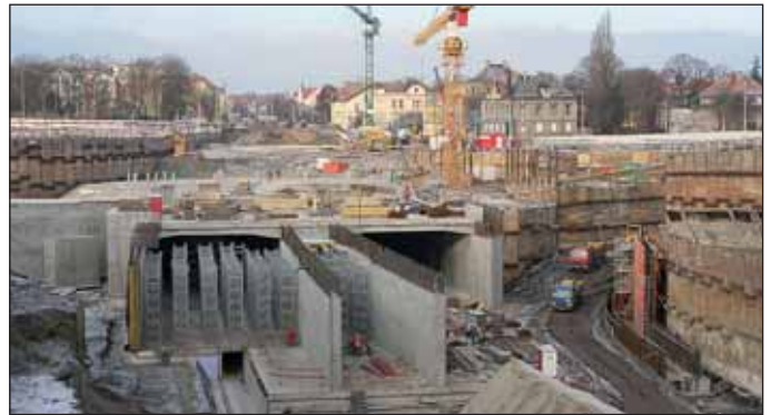
Obr. 2 Staveniště Letná, výstavba v otevřené jámě Fig. 2 Letná construction site, open trench
