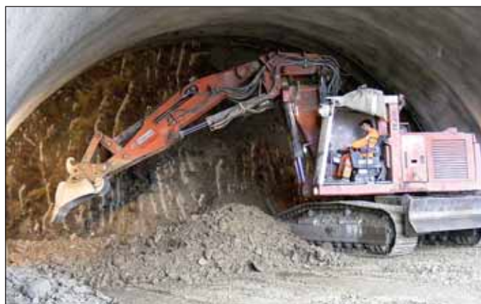
Obr. 4 Tunelový bagr na čelbě dvoupruhového tunelu při dorážce od lahovického portálu Fig. 4 Tunnel excavator at the double-lane tunnel excavation face during the completion of driving from the Lahovice portal
