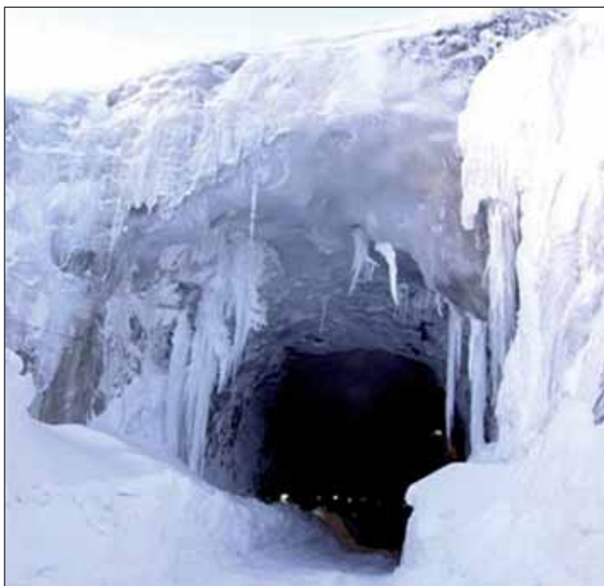
Obr. 1 Portál Surge tunelu po sněhové bouři. Odstraňování několikametrových rampouchů v portálových oblastech tunelů patřilo k běžným činnostem Fig. 1 Surge tunnel portal shortly after snowstorm; removing few metres long icicles in portal locations became a common working activity
