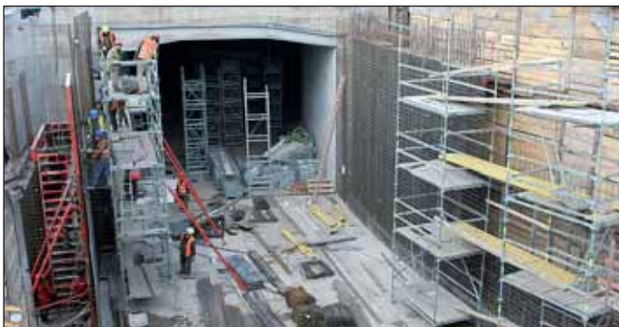
Obr. 3 Staveniště Letná, vjezdová rampa 4, výstavba dilatace R10 Fig. 3 Letná construction site, access ramp No. 4, construction of expansion block R10
