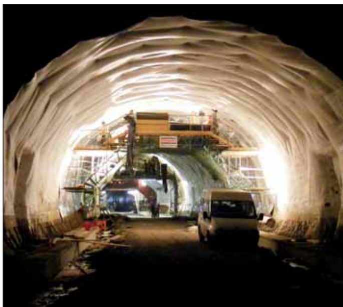
Obr. 11 Izolační práce v třípruhovém tunelu Fig. 11 Installation of waterproofing in the three-lane tunnel
