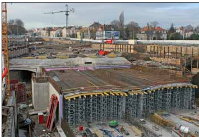
Obr. 10 Pohled na výstavbu hloubených tunelů Letná (11/2008) Fig. 10 A view of the construction of cut-and-cover tunnels in Letná (11/2008)
