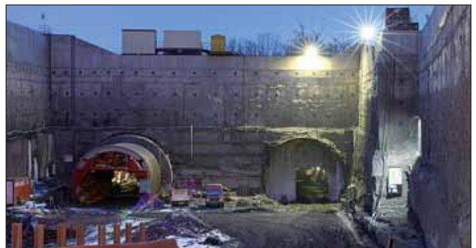
Obr. 6 Staveniště Trója, portály ražených tunelů Fig. 6 Troja construction site – mined tunnel portals
