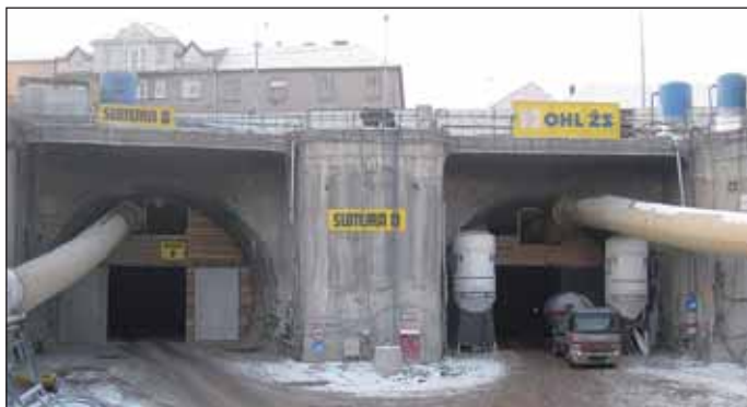
Obr. 1 Provizorní portál Královo Pole v zimním období Fig. 1 Královo Pole temporary portal in the winter season
