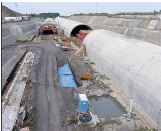
Obr. 9 Hloubené tunely u sliveneckého portálu Fig. 9 Cut-and-cover tunnels at the Slivenec portal
