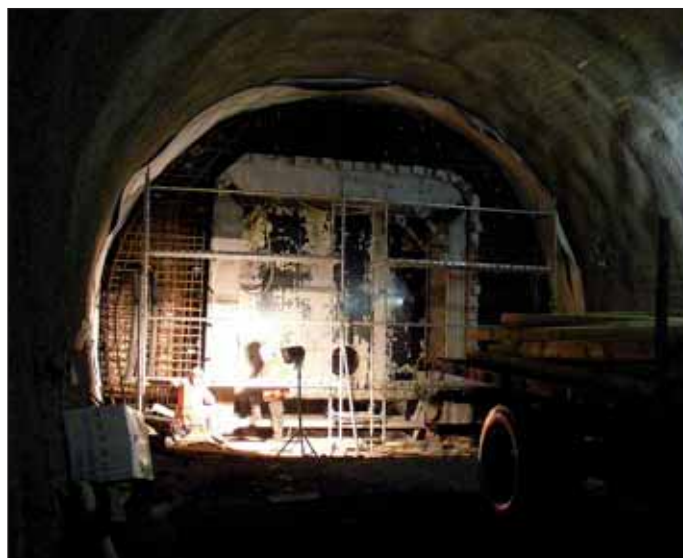
Obr. 10 Výztuž a bednění krčku na styku třípruhového tunelu a propojky Fig. 10 Reinforcement and formwork for a neck at the contact between the three-lane tunnel and a cross passage
