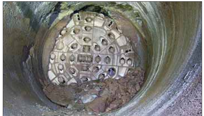
Obr. 9 Závěrečná prorážka TBM 3 na hlavním tunelové přivaděči HRT – 5. prosince 2006
