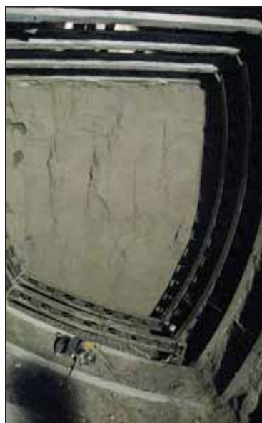
Obr. 4 Osazování výztužných rámu HEBREX v dolní štolu tunelu Fig. 4 Erection of HEBREX supporting frames in the lower part of the sidewall drift
