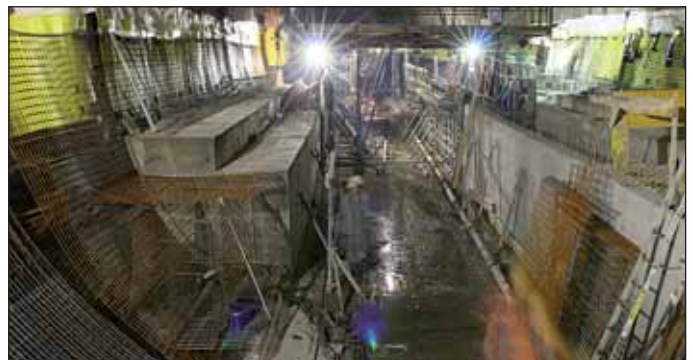
Obr. 4 Ražený tunel Špelc, provádění spodní klenby sekundárního ostění Fig. 4 Mined tunnel – construction of secondary lining of the bottom
