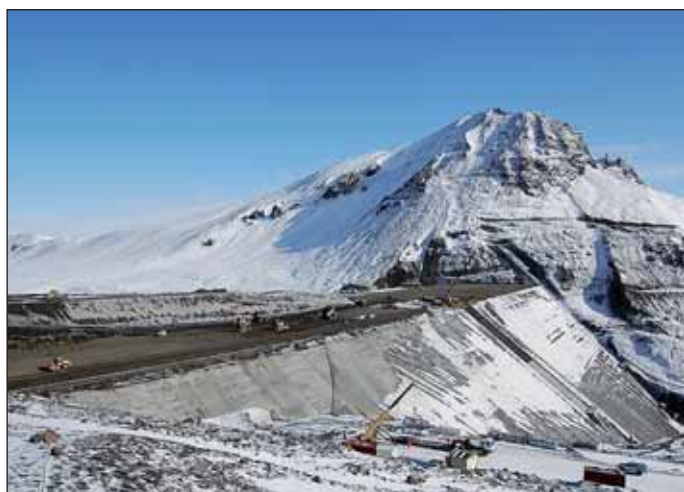
Obr. 2 Přehrada Kárahnjúkástífla během výstavby, v pozadí hora Kárahnjúkar Fig. 2 Kárahnjúkástífla Dam during construction with Kárahnjúkar mountain on background
