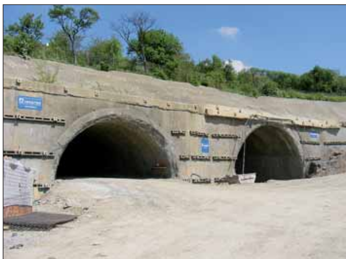
Obr. 5 Lahovický portál tunelu Fig. 5 Lahovice portal of the tunnel
