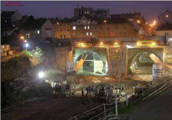
Obr. 1 Provizorní portál Královo Pole Fig. 1 Královo Pole temporary portal
