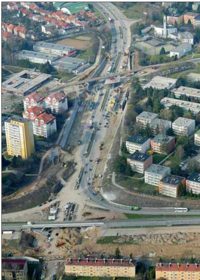
Obr. 1 Letecký pohled na prostor stavby tunelů Fig. 1 Aerial view of the tunnel construction area
