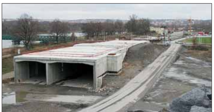
Obr. 8 Staveniště Trója, dokončené konstrukce dilatací 8, 9 a 10 hloubeného tunelu Fig. 8 Troja construction site – completed structures of expansion blocks No. 8, 9 and 10 of the cut-and-cover tunnel
