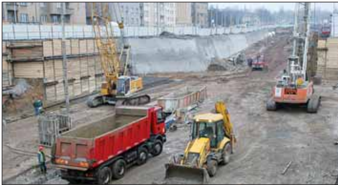
Obr. 1 Staveniště Hradčanská, celkový pohled od Špejcharu Fig. 1 Hradčanská construction site, overall view from Špejchar
