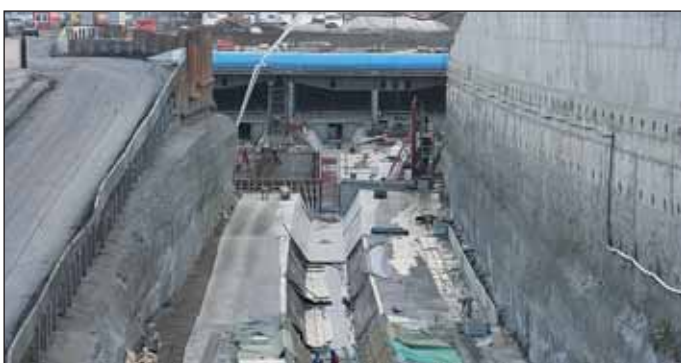
Obr. 7 Staveniště Trója, výstavba jižního hloubeného tunelu v jamách 6 a 4 Fig. 7 Troja construction site – southern tunnel tube construction in trenches No. 6 and 4
