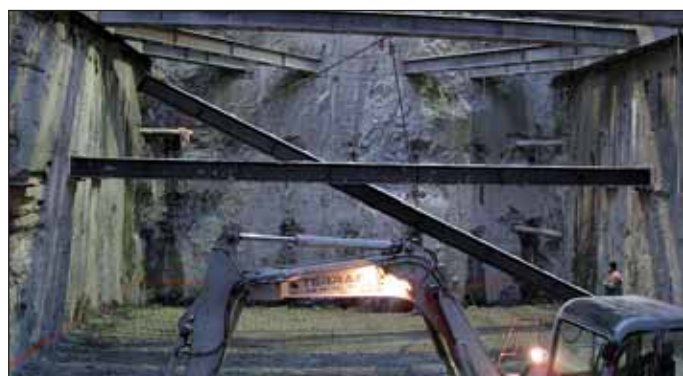
Obr. 6 Osazování ocelových rozpěr ve stavební jámě TC Fig. 6 Installation of steel braces in the construction pit for the services centre structure
