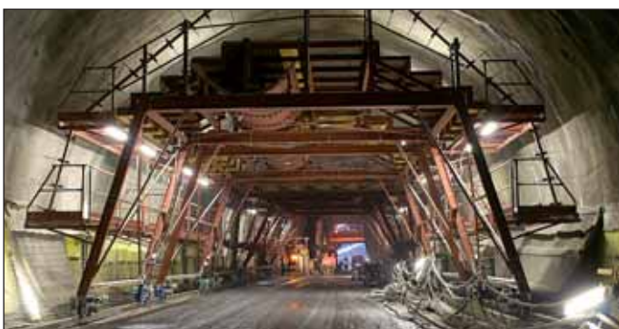
Obr. 5 Ražený tunel, profilovací vůz klenby primárního ostění Fig. 5 Mined tunnel – primary lining profile checking gantry
