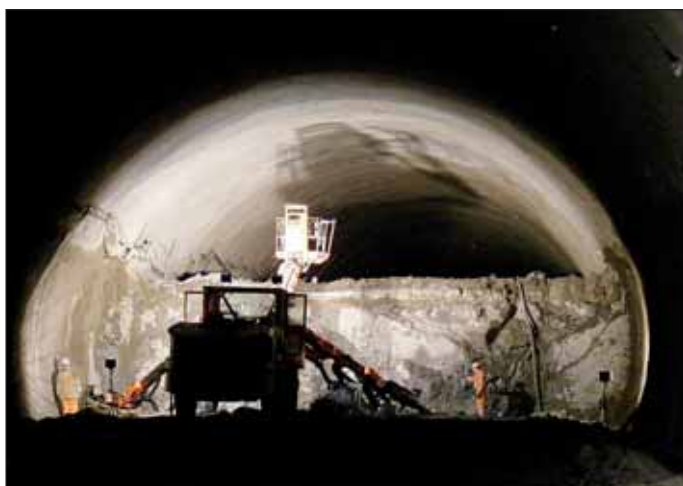
Obr. 3 Vrtání čelby lavice v třípruhovém tunelu Fig. 3 Excavation face drilling – the bench in the three-lane tunnel
