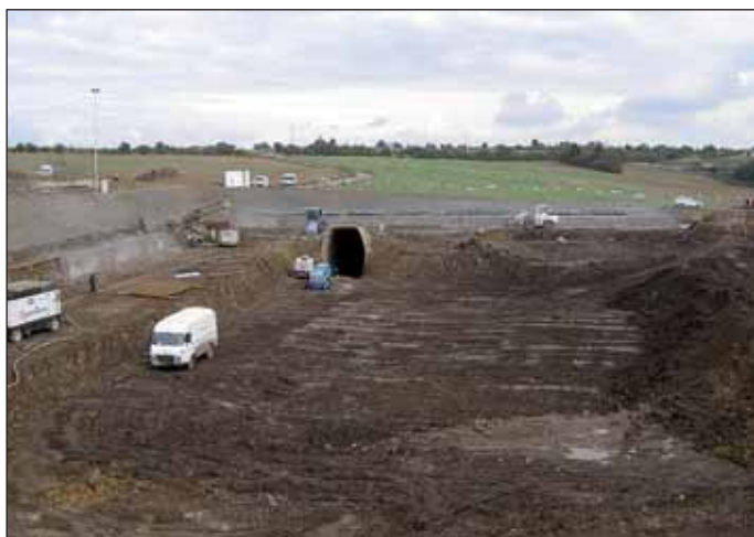
Obr. 1 Hloubení stavební jámy v prostoru sliveneckého portálu Fig. 1 Excavation of the construction trench in the Slivenec portal area
