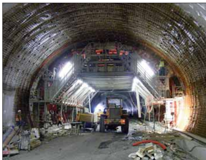
Obr. 8 Bednicí vůz definitivního ostění v třípruhovém tunelu Fig. 8 Travelling formwork for the final lining in the three-lane tunnel
