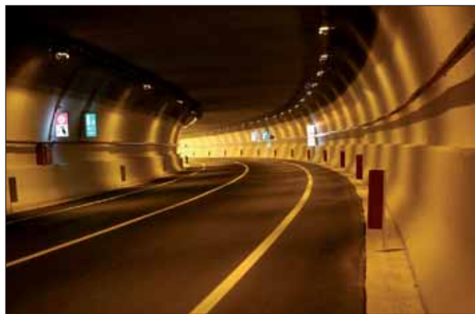
Obr. 6 Tunel Monte Cuneo po dokončení
