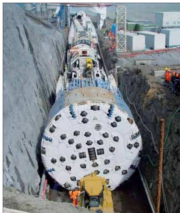
Obr. 6 Montáž TBM 1 před portálem štoly Adit 1 Fig. 6 TBM 1 assembling in front of the Adit 1 portal
