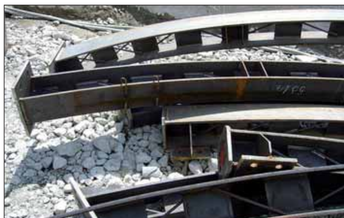
Obr. 2 Výztužné prvky HEBREX Fig. 2 HEBREX reinforcement elements
