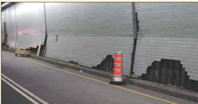
Obr. 1 Po celé délce tunelu v místě zrezivělé konstrukce chybí obložení Fig. 1 The cladding is missing throughout the tunnel length in the locations where the structure is damaged by rusting
