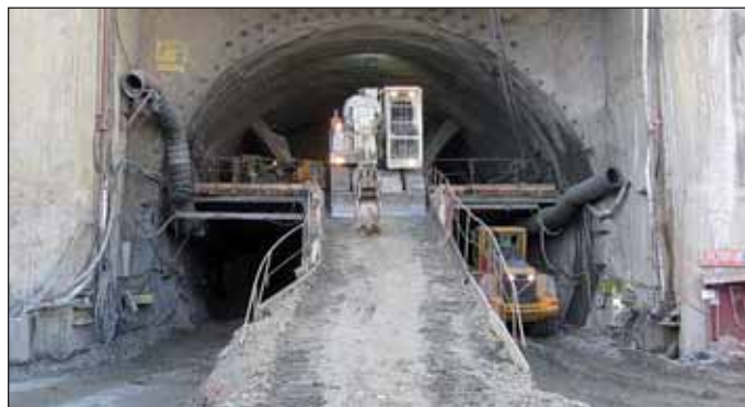
Obr. 2 Nájezdová rampa ke kaloři tunelu u provizorního portálu Královo Pole Fig. 2 Approach ramp to the top heading at the Královo Pole temporary portal
