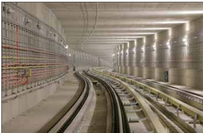
Obr. 5 Hloubený tunel mezi stanicemi Střížkov a Prosek Fig. 5 The cut-and-cover tunnel between Střížkov and Prosek stations
