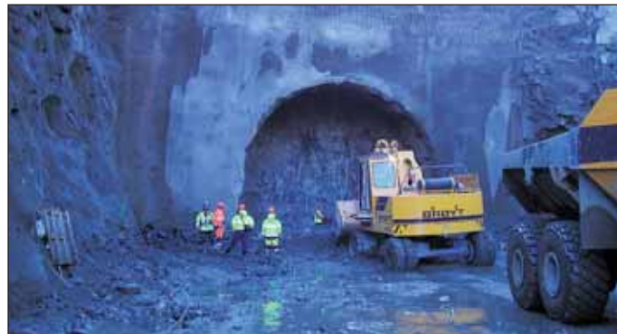
Obr. 2 Portál tunelu po vyražení prvního postupového kroku Fig. 2 Tunnel portal after the first excavation round
