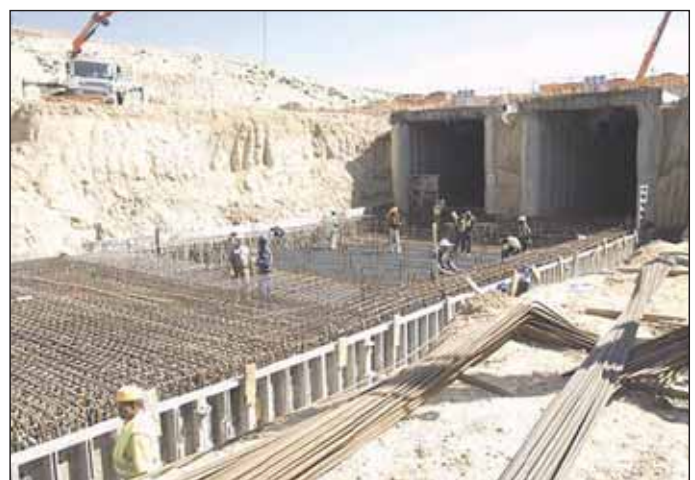
Obr. 9 Výstavba ve svaňované jámě [4]
