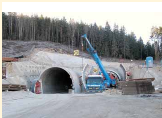
Obr. 2 Hĺbené tunely na východnom portáli Fig. 2 Cut-and-cover tunnels at the eastern portal
