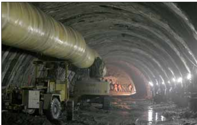
Obr. 7 Odstavená mechanizace při práci na čelbě JTT
