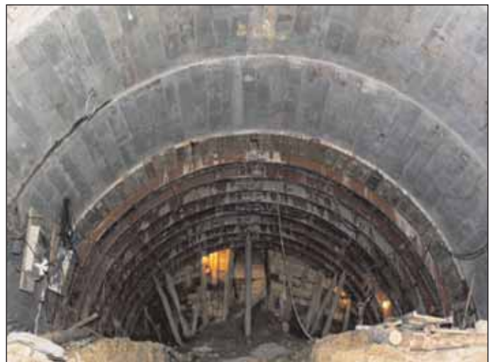
Obr. 8 Madridská tunelovací metoda [3]
