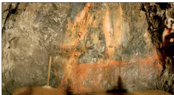
Obr. 6 Pohled na čelbu po odtěžení rubaniny při délce záběru 5,3 m Fig. 6 View of the face after the muck removal, at the excavation round length of 5.3m
