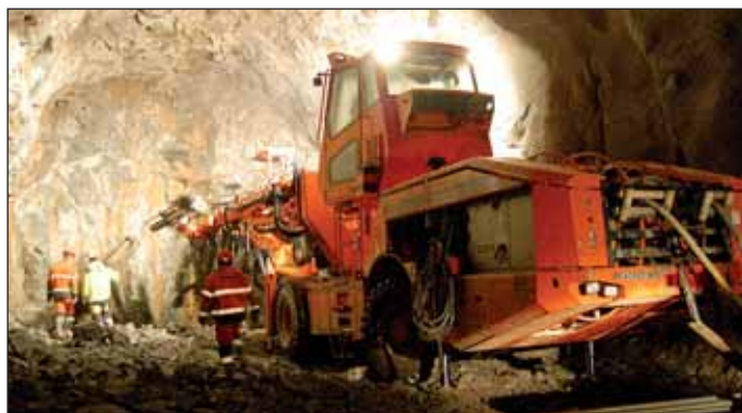
Obr. 4 Vrtání čelby pro odpal vrtacím vozem Axera Tamrock Fig. 4 Face drilling for the blasting, using an Axera Tamrock drilling rig
