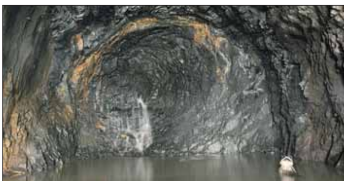
Obr. 7 Zatopené čelo tunelu po odpale a odtěžení (úpadní ražba) Fig. 7 Inundated tunnel heading after the blasting and removal of muck (a downhill drive)
