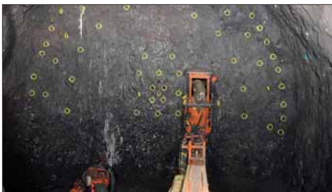
Obr. 5 Osazování náloží do vrtů po navrtání čelby Fig. 5 Priming of charges after the face drilling
