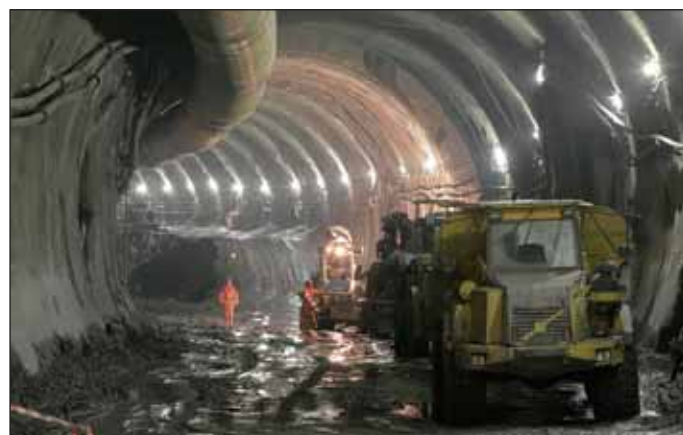
Obr. 6 Pohled do STT po vyražení opěří tunelu
