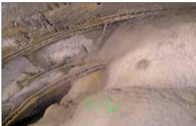
Obr. 3 Zajištění čelby a nadloží tunelu střikaným betonem a injektovanými IBO kotvami (úsek 90 m)
