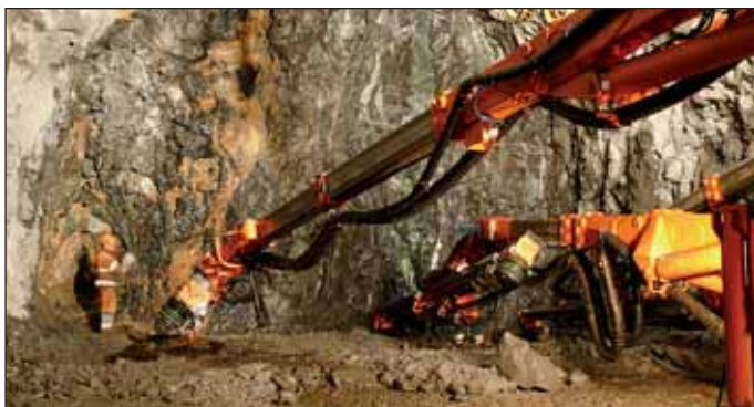
Obr. 3 Vrtání čelby pro další záběrový krok Fig. 3 Face drilling for the next excavation round
