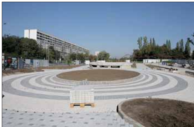
Obr. 6 Úpravy povrchů nad vestibulem stanice Prosek Fig. 6 Surface finishes above the concourse of Prosek station
