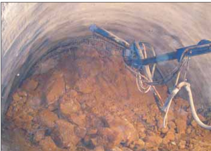
Obr. 1 Skladba rubaniny v úvodním úseku tunelu Lučice Fig. 1 Composition of the muck from the initial section of the Lučice tunnel excavation
