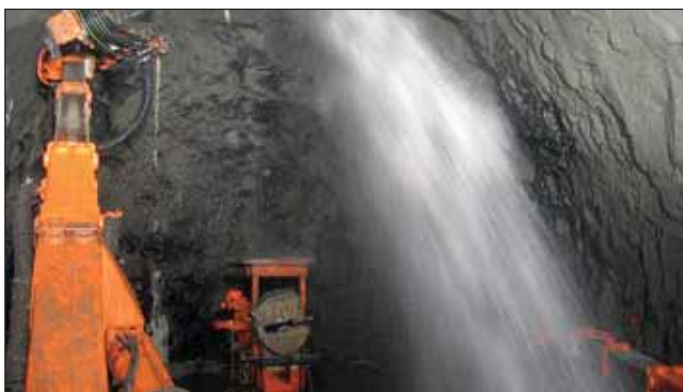
Obr. 7 Tryskající tlaková voda z čelby po provedeném předvrtu Fig. 7 Pressure water gushing from a completed probe borehole
