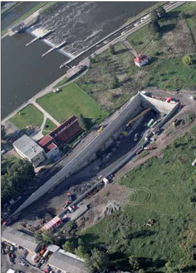
Obr. 4 Letecký pohled na portály STT a JTT ve stavební jámě Troja Fig. 4 NTT and STT portals in the construction trench in Troja – an aerial view
