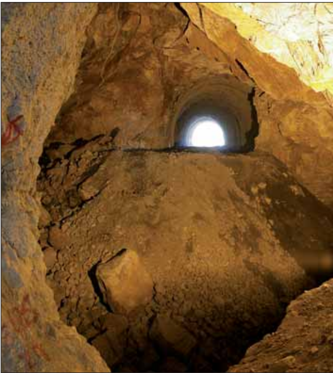
Obr. 6 Obrovská krasová kaverna v souběžně budovaném tunelu Vrata, v níž bude vybudován most o délce 47 metrů
