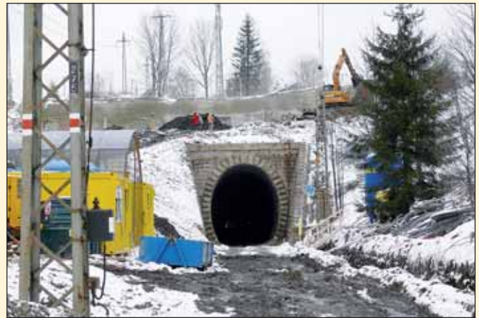
Obr. Jablůňkovský tunel Fig. The Jablunkov tunnel
