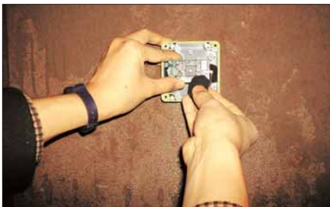
Obr. 6 Instalace bezdrátového měřicího bodu v pražském metru Fig. 6 Installation of a wireless measurement point in the Prague metro
