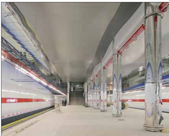
Obr. 10 Nástupiště stanice Letňany Fig. 10 Letňany station – the platform
