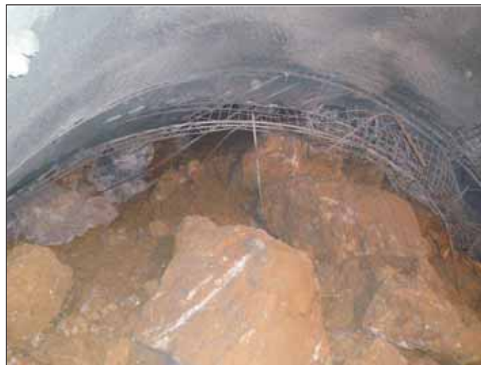
Obr. 2 Roztroušené balvany v materiálu charakteru zeminy Fig. 2 Scattered boulders in the soil material
