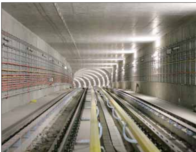
Obr. 8 Přechod hloubeného tunelu do raženého za stanicí Prosek ve směru na Letňany
