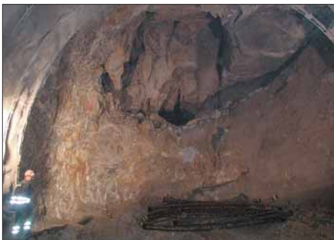
Obr. 5 Zastižené krasové jevy s nevyplněnými dutinami v pevnějších polohách dolomitů
