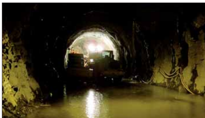
Obr. 8 Zatopené čelo tunelu při průchodu zvodnělou horninovou poruchou Fig. 8 Inundated tunnel heading during the passage through a water-bearing weakness zone
