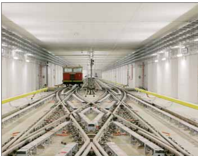
Obr. 11 Výhybkový komplex za stanicí Letňany Fig. 11 The complex of rail switches behind Letňany station
