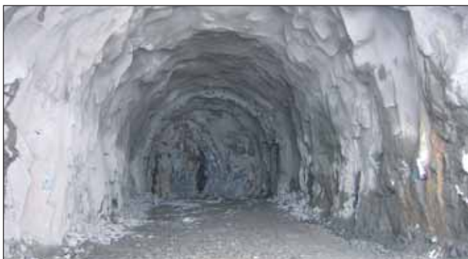
Obr. 3 Tunel po vyražení první desítky metrů Fig. 3 The tunnel after the completion of the excavation of initial ten meters
