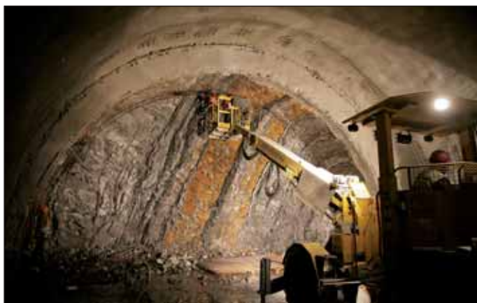
Obr. 5 Osazování sítě a rámu Bretex v kalotě STT
