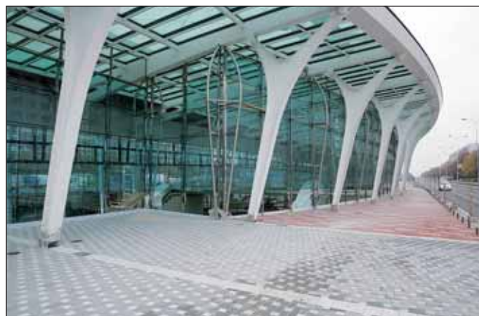
Obr. 3 Vstup z ulice Vysočanské do stanice Střížkov Fig. 3 The entrance to Střížkov station from Vysočanská Street
