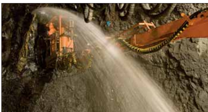
Obr. 5 Voda tryskající pod tlakem při vrtání čelby pro další záběr Fig. 5 Water gushing under a pressure during the face drilling for the next excavation round
