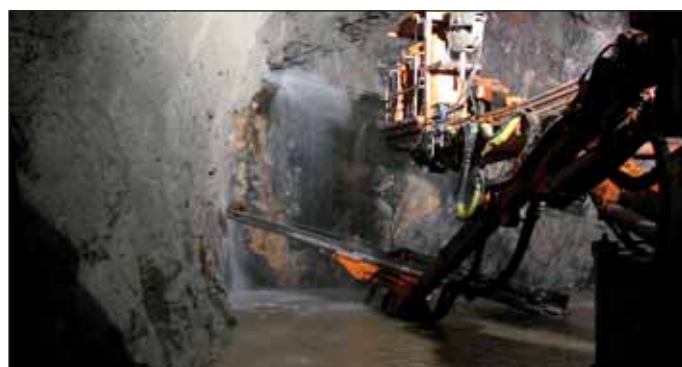
Obr. 6 Přítoky tlakové vody po provedení vývrtů pro kotvy na boku tunelu Fig. 6 Pressure water inflows after the completion of boreholes for anchors on the tunnel side
