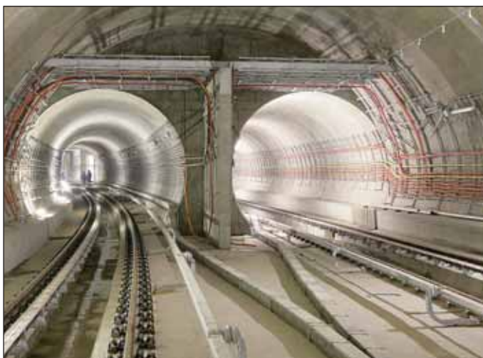
Obr. 9 Přechod dvoukolejného raženého tunelu do dvou jednokolejných před stanicí Letňany
