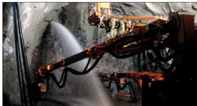
Obr. 4 Průnik tlakové vody po provedení předvrtu Fig. 4 Intrusion of pressure water after the completion of a probe borehole
