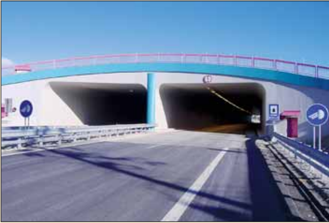
Obr. 4 Pohľad na portál krátkeho tunela Lučivná Fig. 4 View of the portal of the short tunnel Lučivná
