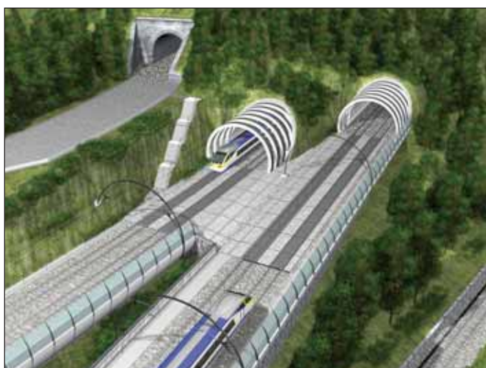
Obr. 6 Pohled na výjezdové (východní) portály tunelů Fig. 6 A view of the exit (eastern) portals of the tunnels
