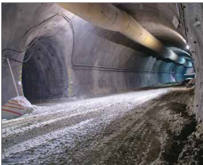
Obr. 7 Napojenie únikovej cesty vo východnej tunelovej rúre Fig. 7 Connection of the Escape route in the Eastern Tunnel Tube
