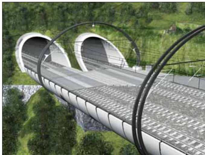
Obr. 8 Pohled na vjezdové (západní) portály tunelů Fig. 8 A view of the access (western) portals of the tunnels
