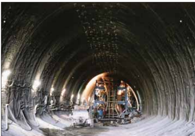
Obr. 5 Příprava bednění pro betonáž středního pilíře ve středním tunelu Fig. 5 Preparation of the shuttering for the central pillar casting in the central tunnel tube
