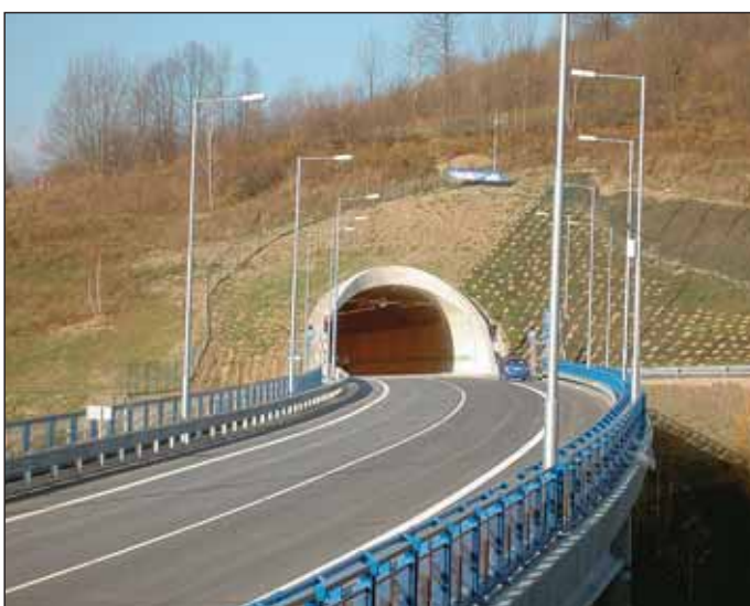
Obr. 3 Východný portál tunela Horelica Fig. 3 East portal of the Horelica tunnel
