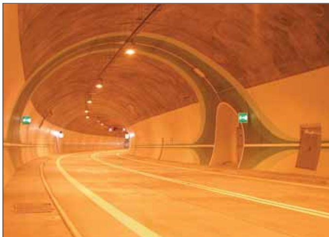
Obr. 2 Pohľad do dopravného priestoru tunela Horelica Fig. 2 A view of the traffic space in the Horelica tunnel
