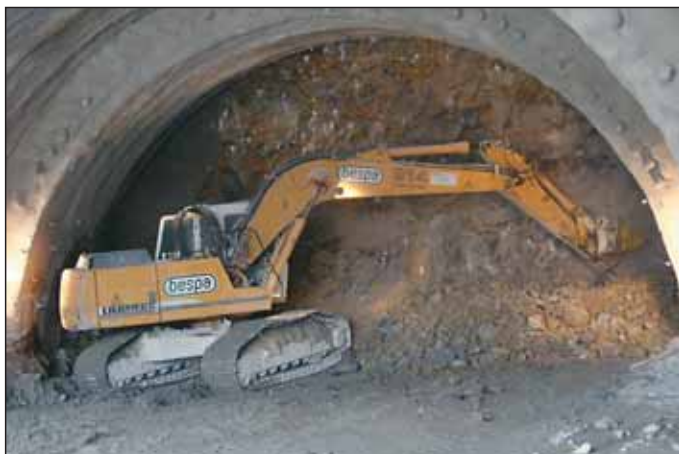
Obr. 5 Vylomové práce pod mikropilótvým dáždnikom v mieste severného portálu
