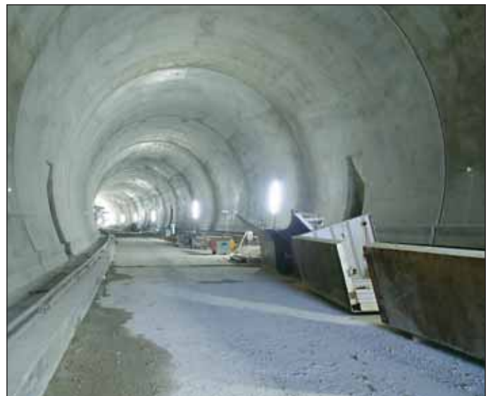
Obr. 8 Úsek tunela s hotovým sekundárnym ostením Fig. 8 Tunnel Section with the Secondary Lining Completed
