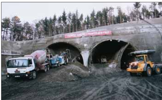
Obr. 7 Ražba z rozvadovského portálu
