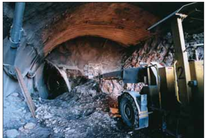
Obr. 9 Čelba pravého tunelu Fig. 9 The face of the right tunnel tube
