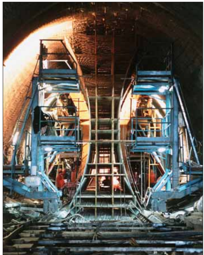
Obr. 6 Detail bednění a výztuže středního pilíře Fig. 6 Shuttering and reinforcement of the central pillar
