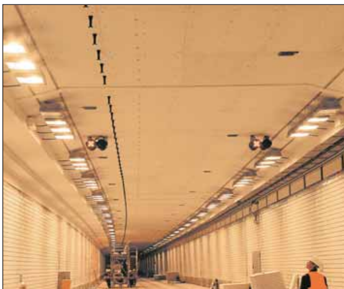
Obr. 4 Kabelový kanál, stropní obklad a zakrytí dilatačních spár Fig. 4 Cable duct, ceiling lining and expansion joint covering
