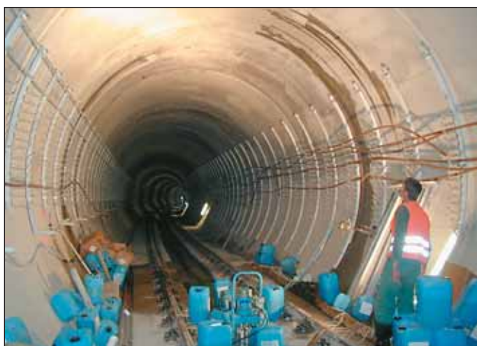
Obr. 1 Metro IVC1 injektáž jednokolejného tratového tunelu Fig. 1 Metro IVC1 grouting in the single-track running tunnel
