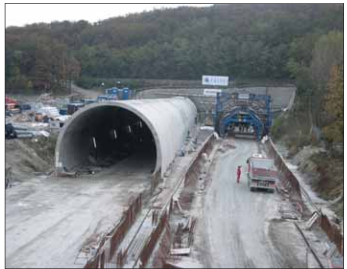
Obr. 3 Severný portál s budovanými konštrukciami hlbého tunela Fig. 3 Northern Portal with Cut-and-Cover Tunnel under Construction
