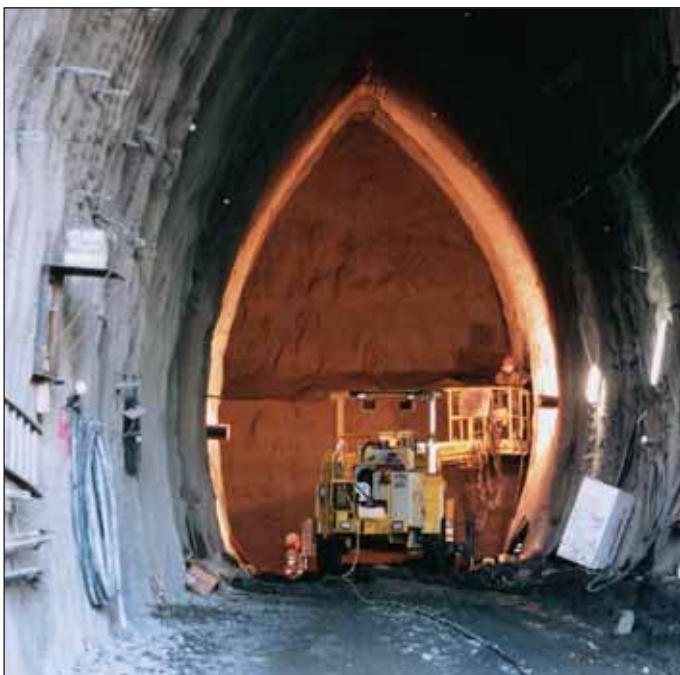
Obr. 8 Čelba pravé boční stoly Fig. 8 The face of the right sidewall drift
