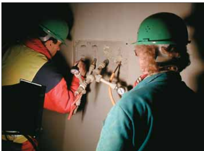
Obr. 4 Tunel Mrázovka – zkouška průchodnosti a souvislosti injekčního systému
