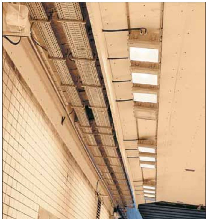
Obr. 3 Napojení kabelového kanálu na stěnu a strop v odkrytém stavu Fig. 3 Connecting of the cable duct to the wall and ceiling in an open state
