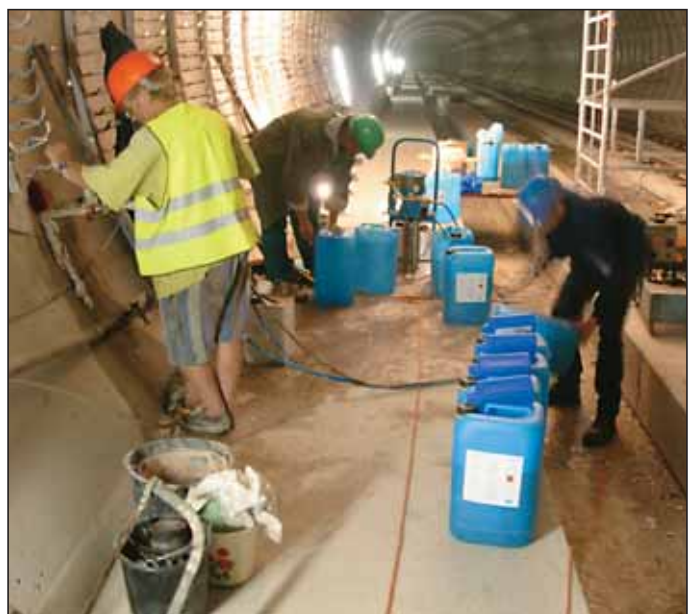
Obr. 3 Metro IVC1 – injektáž dvojkoľajného traťového tunelu
