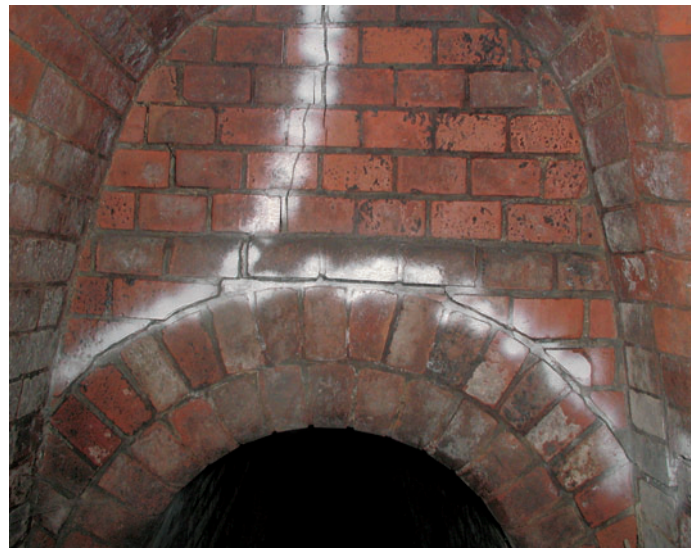
Obr. 6 Průběžná trhlina na rubu obezdívky - Praha 7, ulice Komunardů Fig. 6 Running crack in the back of the lining - Prague 7, Komunardů street
