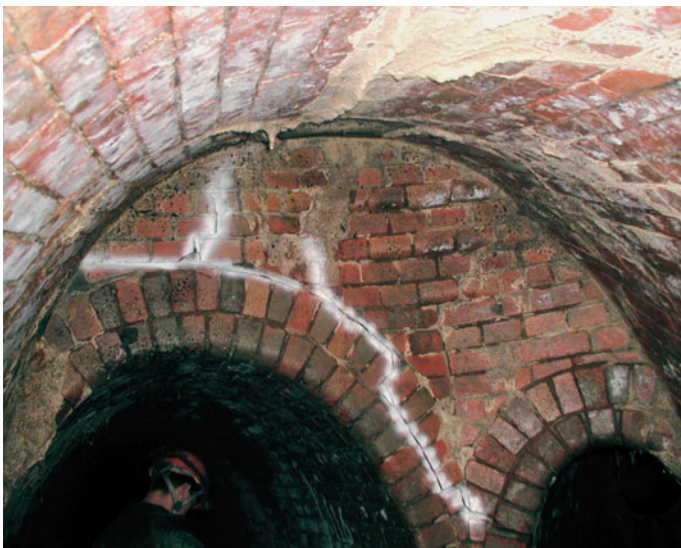
Obr. 8 Přečhod rubové trhliny mezi pasy obezdívky - Praha 1, Malá Strana Fig. 8 Passage of the back crack between lining shells - Prague 1, Malá Strana
