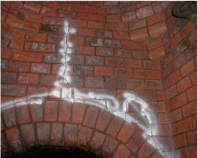
Obr. 3 Svislá trhlina - Praha 1, Malá Strana Fig. 3 Vertical crack - Prague 1, Malá Strana
