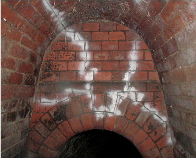
Obr. 1 Typické šikmé trhliny - Praha 7, ulice Komunardů Fig. 1 Typical oblique cracks - Prague 7, Komunardů street
