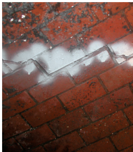
Obr. 10 Průběh trhliny ve vrcholu klenby - Praha 8, Křížikova ulice Fig. 10 Passage of crack at the vault top - Prague 8, Křížikova street
