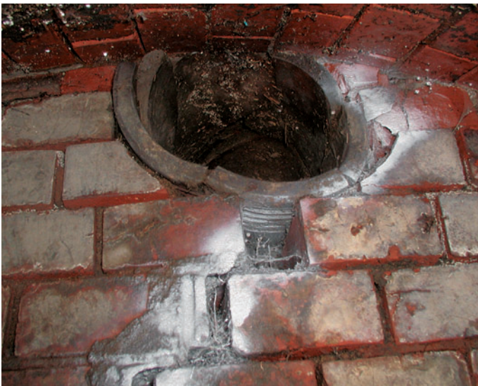
Obr. 5 Výrazné porušení portálové zdi - Praha 7, ulice Komunardů Fig. 5 Serious damage to the portal wall - Prague 7, Komunardů street
