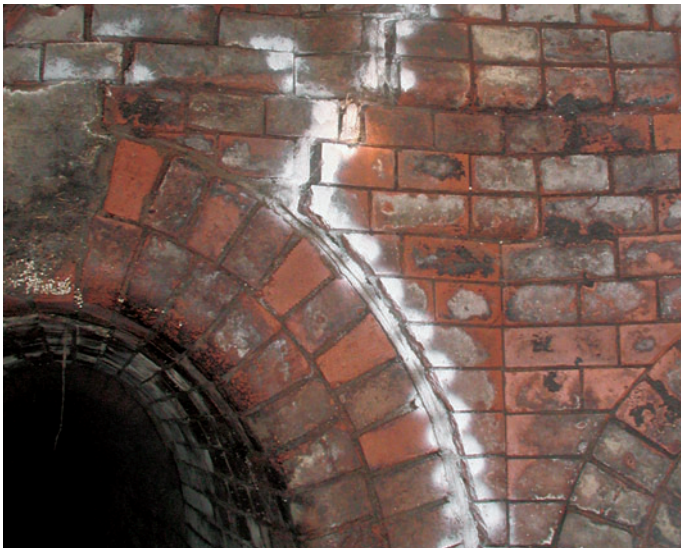
Obr. 7 Částečná trhlina na rubu obezdívky - Praha 7, ulice Komunardů Fig. 7 Partial crack in the back of the lining - Prague 7, Komunardů street
