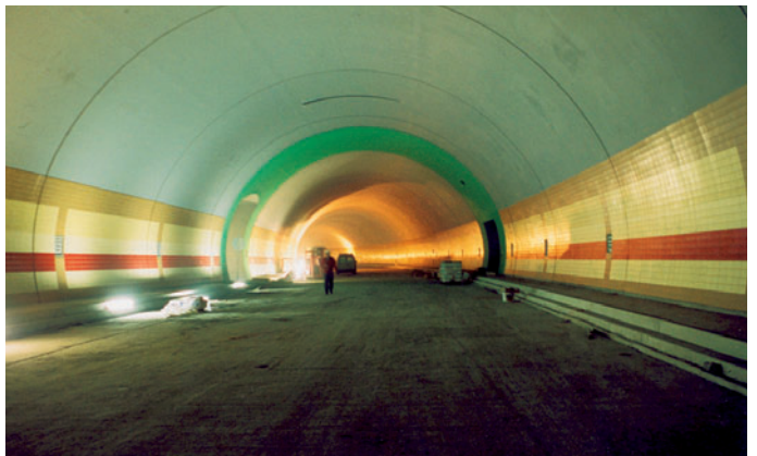
Obr. 5 Západní tunel u propojky číslo 5 – skutečnost Fig. 5 WTT at cross passage No. 5 – reality
