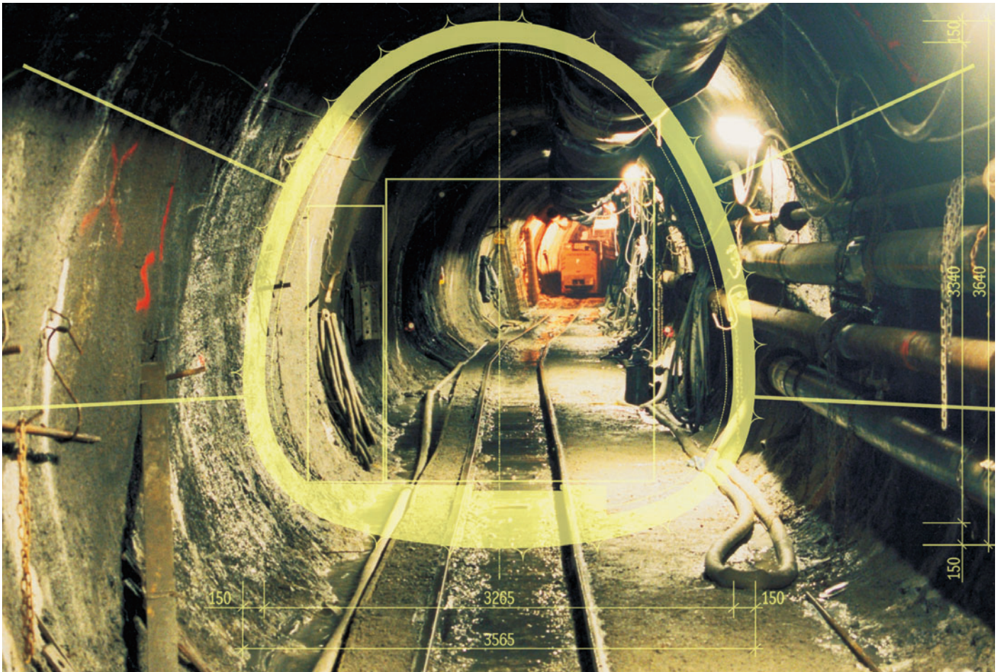
Obr. 2 Příčný řez jednokolejným profilem Fig. 2 Single-track cross section
