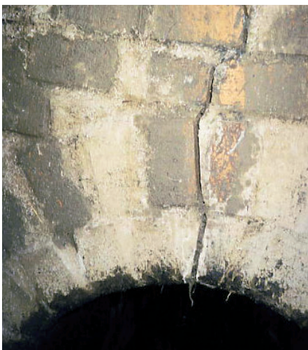
Obr. 9 Rozevřená trhlina ve vrcholu klenby - Praha 8, Křížikova ulice Fig. 9 Open crack at the vault top - Prague 8, Křížikova street
