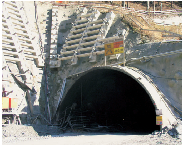
Obr. 4 Zajištění stěny západního portálu Fig. 4 Support of the western portal wall
