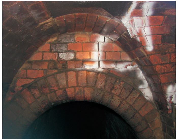
Obr. 4 Jiná orientace trhlín - Praha 1, Valdštejská ulice Fig. 4 Other orientation of crack - Prague 1, Valdštejská street
