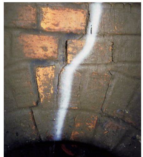
Obr. 11 Vícenásobné trhliny ve vrcholu klenby - Praha 8, Křížikova ulice Fig. 11 Multiple cracks at the vault top - Prague 8, Křížikova street
