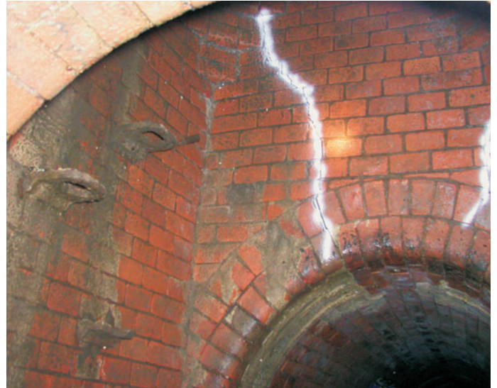
Obr. 2 Typické šikmé trhliny - Praha 1, Malá Strana Fig. 2 Typical oblique cracks - Prague 1, Malá Strana
