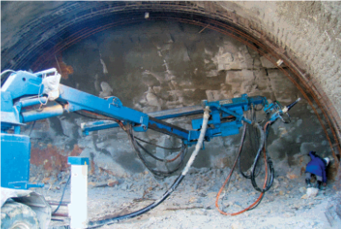
Obr. 3 Zajištění čela výrubu Fig. 3 Support of the tunnel face
