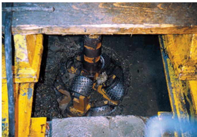
Obr. 5 Provtání RD 1400 mm na povrch Fig. 5 Penetration of the RD 1 400 mm to surface
