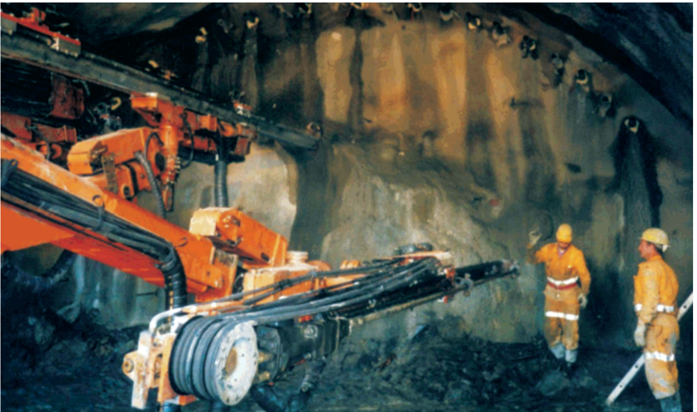
Obr. 2 Ochranný dáždnik z ocelových rúr Fig. 2 Safety umbrella with steel pipes
