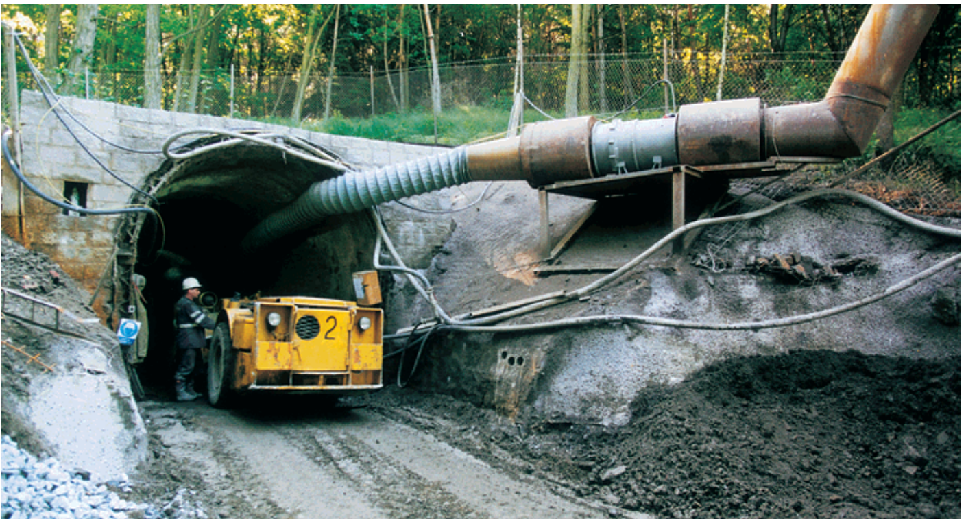
Obr. 1 Portál průzkumné štol Fig. 1 Portal of the exploration gallery
