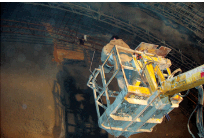
Obr. 4 Montáž primární výztuže Fig. 4 Installation of the primary support
