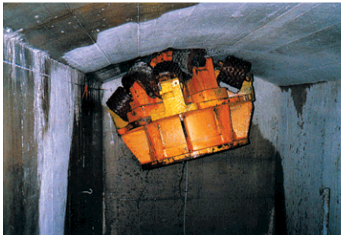
Obr. 4 Zavrtávání RD 1 400 mm do stropu „toskomory“ Fig. 4 EC 1 400 boring into the roof of the “toss-chamber”
