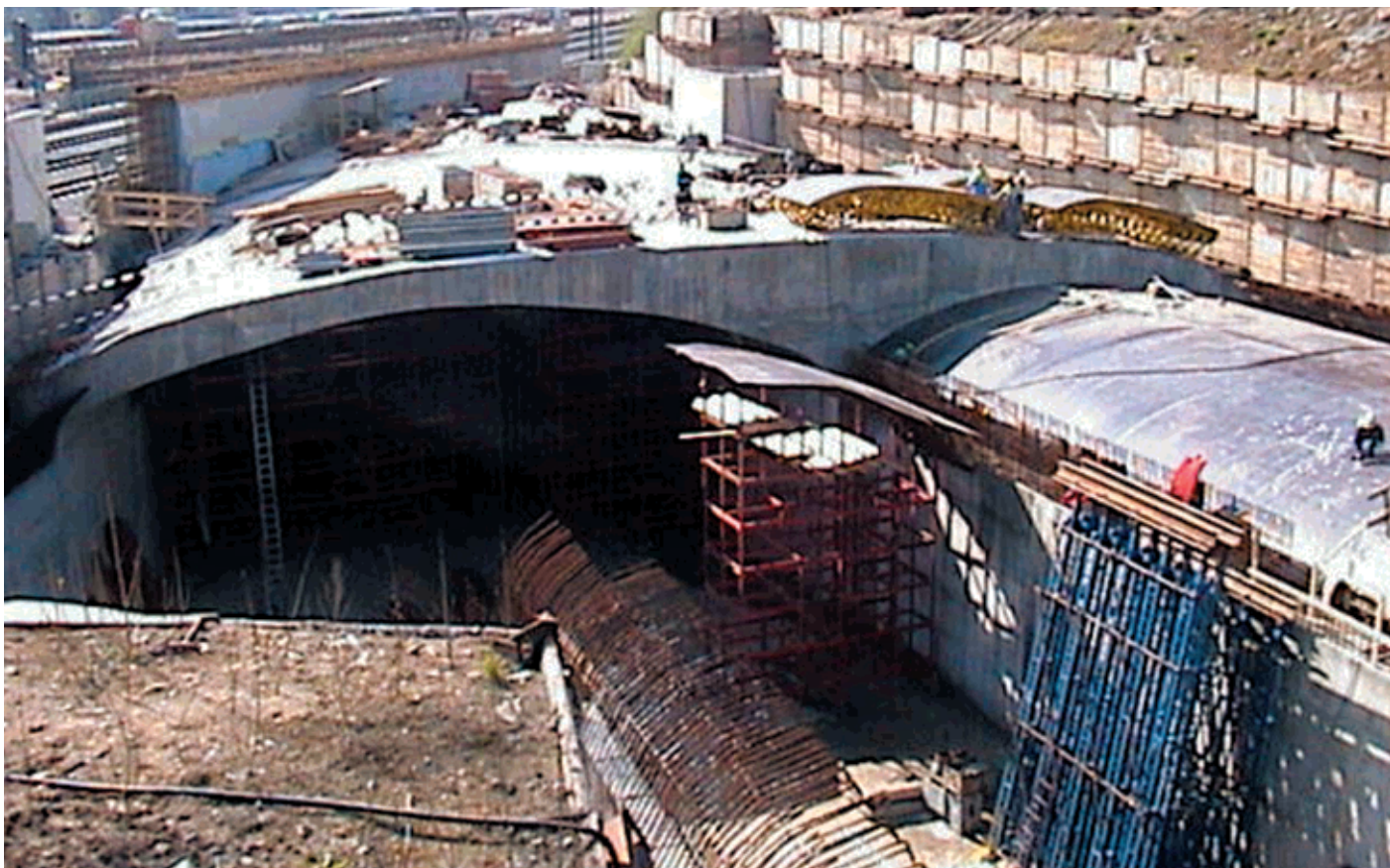
Obr. 5 Pohled do otevřené stavební jámy v místě jejího rozšíření pro napojení výhledové Radlické radiály a křížující lávky pro pěší Fig. 5 A view inside the box excavation at the location of its expansion for the future connection of the Radlice Radial and the crossing pedestrian bridge
