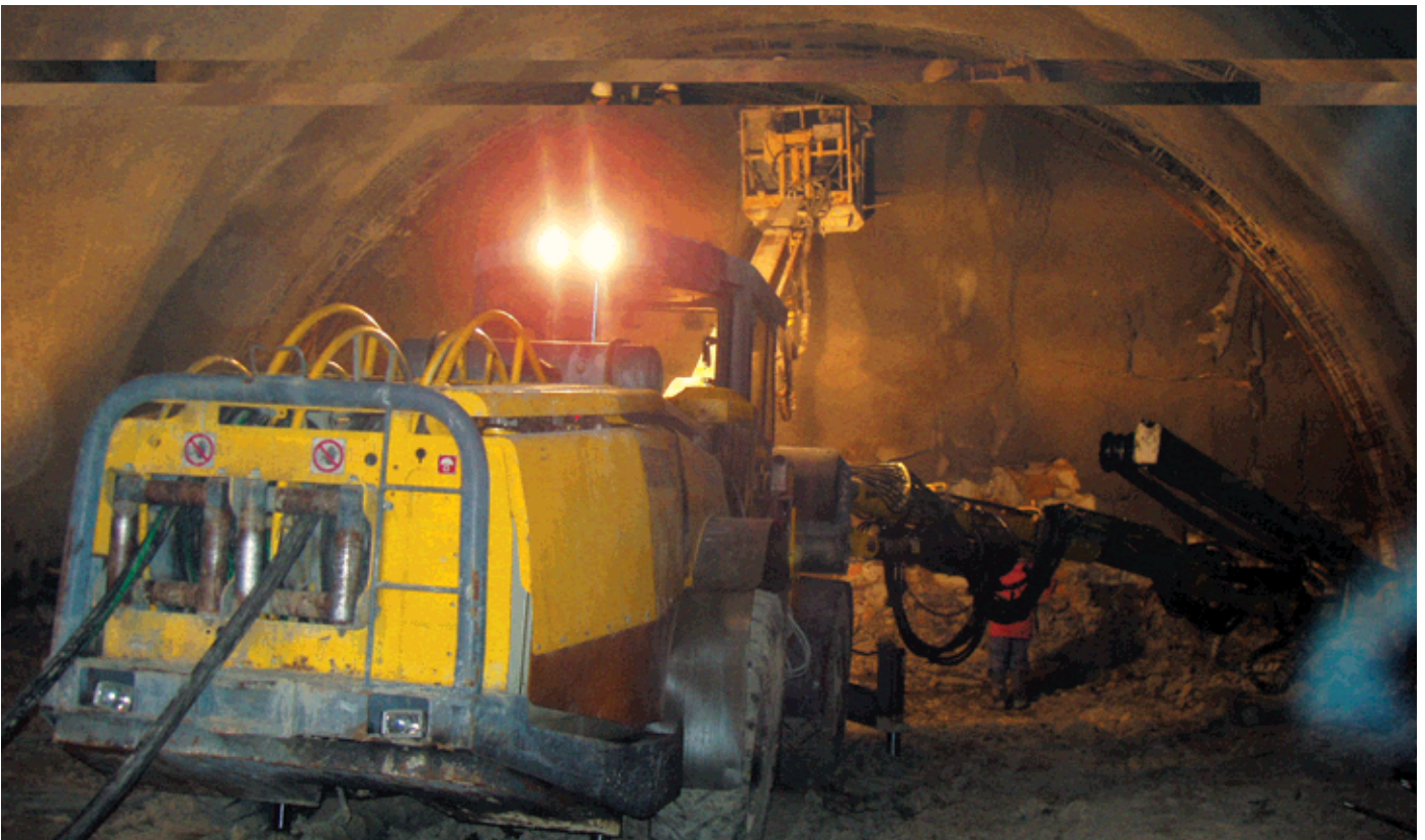
Obr. 2 Příprava primárního ostění Fig. 2 Preparation of the primary lining
