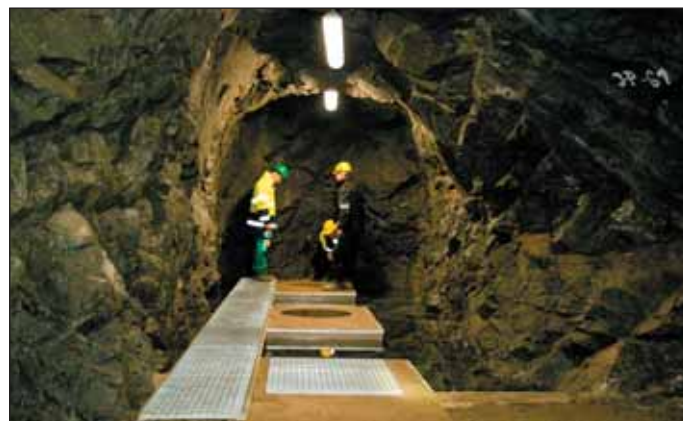
Obr. 4 Příprava jedné z rozrážek pro experimentální výzkum Fig. 4 Preparation of one of the side stubs for experimental research
