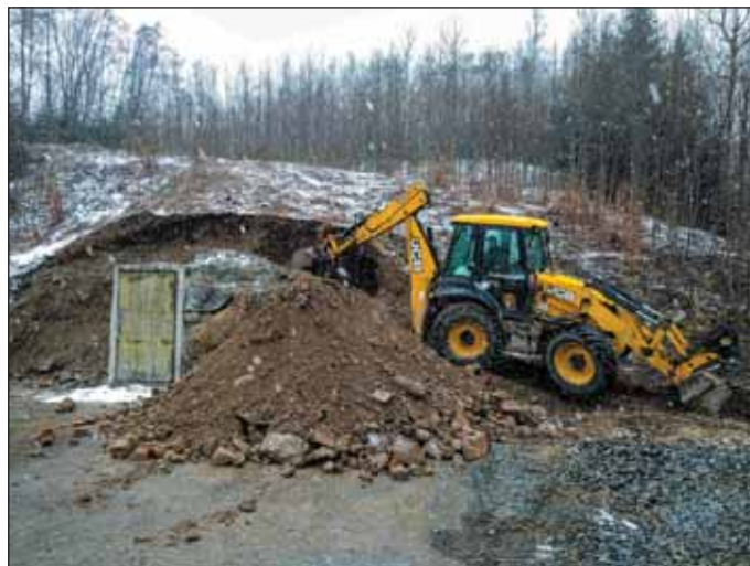
Obr. 3 Zahájení otvirkových prací na ústí Úvodní úpadnice Fig. 3 Start of opening works on the entrance of the Initial inclined drift
