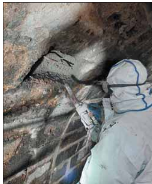
Obr. 5 Plombovanie vypadnutých kvádrov tunelového ostenia sanačnou hmotou Fig. 5 Sealing of fallen blocks of the tunnel lining with repair material
