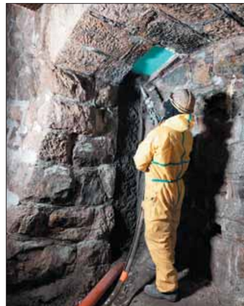
Obr. 9 Aplikácia striekaného betónu na zhotovené zvodnice Fig. 9 Application of shotcrete on finished culverts
