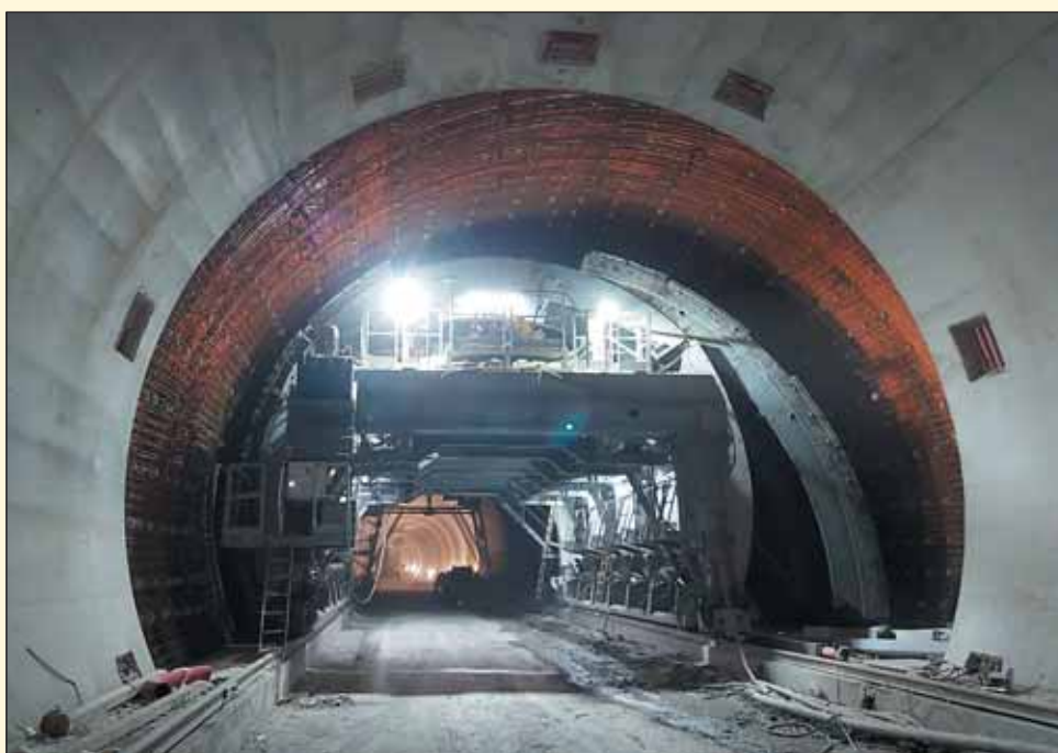
Obr. 6 Príprava betonáže posledného zálivového bloku ostenia v tuneli Čebrať Fig. 6 Preparation for pouring concrete of the last lining block of the lay-by in the Čebrať tunnel
