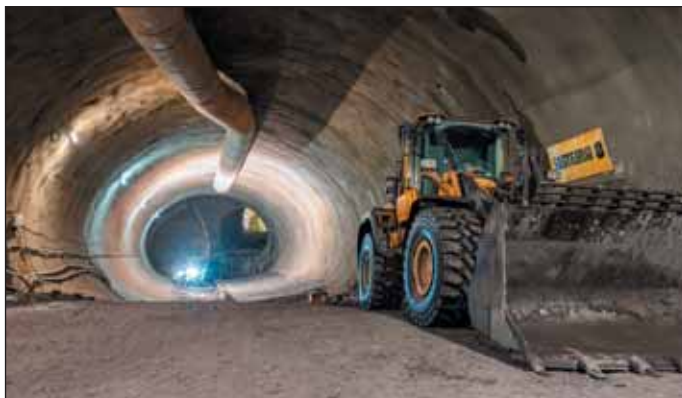
Obr. 5 ZS Pad1b – Příprava na izolace a sekundární ostění dna obrátového tunelu
