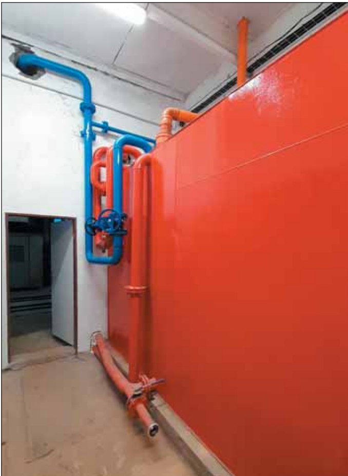
Obr. 8 Nová požární nádrž na ohlubni jámy B1 Fig. 8 New fire water tank on the B1 shaft bank
