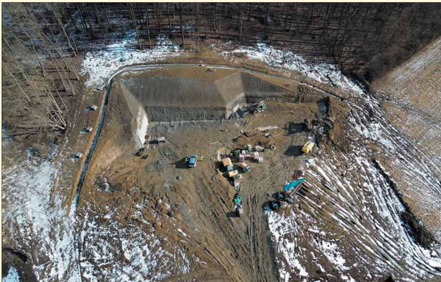
Obr. 5 Práce na západnom portáli tunela Okruhliak Fig. 5 Working on the portal west of the Okruhliak tunnel
