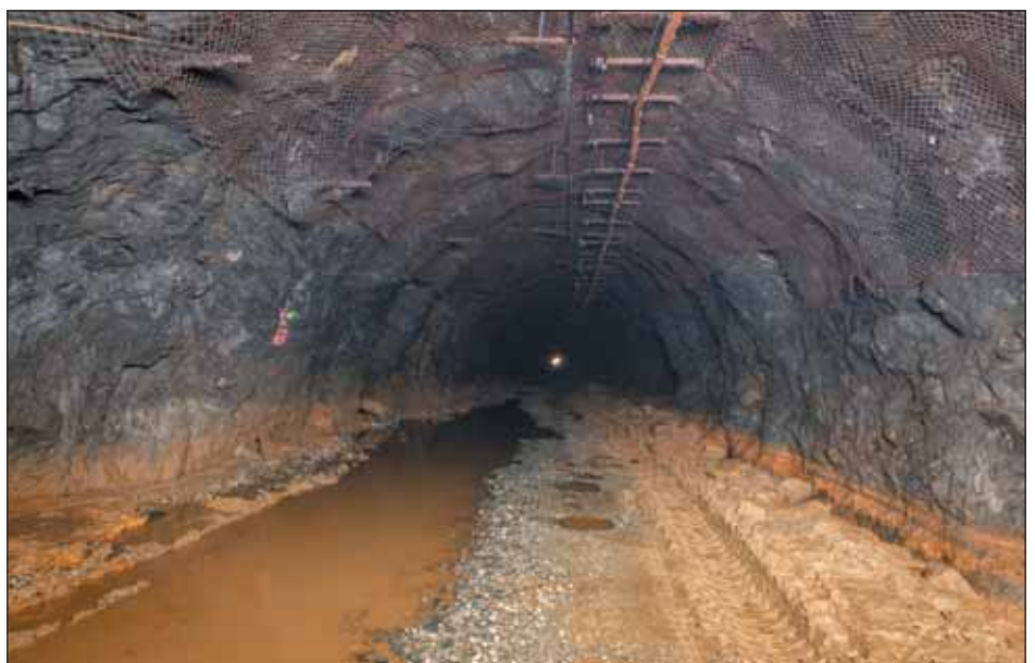
Obr. 6 Chodba 3205 v průběhu prací Fig. 6 Gallery 3205 during the work operations
