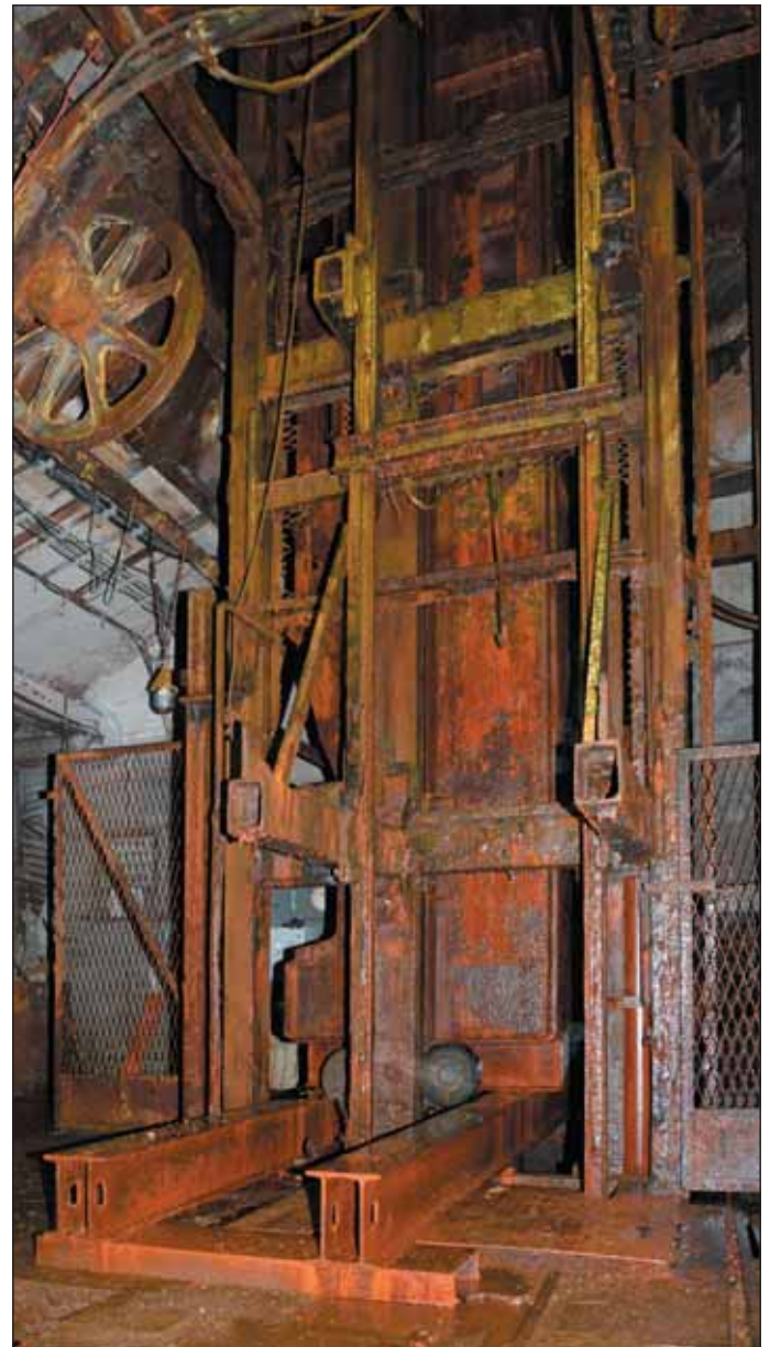
Obr. 3 Skipová nádoba uložena na profily I 300 na 24. patře jámy R3 Fig. 3 Skip vessel placed on I 300 profiles on the 24 th level of shaft R3
