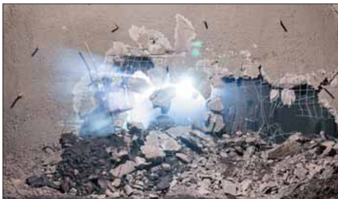
Obr. 1 ZS OL – Zahájení prorážky levého staničního tunelu stanice Olbrachtova
