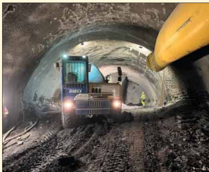
Obr. 4 Ražba časti staničného tunelu stanice Olbrachtova Fig. 4 Driving a part of Olbrachtova station tunnel
