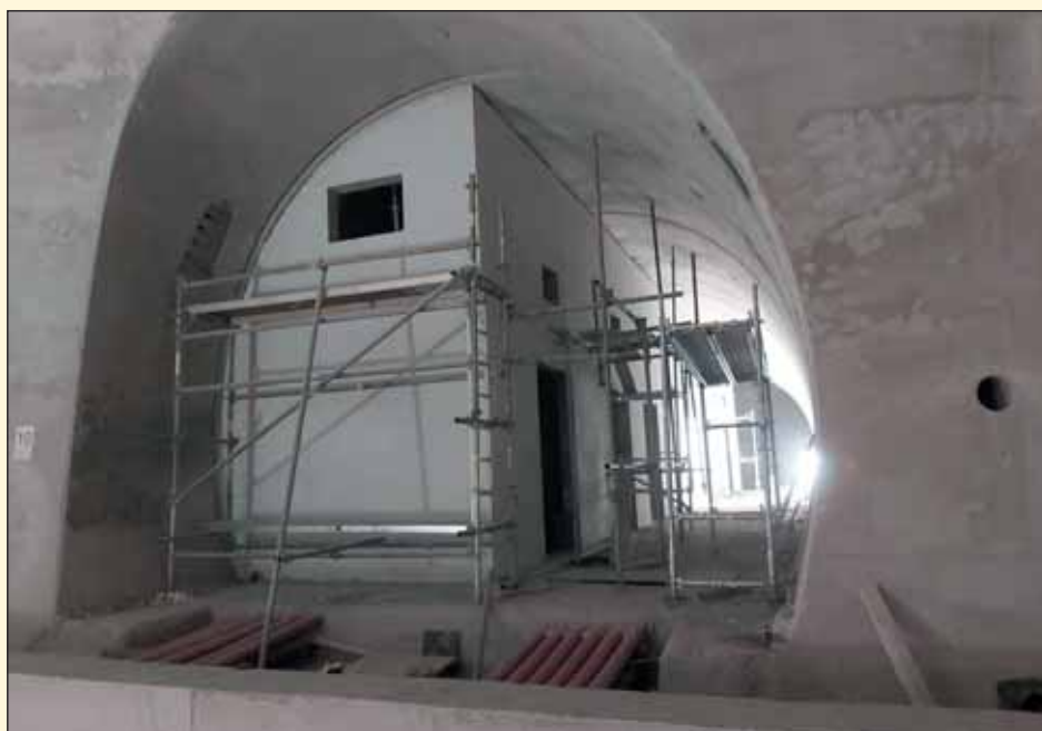
Obr. 8 Vnútorne konštrukcie v priečnom prepojení č. 10 Fig. 8 Internal structures in cross passage No. 10
