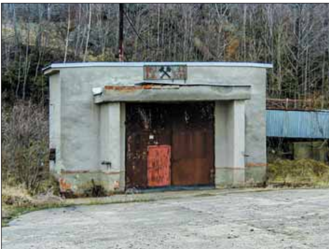
Obr. 1 Ústí Úvodní úpadnice před provedením likvidace Fig. 1 Entrance of Initial inclined drift before execution of liquidation
