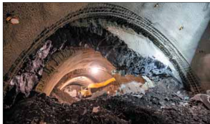
Obr. 2 ZS VO-OL – Prorážka kaloty levého staničního tunelu stanice Olbrachtova
