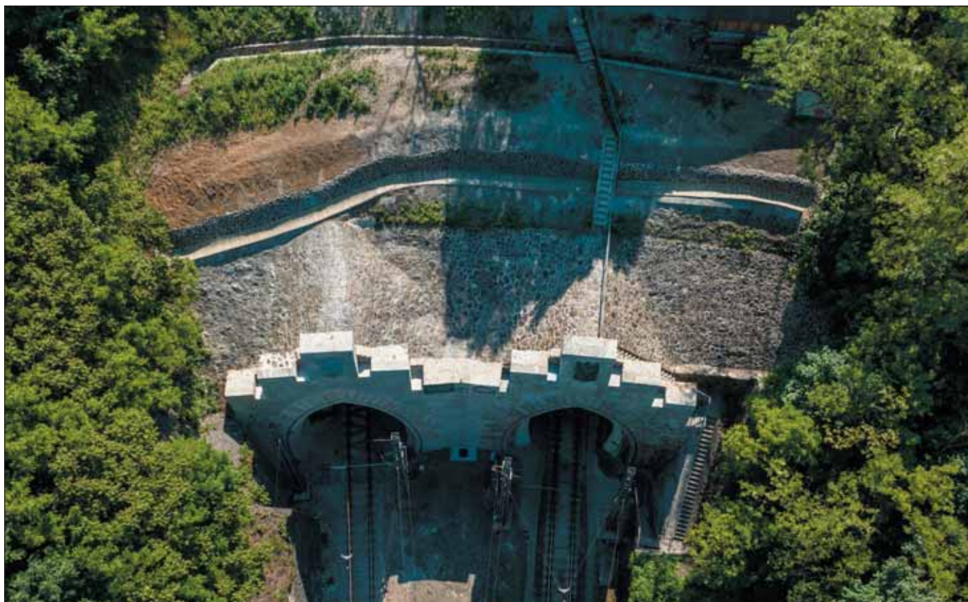
Obr. 13 Pohľad na celkovú situáciu portálu P1 od ŽST Lamač po ukončených prácach
