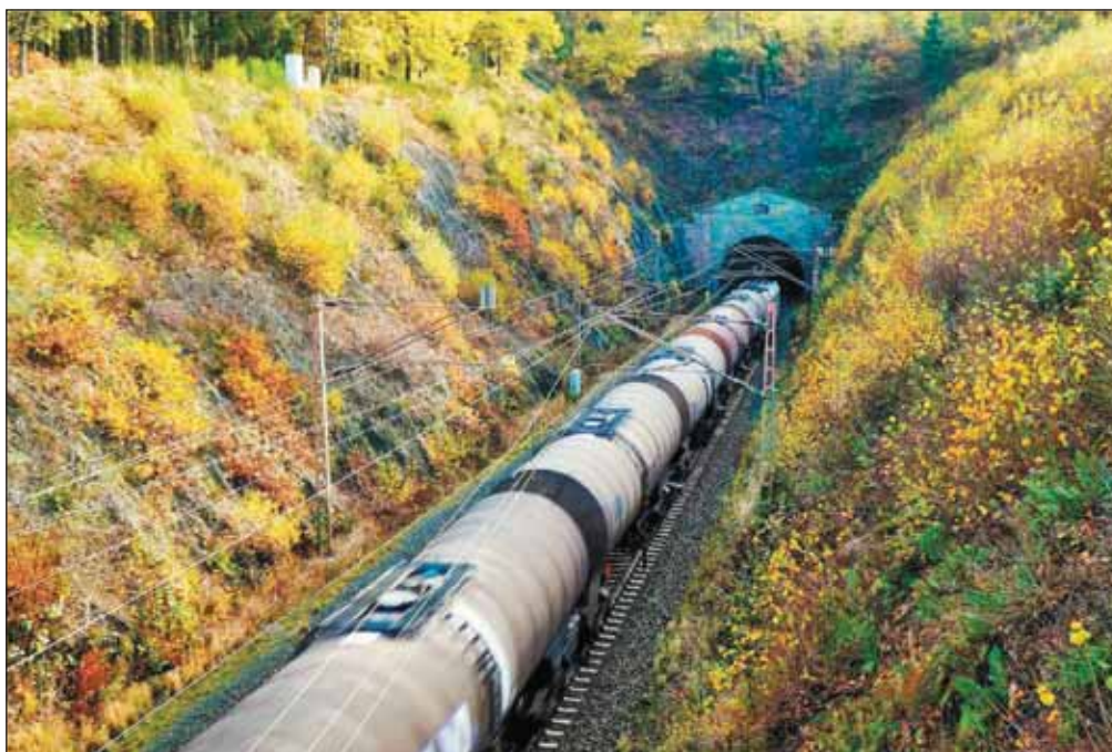
Obr. 5 Pohled na severní portál tunelu Rudersdorfer Fig. 5 View of the western portal of the Rudersdorfer tunnel
