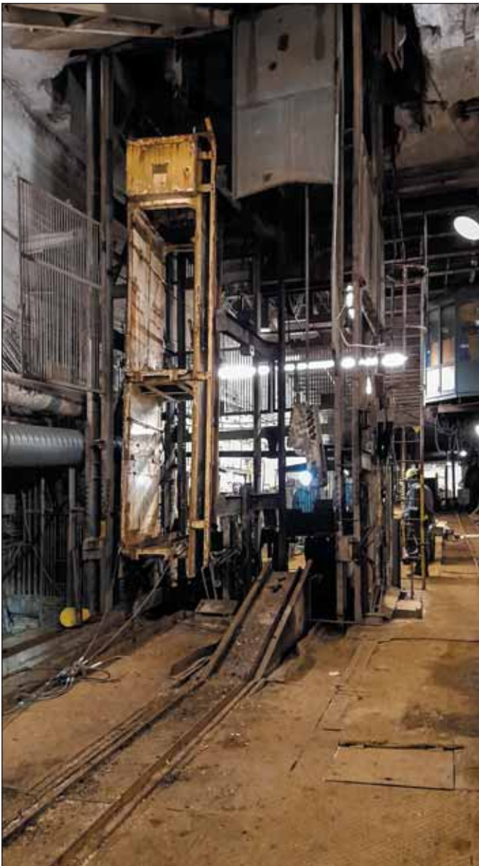
Obr. 2 Demontáž dopravní nádoby těžního stroje 2B3216 2M/1 jámy R7S Fig. 2 Disassembly of the transportation vessel of the hoisting machine 2B3216 2M/1 of shaft R7S
