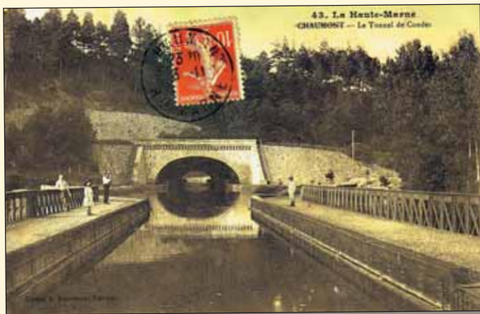
Obr. 8 43. La Haute-Marne. Chaumont – tunel de Condes. Cliché A. Pourtoy, Éditeur. 1911 [sbírka autorů].
