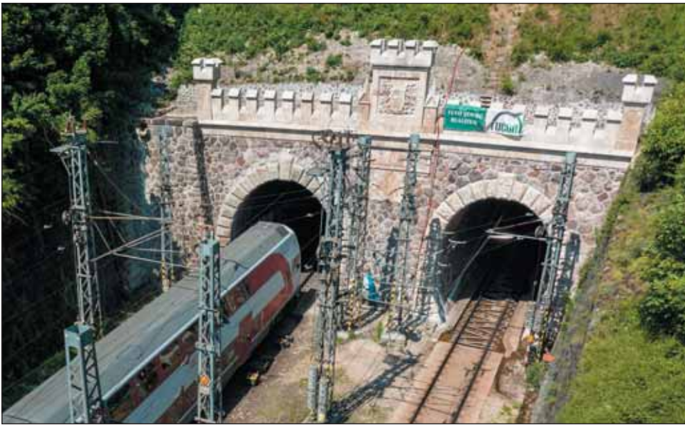
Obr. 11 Pohľad na zrekonštruovaný portál P2 od ŽST Bratislava hl. st. Fig. 11 View of the reconstructed portal P2 from the Bratislava main railway station
