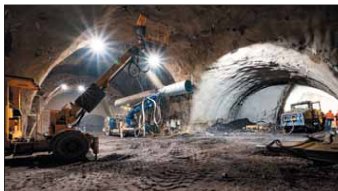
Obr. 6 ZS OL2 – Ražba pravého staničního tunelu stanice Olbrachtova
