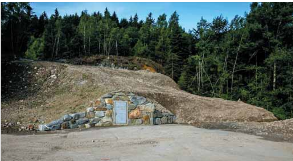
Obr. 2 Ústí Úvodní úpadnice po provedení likvidace Obr. 2 Entrance of Initial inclined drift for the execution of liquidation
