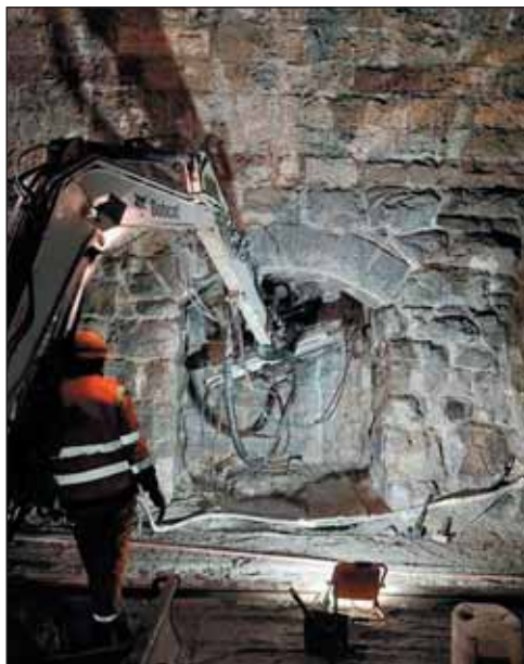
Obr. 8 Realizácia odvodňovacích vrtov v stiesnených pomeroch bezpečnostného výklenku Fig. 8 Implementation of drainage drillholes in the tight space of the safety niche
