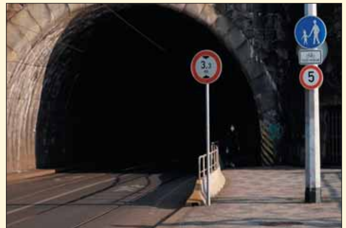
Obr. 6 Jízdní dráhou v tunelu je obousměrně vedena tramvajová trať, automobilová doprava i cyklistická stezka Fig. 6 Bi-directional streetcar line, vehicular traffic and cycle way are led on the tunnel carriageway
