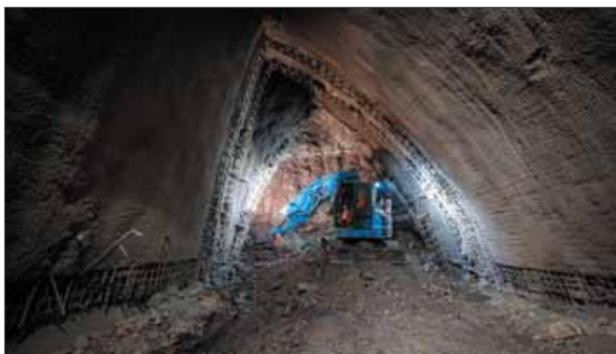
Obr. 3 ZS PAD4 – Ražba kaloty levého důlčího výrubu stanice Pankrác
