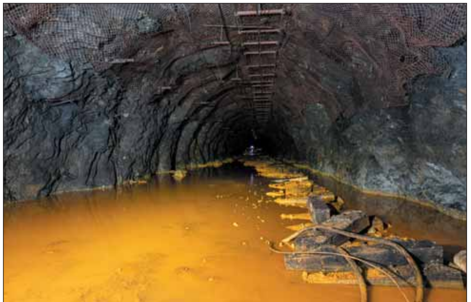
Obr. 5 Chodba 3205 (úroveň 3. patra dolu) před zahájením prací (částečně zaplavena důlními vodami) Fig. 5 Gallery 3205 (3 rd level of the mine) before commencement of works (partially flooded by mine water)
