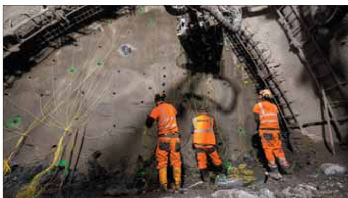
Obr. 1 ZS PAD4 – Příprava kaloty pravého důlčího výrubu stanice na trhací práce
