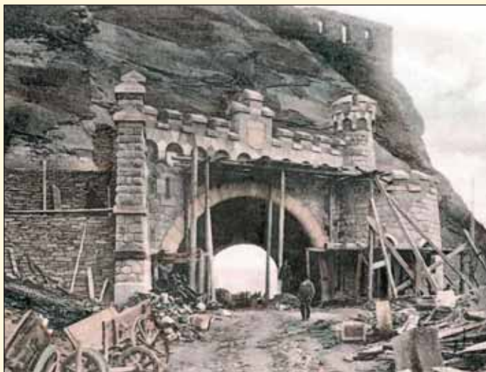
Obr. 3 Dokončování severního portálu se znakem města Prahy Fig. 3 Completing the northern portal with the coat of arms of the city of Prague
