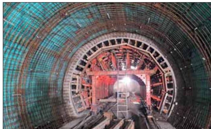
Obr. 4 ZS VO-OL – Izolace a armatura klenby strojovny vzduchotechniky
