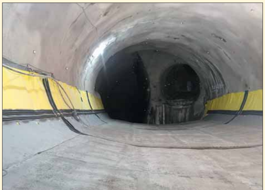
Obr. 2 Pokládka hydroizolace a její ochrany mazaninou při provádění tunelů obratových kolejí Fig. 2 Laying waterproofing layer and its protection with screed when working on turn-back tracks
