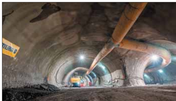
Obr. 4 ZS Pad1b – Rozrážka obrátového tunelu za stanicí Pankrác D
