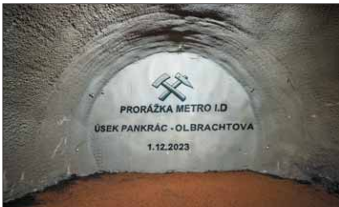
Obr. 3 ZS OL2 – Příprava slavnostní prorážky levého staničního tunelu stanice Olbrachtova
