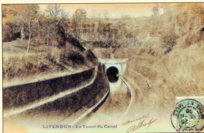
Obr. 5 Liverdun – tunel na kanálu? 1905 [sbírka autorů]. Hluboce zaříznutý východní vstup do plavebního tunelu. Fig. 5 Liverdun – a tunnel on the canal? 1905 [authors' collection]. Deeply cut eastern entrance to the navigation tunnel.
