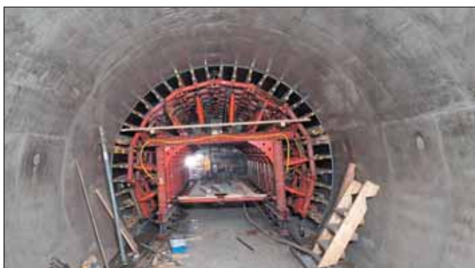
Obr. 5 ZS VO-OL – Sekundární ostění strojovny vzduchotechniky
