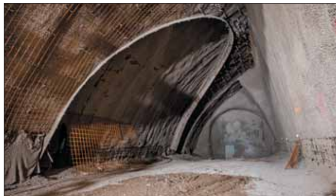
Obr. 6 ZS PAD4 – Zesílení ostění v místě budoucího napojení eskalátoru Gemini
