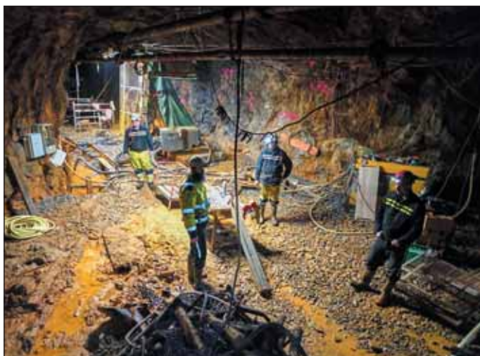
Obr. 8 Pracoviště vrtné soupravy Fig. 8 Drilling rig workplace
