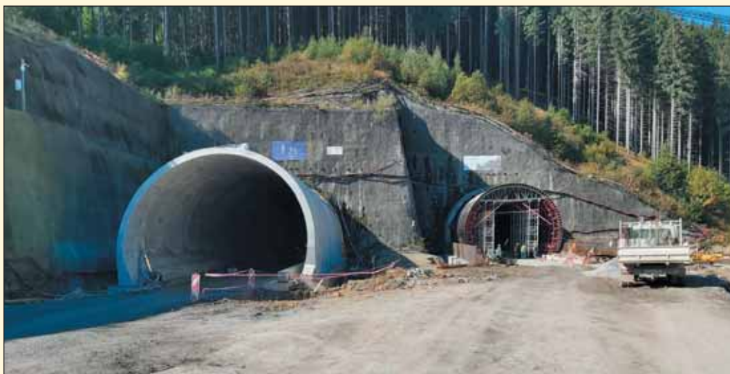
Obr. 5 Hĺbené tunely na východnom portáli tunela Čebrať Fig. 5 Cut-and-cover tunnels at the eastern portal of the Čebrať tunnel
