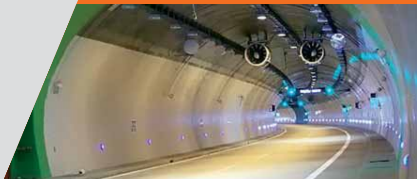
Tunel Klimkovic, stavba roku Moravskoslezského kraje 2008
