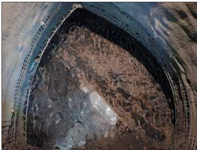
Obr. 4 Lavicovité polohy pískovců polyteichové facie v prostředí břidlic zastížené při ražbě dvoukolejného tunelu
