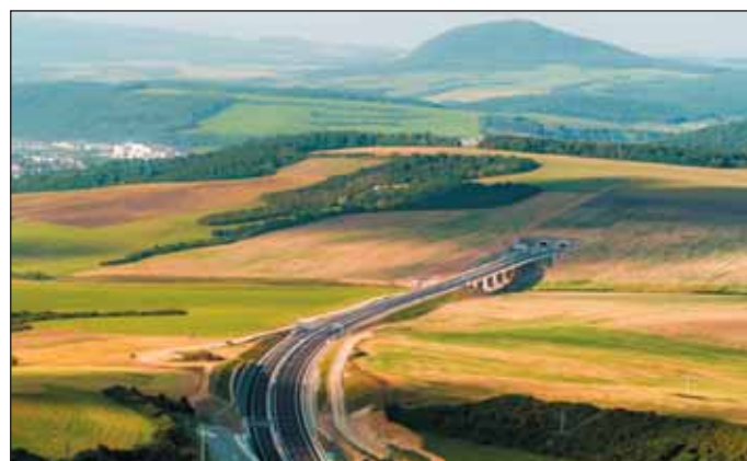
Obr. 6 Rýchlostná cesta v úseku pred južným portálom Fig. 6 Fast highway section in front of southern portal
