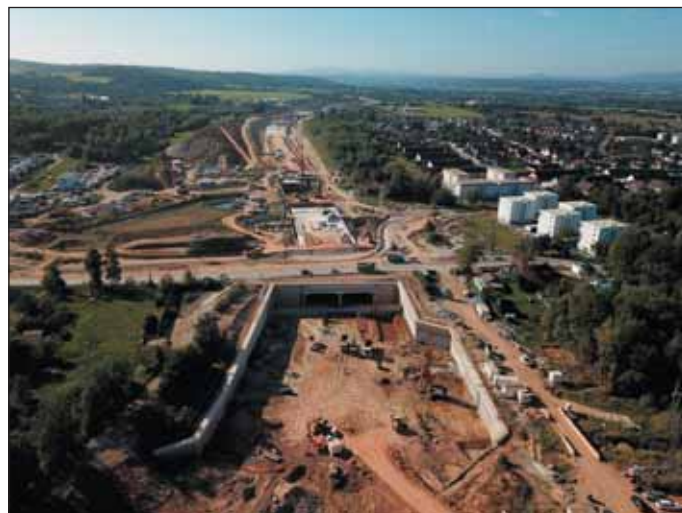
Obr. 2 Pohled na severní portál tunelu Pohůrka (aktuální stav) Fig. 2 A view of the Pohůrka tunnel northern portal (current state)
