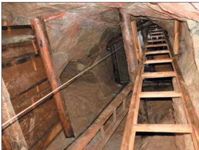
Obr. 11 Stvol staré šachty po vyzmáhání a výstrojení v duchu 16. století, KŠ2 Fig. 11 Old shaft after remediation and equipment restoration by the methods of the 16 th century, KŠ2
