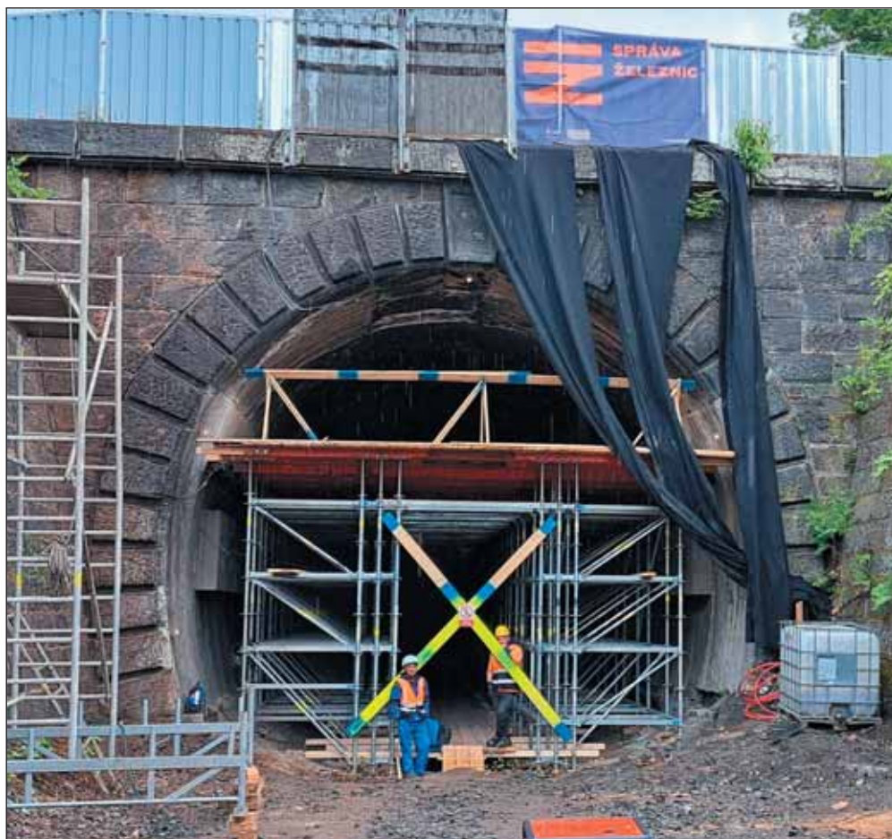
Obr. 2 Rozepržení tunelu před bouráním klenby Fig. 2 Bracing the tunnel before demolishing the vault
