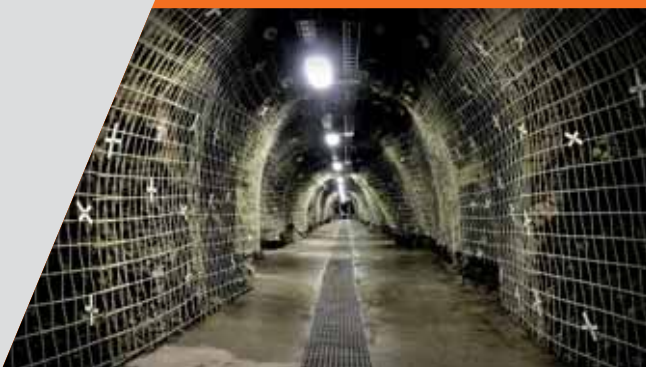
Odvodňovací štola VD Šance, stavba roku 2014 (ČKAIT)
