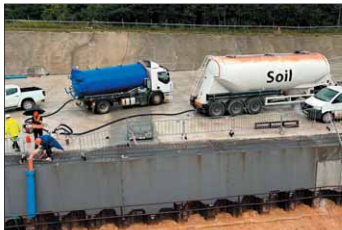
Obr. 6 Výplň prostoru mezi konstrukcí tunelu a štiťovnicemi popůlkobetonem Fig. 6 Filling of space between tunnel structure and sheetpiles with cinder concrete
