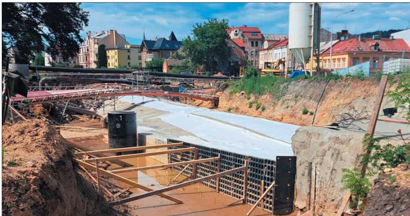
Obr. 8 Pohled na izolovaný rub klenby Loubského tunelu
