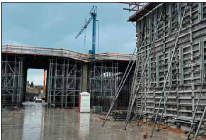
Obr. 3 Bednění střední dělicí stěny a stropní desky Fig. 3 Central dividing wall and floor slab Formwork
