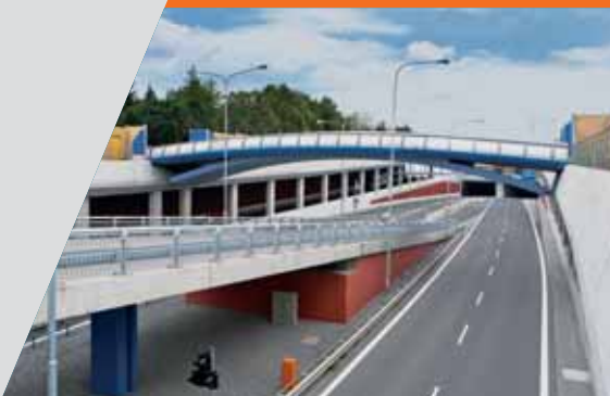
Královopolský tunel, stavba roku 2013
