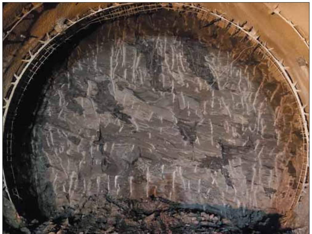
Obr. 3 Zdravé břidlice bohdaleckého souvrství na čelbě pravého jednokolejného tunelu
