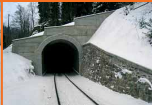
Rekonstrukce Domašovského tunelu, rok 2013
