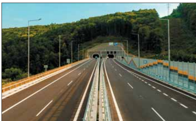
Obr. 1 Úsek rýchlostnej cesty pred severným portálom tunela Bikoš Fig. 1 Fast highway section in front of the northern portal of the Bikoš tunnel
