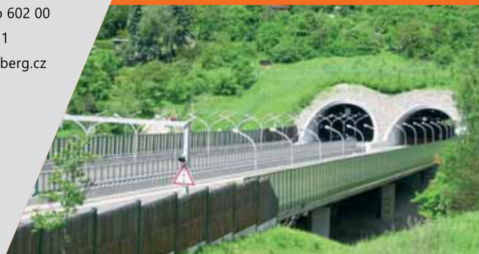
Pisárecký tunel, stavba roku 1998
