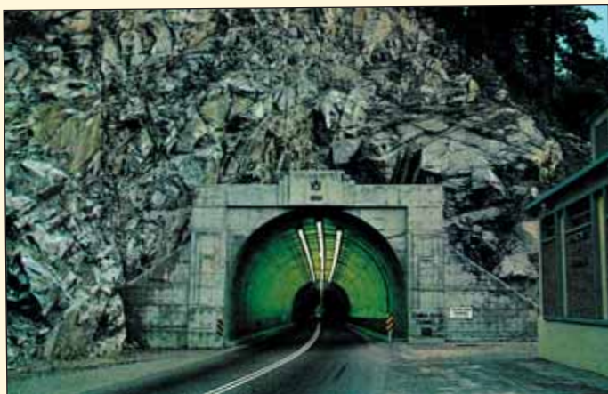
Obr. 5 Poblíž Boston Bar, Britská Kolumbie. China Bar Tunnel, dlouhý 637 m (2 090 stop), je jedním z tunelů a mostů – moderních zázraků, které nahradily zrádnou stezku průkopníků do Frazer Canyonu. Photo-Right – Dorsey McTaggart. Dist. By „Scenes by Dorsey“ 2403 Trinity St., Vancouver, B.C. Po 1961 [sbírka autorů].
