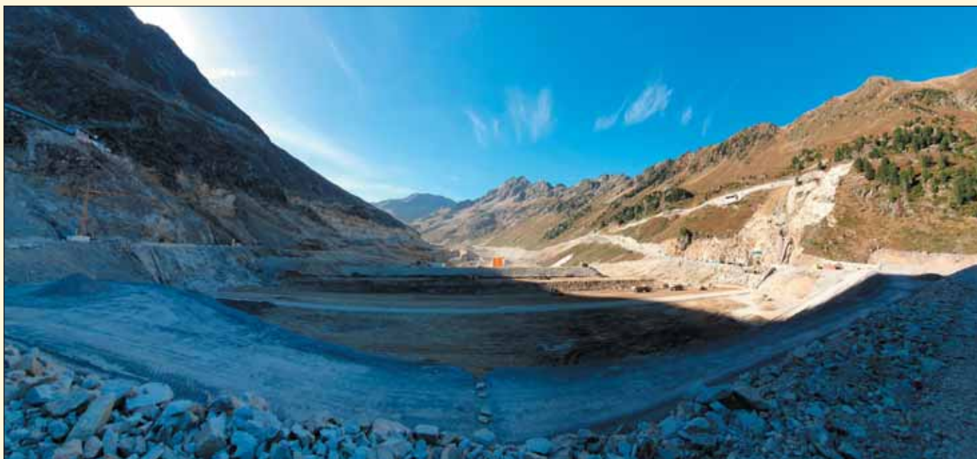
Obr. 5 Přehradní profil – budování hráze Fig. 5 Dam profile – building the dam
