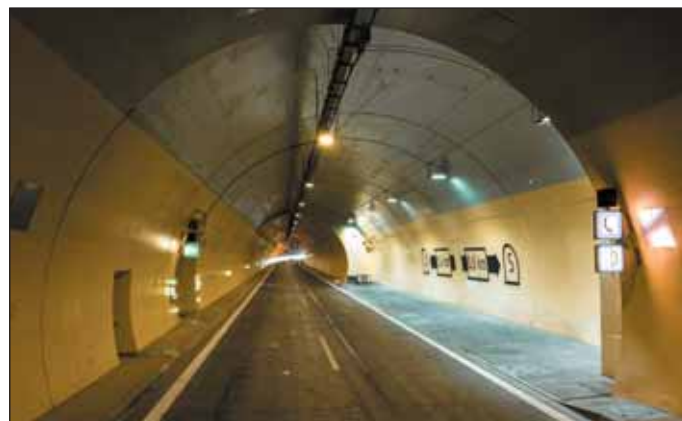
Obr. 2 Pohľad dovnútra tunela v mieste núdzového zálivu Fig. 2 A view down the tunnel in the location of emergency lay-by
