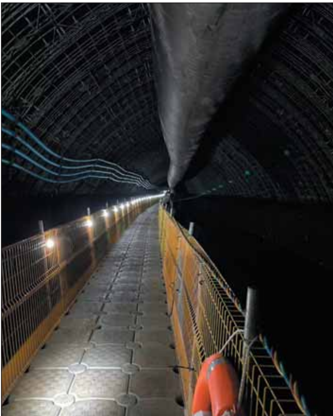
Obr. 5 Pontonový chodník v tunelu Queensbury Fig. 5 Pontoon walkway in Queensbury tunnel
