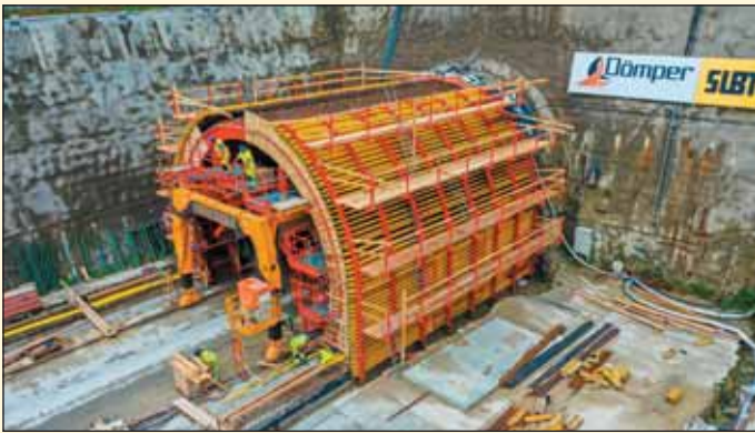
Obr. 3 Betonáž tunelu v otevřené stavební jámě Fig. 3 Concreting of the tunnel in an open construction pit
