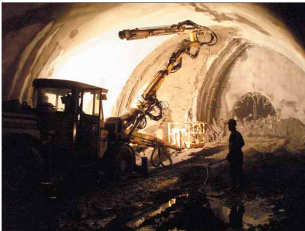
Obr. 4 Vrtací práce pro realizaci zpevňujících injektáží na členěné kalotě raženého tunelu (lokality Královská obora, TKB)
