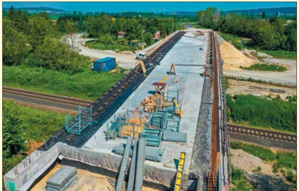
Obr. 4 Realizace mostního objektu Fig. 4 Construction of the bridge
