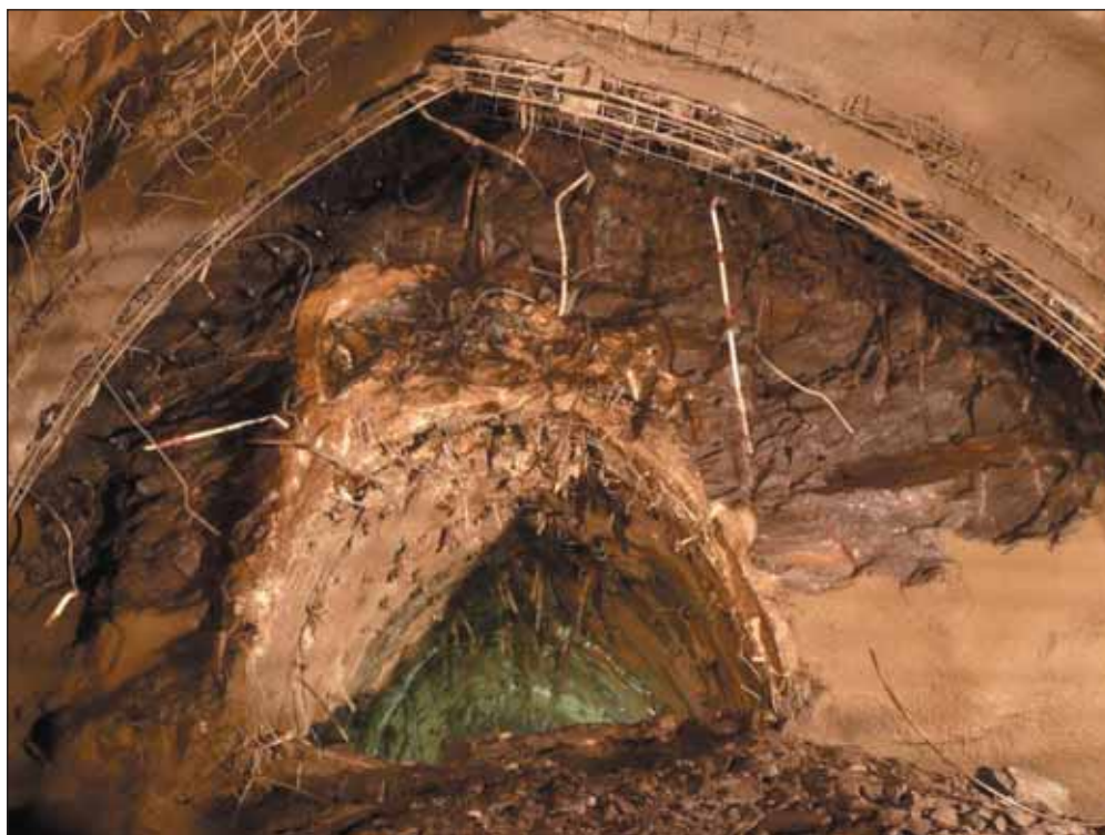
Obr. 2 Celkový pohled na kalotu čelby po odtěžení horniny (lokality Královská obořa, TKB)
