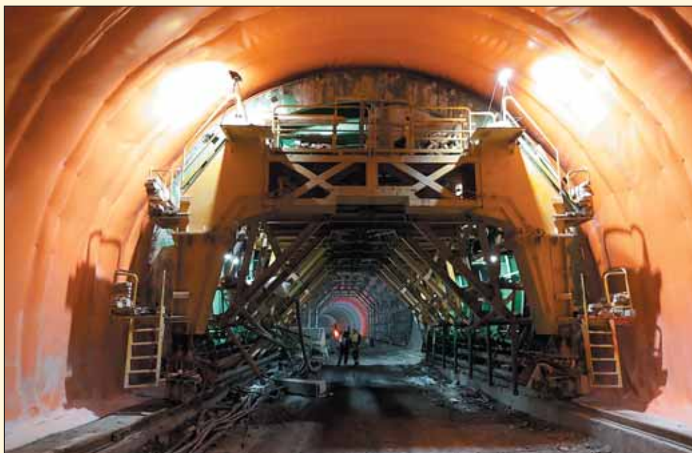
Obr. 5 Debniaci voz v tuneli Čebrať Fig. 5 Tunnel form traveller for the Čebrať tunnel
