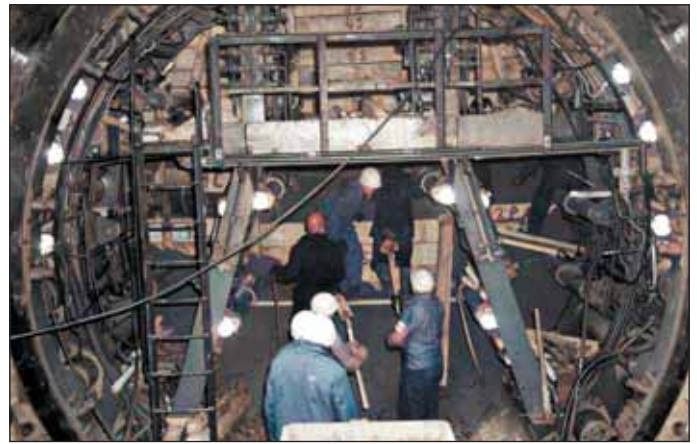
Obr. 3 Pracovníci na čelbě nemechanizovaného štítu Fig. 3 Workers at excavation face of the non-mechanised shield
