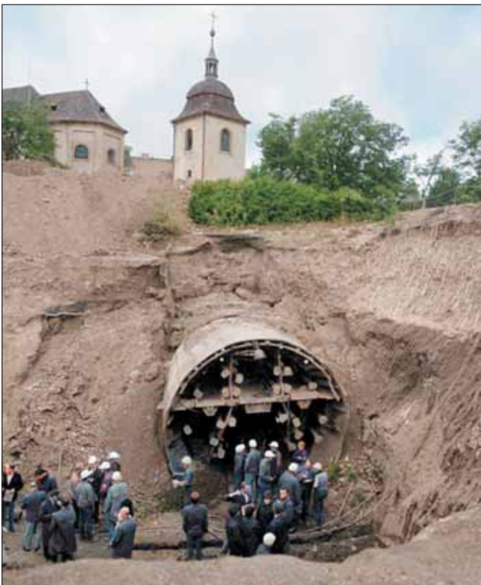
Obr. 5 Prorážka pod kostelem sv. Pankráce Fig. 5 Breakthrough under St. Pankrac church
