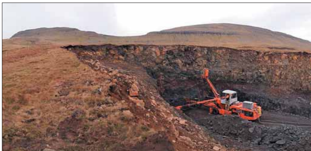
Obr. 9 Vrtací vůz v prostoru portálu tunelu – odkryté čediče lávového proudu Fig. 9 Drilling jumbo in the tunnel portal area – exposed basalts of the lava flow
