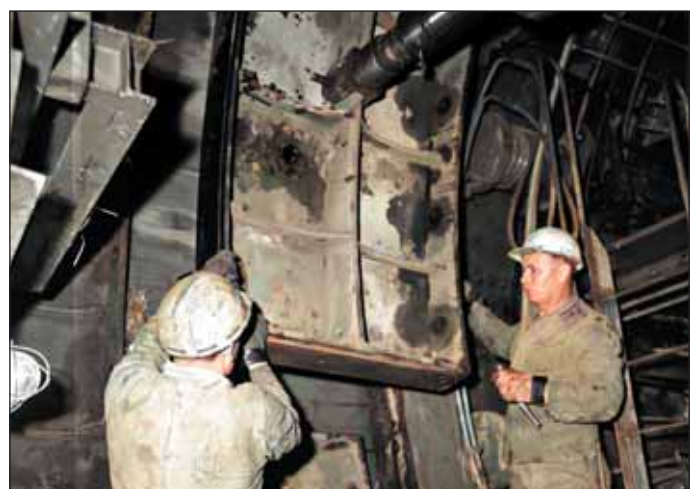
Obr. 4 Montáž tunelového ostění erektorem v nemechanizovaném štítu Fig. 4 Assembly of tunnel lining by an erector in the non-mechanised shield
