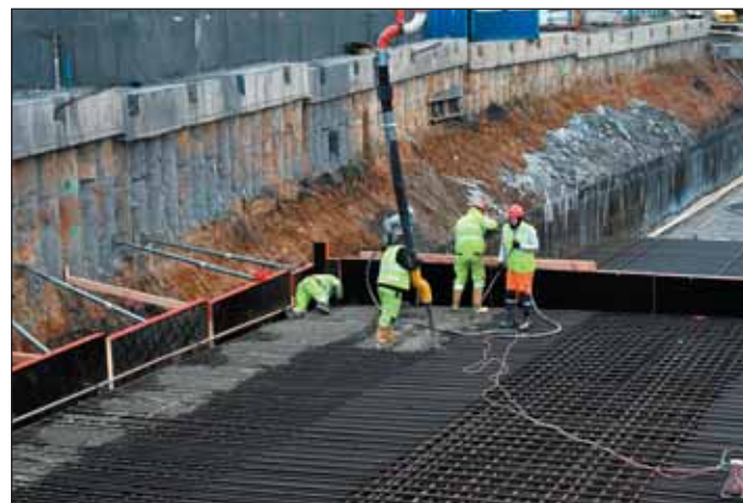
Obr. 5 Betonáž stropní desky Fig. 5 Concreting of a roof deck slab
