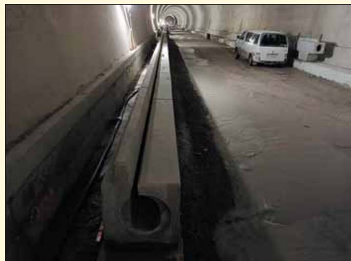
Obr. 9 Pokládka štrbinových žlabov odvodnenia vozovky v tuneli Višňové Fig. 9 Installation of slotted pipes draining the roadway in Višňové tunnel
