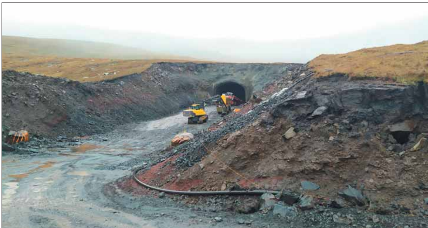
Obr. 10 Pohled na budoucí portál tunelu Ørðavík Fig. 10 View of the future Ørðavík tunnel portal
