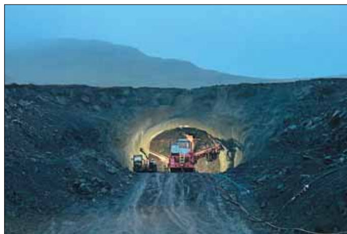
Obr. 4 Vrtací vůz na čelbě tunelu Fig. 4 Drill rig at the tunnel heading
