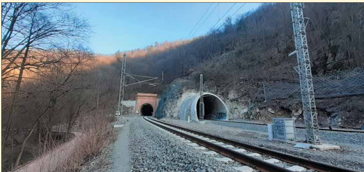
Obr. 3 Jednokolejný tunel Blanenský č. 8/2
