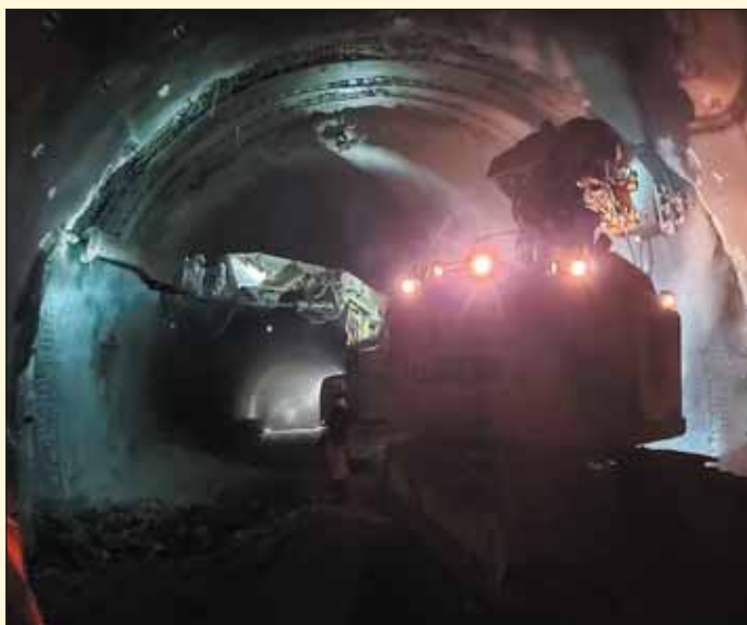
Obr. 6 Rekonštrukcia zálivu č. 1 v južnej rúre tunela Čebrať Fig. 6 Reconstruction of lay-by No. 1 in Čebrať tunnel southern tube
