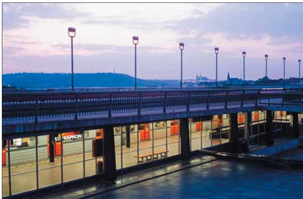
Obr. 1 Pražská podzemní dráha, stanice Vyšehrad Fig. 1 Prague underground, Vyšehrad station
