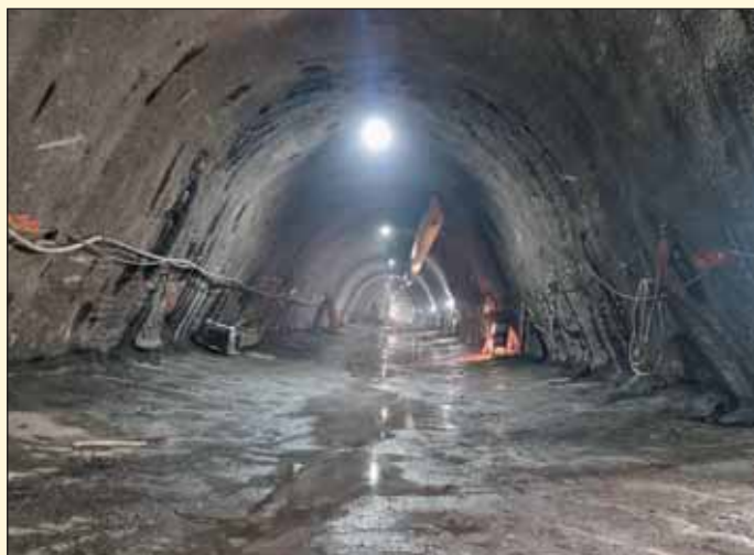
Obr. 2 Ražba patní štoly stanice Pankrác Fig. 2 Excavation of Pankrác station bottom gallery
