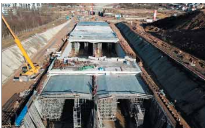
Obr. 3 Monolitické práce na střední části tunelu – pohled od jihu
