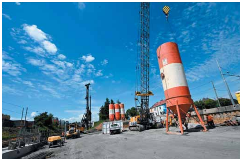
Obr. 7 Zařízení staveniště pro výrobu lamel Fig. 7 Construction site facility for production of lamellas
