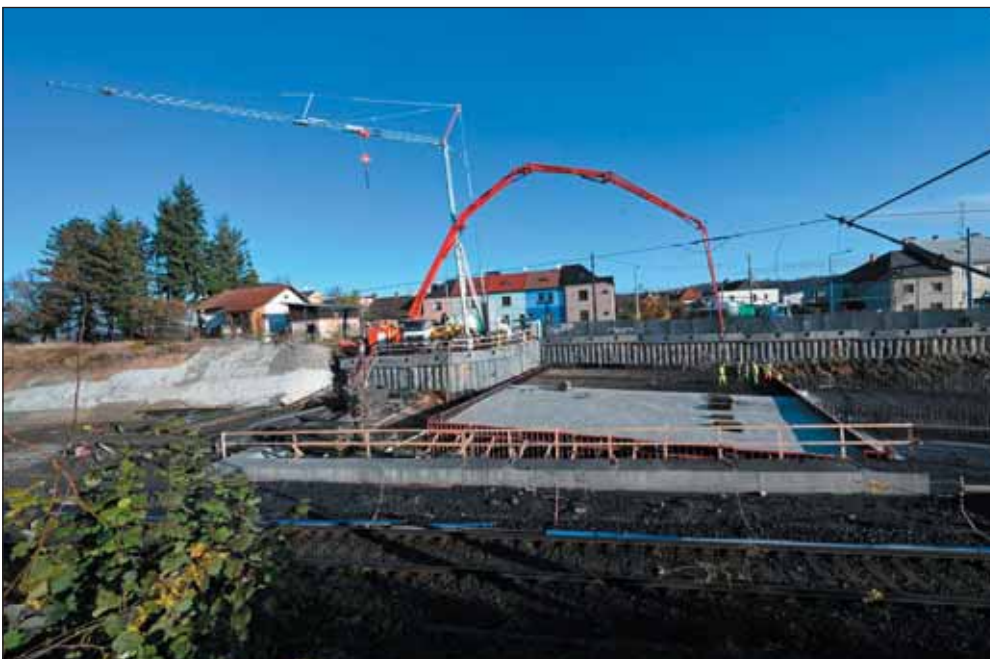
Obr. 11 Betonáž dilatačního dílu 1
