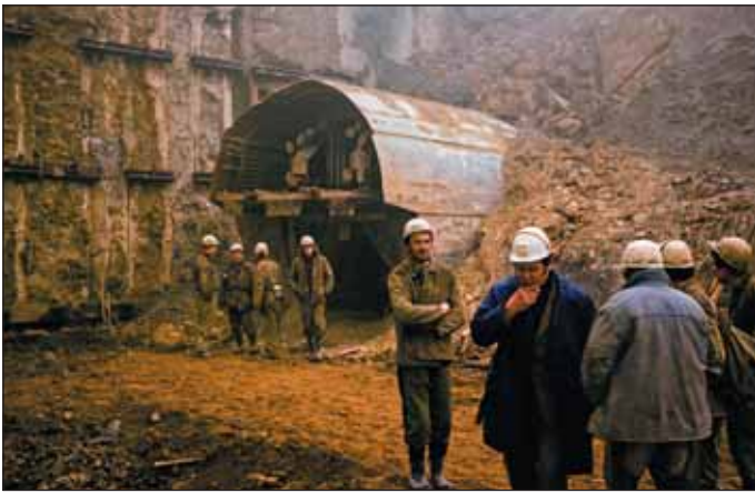
Obr. 2 Štítová část nemechanizovaného komplexu KM34 (1978) Fig. 2 Shield part of the non-mechanised complex KM34 (1978)
