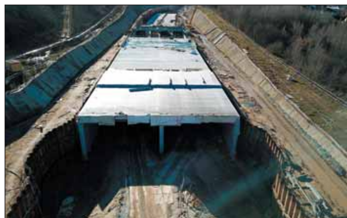
Obr. 4 Monolitické práce na střední části tunelu – pohled od severu
