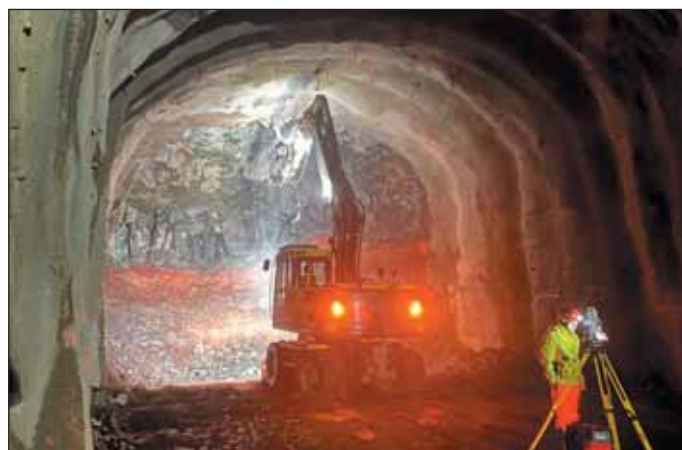
Obr. 6 Scaling (strojní dočišťování výrubu) po provedení trhacích prací Fig. 6 Mechanical scaling after completion of blasting
