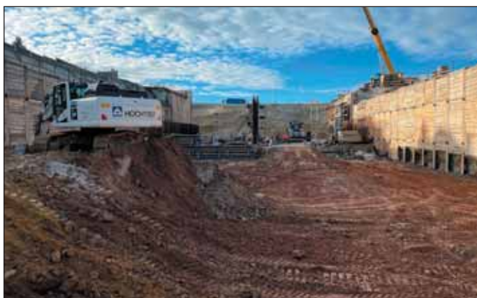
Obr. 5 Zemní práce na Kaplickém portále
