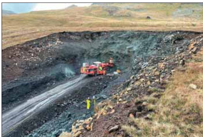
Obr. 3 Portálová jáma tunelu Fámjin Fig. 3 Portal pit of Fámjin tunnel
