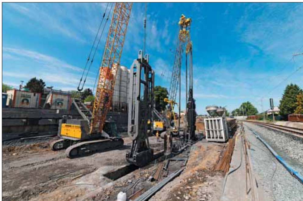
Obr. 4 Fréza a drapák pro realizaci podzemních stěn Fig. 4 Hydroraise mill and grab for construction of diaphragm walls
