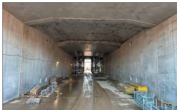
Obr. 6 Pohled do nosné konstrukce tunelu
