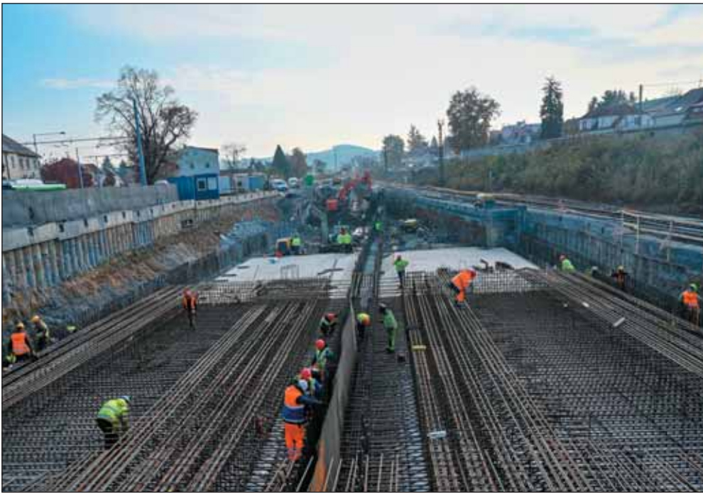
Obr. 10 Armování 1. dilatace a podklad pro 2. dilataci
