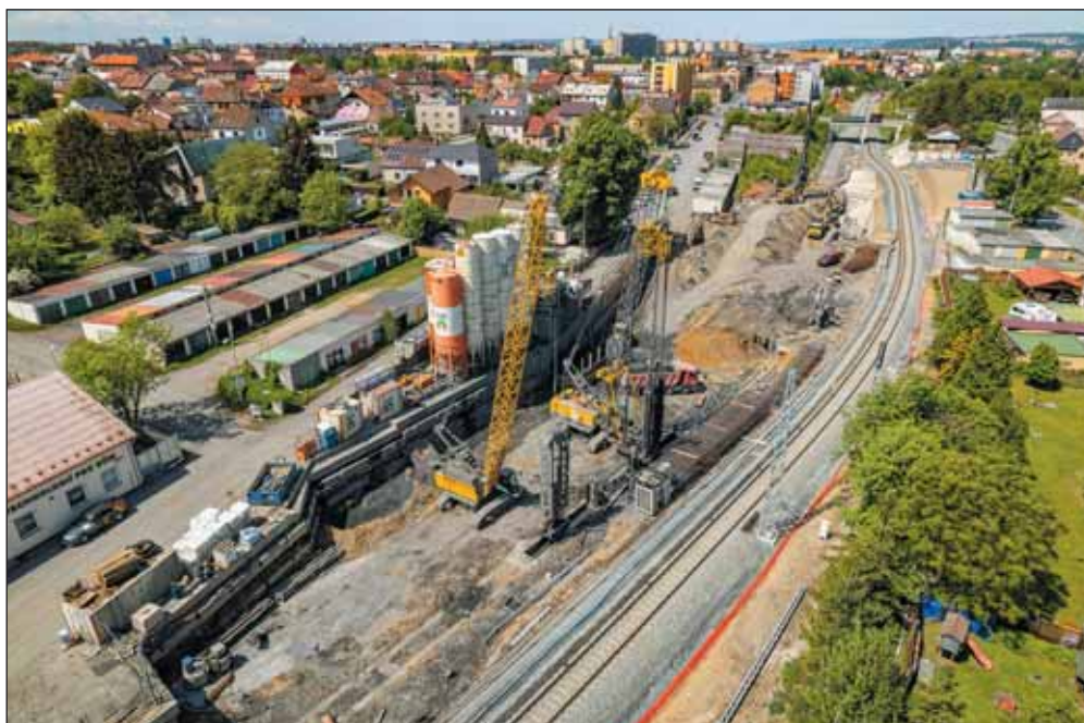
Obr. 2 Letecký pohled na stavbu Uzlu 5 Fig. 2 Aerial view of the Node 5 construction
