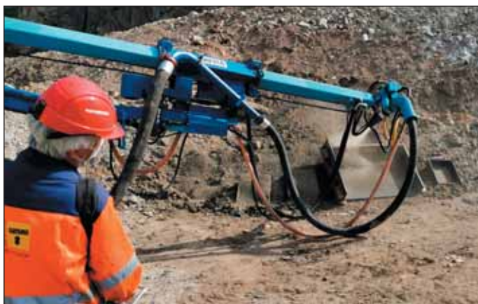
Obr. 4 Nástřik zkušební desky z vláknobetonu na stavbě
