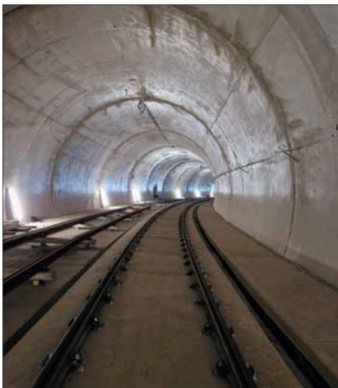
Obr. 7 Výstavba pevné železniční dráhy Fig. 7 Construction of slab track
