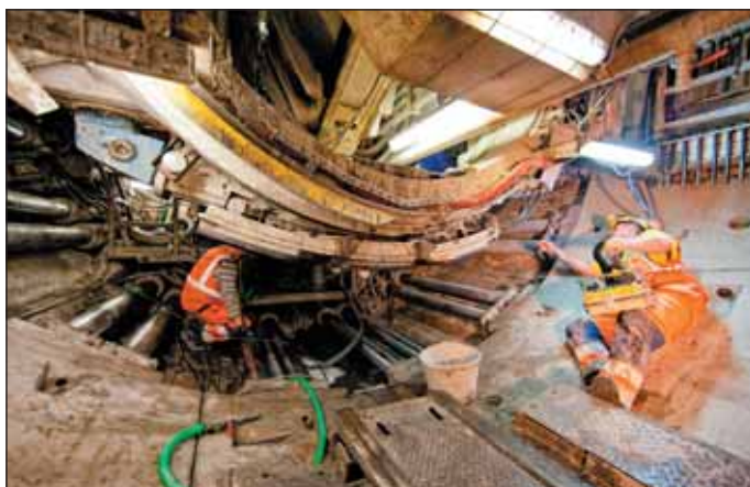
Obr. 12 Montáž ostění erektorem na stroji S-609 Fig. 12 Assembly of lining by erector on S-609 machine
