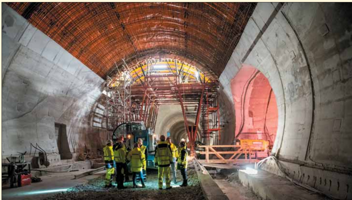
Obr. 8 Realizácia sekundárneho ostenia núdzového zálivu v tuneli Višňové Fig. 8 Work on secondary lining of emergency lay-by in Višňové tunnel
