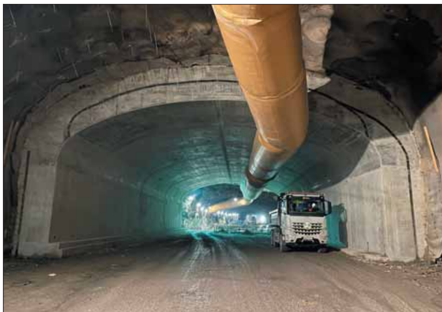
Obr. 12 Dokončené sekundární ostění tunelové trouby HT202 Fig. 12 Completed secondary lining of tunnel tube HT202
