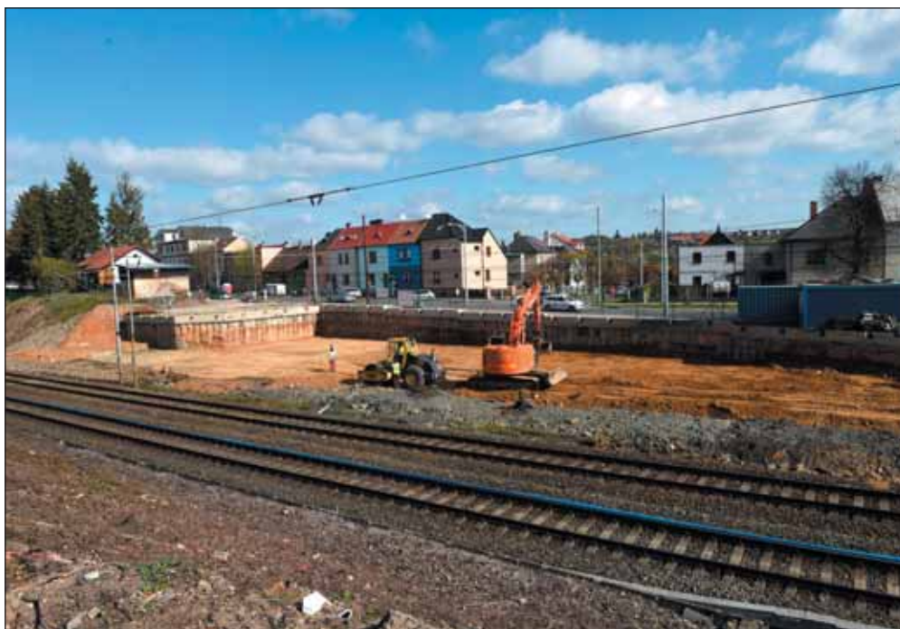
Obr. 8 Stavební jáma
