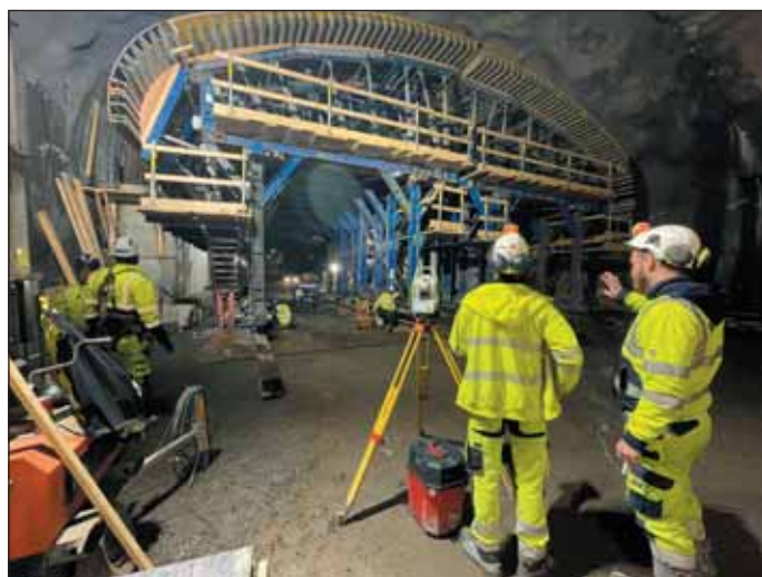
Obr. 5 Bednicí forma klenby ostění Fig. 5 Formwork for vault of lining
