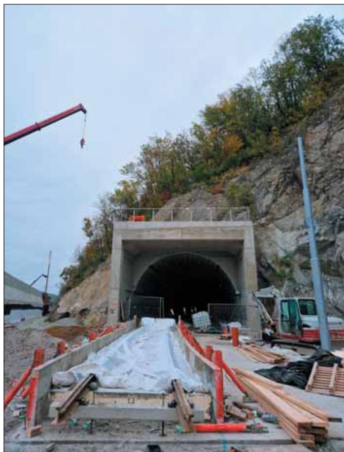
Obr. 3 Jižní portál raženého tunelu Fig. 3 Southern portal of the mined tunnel
