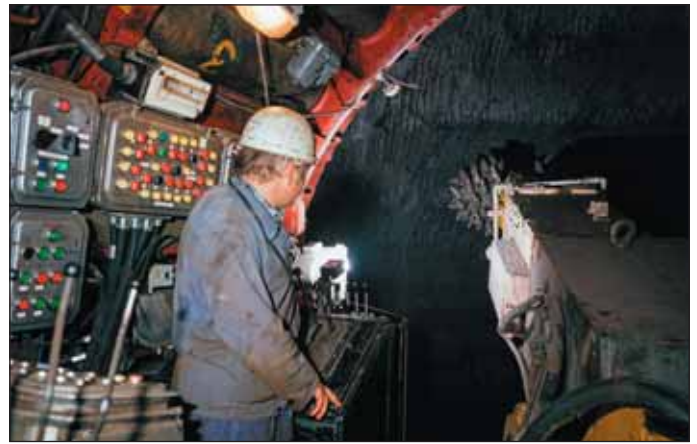
Obr. 10 Práce na čelbě štítu RŠF-1 Fig. 10 Work at the heading of RŠF-1 shield
