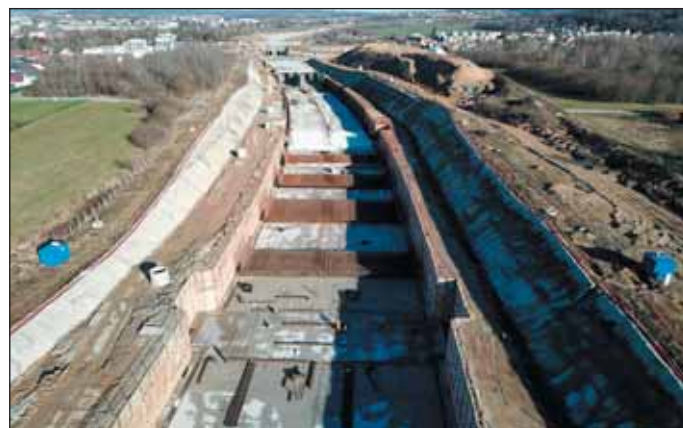
Obr. 2 Armovací práce ve střední části tunelu – pohled od jihu
