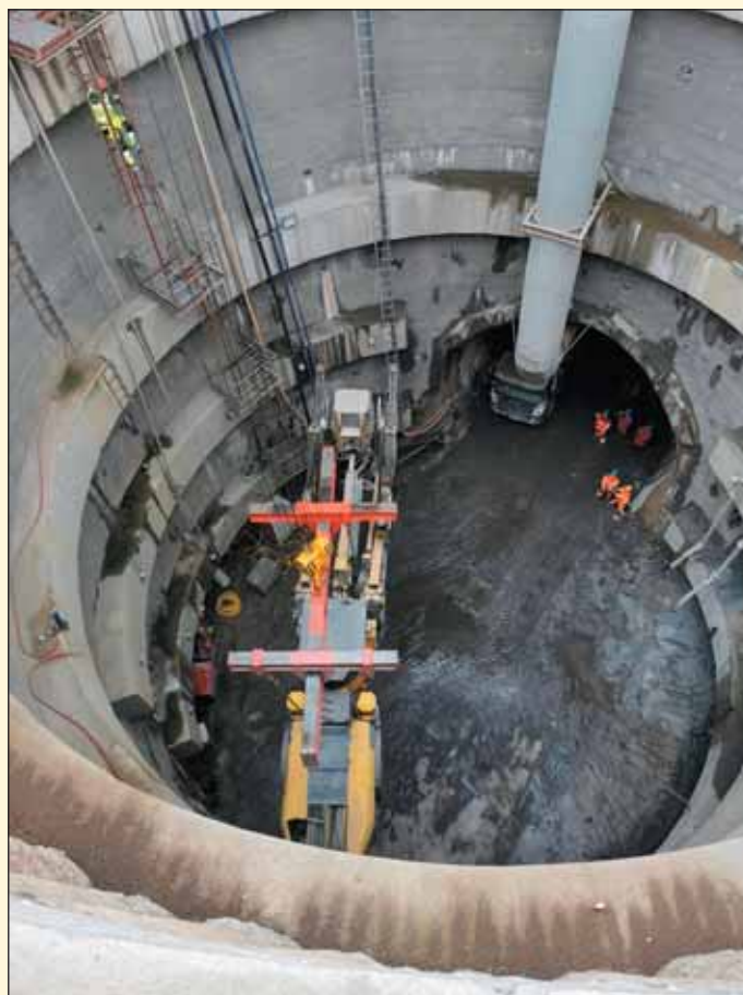
Obr. 2 Těžní šachta sloužící k podpoře zde prováděných ražeb Fig. 2 Hoisting shaft used for supporting the excavation being carried out in this place
