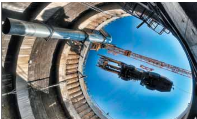
Obr. 3 Spouštění vrtacího vozu Epiroc E2C do šachty na staveništi PAD1
