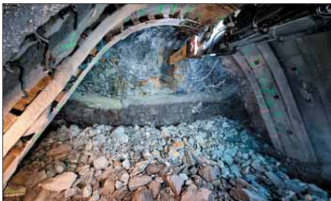
Obr. 5 Pohled na čelbu zastiženou během ražby patní štoly stanice Pankrác D
