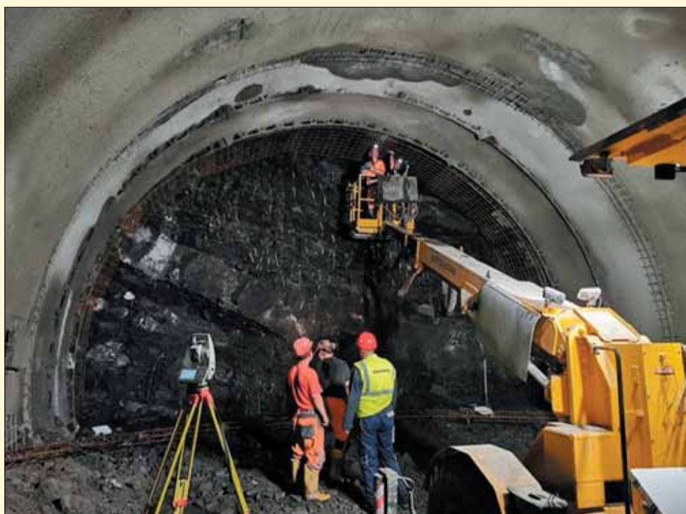
Obr. 3 Provádění ražeb přístupové štoly do stanice Pankrác Fig. 3 Excavation of access gallery to Pankrác station
