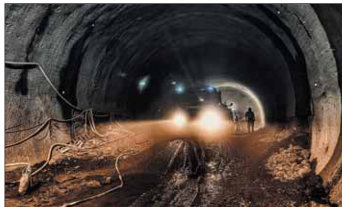
Obr. 4 Čelba přístupové štoly do stanice Pankrác
