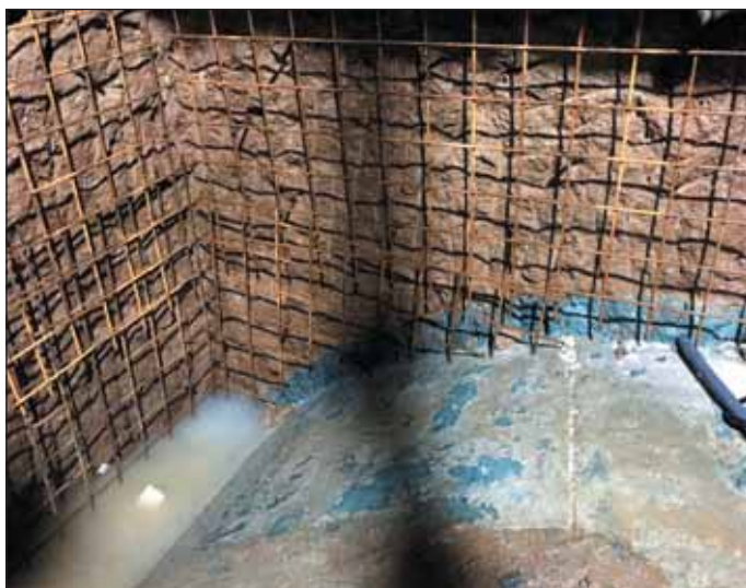
Obr. 12 Výkop nad tunelom razeným EPB štítom Fig. 12 Excavation above EPB shield driven tunnel
