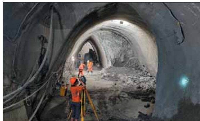
Obr. 6 Měření konvergencí na patní štole stanice Pankrác D
