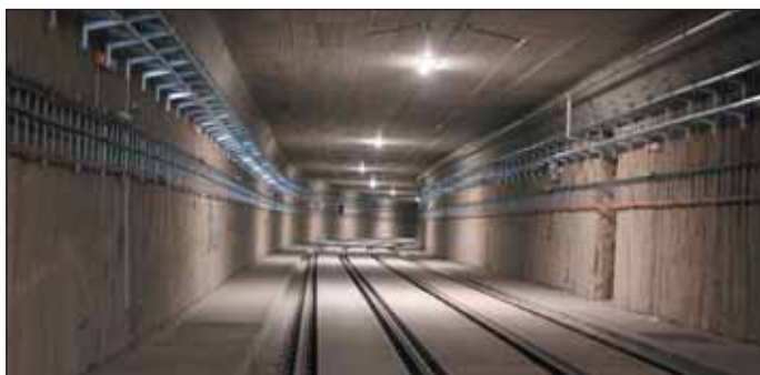
Obr. 3 Část tunelu vedená v podzemních stěnách s dokončenou pevnou jízdni dráhou Fig. 3 Part of the tunnel running between diaphragm walls with a completed slab track
