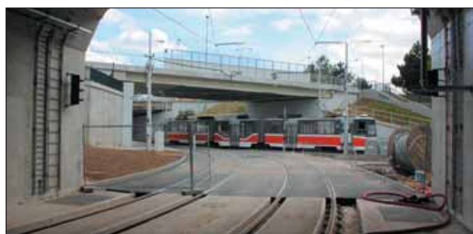
Obr. 2 Pohled z tunelu na místo rozpletu původní a nové trati před vjezdovým portálem Fig. 2 View from the tunnel to the bifurcation of the original and new tracks in front of the entrance portal
