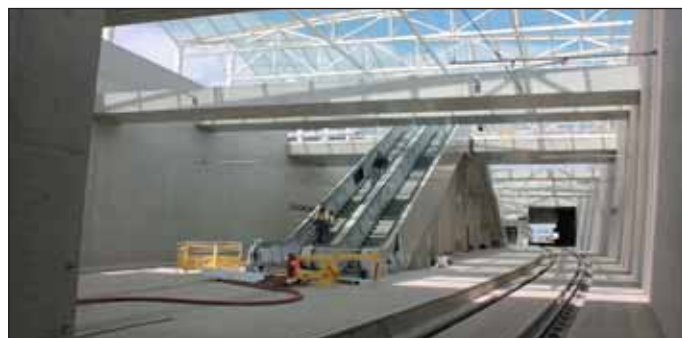
Obr. 4 Pohled na dokončovanou stanici Západní brána Fig. 4 View of the Západní Brána station being finished
