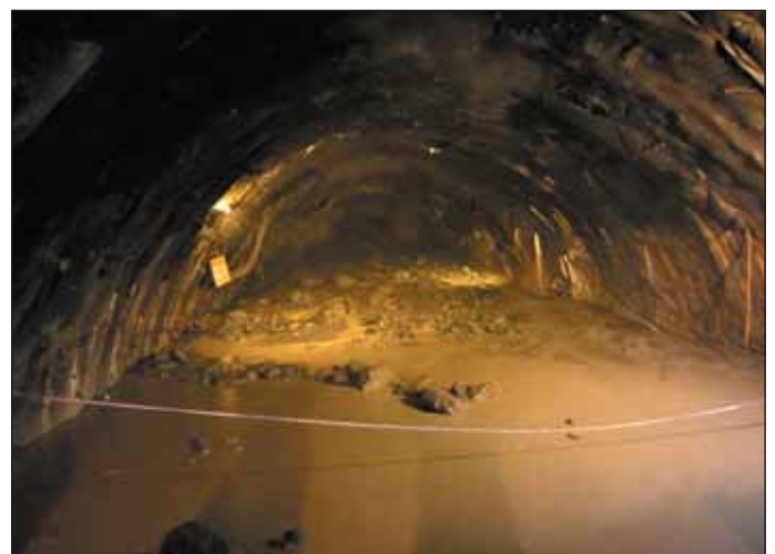
Obr. 6 Vyplavení materiálu v kalotě tunelu ve staničení 2390 ze dne 30. 8. 2014 Fig. 6 Material washed out at Ch. 2390 dated 30/08/2014
