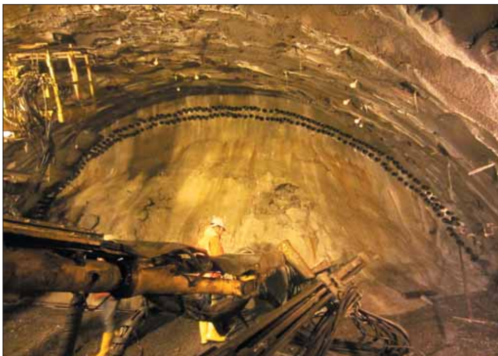
Obr 7 Provádění dvouřadého deštníku o průměru 114 mm ve staničení 2413 až 2445
