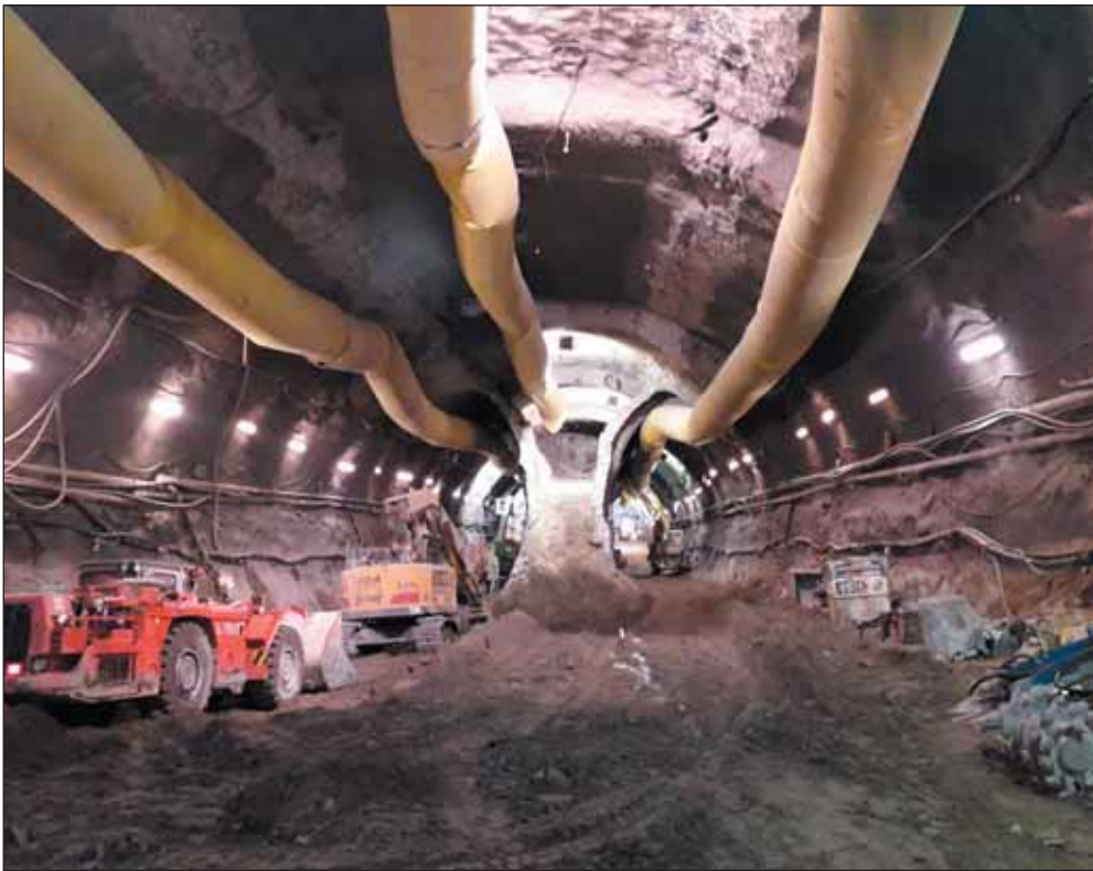
Obr. 12 Staniční tunel ve stanici Avenue po odstranění části dočasných stěn Fig. 12 The station tunnel in Aveune station after removing temporary walls
