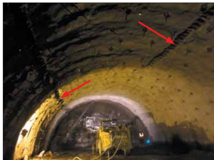
Obr. 9 Dvě řady LSC, jedna řada LSC umístěna poblíž čela kaloty, červenec 2015
