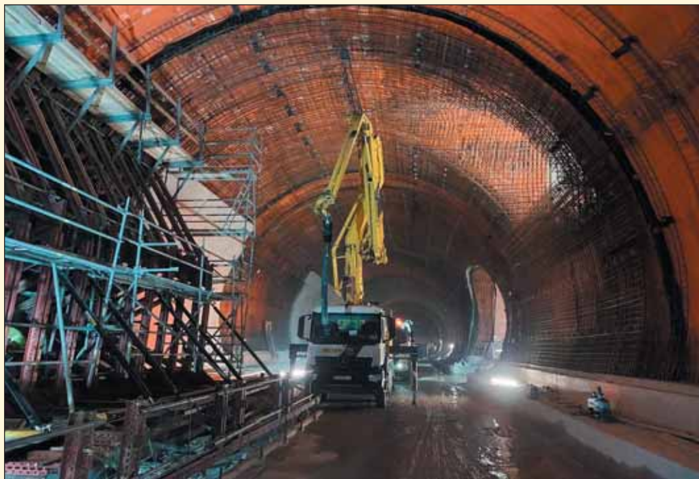
Obr. 7 Realizácia sekundárneho ostenia v tuneli Višňové Fig. 7 Installation of secondary lining in the Višňové tunnel
