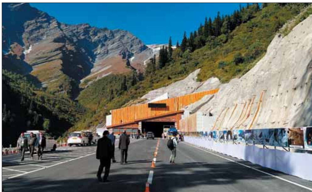
Obr. 11 Jižní portál tunelu Atal (původní název Rohtang), jeden den před oficiálním otevřením Fig. 11 The South Portal of the Atal Tunnel, one day prior official opening
