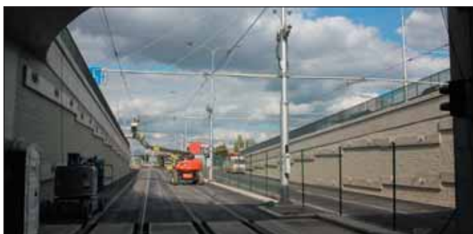
Obr. 5 Pohled z části tunelu pod ulicí Jihlavská, vlevo dvojice průjezdných kolejí před konečnou zastávkou Nemocnice Bohunice, vpravo dvojice odstavných kolejí Fig. 5 View from the part of the tunnel under Jihlavská Street, for the left pair of through tracks in front of the final stop Nemocnice Bohunice, for the right pair of stabling tracks
