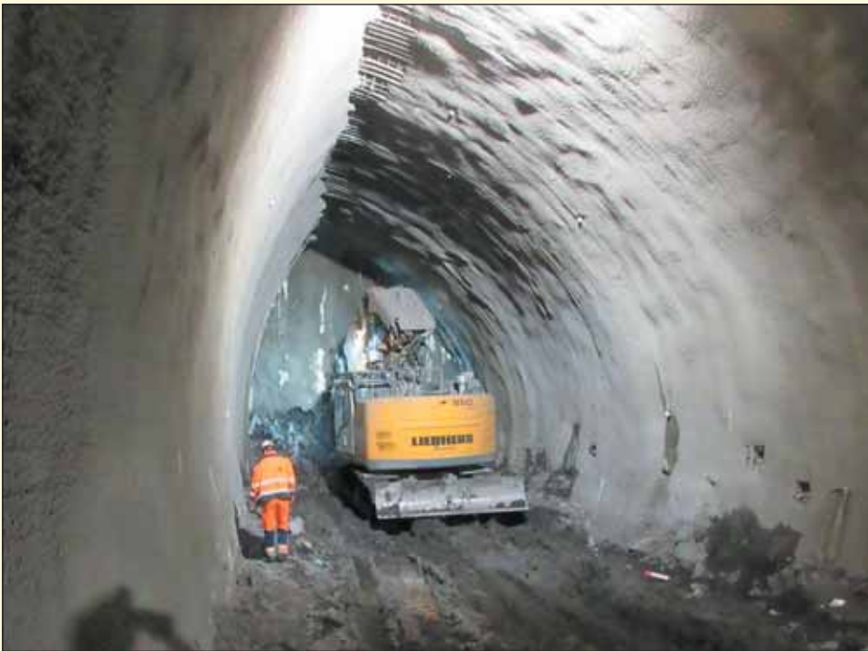
Obr. 4 Provádění ražeb části profilu budoucího dvoukolejného tunelu Fig. 4 Excavation of a part of a future double-track tunnel
