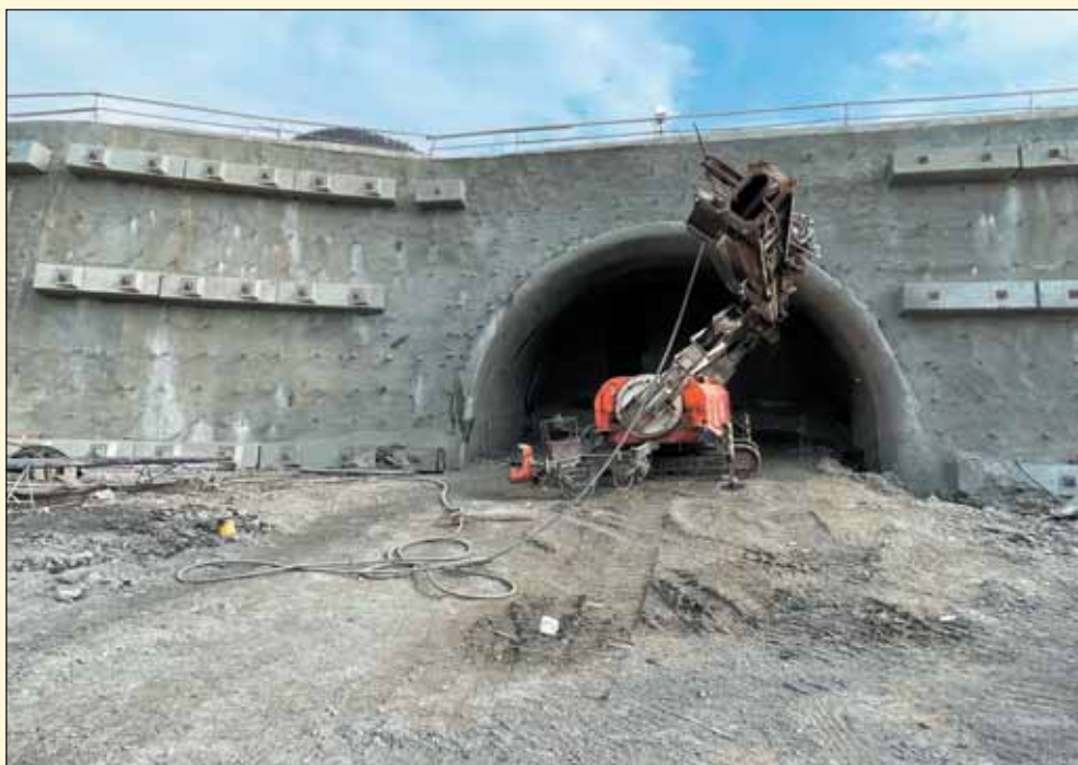
Obr. 5 Západný portál tunela Čebrať, vrtanie 2. mikropilotového dáždnika v južnej tunelovej rúre Fig. 5 Western portal of Čebrať tunnel, including 2 nd canopy tube presupport in the southern tunnel tube
