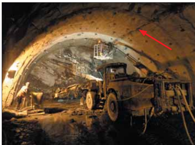
Obr. 8 Jedna řáda pro regulaci napětí v primárním ostění za čelem kaloty, červenec 2017
