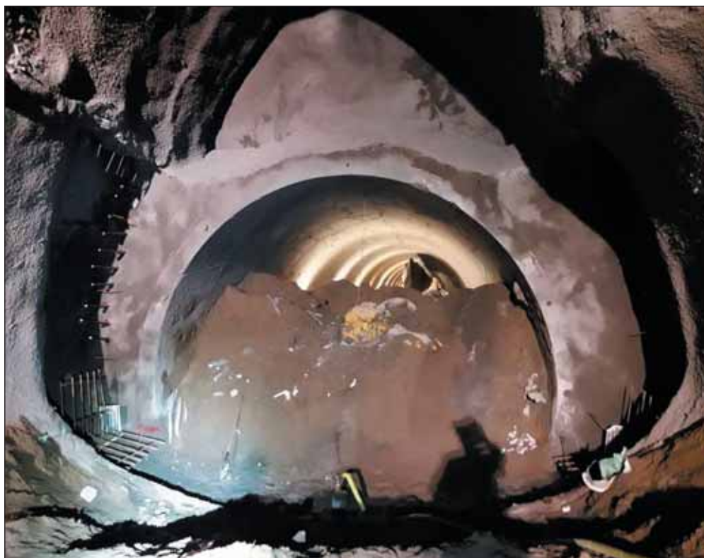
Obr. 9 Realizace vyztužování a zajišťování dílčího výrubu bočního tunelu Fig. 9 Installation of reinforcement and support of the side drift
