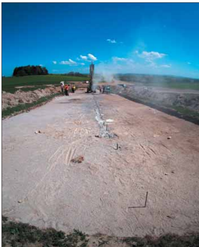
Obr. 4 Realizace 1. etapy vrtů těsnicí stěny
