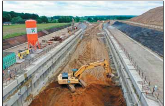
Obr. 2 Odtěžování jámy mezi pilotovými stěnami Fig. 2 Excavation of a pit between pile walls
