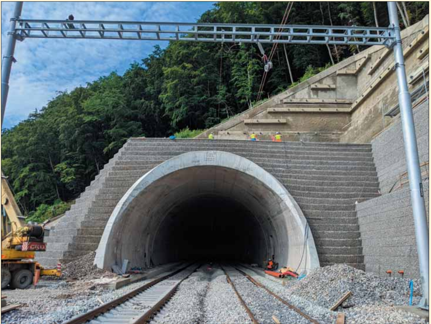
Obr. 8 Konečné terénne úpravy na portáli únikovej štôlne tunela Diel Fig. 8 Final terrain finishes at the portal of the Diel tunnel escape gallery
