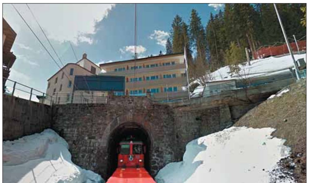
Obr. 3 Výjezdový portál Arosa Fig. 3 Arosa exit portal
