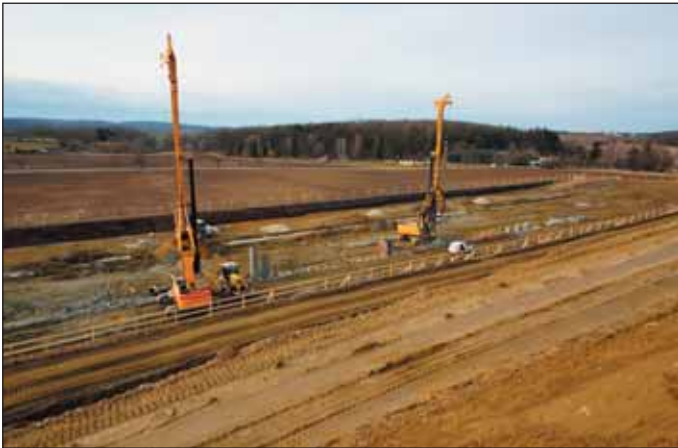
Obr. 1 Zahájení vrtání pilotových stěn Fig. 1 Commencement of drilling for pile walls
