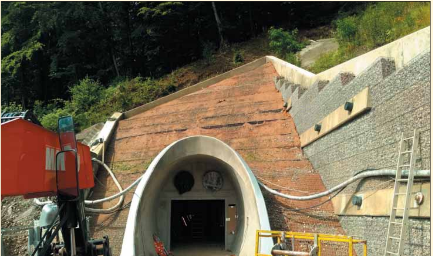
Obr. 7 Konečné terénne úpravy na portáli únikovej štôlne tunela Diel Fig. 7 Final terrain finishes at the portal of the Diel tunnel escape gallery
