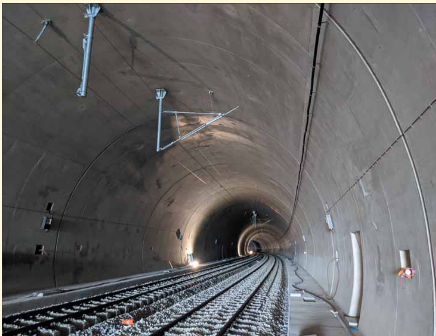
Obr. 6 Montáž železničného zvršku a technológie v tuneli Diel Fig. 6 Installation of trackwork and equipment in the Diel tunnel
