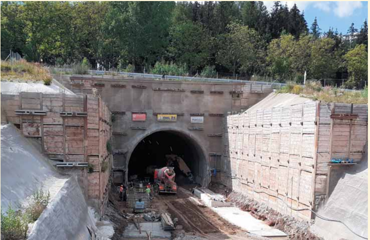
Obr. 4 Budování základových pásů hloubeného tunelu na vjezdovém portálu tunelu Deboreč Fig. 4 Construction of strip footings of the cut-and-cover tunnel at the entrance portal of the Deboreč tunnel
