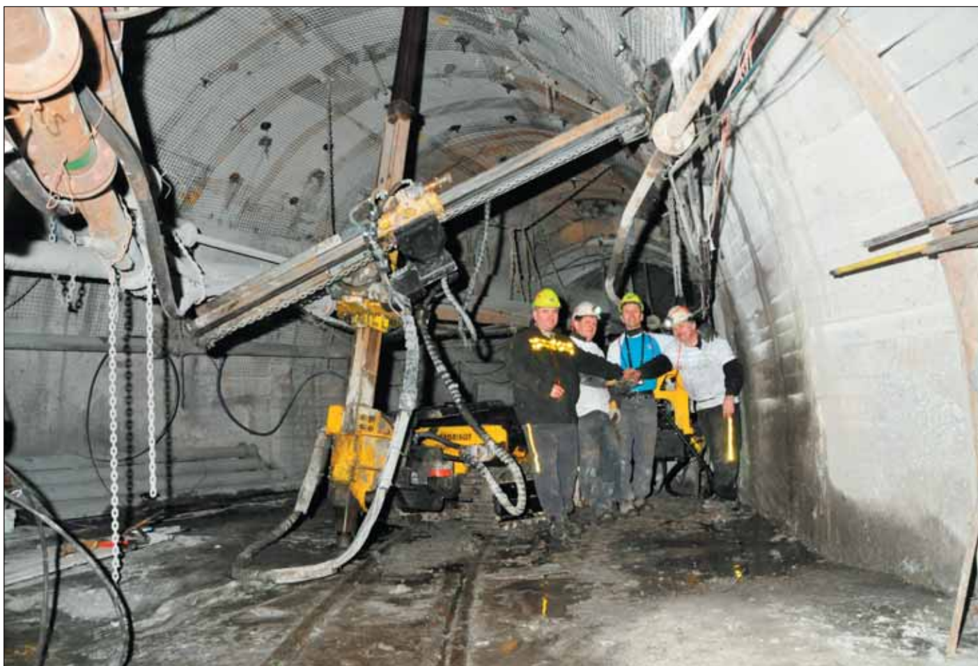
Obr. 6 Vrtací a svornikovací souprava ANDRIBOT při ověřovacím provozu kombinované výztuže [4] Fig. 6 ANDRIBOT drilling and bolting rig during verification operations of combined support [4]
