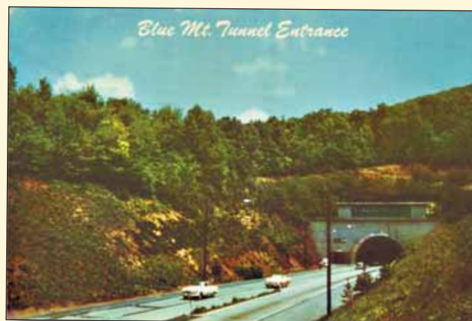
Obr. 2 Portál Blue Mt. Tunelu. Pensylvánská mýtná silnice (Pennsylvania Turnpike) – „Největší dálnice světa“. Postcard Johnson Publishing Department, Bedford, Pa. 1969. [sbírka autorů]
