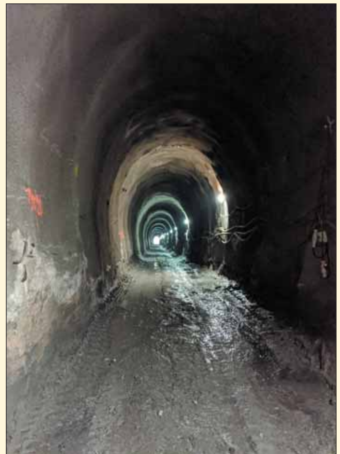
Obr. 10 Úniková štôľňa tunela Milochov Fig. 10 Milochov tunnel escape gallery
