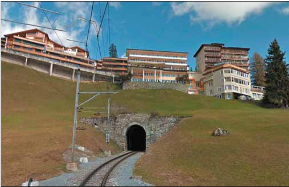
Obr. 2 Vjezdový portál Chur Fig. 2 Chur entrance portal
