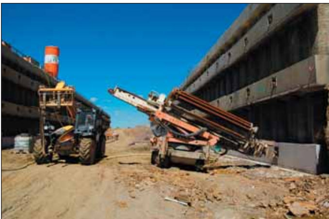
Obr. 3 Vrtky pro lanové kotvy na třetí převážce Fig. 3 Drillholes for cable anchors on the third waler
