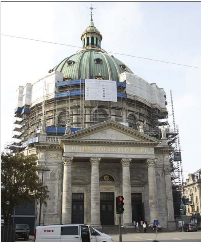
Obr. 6 Sanační práce na kupoli kostela Marmorkirken před započatím výstavby Fig. 6 Rehabilitation work on the Marmorkirken church dome before the project commencement
