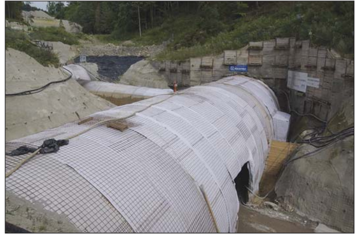
Obr. 4 Délka hloubeného úseku jižní trouby ve střední stavební jámě Fig. 4 The length of the cut-and-cover tunnel section in the mid-point construction pit
