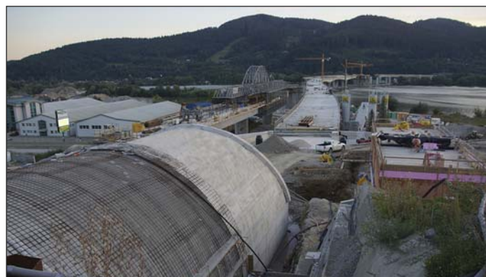
Obr. 15 Portál tunelu a návaznost na estakádu přes Hričovskou vodní nádrž Fig. 15 The tunnel portal and continuation to the viaduct over Hričov water reservoir
