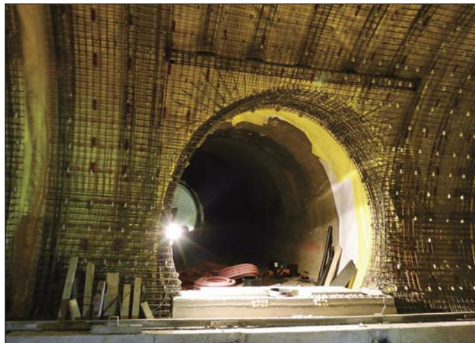
Obr. 2 Armovanie priečného prepojenia PPI Fig. 2 Cross passage PPI – installation of concrete reinforcement
