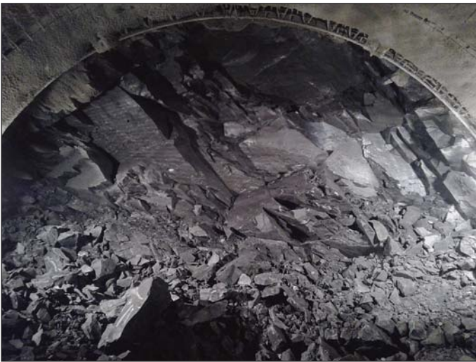
Obr. 6 Lavicovité až masivní polohy břidlice Fig. 6 Tabular to massive shale beds
