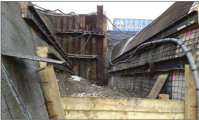
Obr. 9 Zásyp a prvky rozepření před betonáží sekundárního ostění Fig. 9 Backfill and bracing elements before casting of secondary lining concrete
