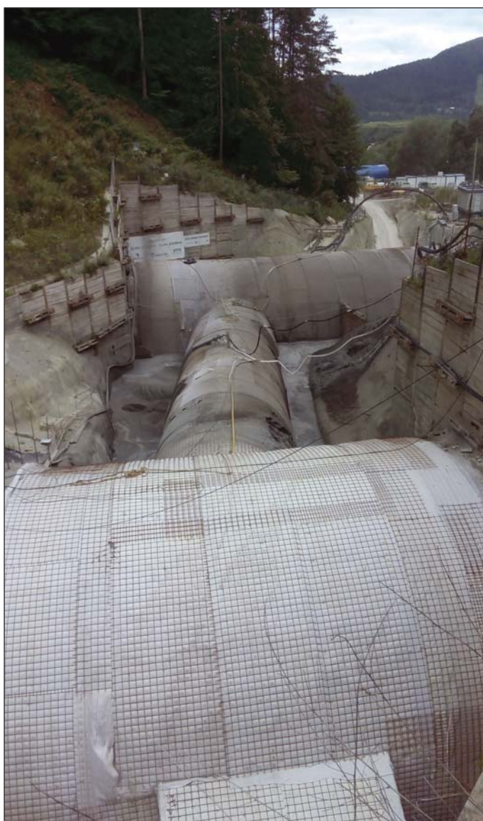
Obr. 11 První fáze zaplavování střední jámy popílkem Fig. 11 First phase of flooding of the mid-point construction trench with fly ash
