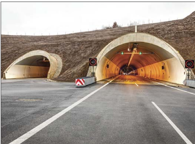
Obr. 5 Pražský portál tunelu Radejčín Fig. 5 Prague portal of the Radejčín tunnel
