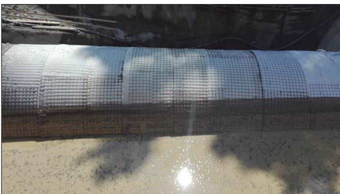
Obr. 10 Zaplavení střední jámy po přívalovém dešti Fig. 10 Flooding of the mid-point construction pit after torrential rains
