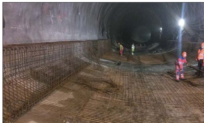
Obr. 6 Tunel Žilina, južná tunelová rúra – sekundárne ostenie (armovanie spodnej klenby)
