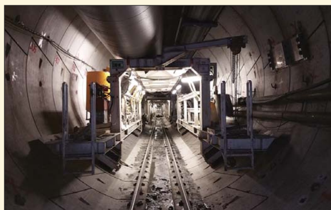
Obr. 3 Hotový tunel a poslední vozy závěsu stroje TBM
