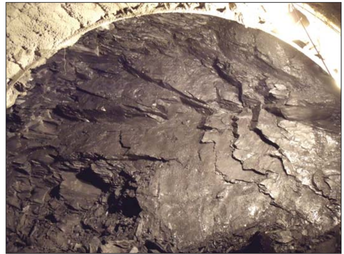
Obr. 7 Tektonické ohlasy na plochách odlučnosti na čelbě Fig. 7 Tectonic slickensides on joint planes at the excavation face
