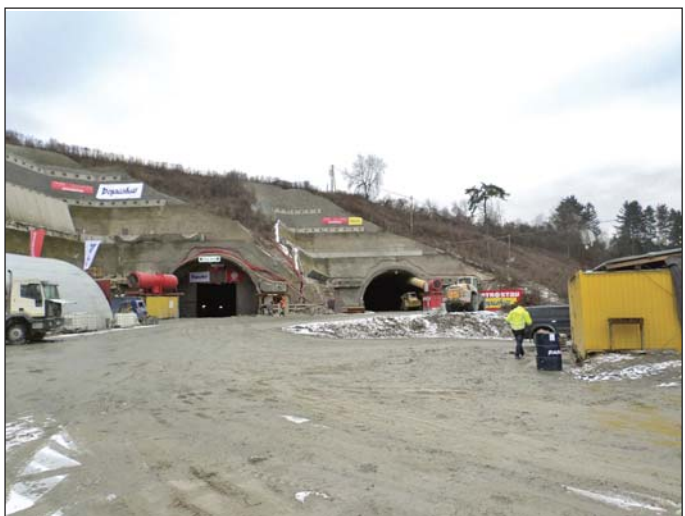
Obr. 3 Tunel Žilina – pohľad na východný portál Fig. 3 Žilina tunnel – a view of the eastern portal
