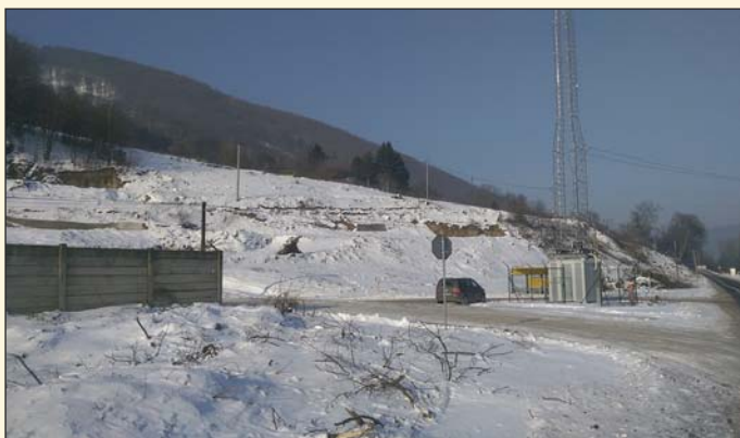
Obr. 4 Oblasť východného portálu tunela Milochov Fig. 4 Area of the eastern portal of the Milochov tunnel
