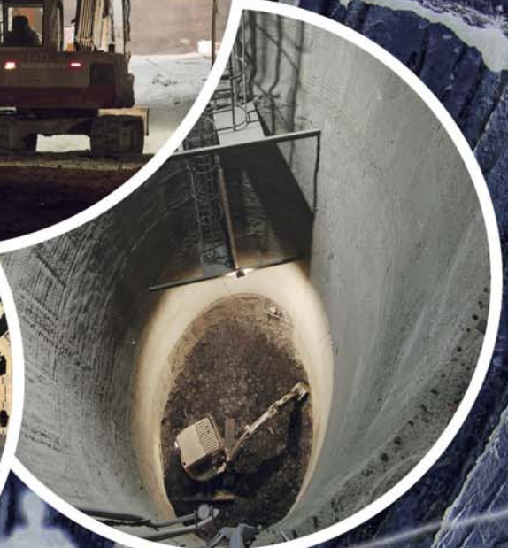
METRO TRASY B, STANICE ANDĚL, VÝTAHOVÁ ŠACHTA, 2014
