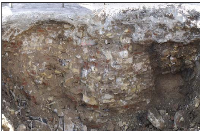
Obr. 2 Zdivo základů staré zástavby zastíženo při hloubení šachty
