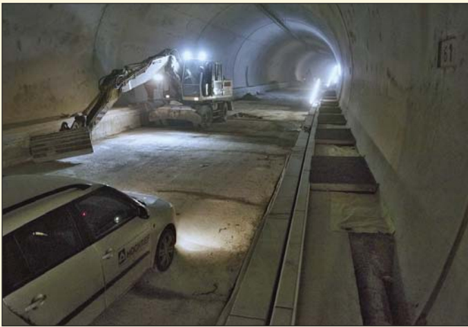
Obr. 5 Južná tunelová rúra tunelu Považský Chlmec Fig. 5 Southern tunnel tube of Považský Chlmec tunnel
