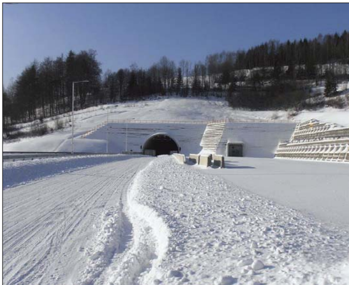
Obr. 1 Tunel Poľana – pohľad na východný portál Fig. 1 Poľana tunnel – a view of the eastern portal
