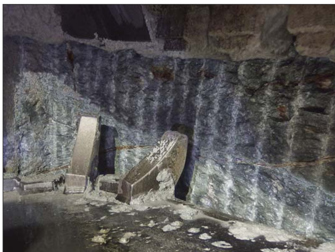
Obr. 5 Spilitový masiv v okně řezné hlavy Fig. 5 Spilite massif in a cutterhead window
