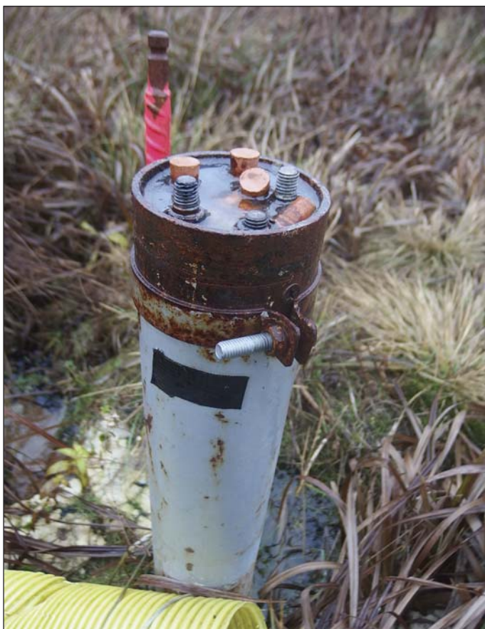
Obr. 12 Detail zhlaví extenzometru ve staničení 95,918 km Fig. 12 Detail of extensometer head at chainage km 95.918
