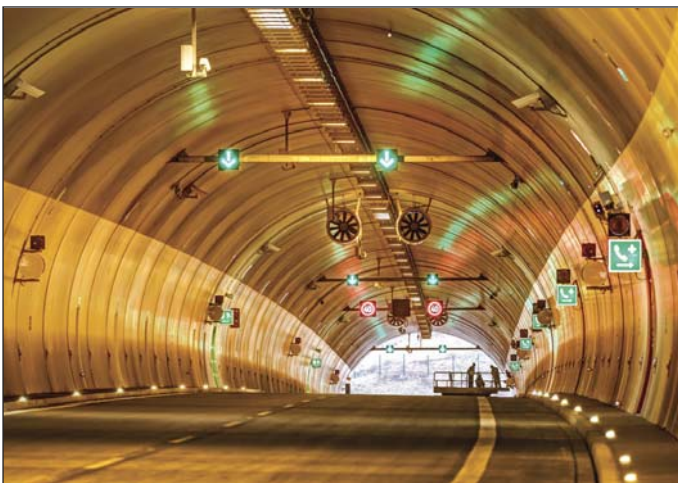
Obr. 3 Dokončený tunel Radejčín Fig. 3 Completed Radejčín tunnel
