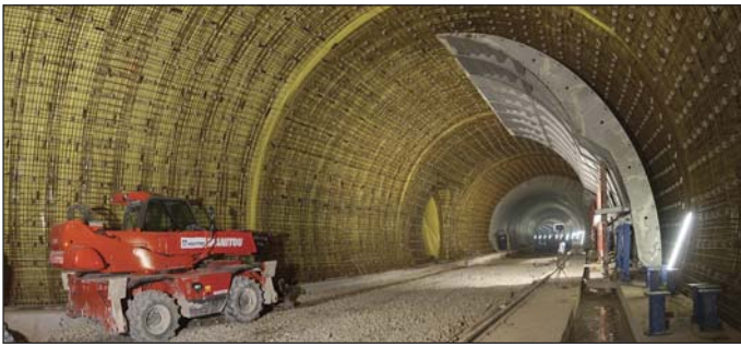
Obr. 13 Samonosná výztuž a bednění nouzového zálivu Fig. 13 Self-supporting reinforcement and formwork of an emergency lay-by
