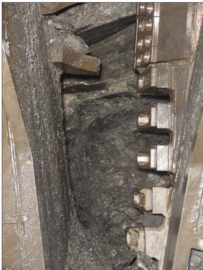
Obr. 2 Tektonicky porušené břidlice s polohami prachovců Fig. 2 Tectonically disturbed shale with siltstone interbeds in a cutterhead window
