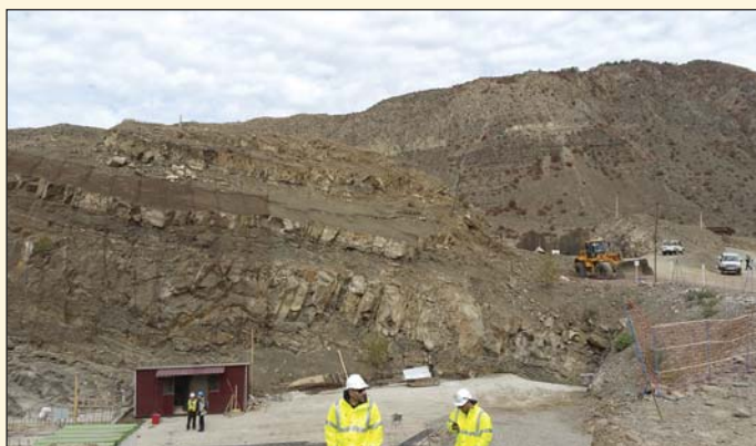
Obr. 2 Dobře patrné struktury horninového masivu v odřezu poblíž portálu tunelu
