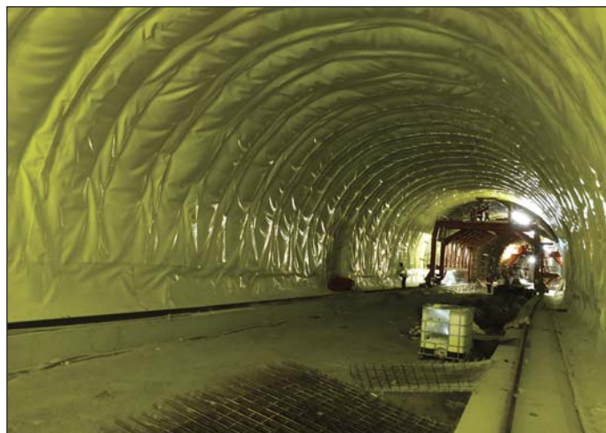
Obr. 4 Hydroizolácie hornej klenby Fig. 4 Waterproofing of the upper vault
