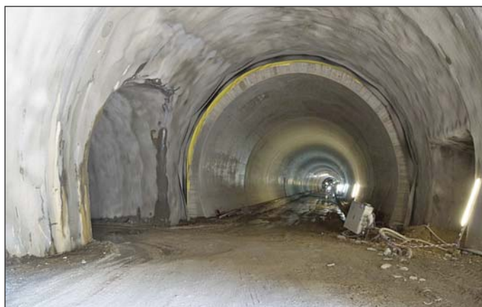
Obr. 8 Falešné primární ostění v místě napojení tunelové propojky Fig. 8 False primary lining in the location of the connection of the tunnel cross passage
