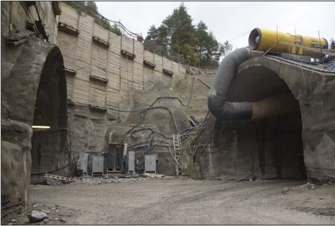
Obr. 3 Vzdálenost portálů severní trouby ve střední stavební jámě Fig. 3 The distance between portals in the mid-point construction pit
