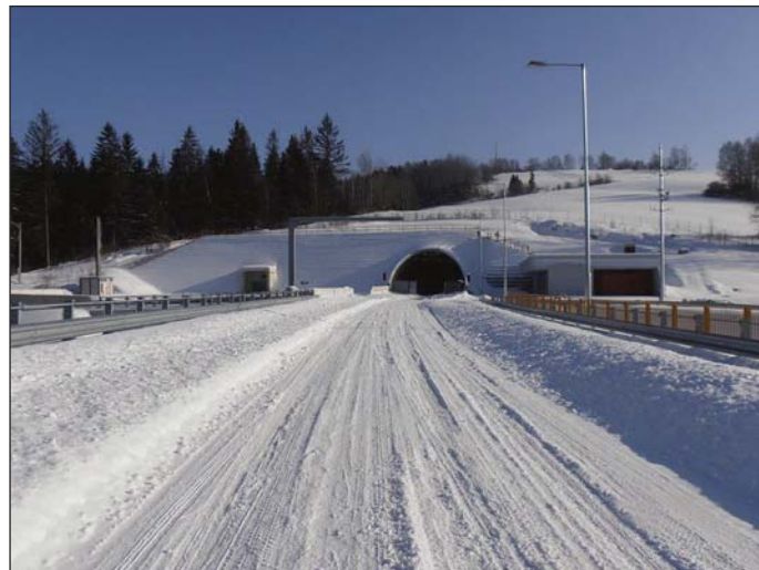
Obr. 2 Tunel Poľana – pohľad na západný portál Fig. 2 Poľana tunnel – a view of the western portal
