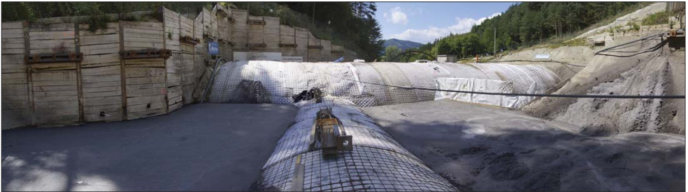
Obr. 12 Zaplavení falešného ostění pod vrchol klenby tunelové propojky Fig. 12 Flooding the false lining under the top of the tunnel cross passage vault
