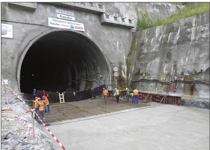
Obr. 3 Betonáž hĺbenej časti spodnej klenby (južná tunelová rúra) Fig. 3 Casting of the cut-and-cover part of the concrete invert (southern tunnel tube)
