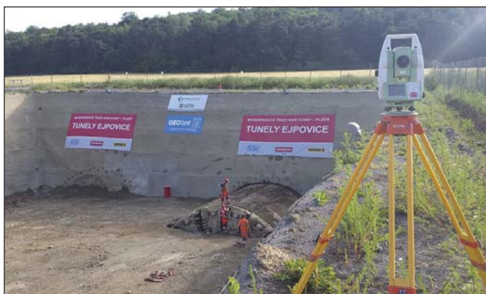
Obr. 1 Totální stanice Fig. 1 Total station
