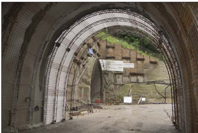
Obr. 6 První nástřik betonu falešného primárního ostění Fig. 6 Application of the initial shotcrete layer of the false primary lining
