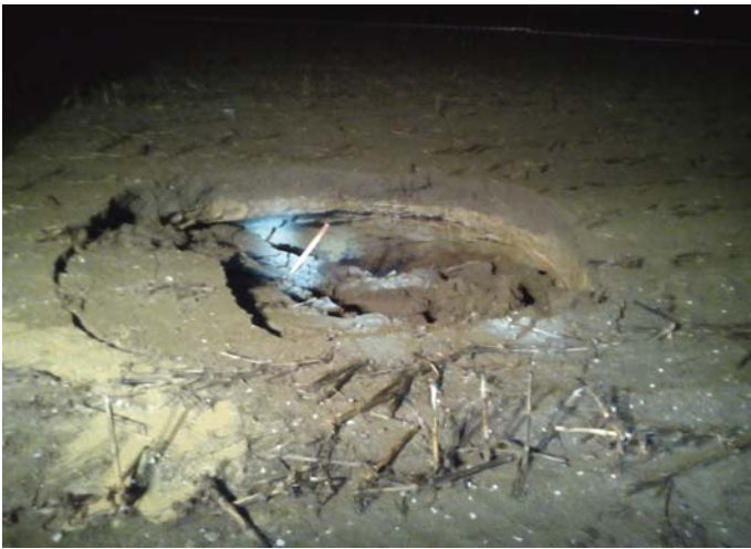
Obr. 15 Místo označeného rozvolnění podloží (nahnutý kolík) na základě geofyzikálního ověření a následný propad před provedením plánované sanace (průměr propadu cca 3 m)
