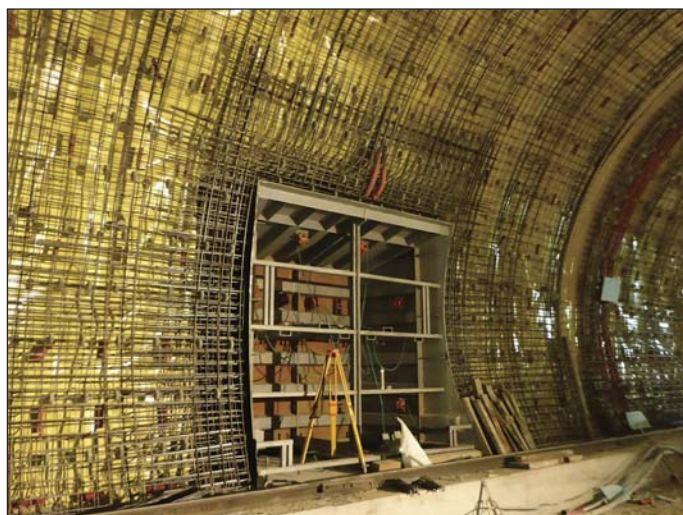
Obr. 6 SOS výklenok Fig. 6 SOS niche
