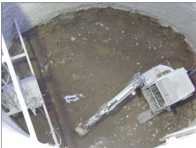
Obr. 3 Hloubení šachty ve štěrčích údolní terasy Vltavy Fig. 3 Sinking the shaft through gravel of the Vltava River flood-plain terrace
