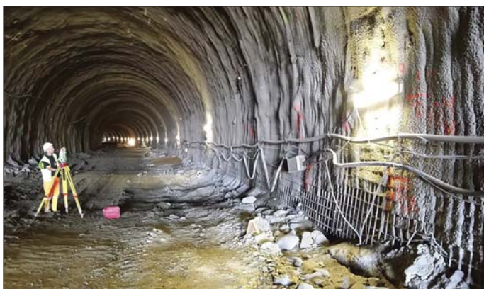
Obr. 8 Příprava usměrňovacího měření – tunel Považský Chlmec Fig. 8 Preparation of orientation measurements – Považský Chlmec tunnel
