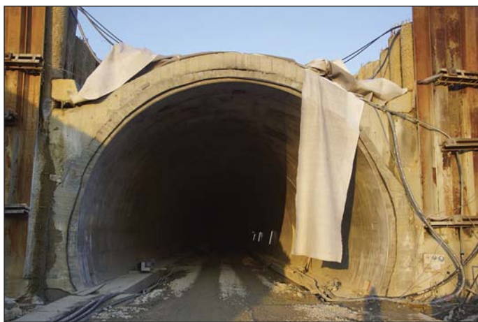
Obr. 2 Sekundární ostění tunelu raženého pod želvou Fig. 2 Secondary lining of the tunnel excavated under the tortoise shell
