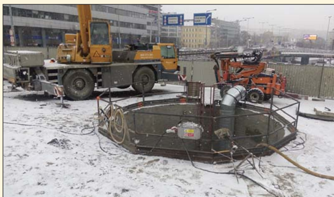
Obr. 2 Vstupní šachta J101 na Těšnově Fig. 2 The entrance shaft J101 in the area of Těšnov
