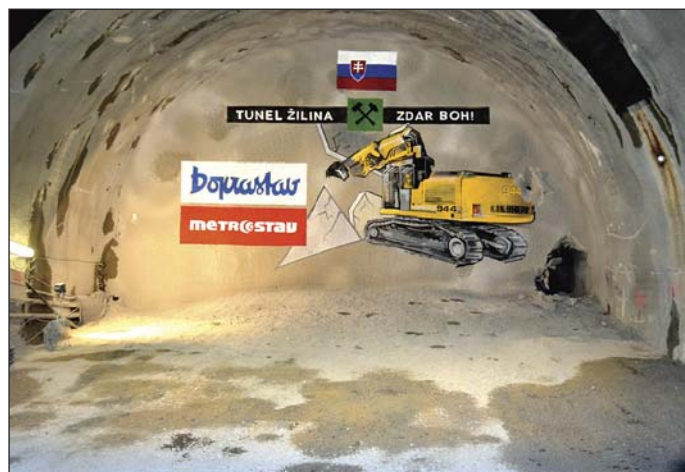
Obr. 4 Tunel Žilina – slávnostná prerážka južnej tunelovej rúry dňa 5. 12. 2016
