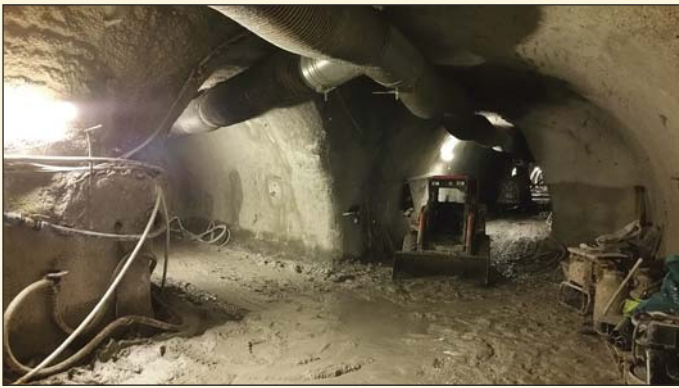
Obr. 1 Průzkumná štola pro Radlickou radiálu Fig. 1 Exploratory gallery for Radlice radial road
