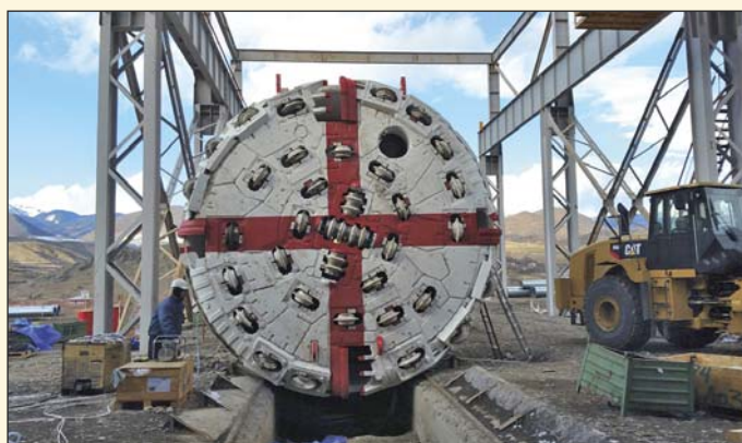
Obr. 1 Řezná hlava stroje TBM double shield hard rock před portálem Fig. 1 Cutterhead of the double shield hard rock TBM in front of portal
