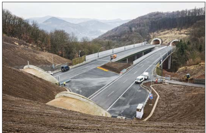
Obr. 4 Pohled na portály tunelů Prackovice a Radejčín propojené mostem Fig. 4 Views of the Prackovice and Radejčín tunnel portals interconnected by the bridge
