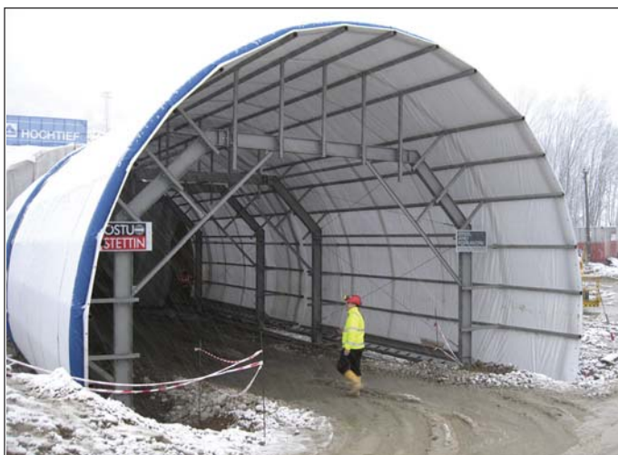
Obr. 14 Ošetřovací vůz pro snížení teplotního šoku Fig. 14 Concrete curing travelling scaffold for reducing the thermal shock
