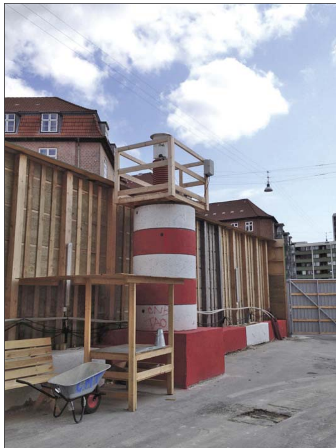
Obr. 4 Totální stanice na měřickém pilíři uvnitř staveniště Fig. 4 A total station on the measuring pillar inside a building site
