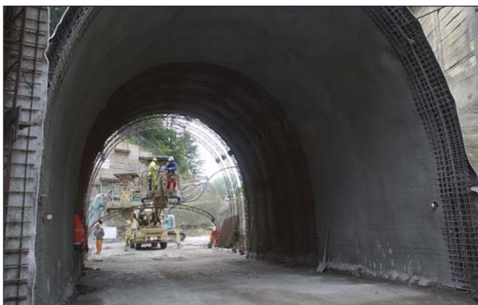
Obr. 7 Líc falešného primárního ostění po dostřikání betonu Fig. 7 Internal surface of the false primary lining after completion of spraying concrete
