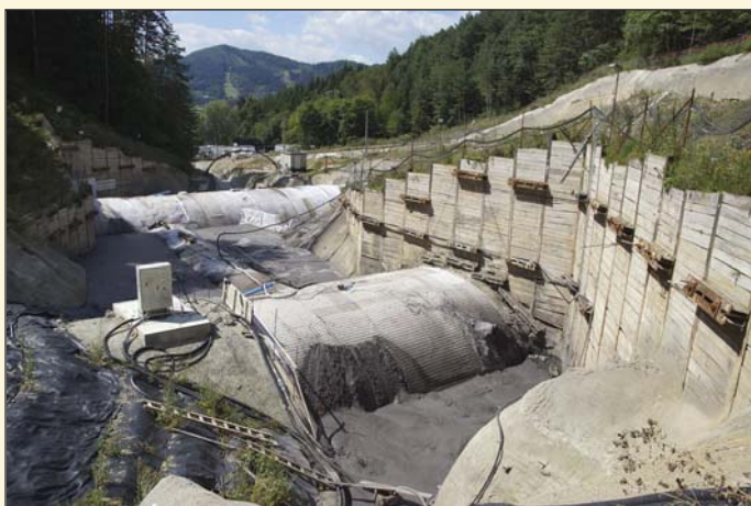
Obr. 1 Tunel Považský Chlmec, zaplavovanie strednej stavebnej jamy popolčekom
