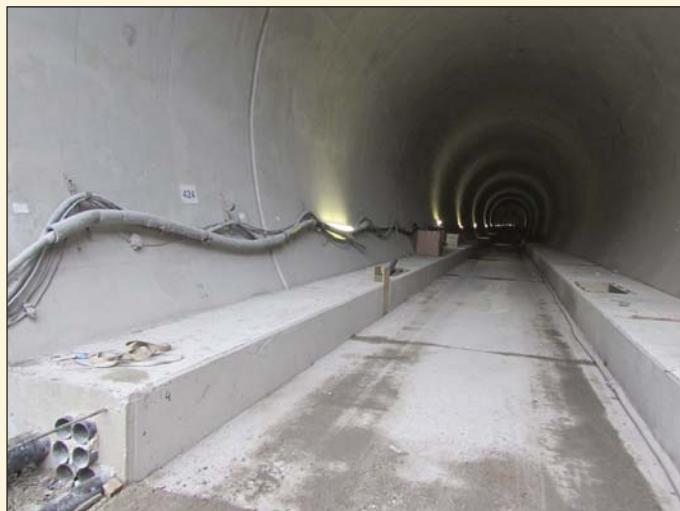
Obr. 4 Definitivní obehádka v tunelu AKWT – pohled z portálu v Cochemu Fig. 4 Final lining in the AKWT tunnel – a view from the portal in Cochem
