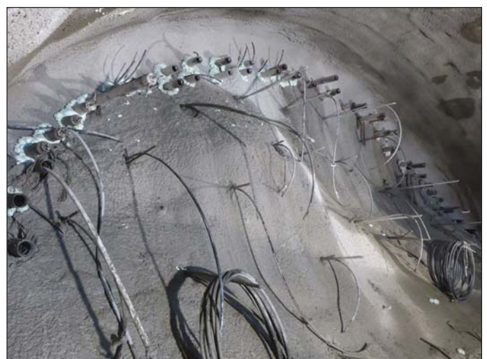
Obr. 7 Pohľad na zaistenú čelbu, sklolaminátové svorníky čelby, dvojradový mikropilotový dáždnik
