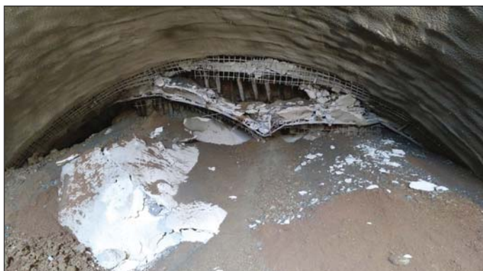
Obr. 5 Vytlačenie horninového materiálu do tunelovej rúry s deformáciou rúr mikropilótového dáždnika a priehradových nosníkov Fig. 5 Ground material extrusion into the tunnel tube; deformation of canopy tubes and lattice girders
