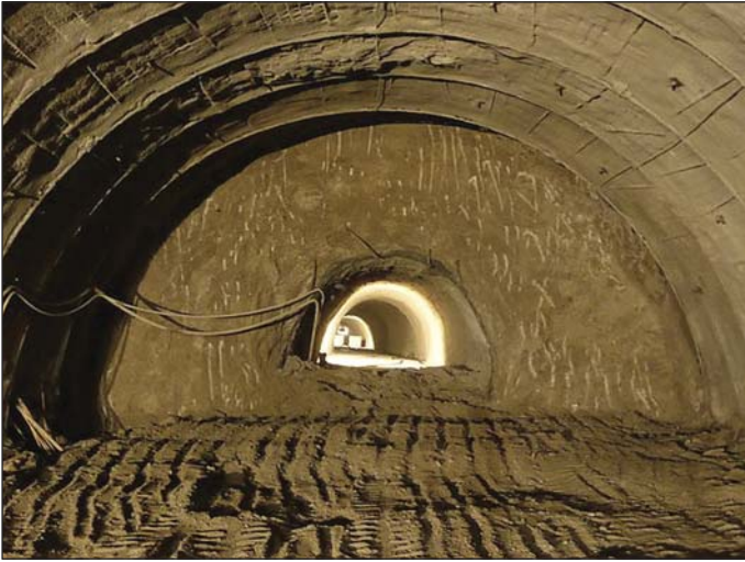
Obr. 2 Charakteristická čelba súľovských zlepcov, kde sa realizovali najdlhšie zábery v kalote Fig. 2 Characteristic excavation face in Súľov conglomerates, where the longest excavation advance rounds were realised at the top heading
