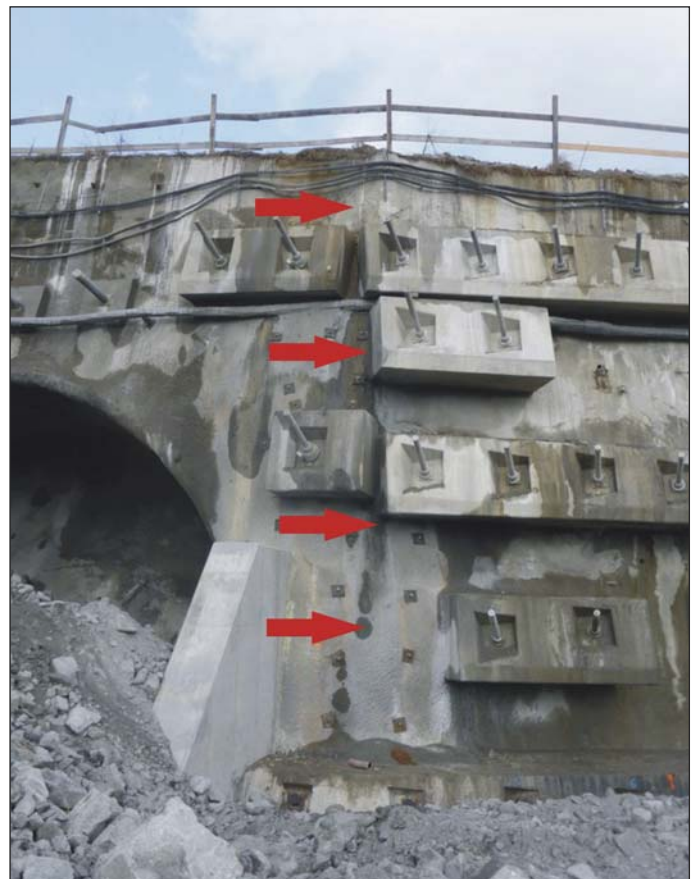
Obr. 3 Miesto porušenia portálovej steny (šípky ukazujú na miesto praskliny) Fig. 3 Portal wall break location (arrows indicate the crack location)
