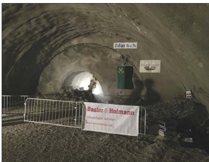
Obr. 1 Prerážka severnej tunelovej rúry Fig. 1 Northern tunnel tube breakthrough
