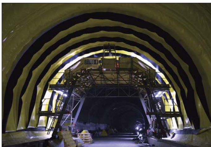
Obr. 2 Hydroizolácie tunela Poľana Fig. 2 Poľana tunnel waterproofing
