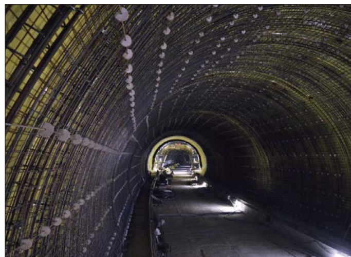
Obr. 3 Výstuž sekundárneho ostenia pravej tunelovej rúry Fig. 3 RTT secondary lining reinforcement
