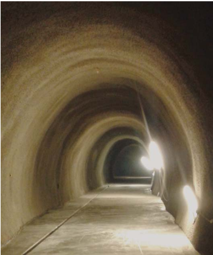
Obr. 5 Definitívne ostenie zo striekaného betónu – úniková štôľňa Fig. 5 Shotcrete final lining – escape gallery
