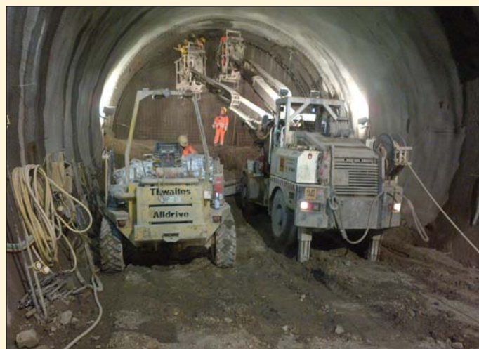
Obr. 5 Ražba kaloty v těsném následování s uzavřením celého profilu Fig. 5 Top heading excavation followed by tight closed invert
