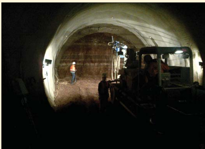
Obr. 4 Ražba kaloty s viditelným směrem proložených anhydridových vrstev Fig. 4 Top heading excavation with interlayered anhydride stratum
