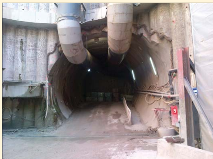
Obr. 3 Přístupový tunel z hlavní těžní šachty Fig. 3 Access tunnel from the main excavation shaft
