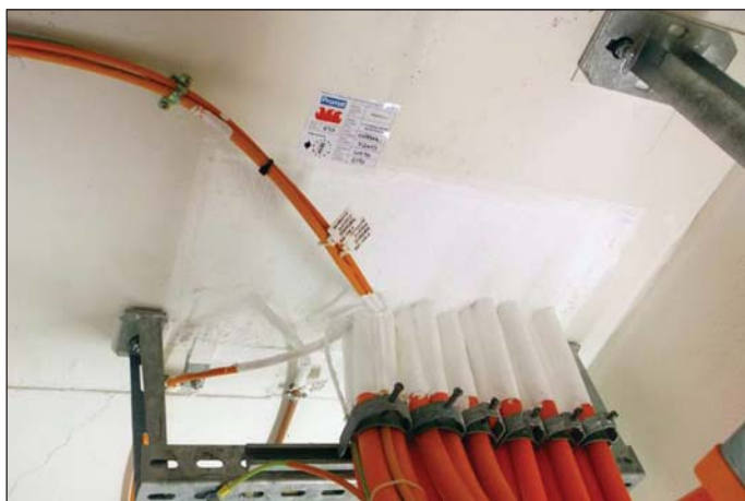
Obr. 4 Požární těsnění prostupů kabelů Fig. 4 Fire-stop sealing of openings for cables
