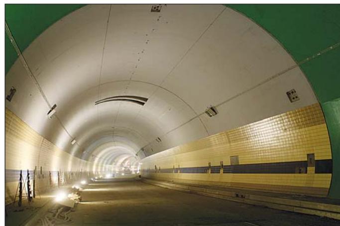
Obr. 3 Nasávací štěrba Fig. 3 Suction slot
