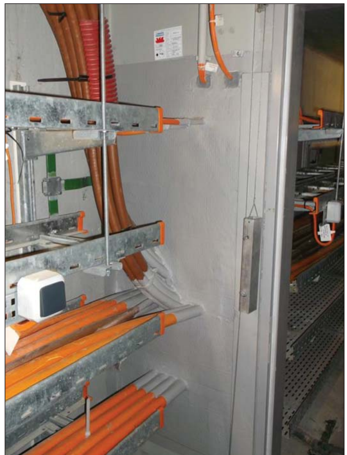
Obr. 5 Požární těsnění prostupů kabelů Fig. 5 Fire-stop sealing of openings for cables
