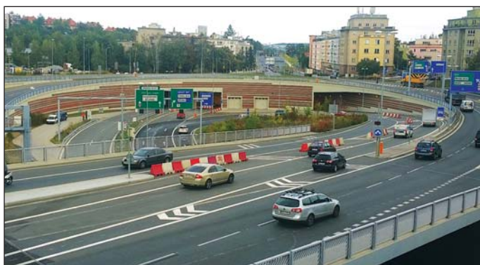
Obr. 1 Otevřený tunelový komplex Blanka Fig. 1 Commissioned Blanka complex of tunnels
