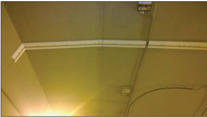
Obr. 6 Spára s požární odolností v klenbě tunelu pod garážemi Prašný most Fig. 6 Fire resistant joint at the tunnel crown under Prašný Most Bridge garages
