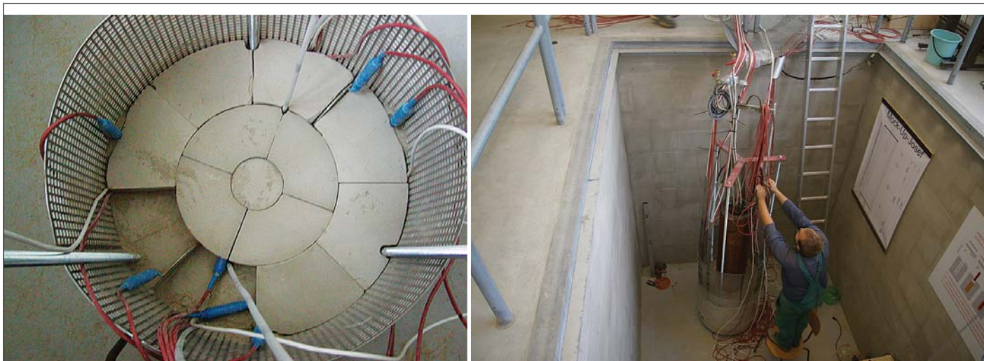
Obr. 4 Foto z výstavby modelu (vlevo pohled na stavěnou geotechnickou bariéru v perforovaném plášti, vpravo foto z výstavby modelu v experimentálním silu v laboratoři, ve které byl model vystavěn) Fig. 4 Photo from the model construction phase (a view of the geotechnical barrier under construction in the perforated shell on the left side; photo from the construction of the model in the experimental silo in the laboratory in which the model was constructed)
