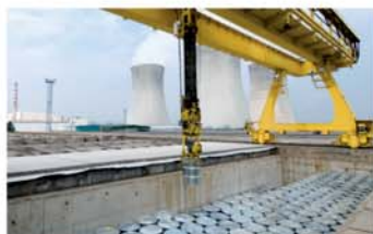
Nízko a středněaktivní odpady vznikající při provozu z obou jaderných elektráren se ukládají přímo v areálu dukovanské elektrárny.
