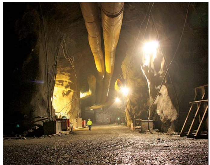
Obr. 4 Pohľad do spojovacieho tunela
