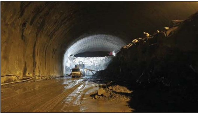
Obr. 5 Razenie stupňa v najširšej časti stanice kde výška dosahuje 18 m Fig. 5 Bench excavation in the widest part of the station, where the height reaches 18m
