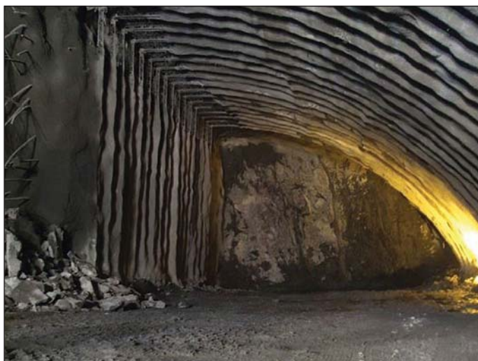
Obr. 8 Prvá fáza budovania priehradových nosníkov Fig. 8 The first phase of the installation of lattice girders
