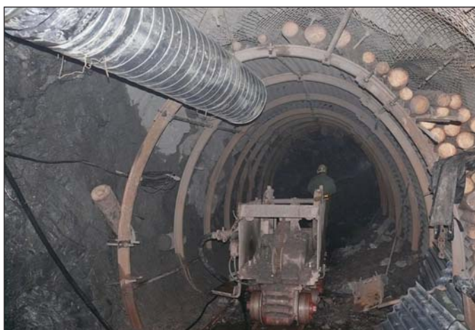
Obr. 4 Překop BZ-XIII, přechod ze svorníkové výztuže na TH výztuž v procesu odtěžování horniny
