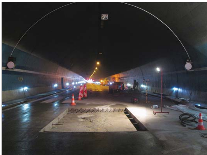
Obr. 9 Příprava na betonáž desky vozovky ve středním jízdním pruhu Fig. 9 Preparation for casting of concrete roadway slab in the central traffic lane
