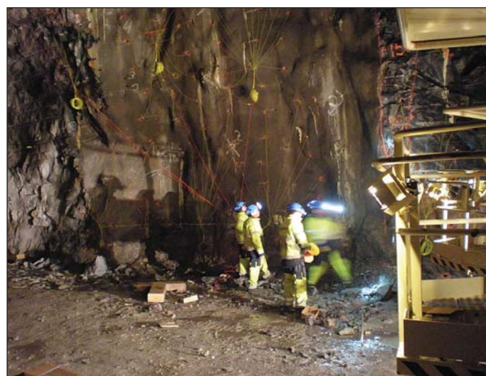
Obr. 4 Trhacie práce – čelba pred odpalom Fig. 4 Blasting operations – excavation face before firing
