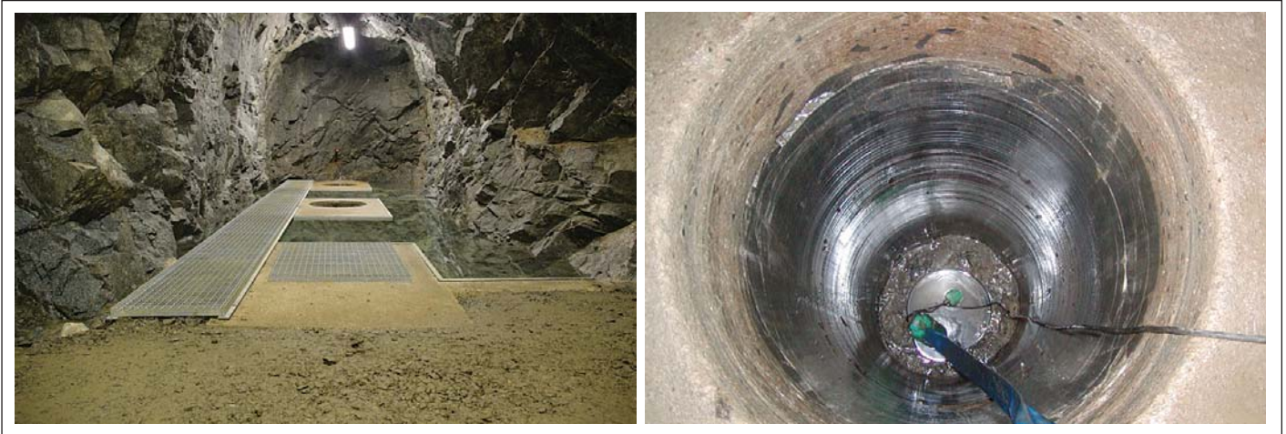
Obr. 1 Vlevo rozrážka s odvrtanými studnami a vpravo pohled do jedné z velkoprofilových studen Fig. 1 Gallery stub with the bored wells on the left side, a view down one of the large-profile wells on the right side
