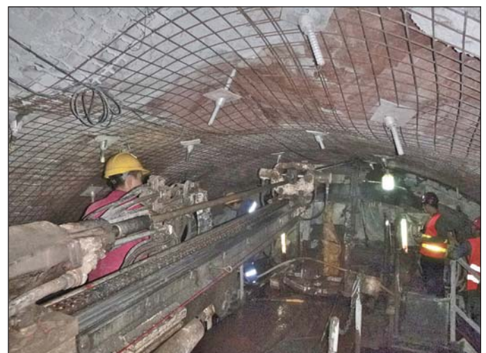
Obr. 4 Vrtná soustrojí pro zhotovení vrtů před čelbou TBM vně obrysu Fig. 4 Drilling equipment for probing ahead of TBM
