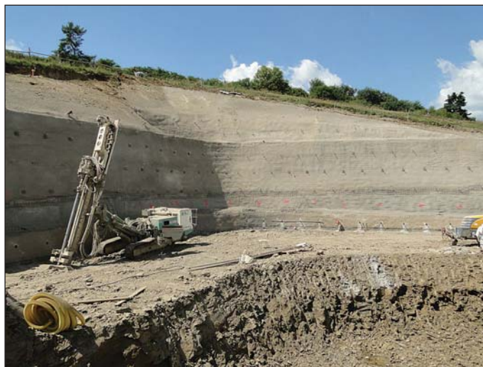
Obr. 2 Prípravné práce na východnom portáli 2. 8. 2013
