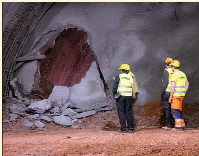
Obr. 1 Prorážka v kalotě pravého tunelu Bancarevo Fig. 1 Breakthrough of the right Bancarevo tunnel tube
