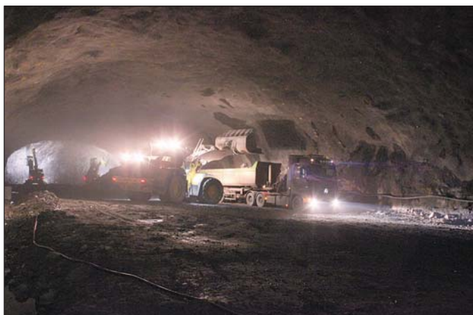
Obr. 5 Nakladanie a odťahba, v pozadí strojná profilácia čelby Fig. 5 Loading and mucking out; mechanical profiling in the background
