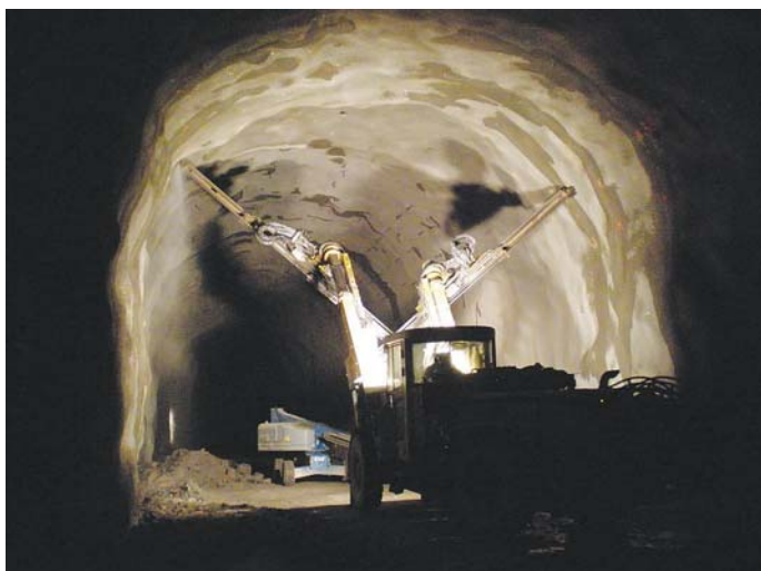
Obr. 5 Vrtanie vývrtov pre definitívne svorníky pomocou vrtacieho voza Atlas Copco E2C Fig. 5 Drilling of holes for definite rockbolts using Atlas Copco E2C drill rig
