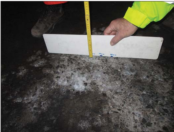
Obr. 5 Měření hloubky poškození vozovky Fig. 5 Measurement of the depth of the damage to roadway
