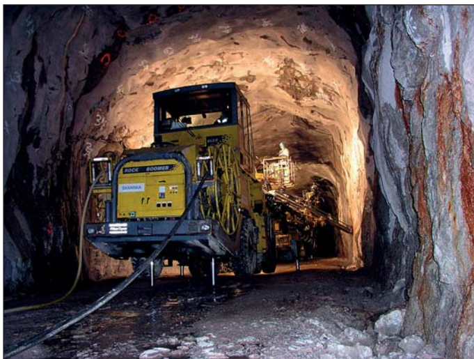
Obr. 3 Vrtanie injektážnych vývrtov pre systematickú injektáž pomocou vrtačiacich vozov Atlas Copco XL3C a L2C Fig. 3 Drilling of grouting holes for systematic grouting using Atlas Copco XL3C and L2C drill rigs
