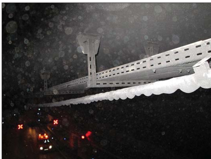
Obr. 8 Poškozený vyzářovací kabel pro rádiovou komunikaci v tunelu Fig. 8 Damaged radiating cable for radio communication inside the tunnel
