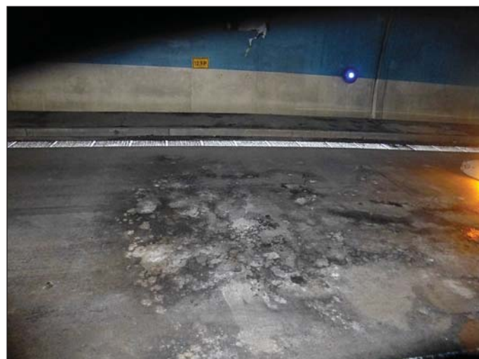
Obr. 4 Poškození vozovky v místě požáru Fig. 4 Damage to roadway surface in the fire location
