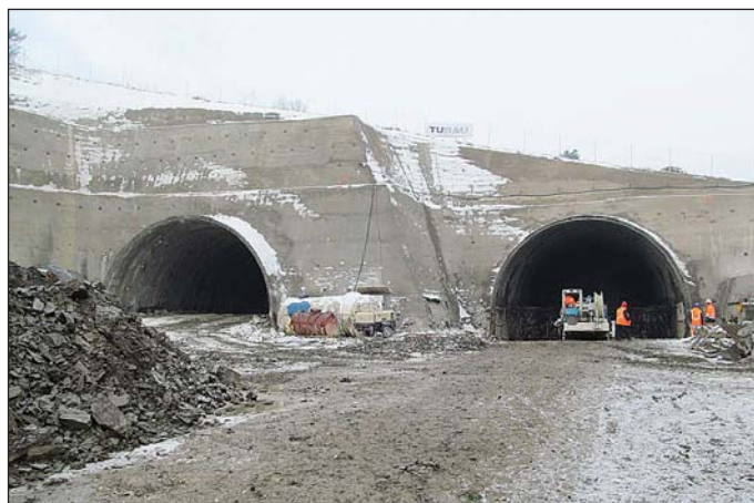
Obr. 4 Ukončenie razenia zo strany východného portálu 20. 12. 2013
