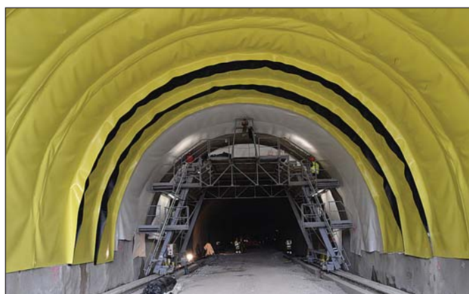
Obr. 6 Izolovanie prvého záberu v severnej tunelovej rúre 8. 4. 2014
