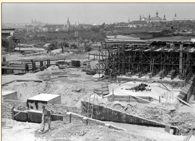
Obr. 4 Stavba stanice Vyšehrad Fig. 4 Construction of Vyšehrad station
