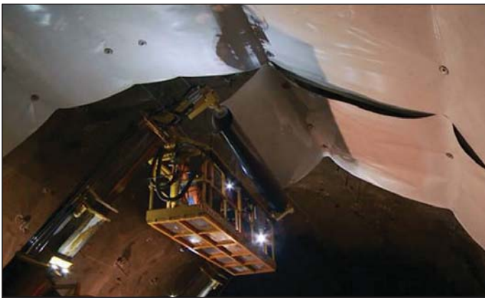
Obr. 11 Montáž hydroizolačnej membrány Fig. 11 Installation of the waterproofing membrane
