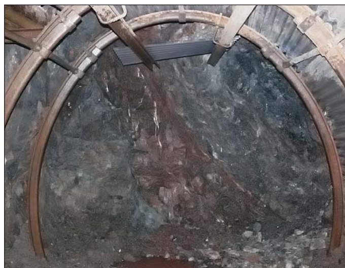
Obr. 3 Překop BZ-XIIJ, provizorní ochrana stropu Fig. 3 Cross gallery BZ-XIIJ, securing excavation with advance support
