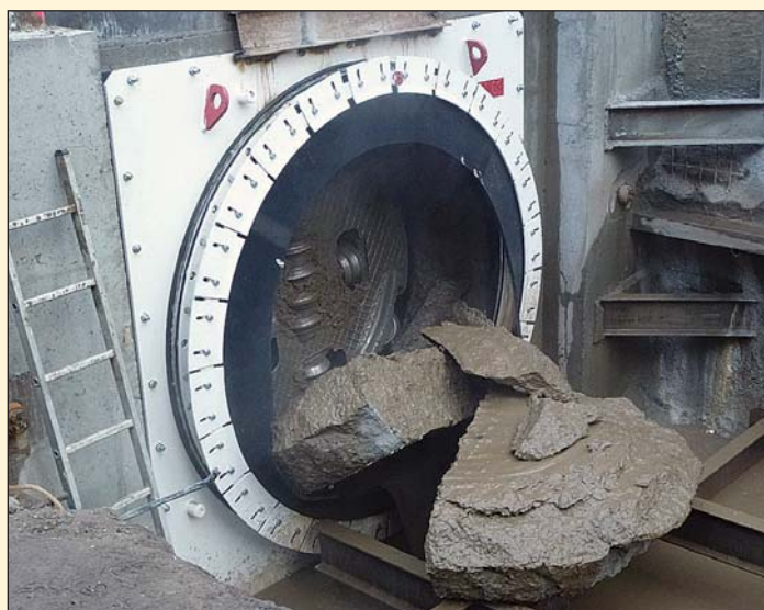
Obr. Prorážka bentonitovým štítem Fig. Breakthrough using the slurry shield
