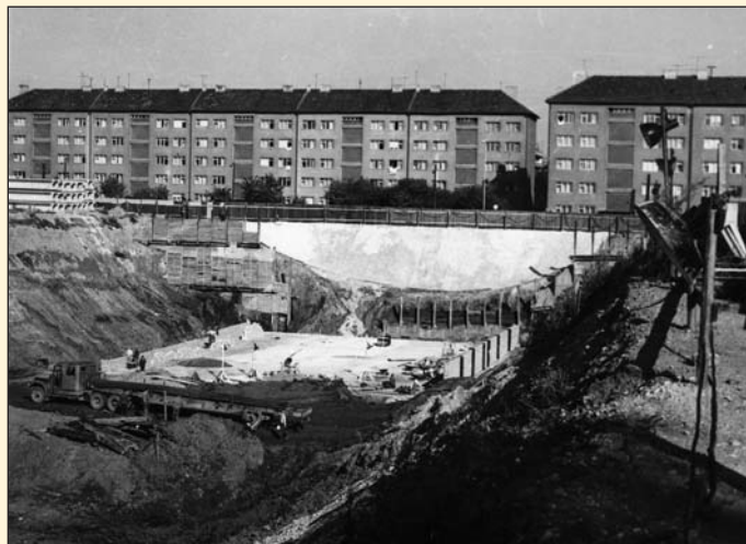
Obr. 5 Výstavba stanice Budějovická Fig. 5 Construction of Budějovická station
