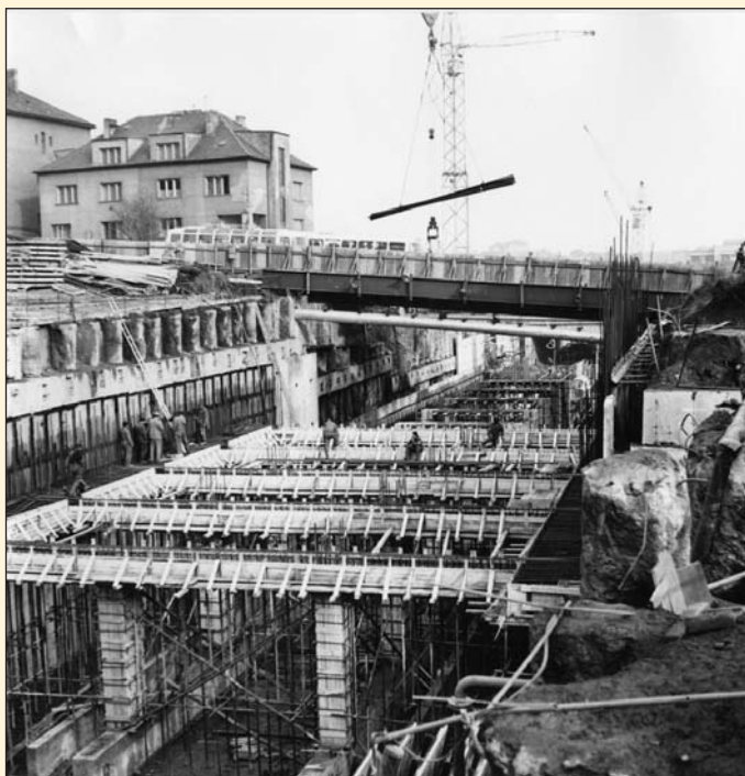
Obr. 6 Stavba stanice Kačerov Fig. 6 Construction of Kačerov station
