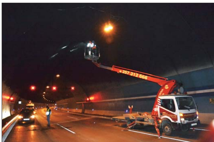
Obr. 6 Prohlídka klenby tunelu, ocelových konstrukcí a zařízení v klenbě Fig. 6 Examination of tunnel vault, steel structures and equipment under the crown
