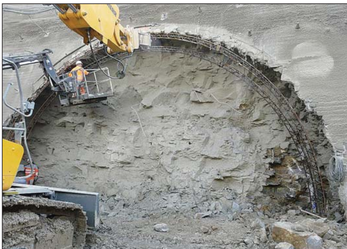
Obr. 1 Prvý záber na západnom portáli – južná tunelová rúra – začiatok razenia tunela Šibenik 29.6.2013
