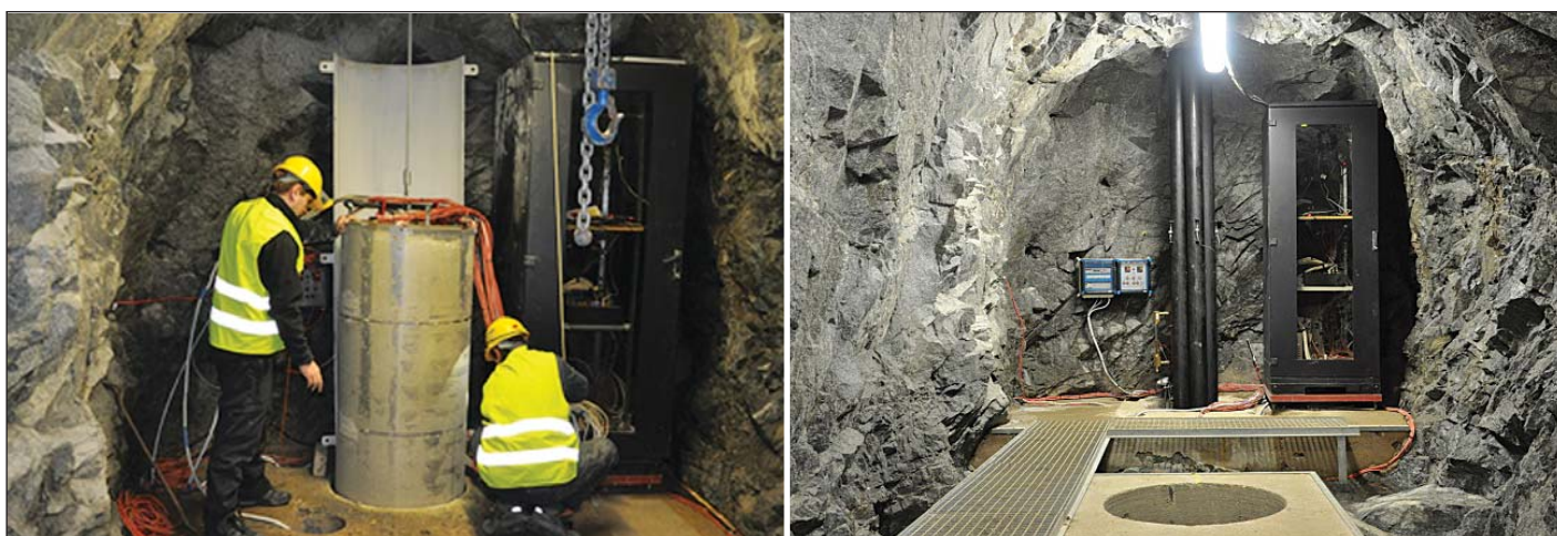
Obr. 6 Spuštění modelu do úložné studny vlevo a pohled do rozrážky s instalovaným modelem a s rozpěrnými trubkami Fig. 6 Lowering the model down the disposal well on the left side; a view down the gallery stub with the model installed in it and the bracing tubes
