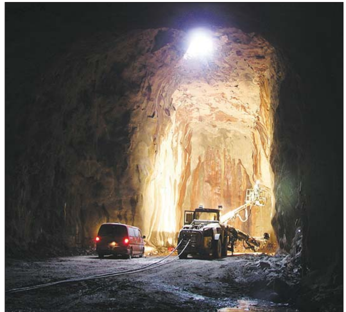
Obr. 7 Pohľad do výťahovej šachty na budovaný výklenok Fig. 7 A recess under construction viewed to the lift shaft
