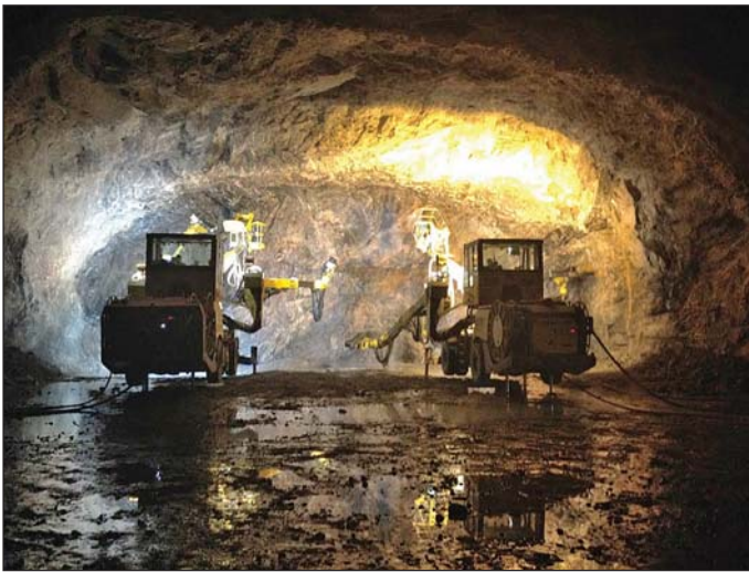
Obr. 11 Vrtanie čelby na odstrel, vrtacie vozy AC XE3 Fig. 11 Drilling for the face blasting, AC XE3 drill rigs
