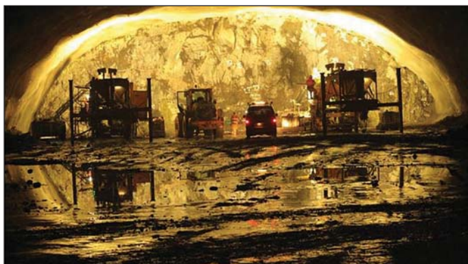
Obr. 4 Kalota v najširšom profile počas injektáže Fig. 4 Top heading in the widest profile during the injection of grout
