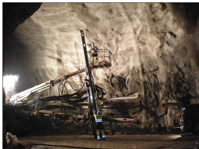
Obr. 6a Osadenie definitívnych svorníkov Fig. 6a Installation of definite rockbolts
