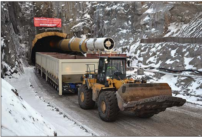
Obr. 10 Dopravník rubaniny na kolovém podvozku Goldhofer tažený kolovým nakladačem
