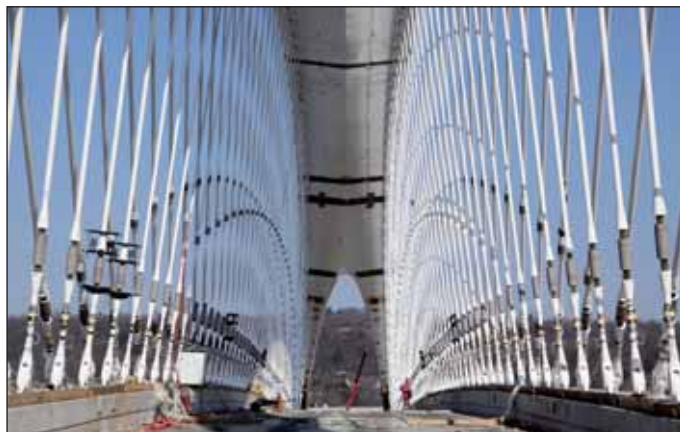
Obr. 6 Oblouk nového mostu přes Vltavu v Troji a „výplet“ tyčových závěsů (foto: Jakub Karlíček)
