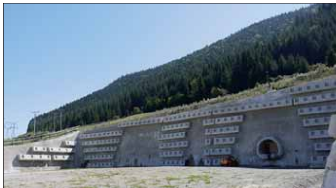
Obr. 7 Západný portál pre razienu tunela Višňové, archív Terraprojekt Fig. 7 Western portal for the Višňové tunnel excavation, Terraprojekt archives
