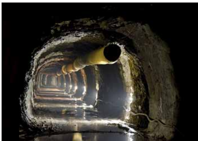
Obr. 3 Ražený traťový tunel Fig. 3 Mined running tunnel
