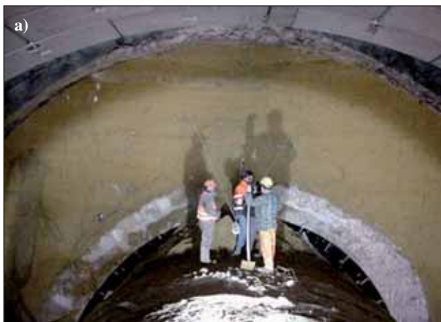
Obr. 3 GROUTMASTER SR10 Aplikácia: a) radiálna; b) vertikálna Fig. 3 GROUTMASTER SR10 Treatment: a) Radial; b) Vertical
