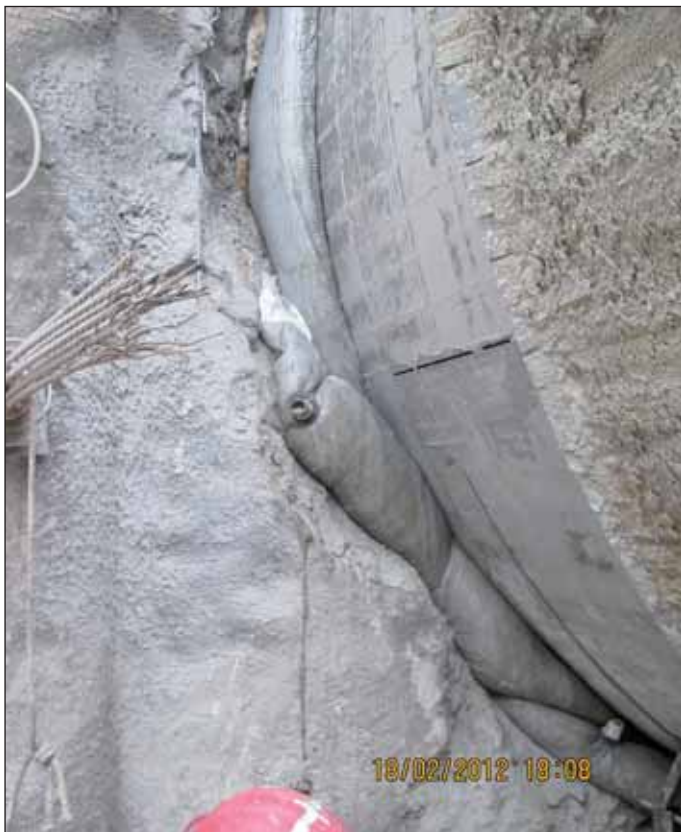
Obr. 7 Čítko z vaku naplněného cementovou směsí Fig. 7 Stop end formed by a bag filled with cement mixture
