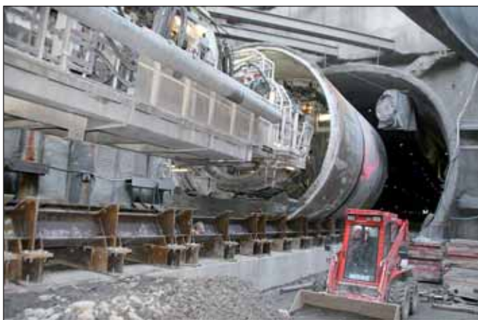
Obr. 6 Stroj S-609 při přesunu přes hloubenou část na ocelové konstrukci Fig. 6 S-609 machine during the shifting on the steel structure along a cut-and-cover section
