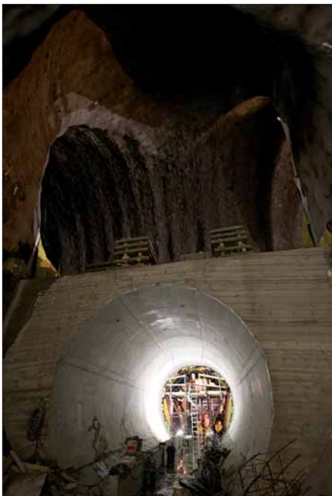
Obr. 16 Pohled do kanálu 04 a severního třípruhového tunelu s dokončeným definitivním ostěním 1. části kanálu
