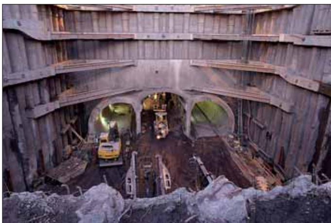
Obr. 13 Stanice Veleslavín, ražba středního tunelu (Metroprojekt) Fig. 13 Veleslavín Station, excavation of middle tunnel (Metroprojekt)
