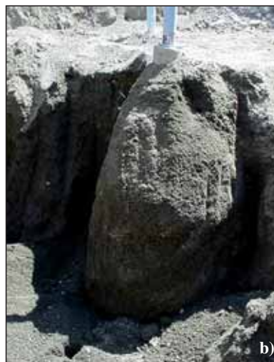
Obr. 3 GROUTMASTER SR10 Aplikácia: a) radiálna; b) vertikálna Fig. 3 GROUTMASTER SR10 Treatment: a) Radial; b) Vertical
