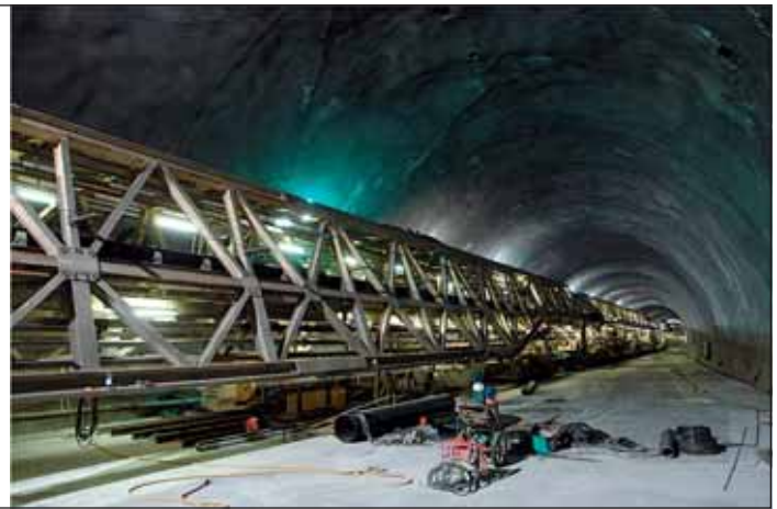
Obr. 12 Konvenční ražba tunelu Sedrun sever (vlevo), instalace závěsu plnoprofilového tunelovacího stroje (vpravo)
