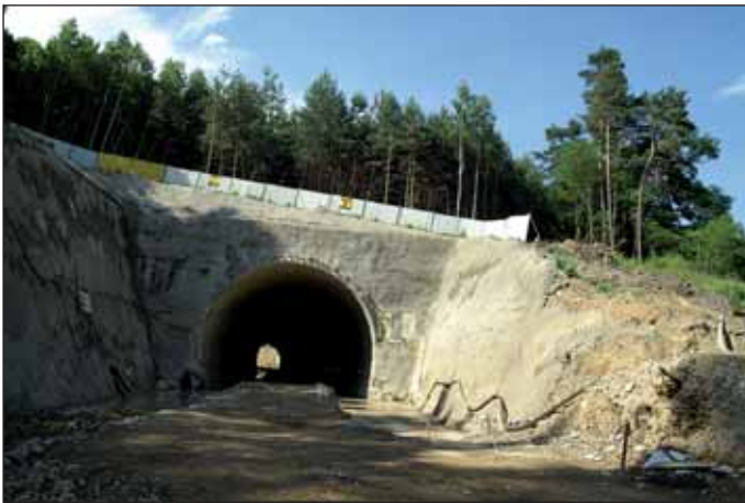
Obr. 20 Tunel Tomický II (v provozu od r. 2011) Fig. 20 Tomice II tunnel (in operation from 2011)
