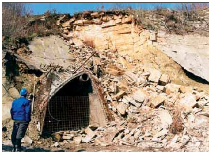
Obr. 2 Tunel Hřebeč (v provozu od r. 1997) Fig. 2 Hřebeč tunnel (in operation from 1997)
