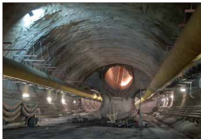
Obr. 10 Červený Vrch – pohled na konec stanice Fig. 10 Červený Vrch – view of the station end
