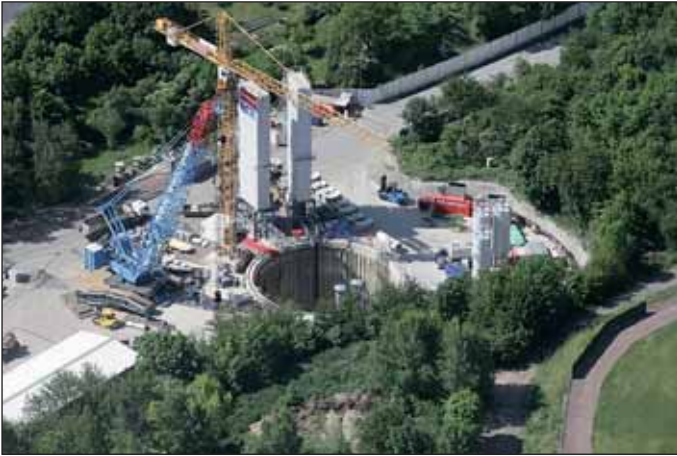
Obr. 11 Pohled na staveniště Vypich (míchací centrum vpravo) Fig. 11 View on the Vypich site (mixing centre on the right)
