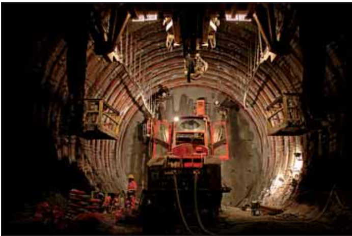
Obr. 12 Konvenční ražba tunelu Sedrun sever (vlevo), instalace závěsu plnoprofilového tunelovacího stroje (vpravo)
