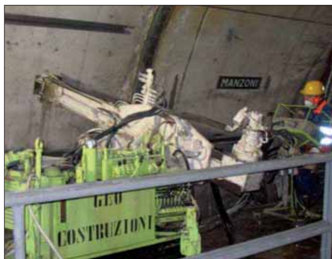
Obr. 9 Injektáž Fig. 9 GROUTMASTER treatment
