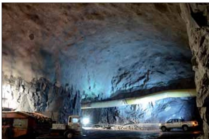
Obr. 4 Větrací šachta s technologickou komorou Fig. 4 Ventilation shaft with a service chamber
