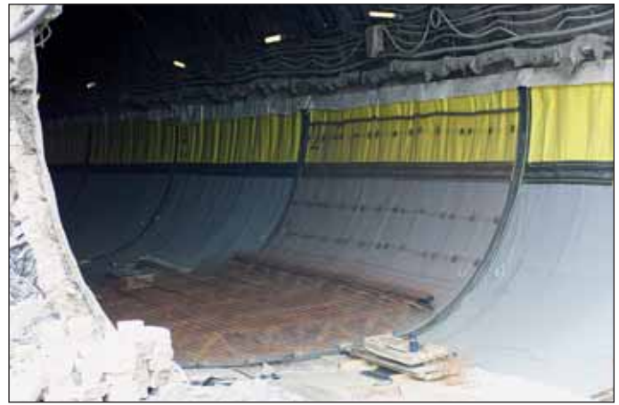
Obr. 6 Armování spodní klenby na ochrannou fólii
