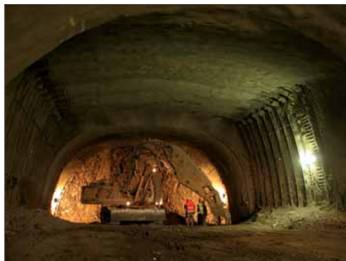
Obr. 14 Tunely Nové spojení (v provozu od r. 2008) Fig. 14 Nové spojení tunel (in operation from 2008)
