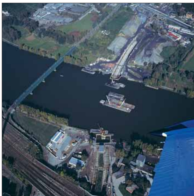
Obr. 6 Pohled na staveniště výsuvu tunelů na trase IV.C Fig. 6 View on the launching site, Line IV.C
