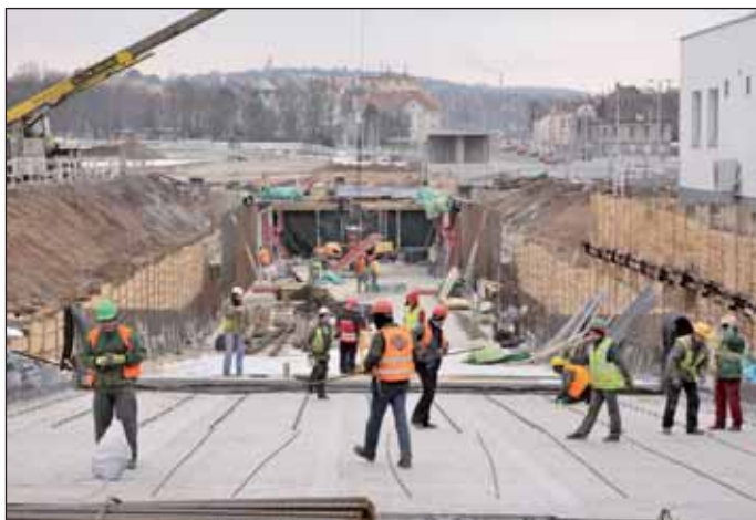
Obr. 3 Výstavba rampy podzemních garáží na Letné (foto: Jakub Karlíček)
