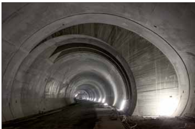
Obr. 3 Definitivní ostění čela nouzového zálivu Fig. 3 Final lining of the lay-by front wall
