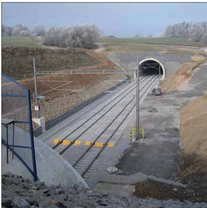
Obr. 21 Tunel Olbramovický (v provozu od r. 2011) Fig. 21 Olbramovice tunnel (in operation from 2011)
