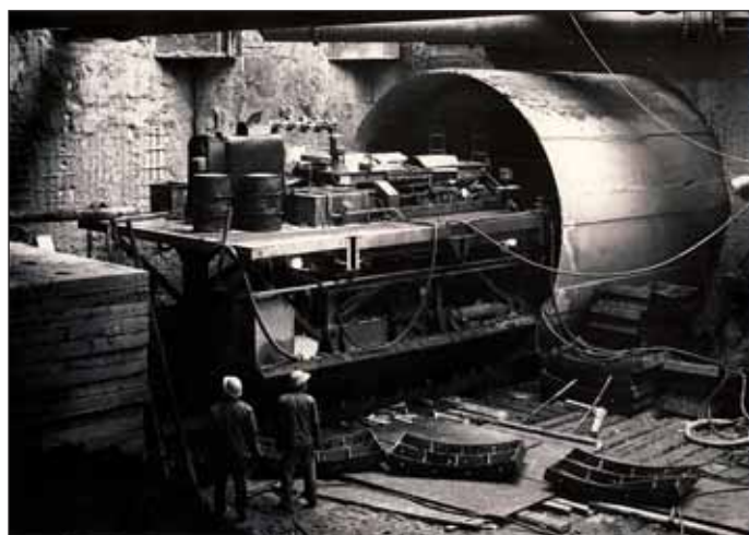
Obr. 2 Ražba prvního tunelu na trase Metra C na Pankráci Fig. 2 First bored tunnel on Metro Line C with open shield, Štětškova street site
