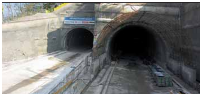
Obr. 15 Tunely Nové spojení (v provozu od r. 2008) Fig. 15 Nové spojení tunel (in operation from 2008)
