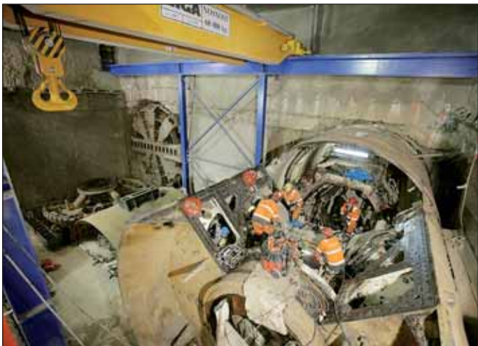
Obr. 1 Demontáž štítu EPB Tonda v demontážní komoře v Dejvicích (foto: Husák)
