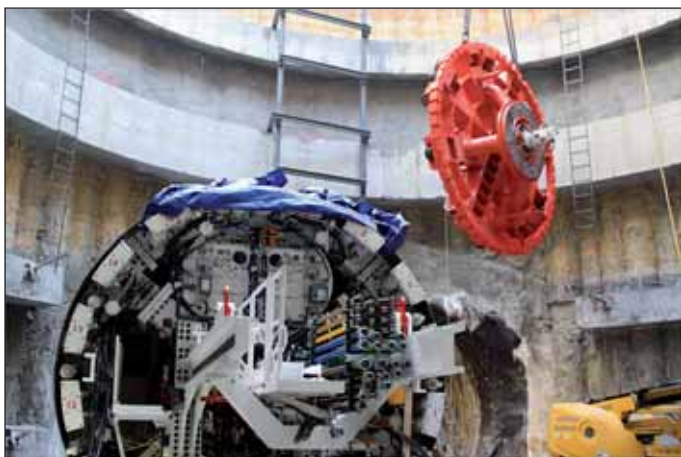
Obr. 1 Spouštění řezné hlavy stroje EPBS S-609 na dno šachty Fig. 1 Lowering of S-609 EPB shield cutter head down to the shaft bottom
