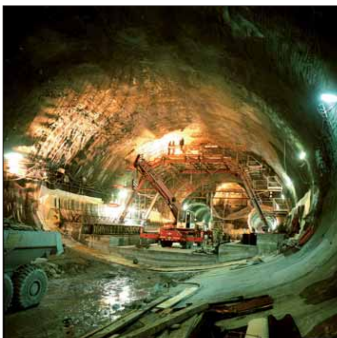
Obr. 5 První ražená jednodlná stanice metra Kobylisy (Husák, J.) Fig. 5 First single vault station Kobylisy (Husák, J.)
