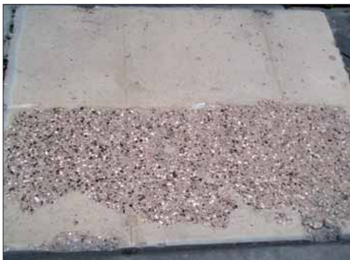
Obr. 12 Vzorek ostění po požární zkoušce (povrch bez odprysků je s PP vlákny) Fig. 12 Sample of lining after the fire test (surface without scales contains PP fibres)
