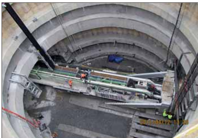
Obr. 2 Stroj EPBS S-609 na dně šachty připravený k ražbám Fig. 2 EPB shield S-609 at the shaft bottom, prepared for launching
