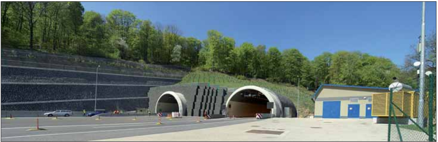
Obr. 10 Tunel Libouchec (v provozu od r. 2006)
