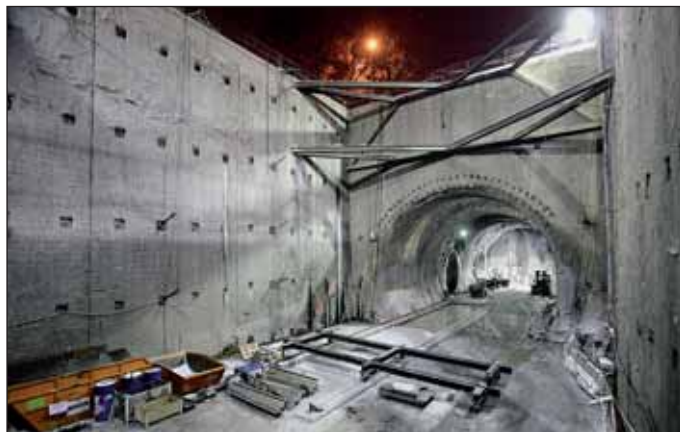
Obr. 6 Stavební jáma E1, v pozadí průnik tratových tunelů (foto: Husák)
