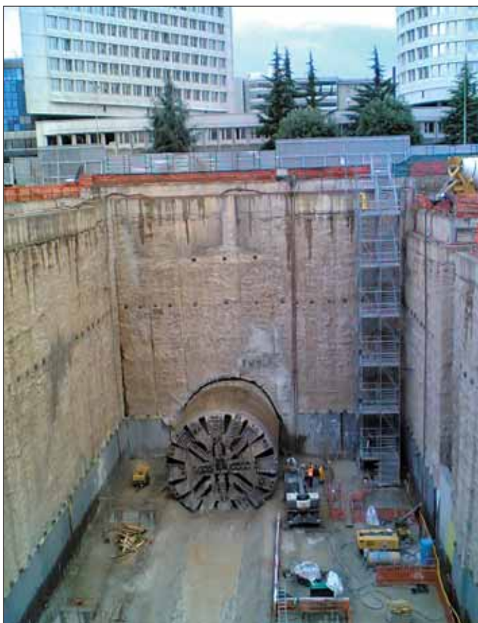
Obr. 5 Prerazenie štítu EPBS Fig. 5 EPBS breakthrough
