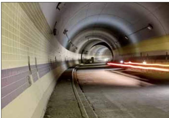
Obr. 5 Ražený dvoupruhový tunel pod Vltavou (foto: Jakub Karlíček)
