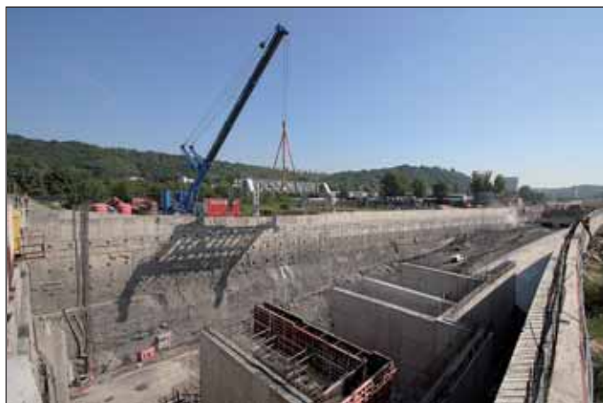
Obr. 13 Montáž formy definitivního ostění v jámě Troja Fig. 13 Assembly of final lining formwork in Troja construction pit
