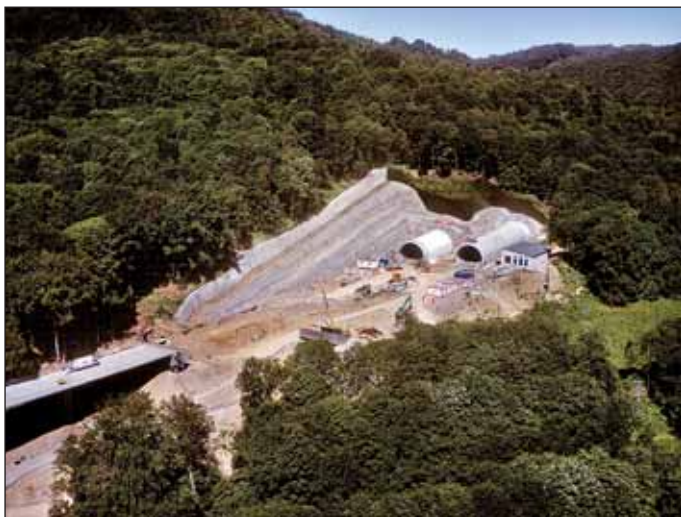
Obr. 9 Tunel Libouchec (v provozu od r. 2006) – foto: Archiv ŘSD Fig. 9 Libouchec tunnel (in operation from 2006) – photo ŘSD archive
