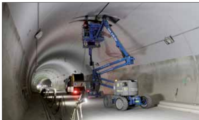
Obr. 4 Realizace kabelových rozvodů pod klenbou raženého dvoupruhového tunelu (foto: Jakub Karlíček)
