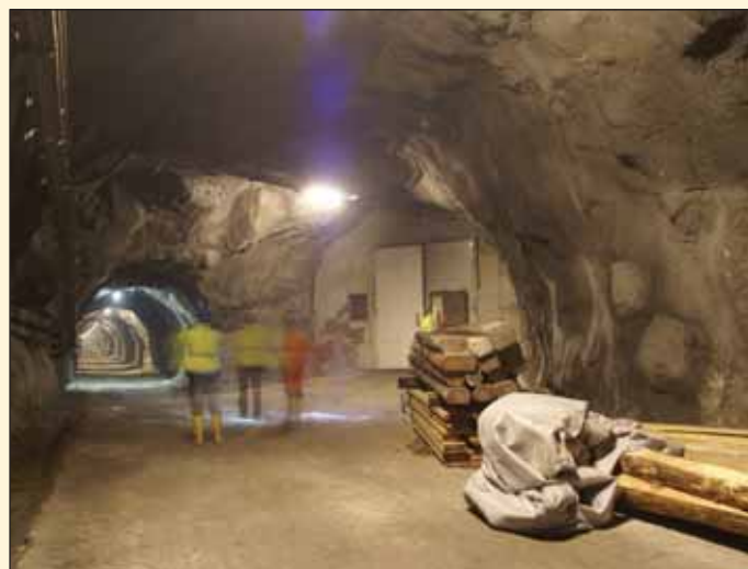
Obr. 8 Větrací a odvodňovací štola ve stříkaném betonu Fig. 8 Ventilation and drainage gallery lined with shotcrete
