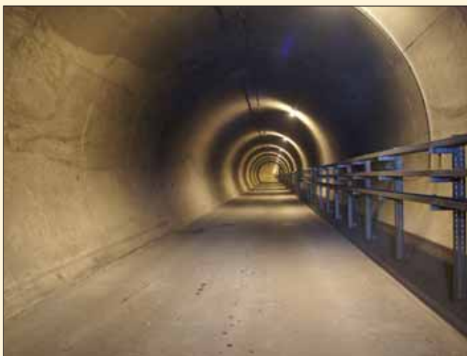
Obr. 7 Větrací a odvodňovací štola s definitivním ostěním Fig. 7 Ventilation and drainage gallery with a final lining
