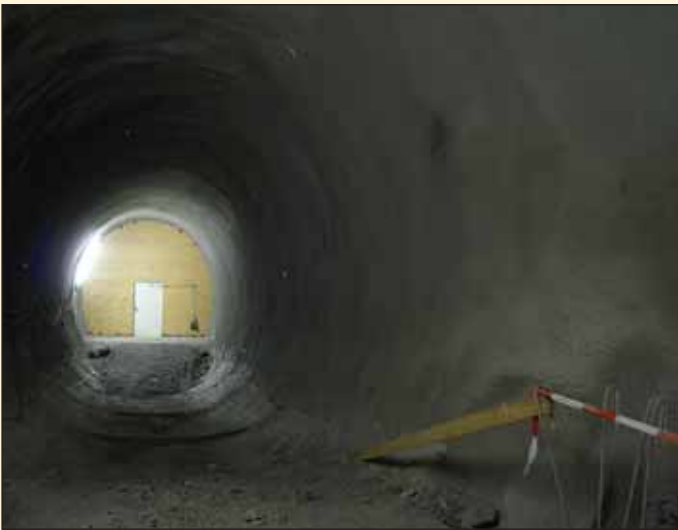
Obr. 5 Primární ostění tunelové propojky Fig. 5 Primary lining of tunnel cross passage
