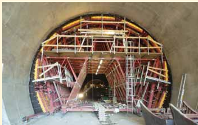
Obr. 5 Tunel Osek – Bednicí vůz a definitivní ostění Fig. 5 Travelling formwork and the final lining
