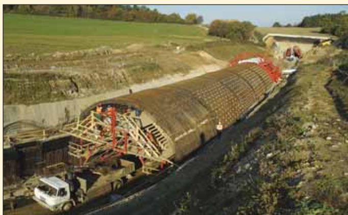
Obr. 3 Samonosná výztuž hloubeného Votického tunelu Fig. 3: Self-supporting reinforcement of the Votice cut-and-cover tunnel structure
