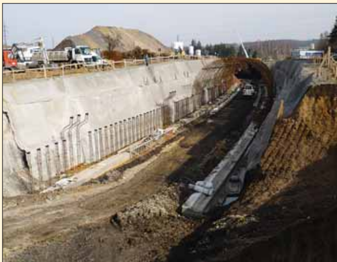
Obr. 4 Tunel Osek – stavební jáma a montáž výztuže falešného primárneho ostění Fig. 4 Construction trench and installation of reinforcement of the false primary lining
