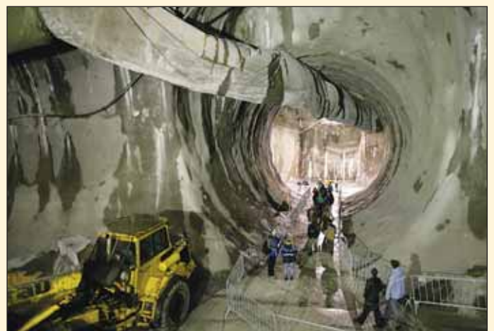
Obr. 2 Tunel Blanka – Den otevřených dveří: Pohled z STT přes propojku č.13 do JTT Fig. 2 Community open day: A view from the NTT, through cross passage No. 13, into the STT
