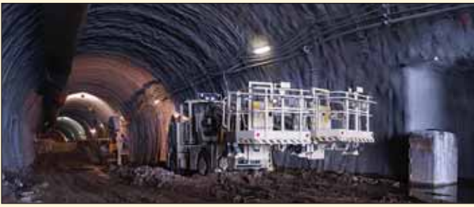
Obr. 7 Horizontální členění výrubu a rampa do kaloty Fig. 7 Horizontal excavation sequence and the ramp to the top heading
