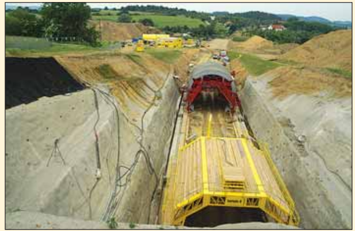
Obr. 9 Sestava pro izolování a betonáž ostění – nová etapa v životě tunelu Fig. 9 Gantry-type scaffold to install the waterproofing and a tunnel form traveler – a new stage in the life of the tunnel
