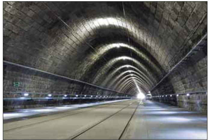
Obr. 8 Interiér tunela po rekonštrukcii Fig. 8 Tunnel interior after reconstruction
