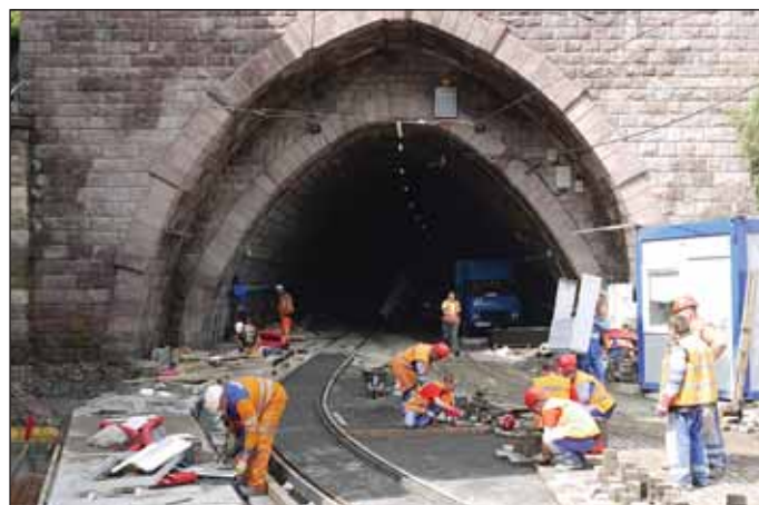
Obr. 7 Práce pred východným portálom tunela Fig. 7 Working in front of the eastern tunnel portal
