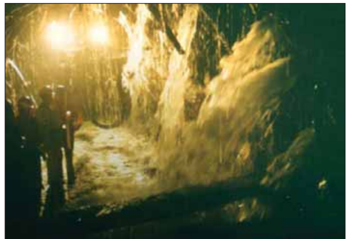
Obr. 20 Průval podzemní vody v tunelu Kaponig v Rakousku Fig. 20 Groundwater breakdown in the Kaponig tunnel, Austria
