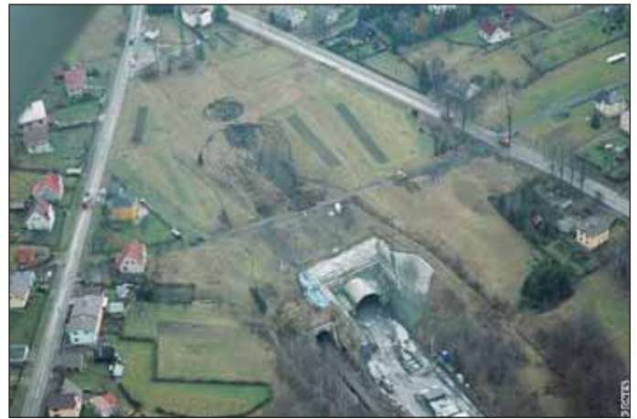
Obr. 18 Povrchový kráter Jablunkovského tunelu (listopad 2009) Fig. 18 A surface crater after a collapse of the Jablunkov tunnel (November 2009)
