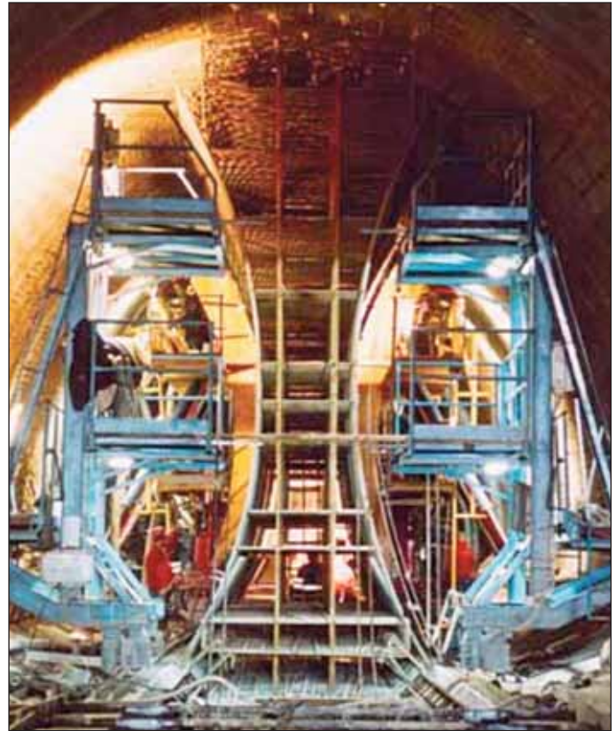
Obr. 4 Výztuž železobetonového středního pilíře s pojízdným bedněním Fig. 4 Reinforcement of the central reinforced concrete pillar and the traveling formwork
