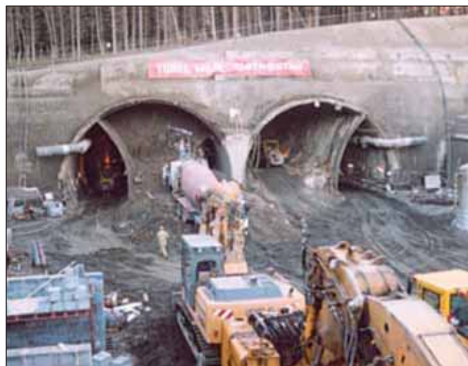
Obr. 1 Západní portál v průběhu ražeb
