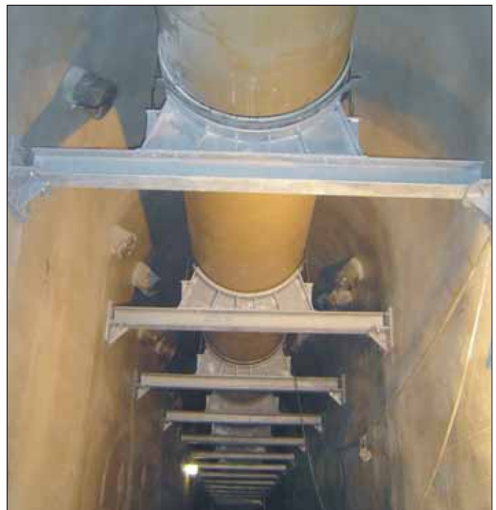
Obr. 16 Uložení kanalizace v kolektoru
