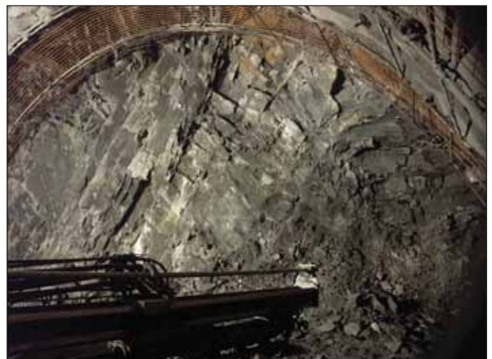
Obr. 10 Strmě uložené aleuopelity v čelbě kaloty s antiformní strukturou vpravo (tunelová trouba B, km 141,864) (foto Stach)
