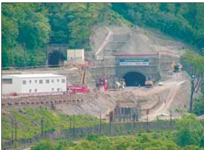
Obr. 6 Východní portál tunelů Fig. 6 Eastern portal of the tunnels
