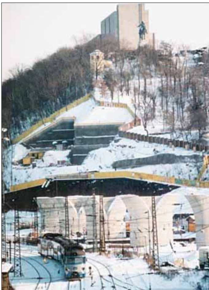
Obr. 7 Západní portál tunelů Fig. 7 Western portal of the tunnels
