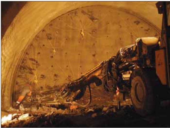
Obr. 2 Příprava k odstřelu Fig. 2 Preparation for blasting
