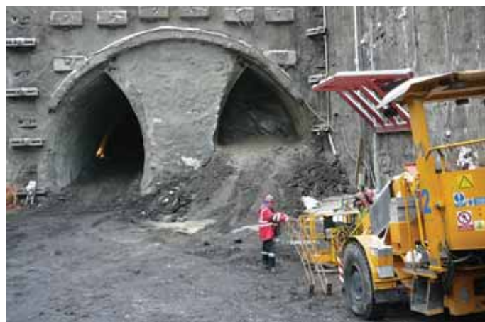
Obr. 4 Portál JTT raženého tunelu Brusnice Fig. 4 Brusnice STT mined tunnel portal
