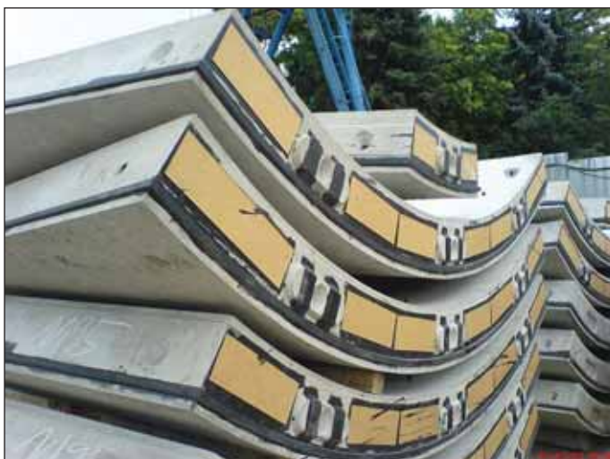
Obr. 10 Skládka segmentů vybavených těsněním a překližkami Fig. 10 Stacking facility for segments fitted with sealing gaskets and plywood
