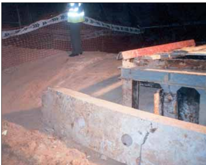
Obr. 6 Výstavba stanice Puerta del Sol – Gran Via Fig. 6 Construction of Puerta del Sol – Gran Via station
