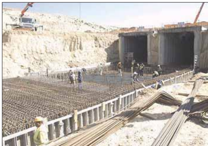
Obr. 9 Výstavba ve svaňované jámě [4]
