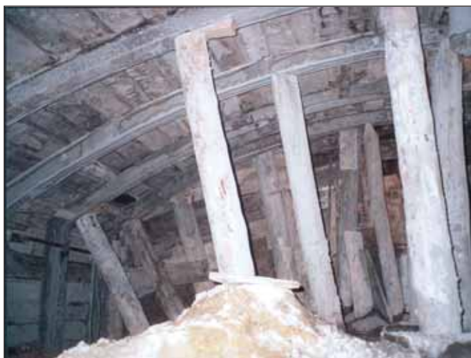
Obr. 5 Výstavba stanice Puerta del Sol – Gran Vía – madridská metoda Fig. 5 Construction of Puerta del Sol-Gran Vía station – the Madrid Method
