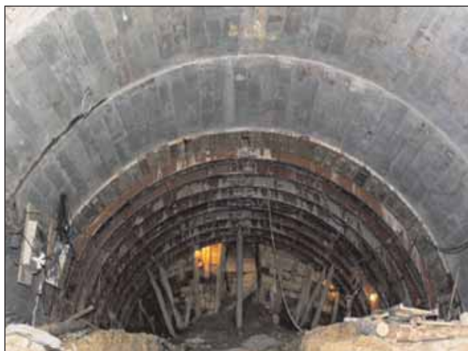
Obr. 8 Madridská tunelovací metoda [3]
