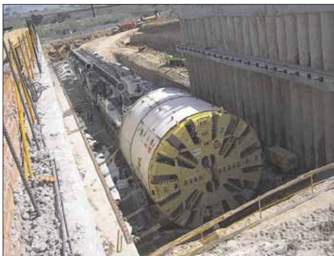
Obr. 7 Zeminový štít Herrenknecht S280 [1] Fig. 7 Herrenknecht S280 EPB TBM [1]
